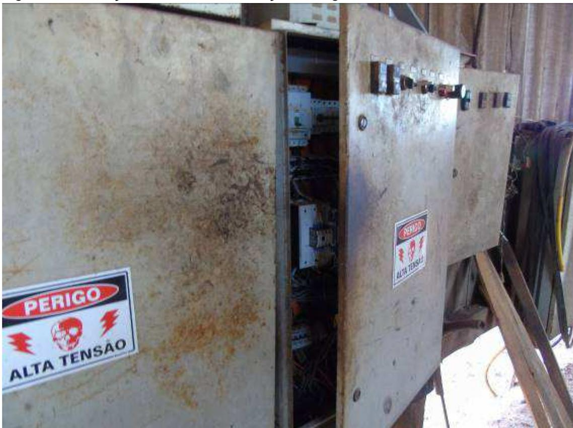
Figura 28 Instalações elétricas em condições inseguras de funcionamento
