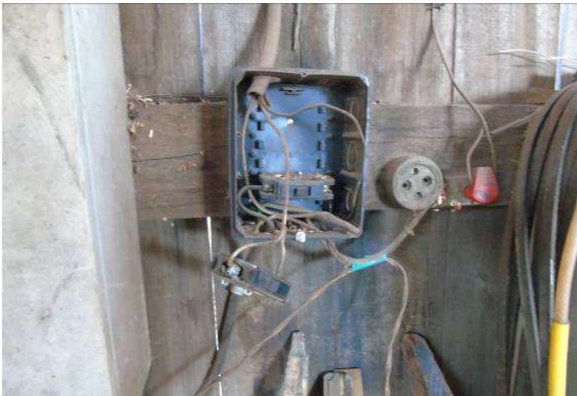
Figura 27 Instalações elétricas em condições inseguras de funcionamento
