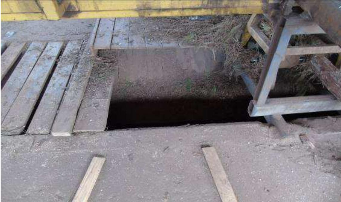
Figura 64: : Abertura no piso que possibilita a queda de pessoas ou objetos sem ser dotada de guarda corpo ou outro tipo de proteção contra quedas.
