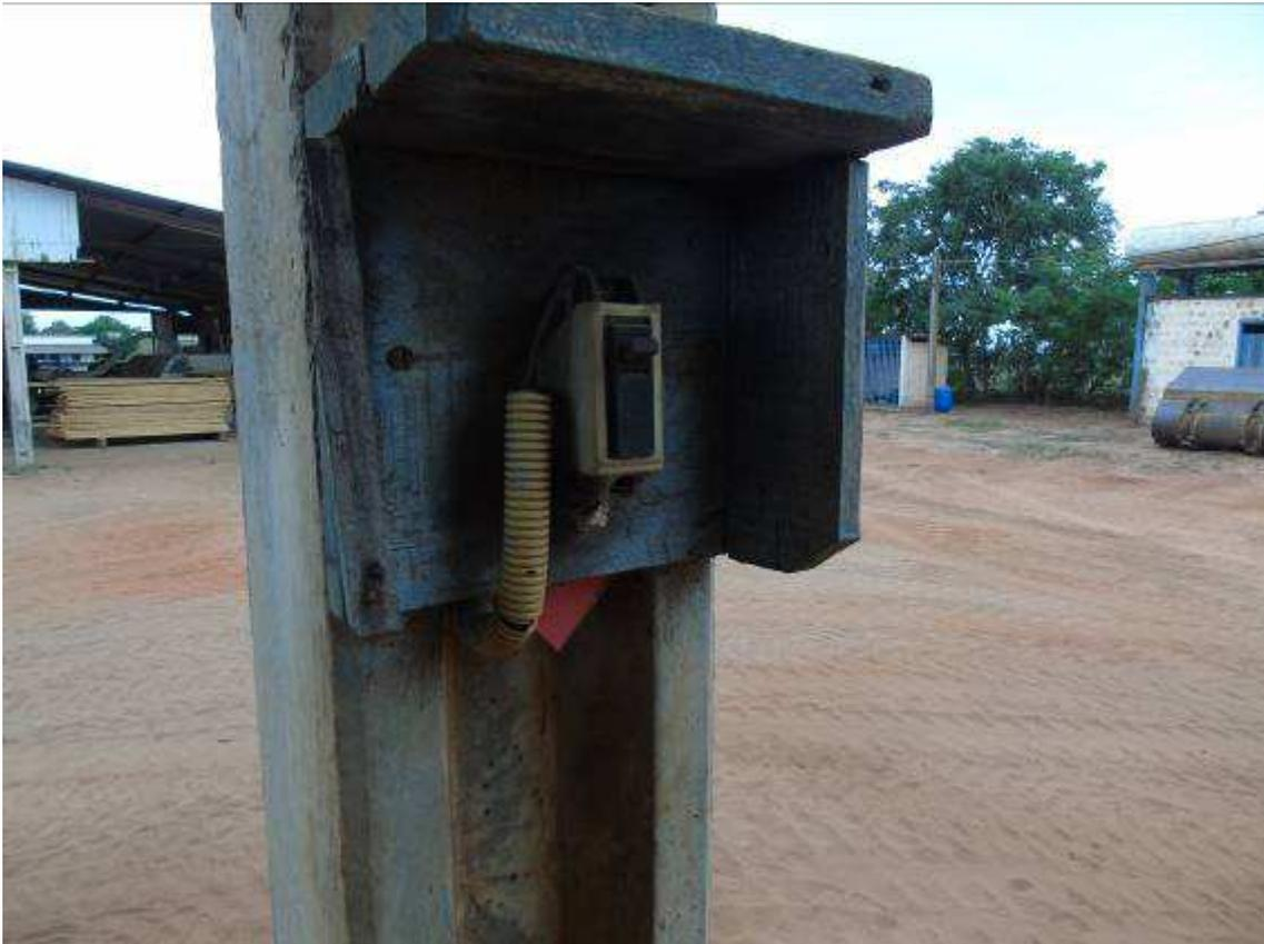
*Figura 5 Falta de quadro e identificação do disjuntor (circuito)*
