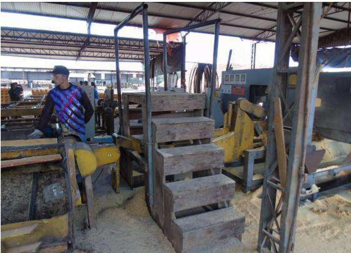
Figura 74: Escada sem corrimão, nos dois lados, além de quantidade de degraus inferior à necessária para atingir o piso ou patamar superior a ser acessado.
