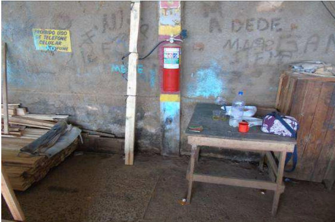
Figura 62: Extintor de incêndio com o acesso obstruído.
