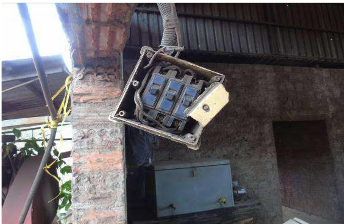
Figura 77: Instalação elétrica sem ser construída, montada, operada, reformada, ampliada, reparada e inspecionada de forma a garantir a segurança e a saúde dos trabalhadores e dos usuários.
