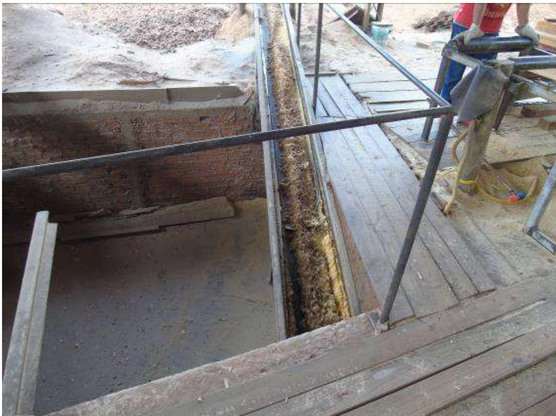
Figura 72: Local de trabalho, acima do solo, sem ser dotado de proteção contra quedas (guarda corpo de proteção)
