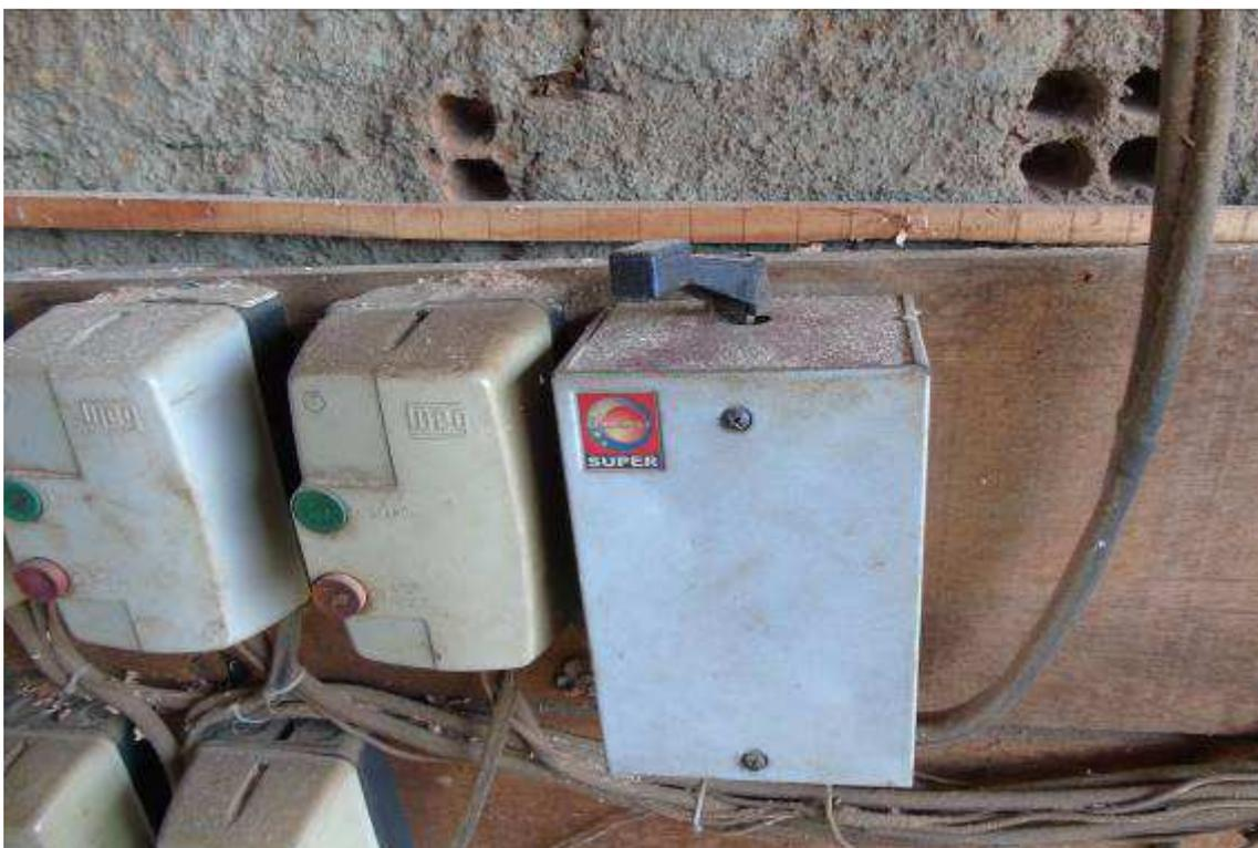
Figura 87: Equipamento sem dispositivos adequados de partida, acionamento e parada. (Chave tipo lombard)
