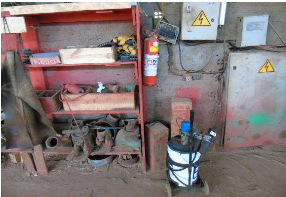
Figura 92: Extintor de incêndio com o acesso obstruído.
