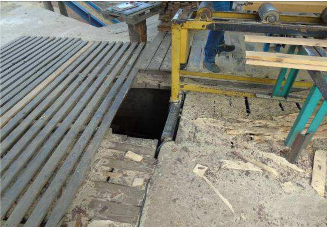
*Figura 67: Abertura no piso que possibilita a queda de pessoas ou objetos sem ser dotada de guarda corpo ou outro tipo de proteção contra quedas.*
