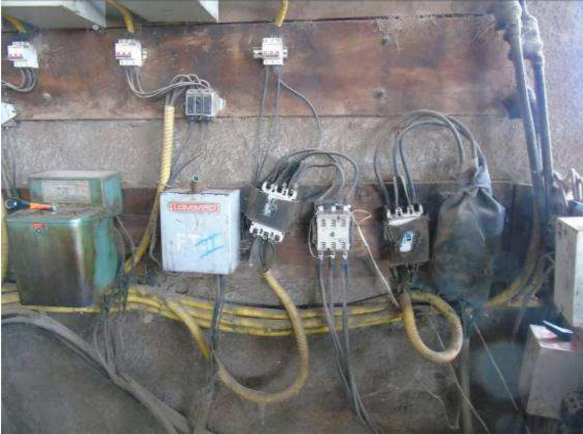
*Figura 48: Instalação elétrica sem ser construída, montada, operada, reformada, ampliada, reparada e inspecionada de forma a garantir a segurança e a saúde dos trabalhadores e dos usuários.*
