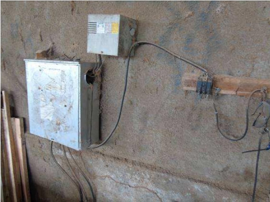
*Figura 46: Instalação elétrica sem ser construída, montada, operada, reformada, ampliada, reparada e inspecionada de forma a garantir a segurança e a saúde dos trabalhadores e dos usuários.*
