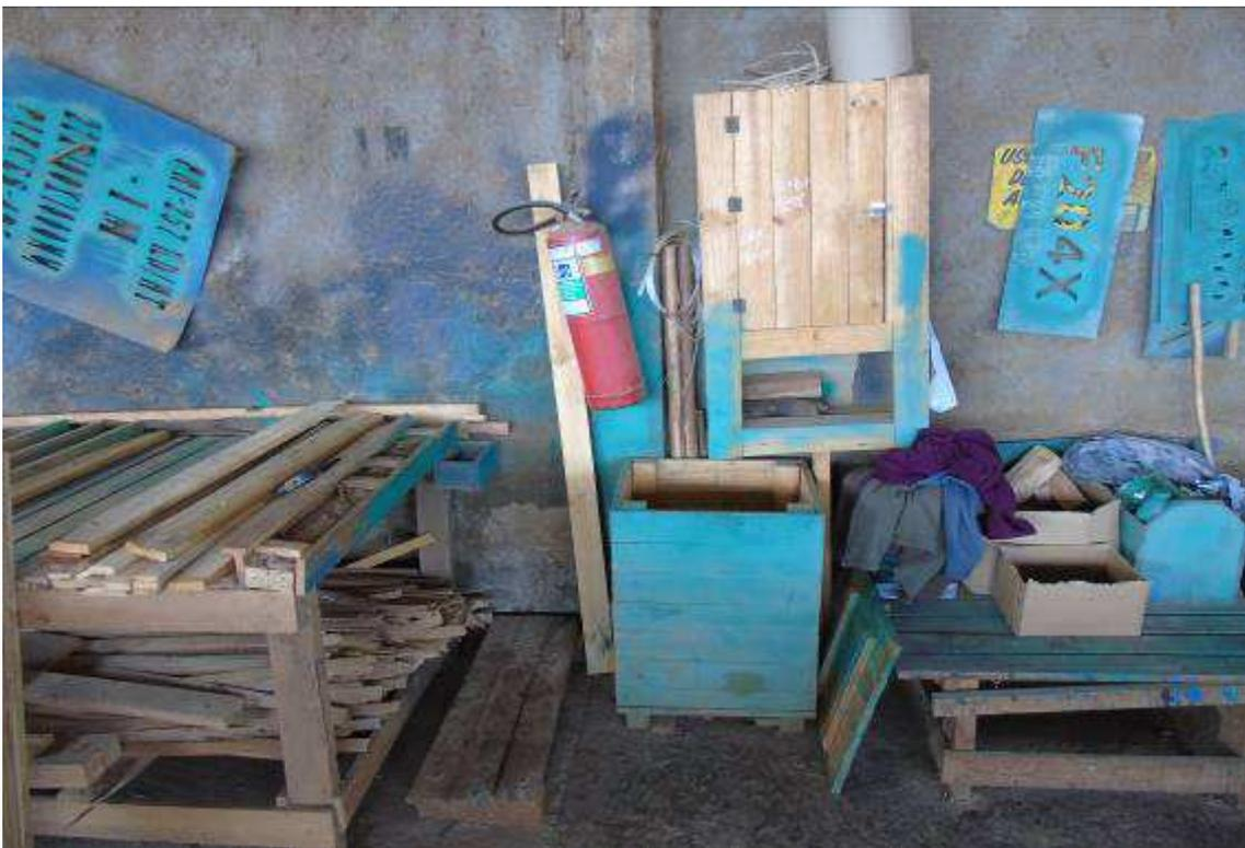
Figura 61: Extintor de incêndio com o acesso obstruído.
