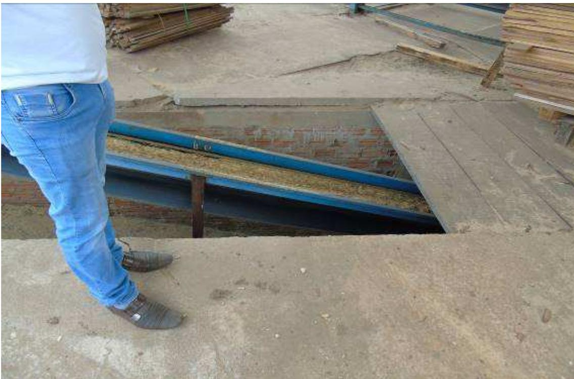
*Figura 68: Abertura no piso que possibilita a queda de pessoas ou objetos sem ser dotada de guarda corpo ou outro tipo de proteção contra quedas.*
