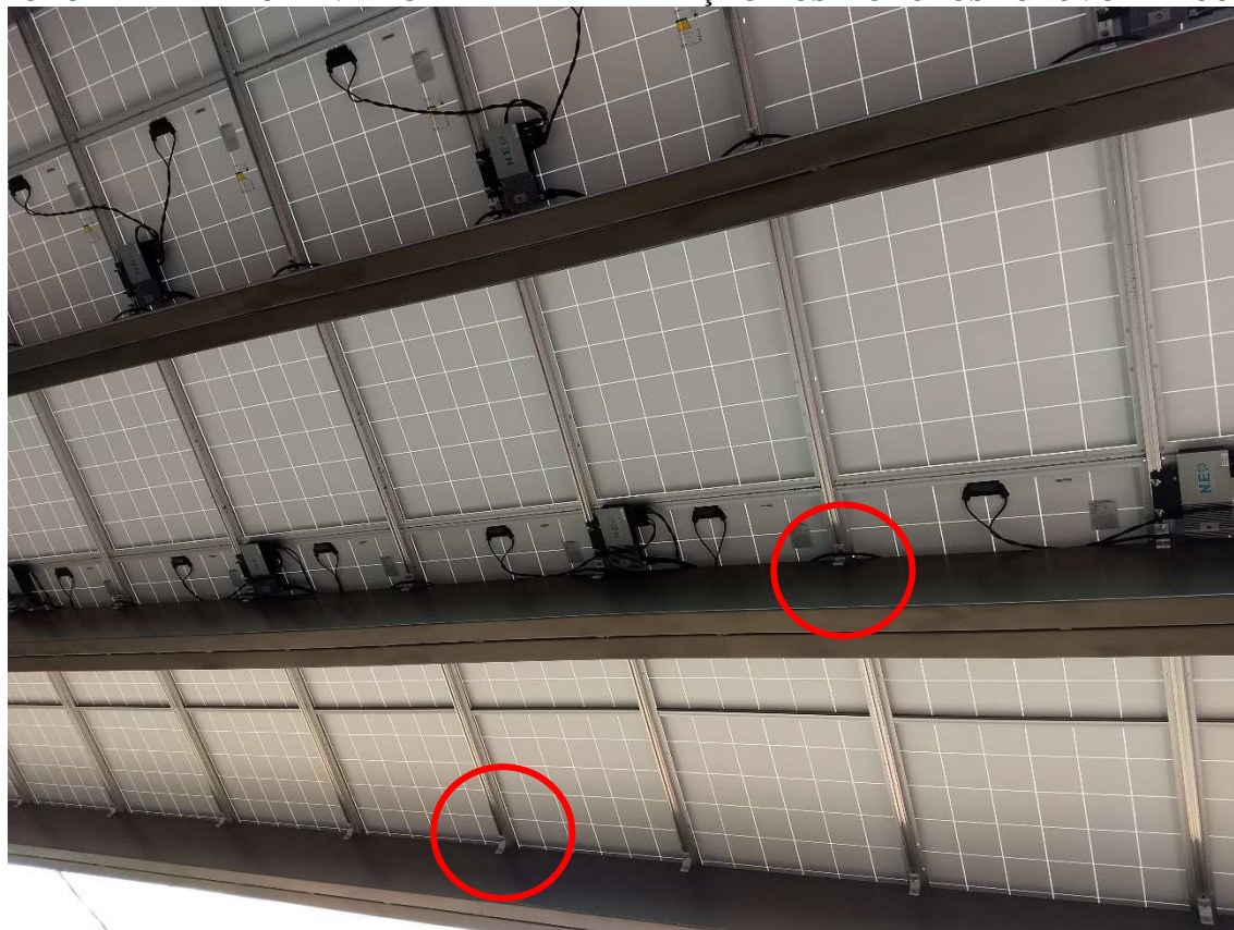
Detalhe das fixações entre os trilhos-guia metálicos, os módulos fotovoltaicos e as terças metálicas de apoio (vista inferior)
