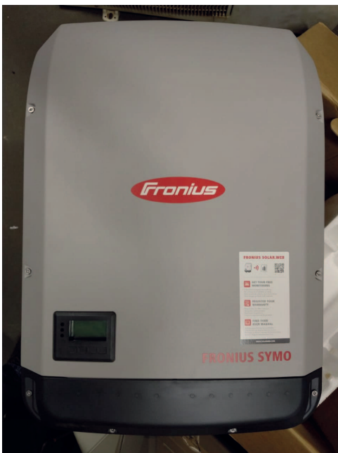
7.2. Inversor transformador Trifásico de 15.000VA (volt-amperes) da fabricante FRONIUS SYMO BRASIL modelo 15.0-3 48/240 com monitoramento wi-fi.
