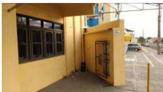
Pintura de paredes da fachada da entrada do anexo
