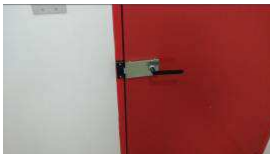
Maçaneta de porta corta-fogo substituída no 6º andar
