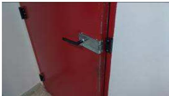
Maçaneta de porta corta-fogo substituída no 7º andar
