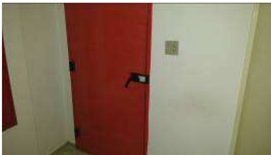
Maçaneta de porta corta-fogo substituída no 1º andar
