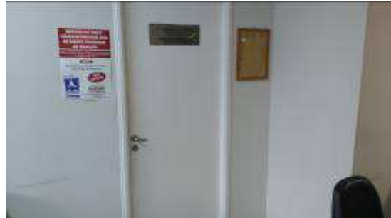
Porta de madeira recuperada com pintura no 1º andar (salas de audiência)
