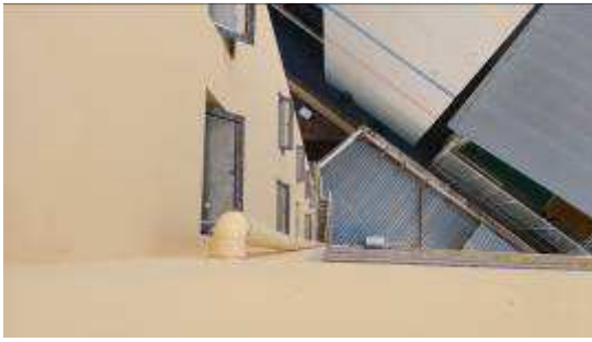
Descida de prumada de água pluvial do bocal da calha lateral direita
