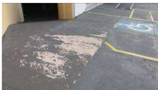
Área concretada na entrada de veículos do subsolo no calçamento da fachada
