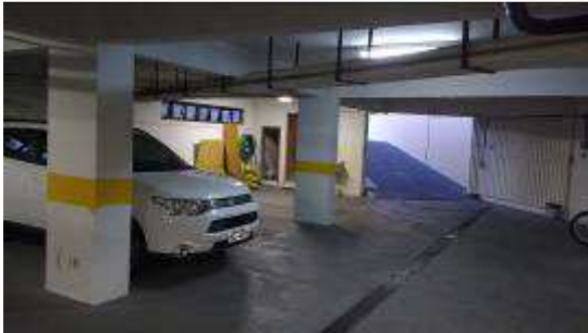
Pintura de paredes, tetos, pisos e pilares da área de subsolo
