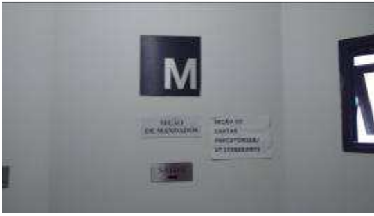
Pintura de parede de área de escada de emergência no Mezanino
