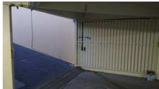
Detalhe de portão de abrir do subsolo
