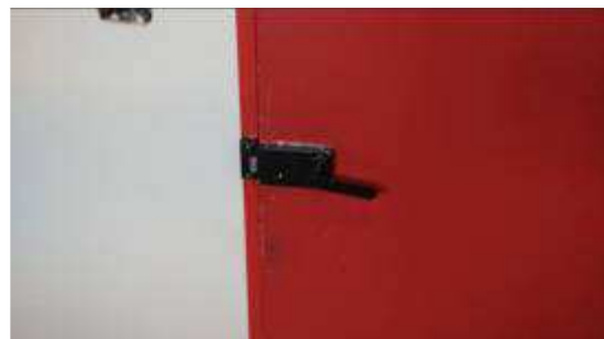
Maçaneta de porta corta-fogo substituída no 7º andar
