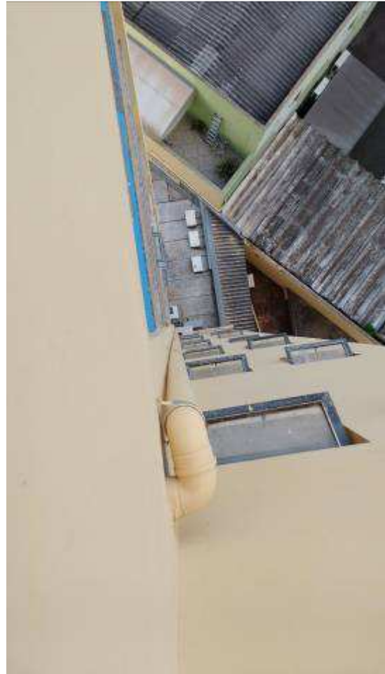
Descida de prumada de água pluvial do bocal da calha lateral esquerda
