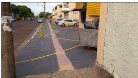
Piso tátil e pintura no calçamento da fachada
