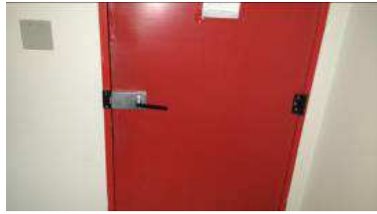
Maçaneta de porta corta-fogo substituída no 2º andar
