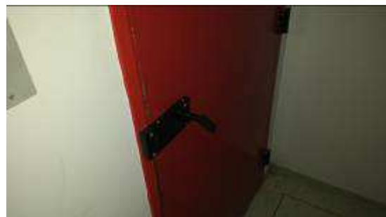
Maçaneta de porta corta-fogo substituída no Mezanino
