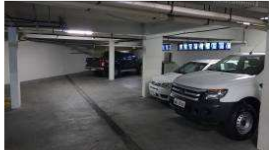
Pintura de paredes, tetos, pisos e pilares da área de subsolo
