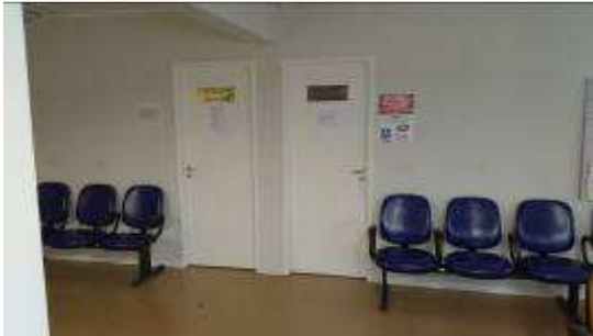
Portas de madeira recuperadas com pintura no 2º andar (salas de audiência)
