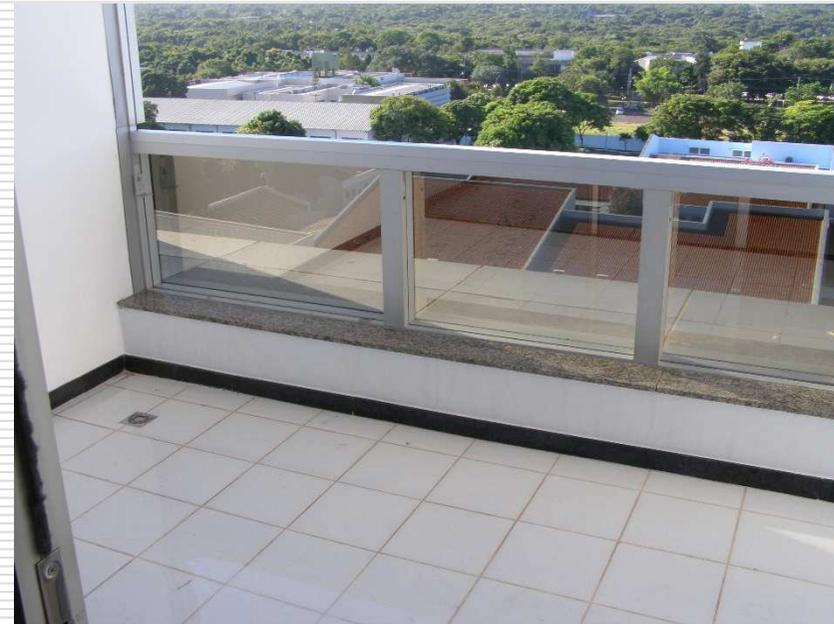
Detalhe do guarda corpo na sacada da sala do gabinete da presidência, estruturado em alumínio com pele de vidro, em substituição ao que existia de alvenaria
