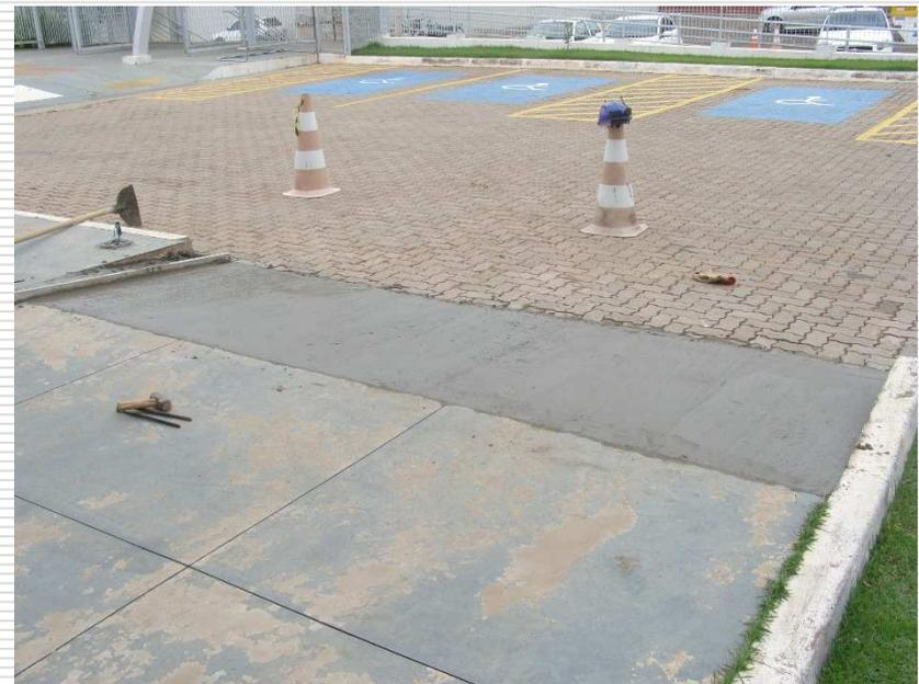
Execução de rebaixo no meio fio em pavimento de concreto no pátio de entrada do prédio sede, para facilitar entradas de carros oficiais
