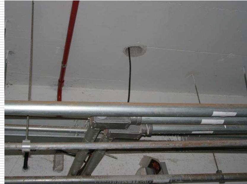
Execução de quatro furos na laje do saguão de entrada principal do prédio sede para execução da infraestrutura dos equipamentos de raio x
