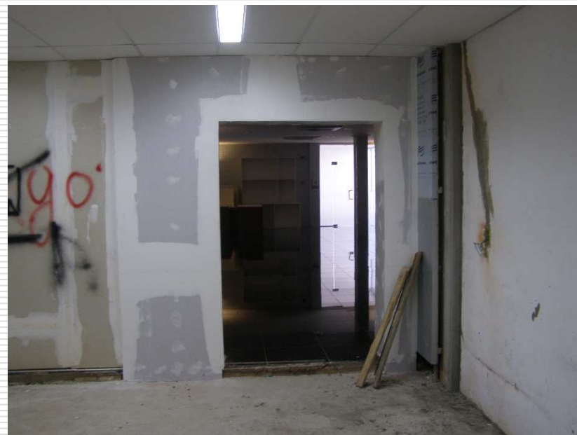
Detalhe da painel em gesso acartonado da porta de entrada da sala de conciliação
