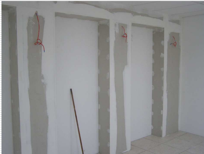
Detalhe do painel em gesso acartonado
