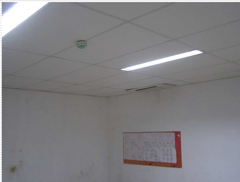
Vista da sala de conciliação: luminárias e forros instalados
