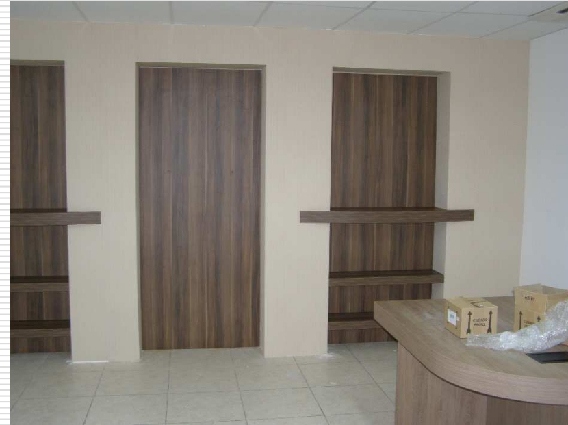
Parede gesso acartonado com revestimento melamínico e papel de parede
