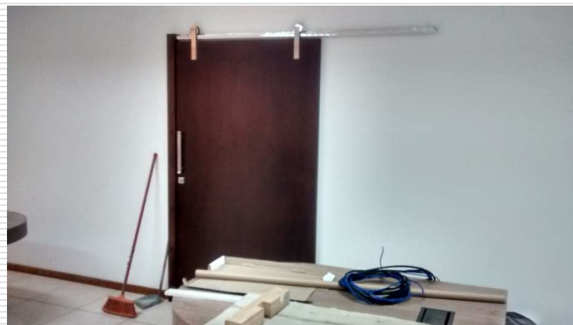
Porta lateral de correr instalada
