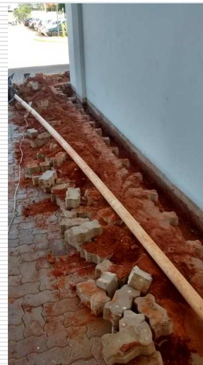
Detalhes do conserto do sistema de captação de águas pluviais e de limpeza na entrada do almoxarifado
