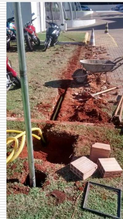
Detalhes da instalação da infraestrutura elétrica e poste de aço para sustentação de câmeras, utilizados para sistema de CFTV na entrada do Tribunal
