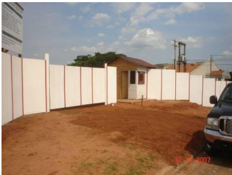
Fechamento da obra, controle de acesso (guarita).
