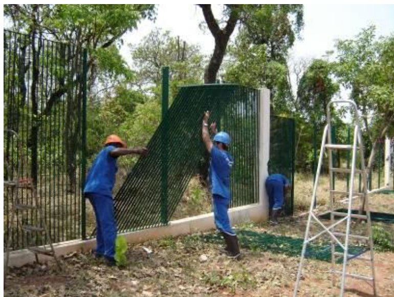
Retirada do Gradil
