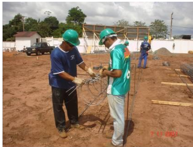
Detalhe da armação das estacas .
