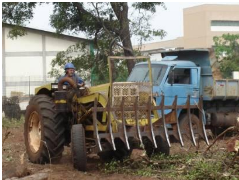
Detalhe do trator CBT e caminhão bota-fora
