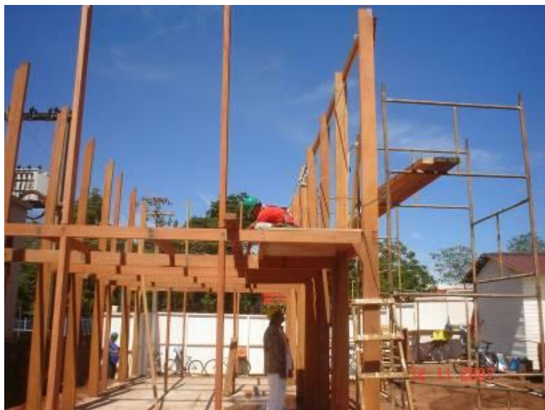
Detalhe da estrutura de madeira dos abrigos
