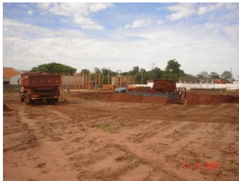
Detalhe da retirada de terra (bota fora)
