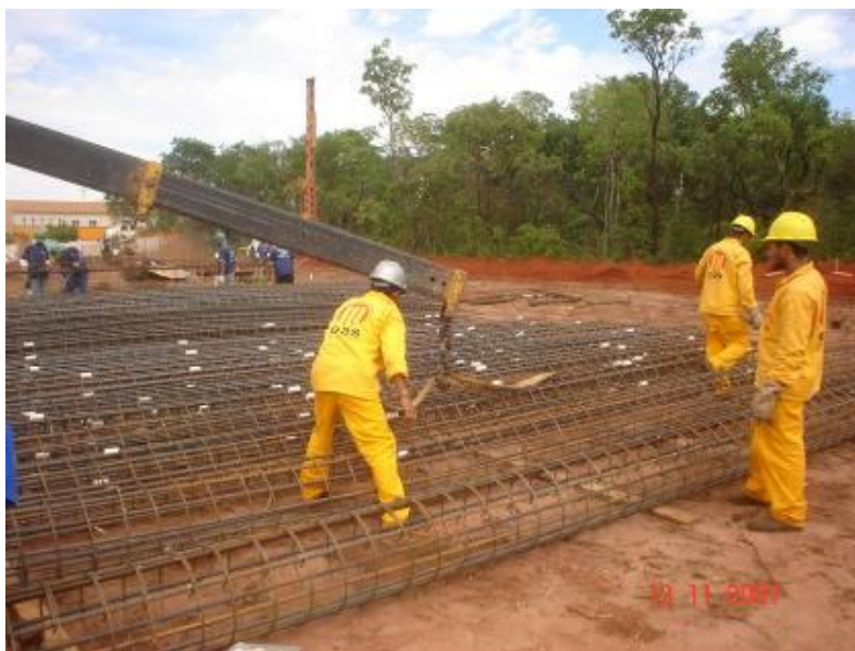
Detalhe das armaduras sendo erguidas pelo “Munck”
