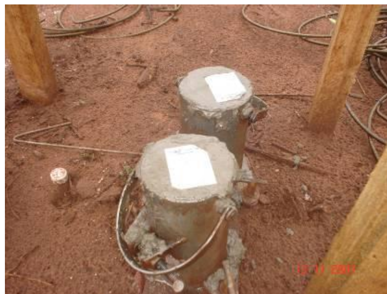
Detalhe do corpo de prova retirado do caminhão betoneira durante a concretagem das estacas (controle de qualidade tecnológico do concreto).
