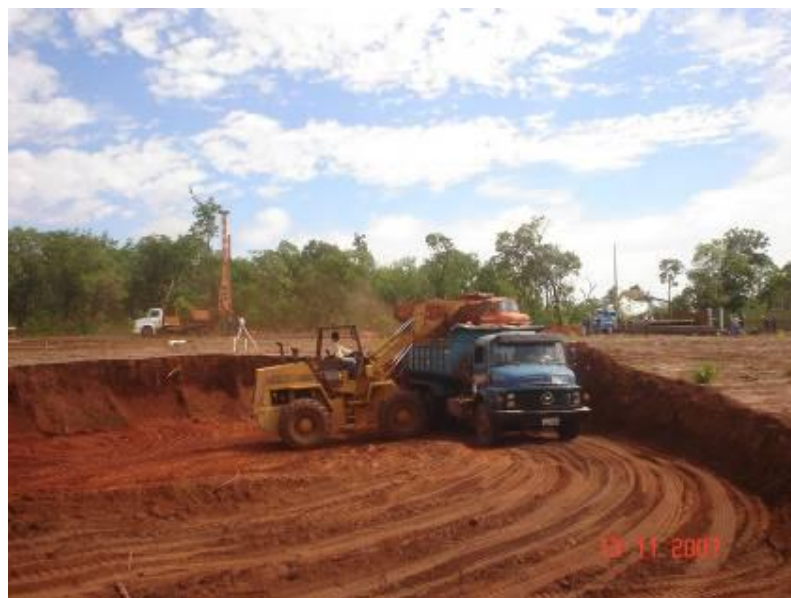
Detalhe da escavação do subsolo
