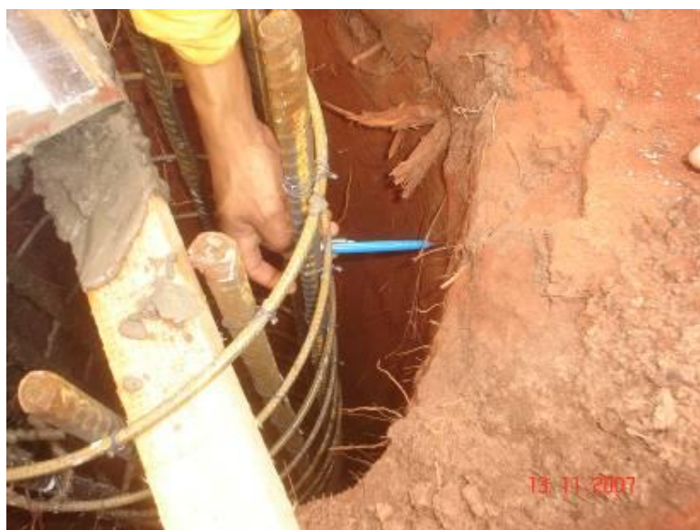
Conferência do posicionamento da armadura e o seu cobrimento
