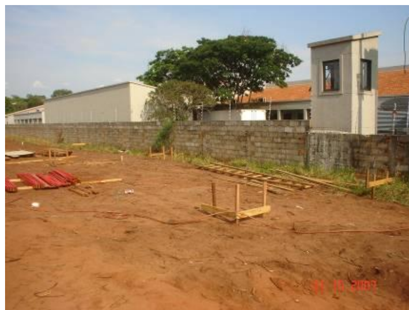
Locação do canteiro - Gabarito do abrigo da fiscalização
