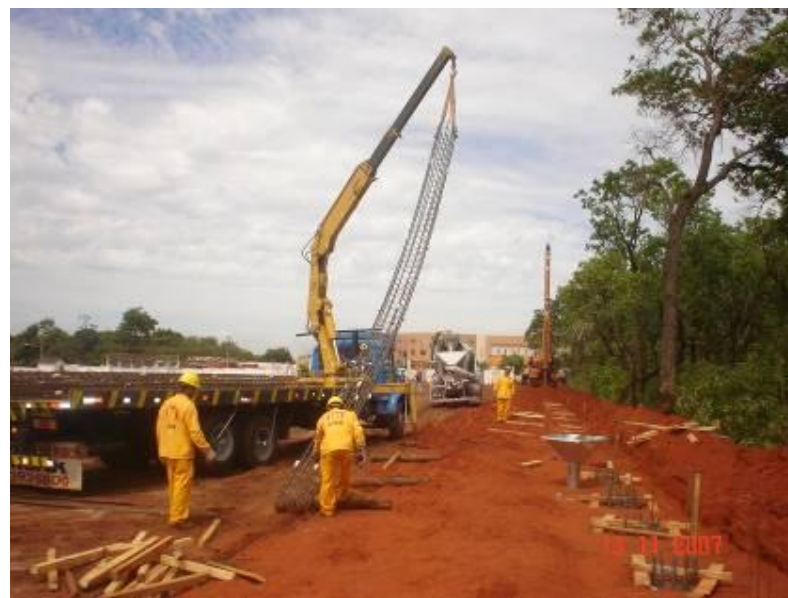
Observação de 3 atividades simultâneas: 1 Posicionamento das armaduras nas estacas 2 Concretagem das estacas 3 Perfuração de estacas
