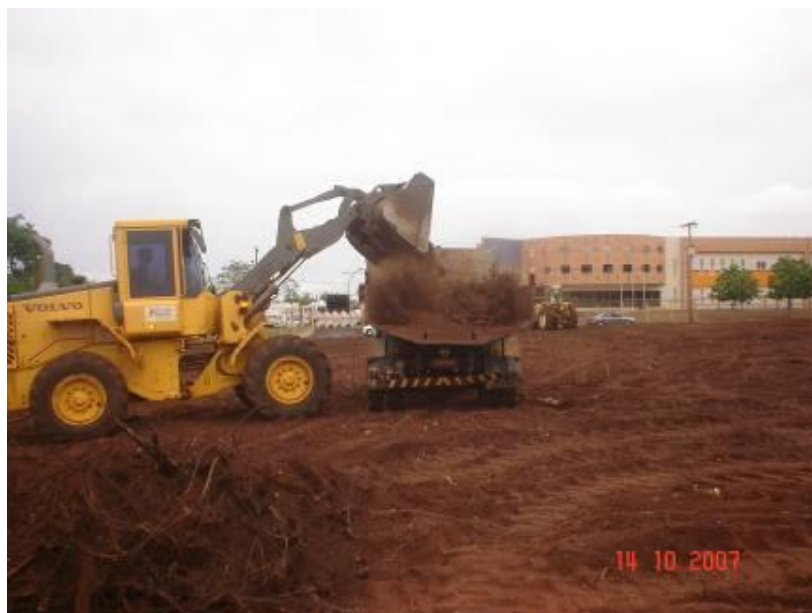
Limpeza do terreno (retirada de tocos e raízes)
