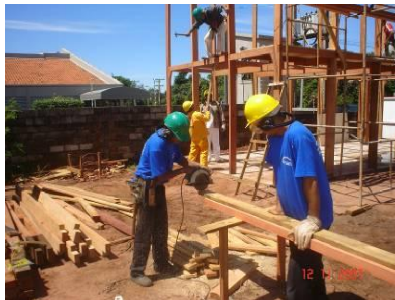
Trabalho com segurança, operários utilizando os EPIs; cinto de segurança, capacetes, luvas, botas, protetores auriculares, viseira e andaime amarrado e contraventado
