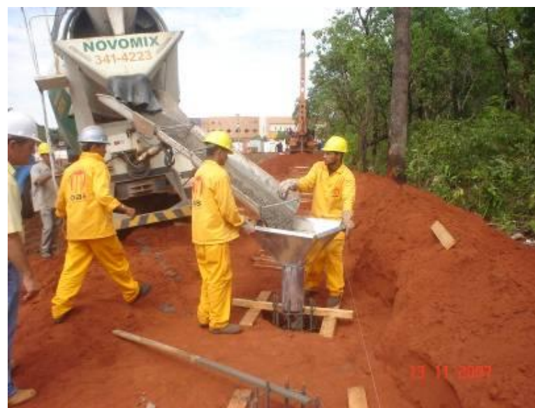
Lançamento do concreto (concreto usinado com 20MPa)
