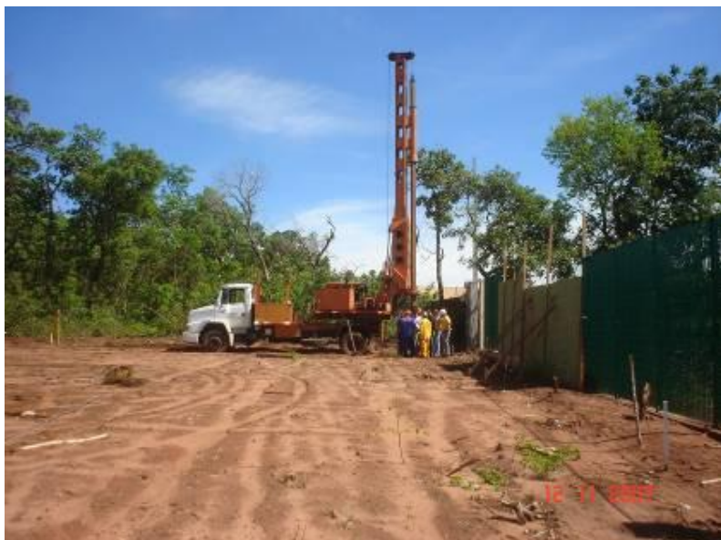
Detalhe do equipamento que executa a escavação da estaca Estaca escavada tipo rotativa executada pela Empresa Funsolos
