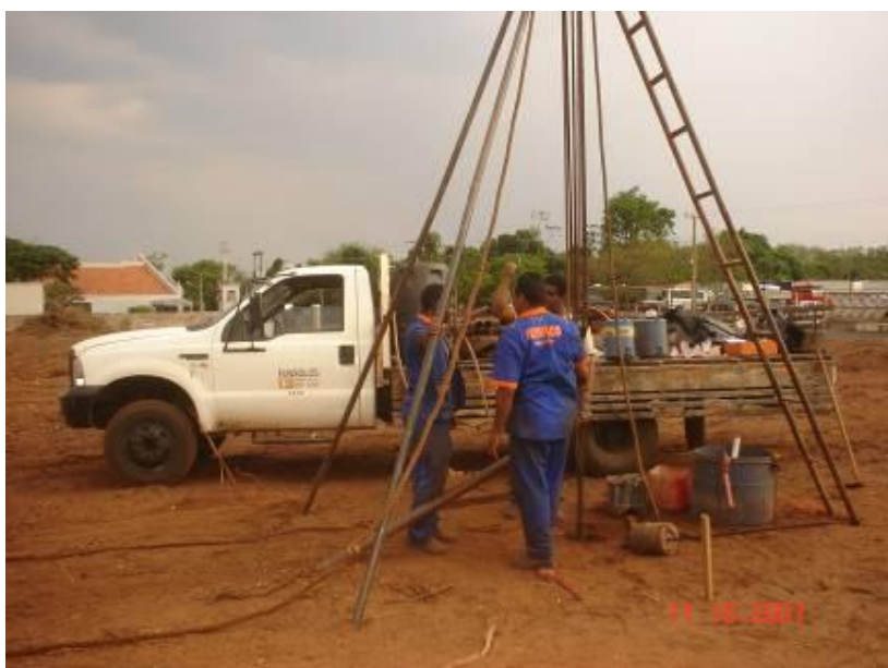
Detalhe da sondagem do terreno, confirmar a resistência do solo.
