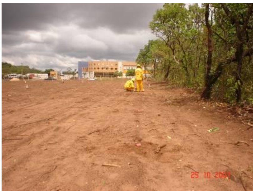
Detalhe do serviço de topografia (locação das estacas de contenção)
