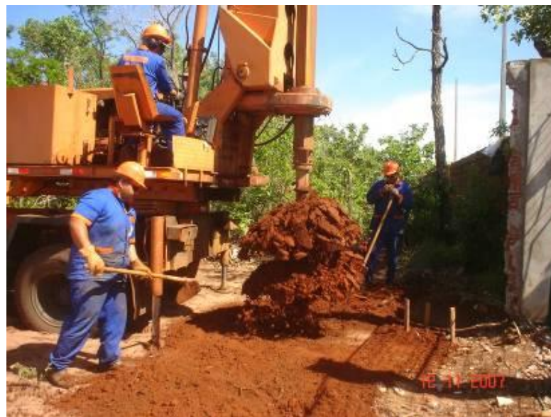
Detalhe do equipamento em operação Produção: 180m/dia
