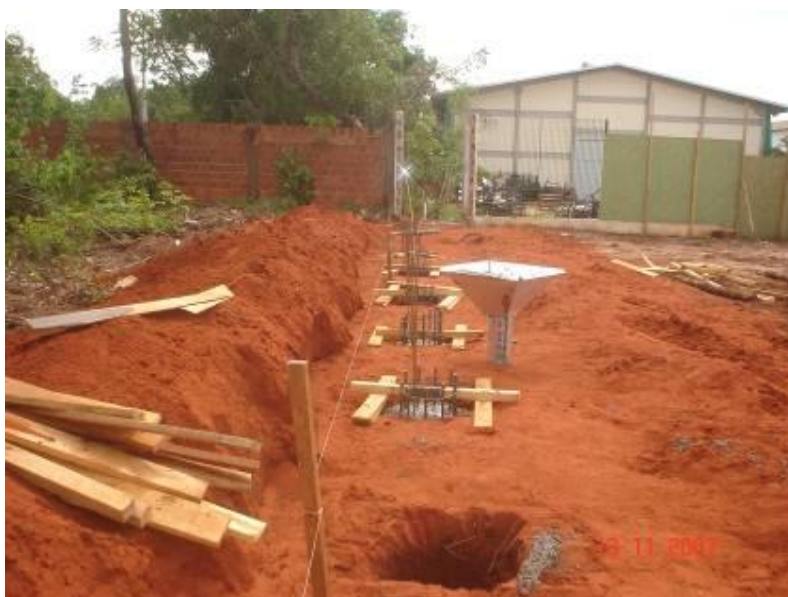
Detalhe das estacas de contenção concretadas
