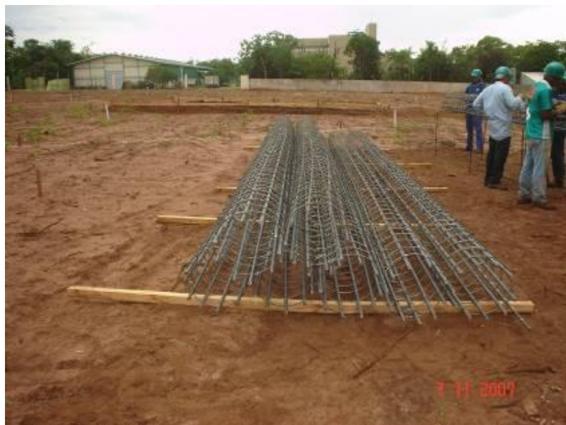
Detalhe da armadura das estacas de contenção 10 barras de 20mm e 60 estribos de 8mm por peça Total de estacas: 265 peças ou 2.385m
