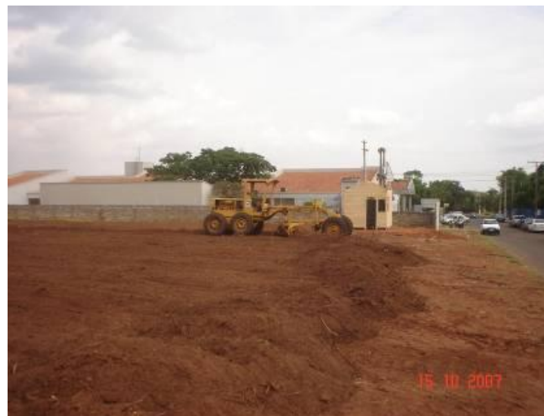
Raspagem e nivelamento do terreno
