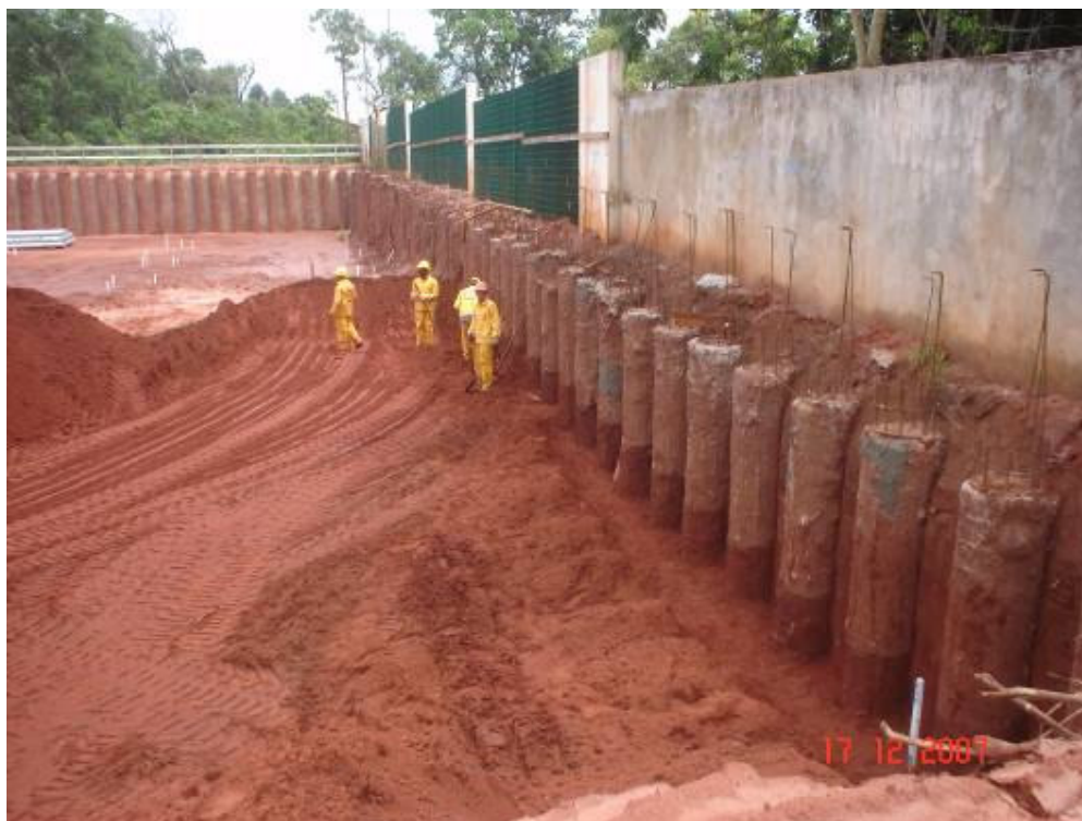
Finalização da escavação do subsolo – vista leste
