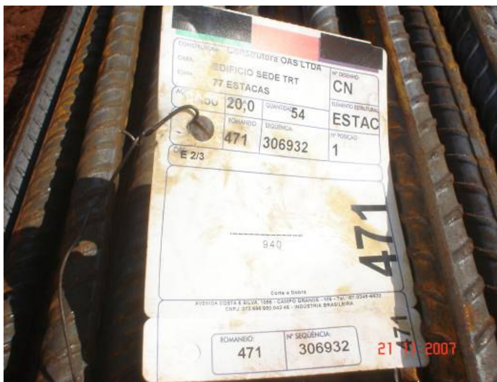
Bitola (20,0mm) dos aços das estacas de contenção
