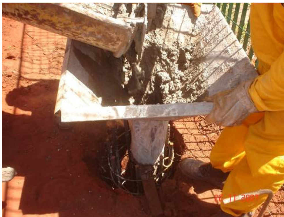
Concretagem das estacas de contenção
