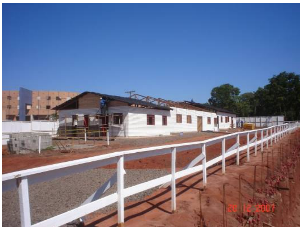
Início da cobertura do abrigo cozinha/refeitório/vestiário/banheiros
