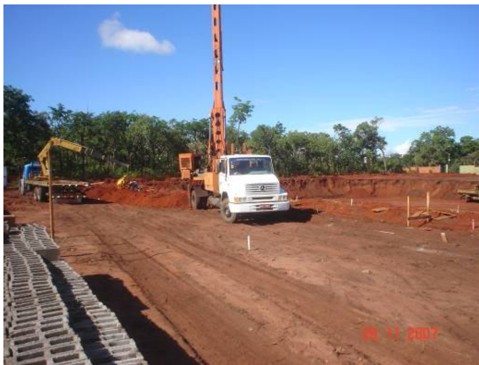
Escavação das estacas de contenção vista oeste
