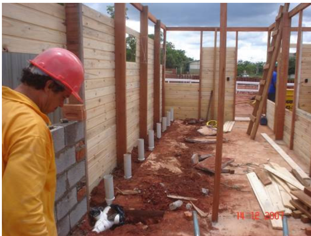
Instalações hidrossanitárias dos banheiros
