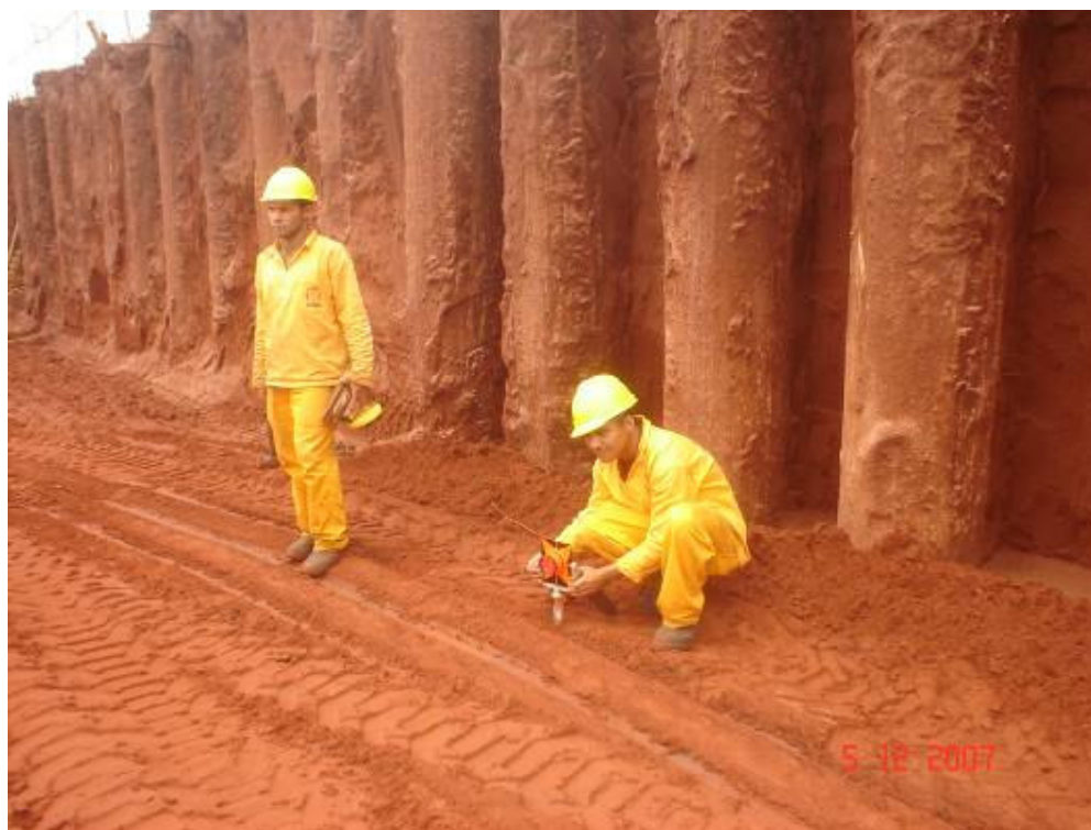
Serviço de topografia – locação do primeiro pilar (número 22)
