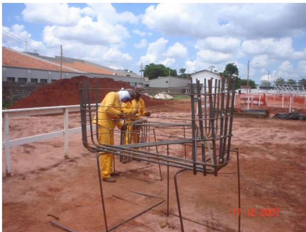
Armação dos blocos para três estacas pré-moldadas (pilar de 50 ton)
