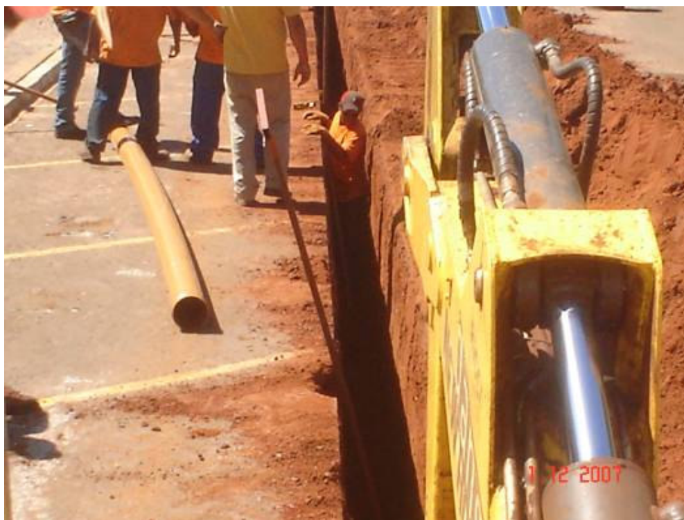
Ligação definitiva da rede de esgoto
