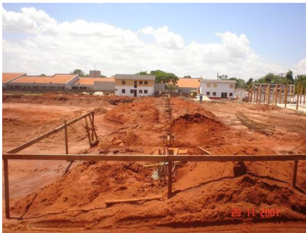
Vista oeste das estacas de contenção e dos abrigos da obra
