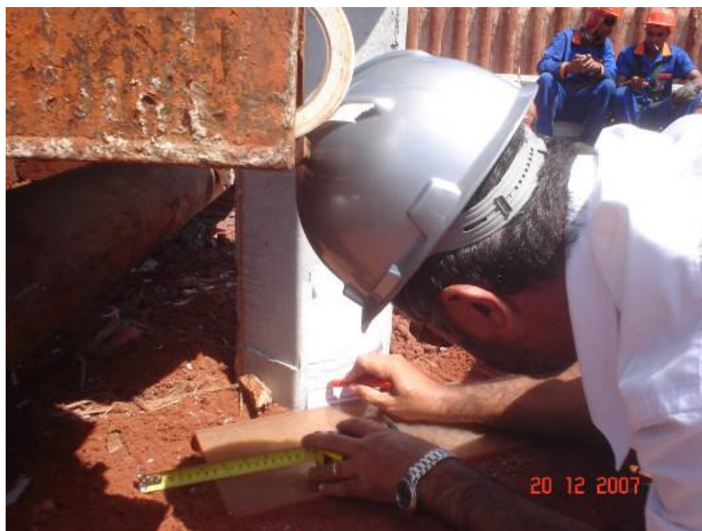
Anotação da nega das estacas cravadas a 18 metros de profundidade
