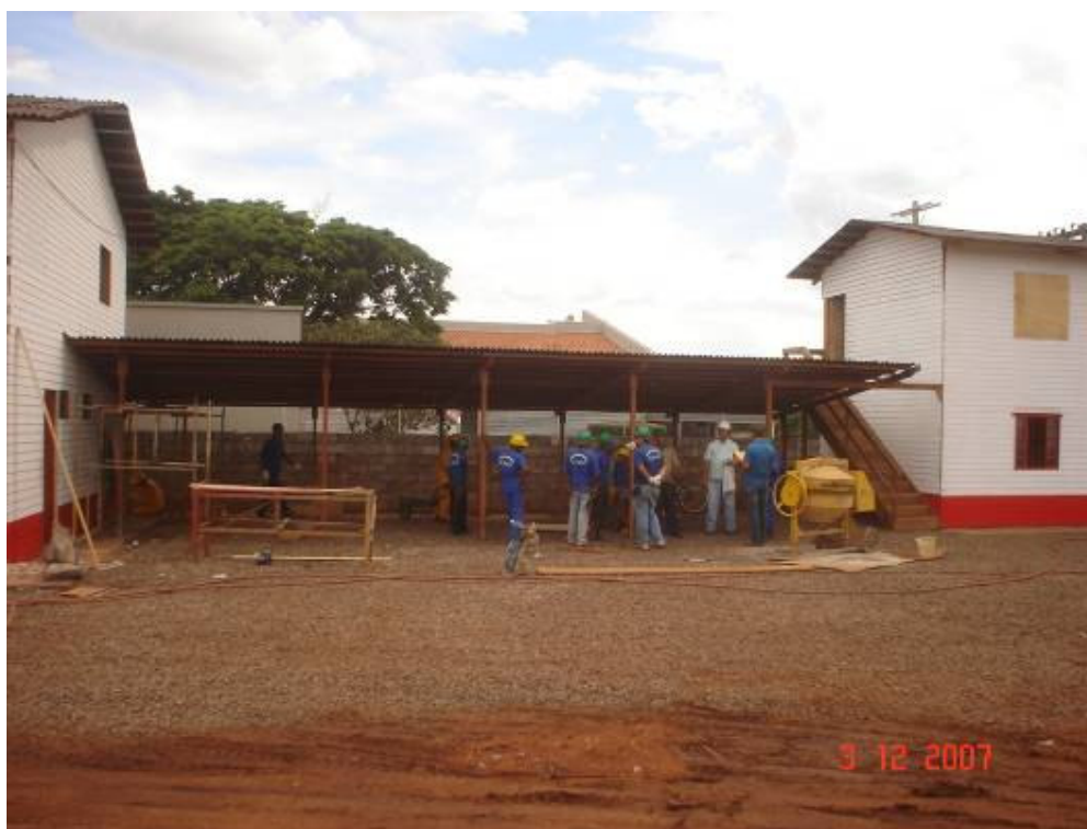
Vista do abrigo da fiscalização/sala de treinamento/SESMT (à direita), estacionamento (ao centro) e da construtora (à esquerda)
