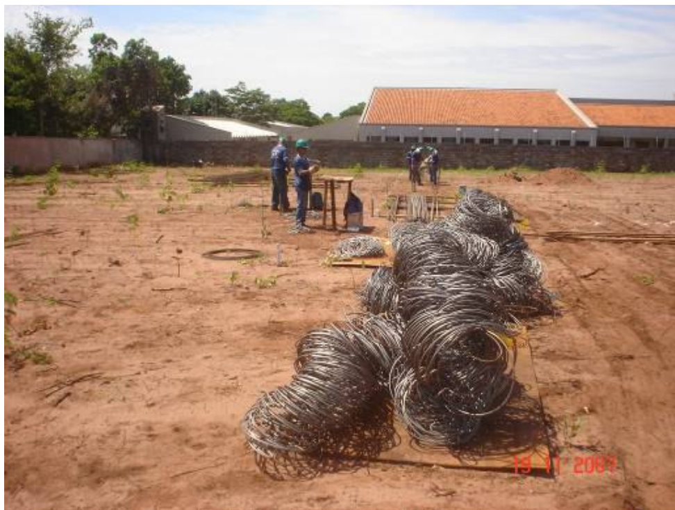
Armação das estacas de contenção
