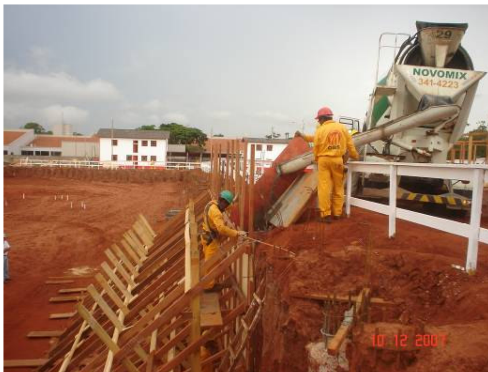
Concretagem das estacas de contenção contínua – vista oeste
