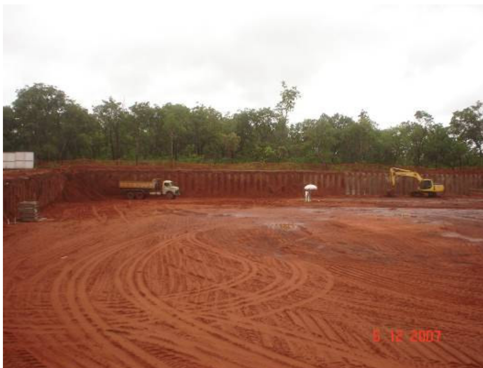
Vista da escavação do subsolo
