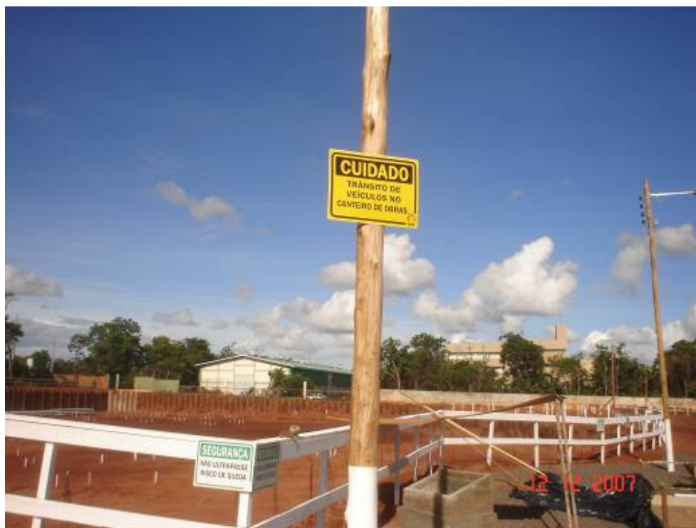
Placas de segurança/guarda-corpo
