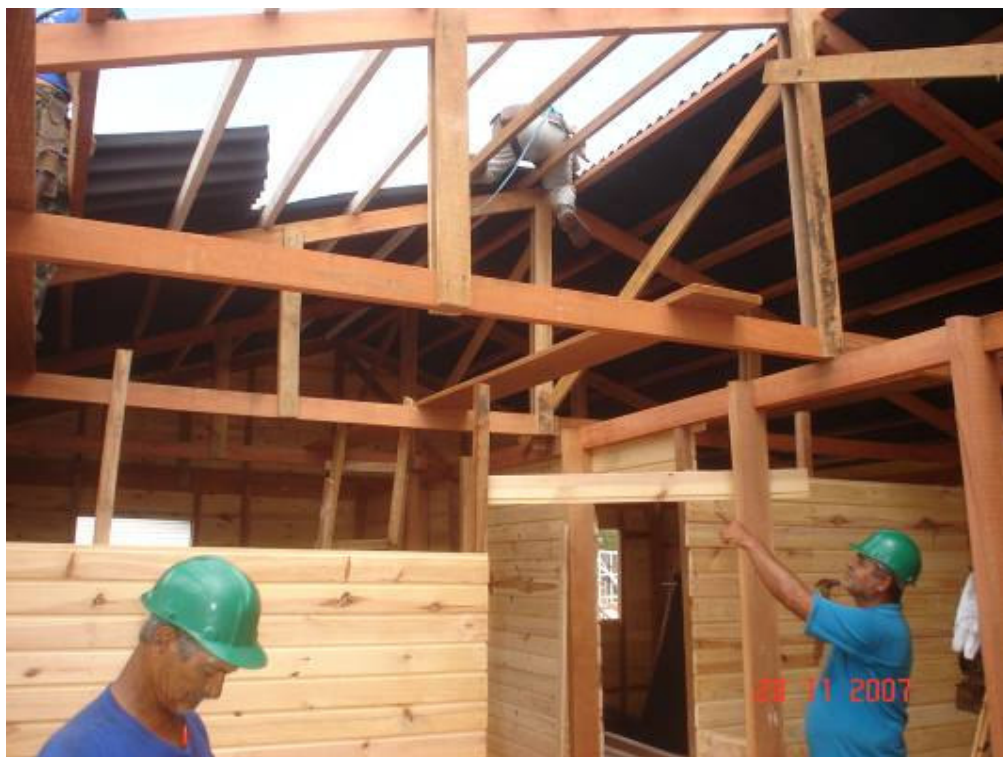
Serviços no abrigo da obra - cobertura
