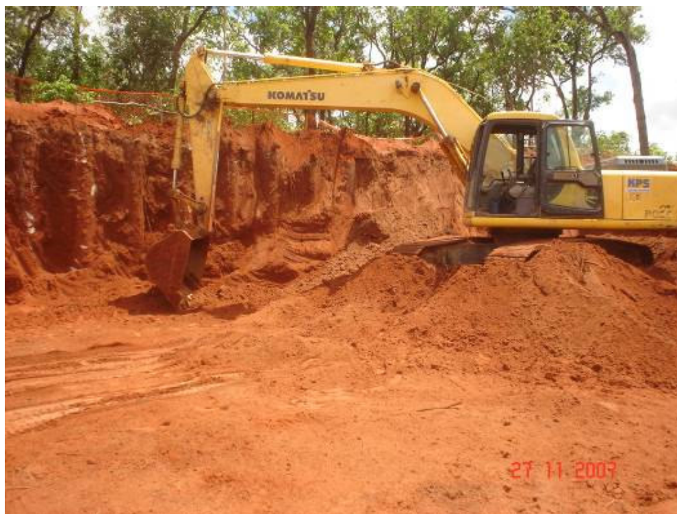
Escavação do subsolo junto às estacas de contenção
