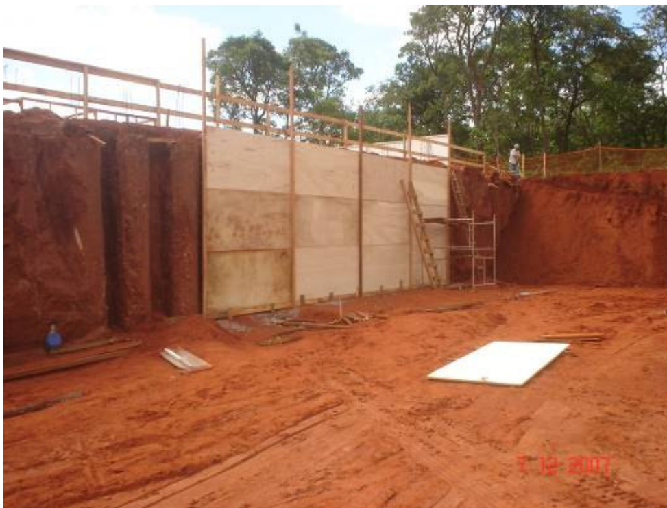
Fôrma para concretagem das estacas de contenção contínua – vista oeste
