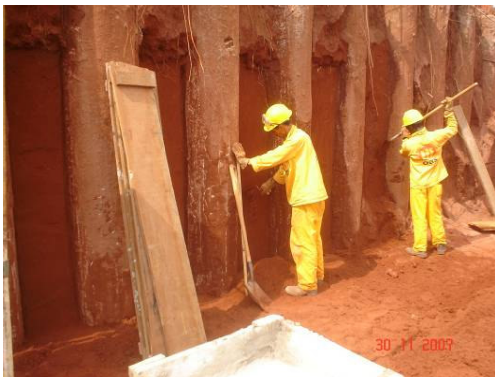
Avanço da escavação manual entre as estacas de contenção – vista norte
