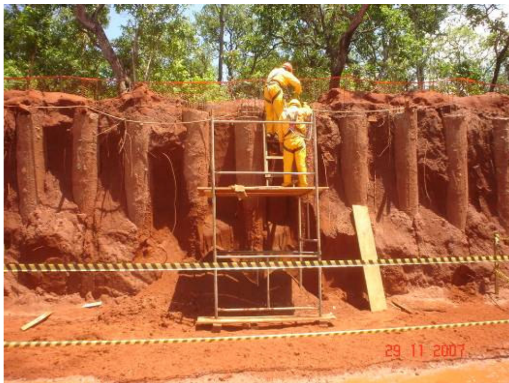
Escavação manual entre as estacas de contenção – vista norte
