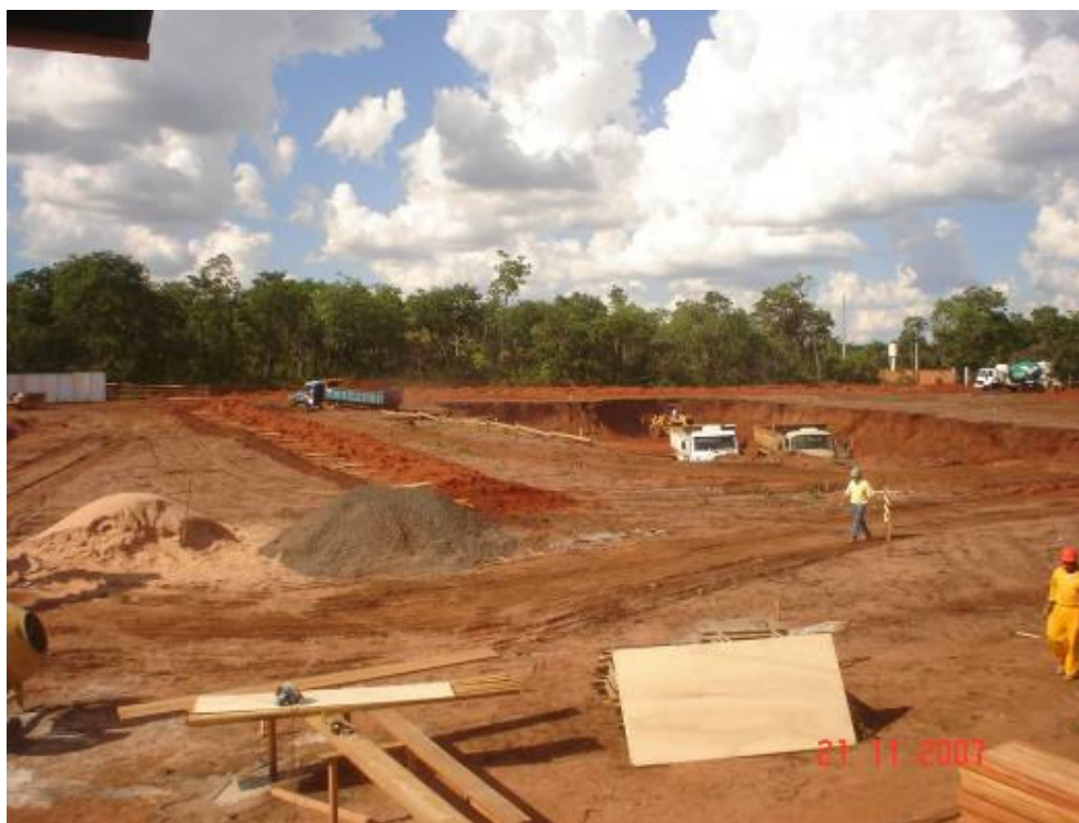
Vista geral das frentes de serviços
