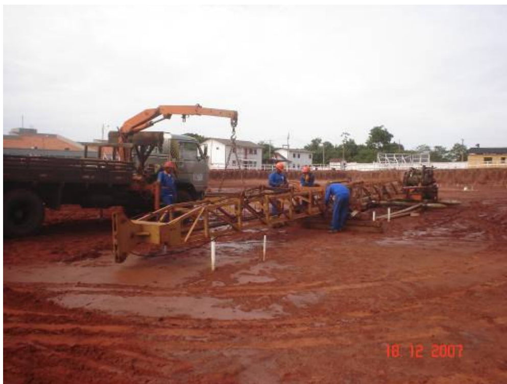
Montagem do bate-estaca
