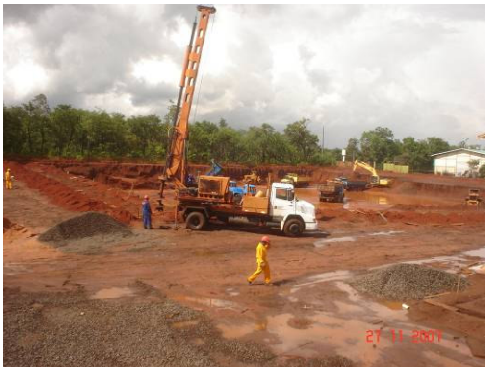
Escavação das estacas de contenção e do subsolo, após forte chuva noturna
