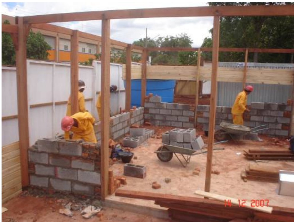
Fechamento em alvenaria dos banheiros
