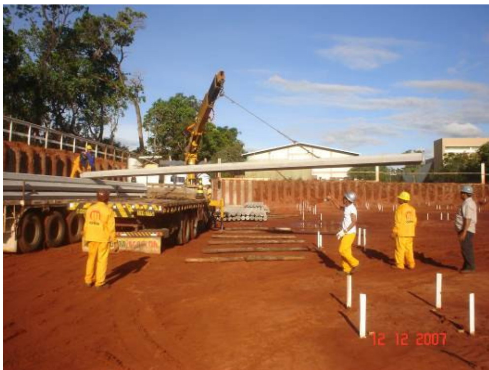
Descarga de estaca pré-moldadas
