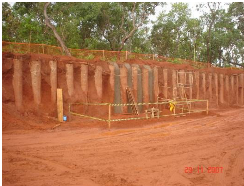
Chapisco entre estacas de contenção – vista norte
