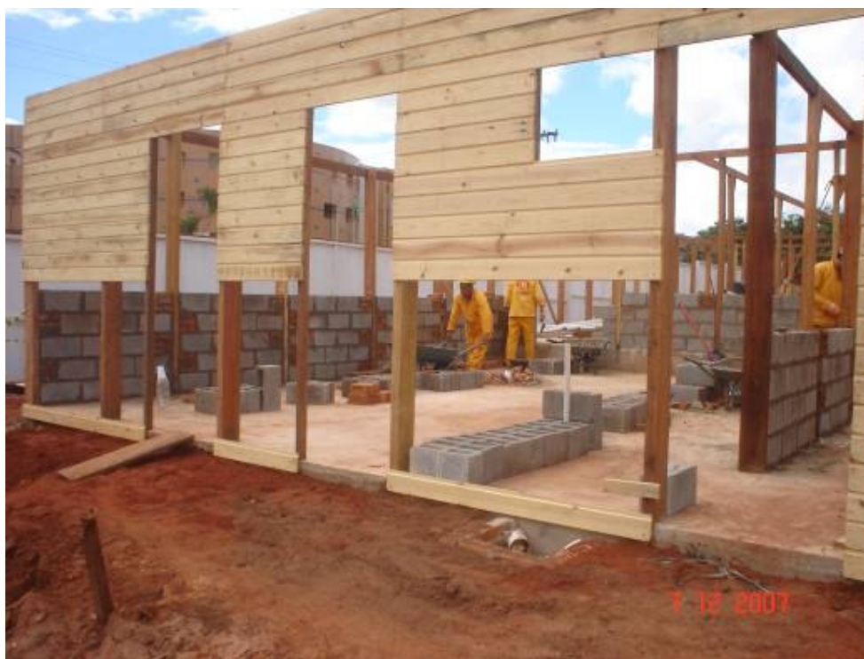
Fechamento em alvenaria do abrigo na área da cozinha
