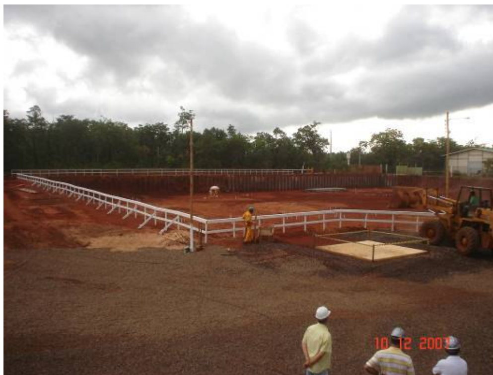
Vista do guarda-corpo de proteção do subsolo escavado
