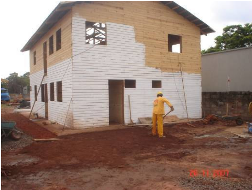
Serviços no abrigo da obra
