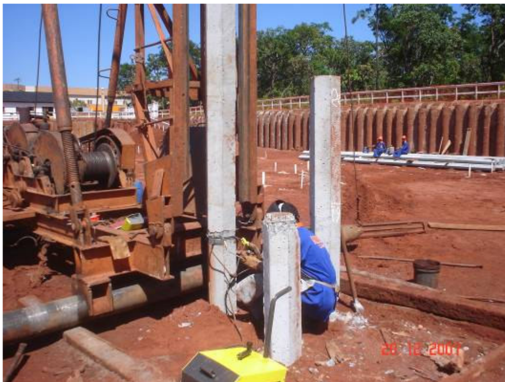
Soldagem e estacas cravadas
