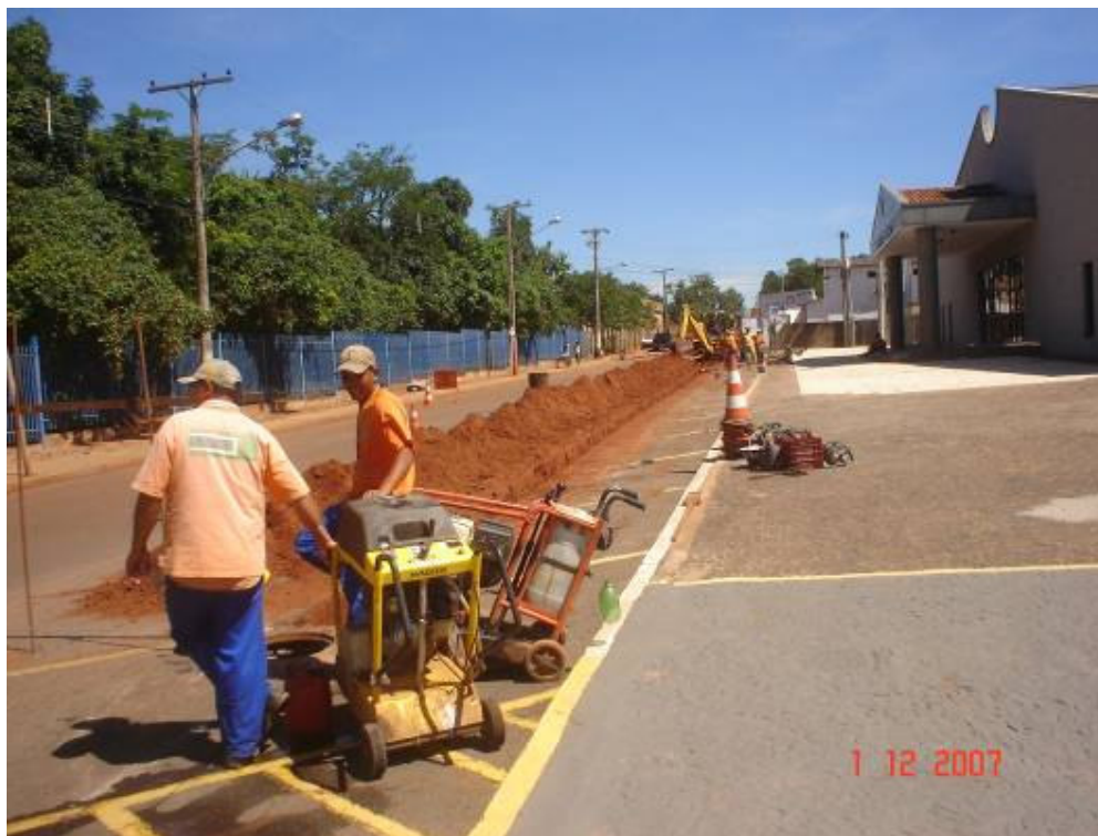
Ligação definitiva da rede de esgoto
