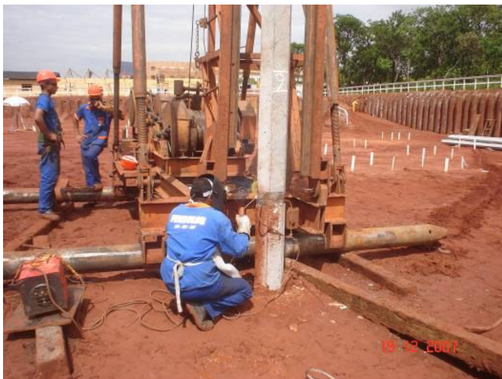
Emenda com solda da primeira estaca
