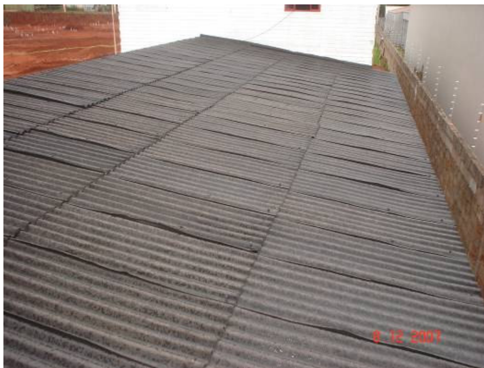
Vista da cobertura do estacionamento em telha ecológica
