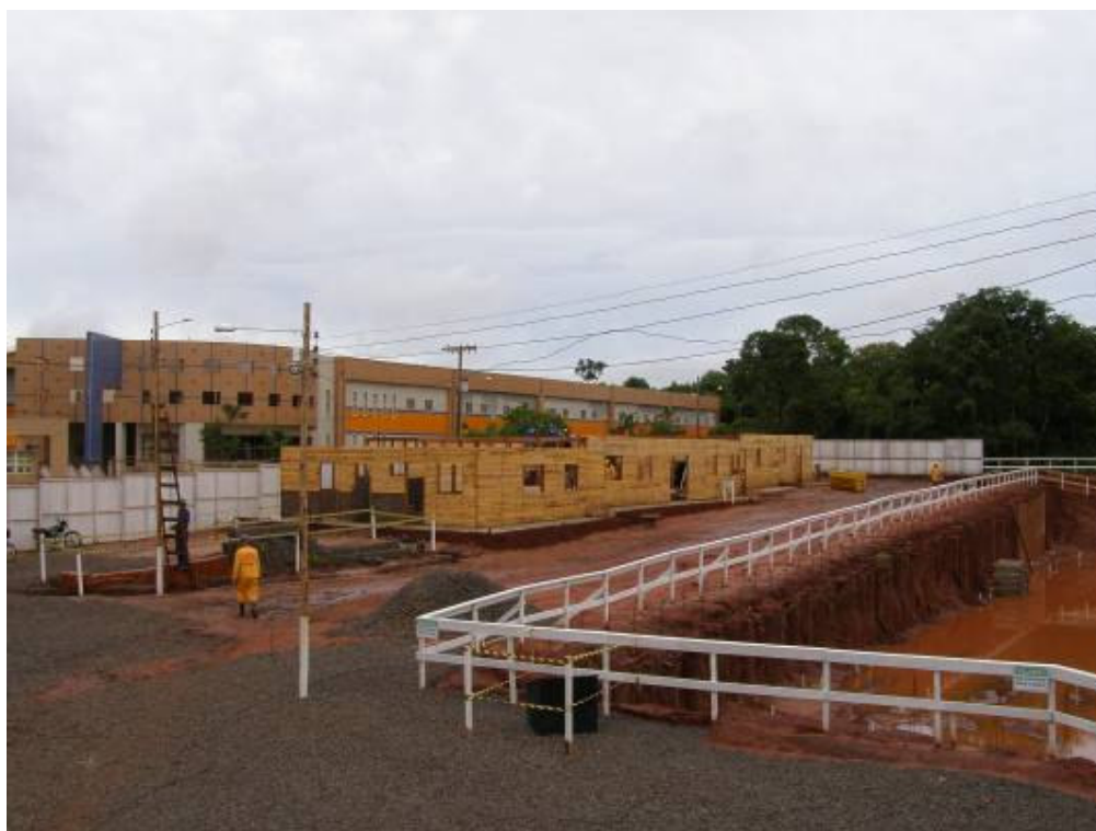
Vista do abrigo cozinha/refeitório/vestiário/banheiros
