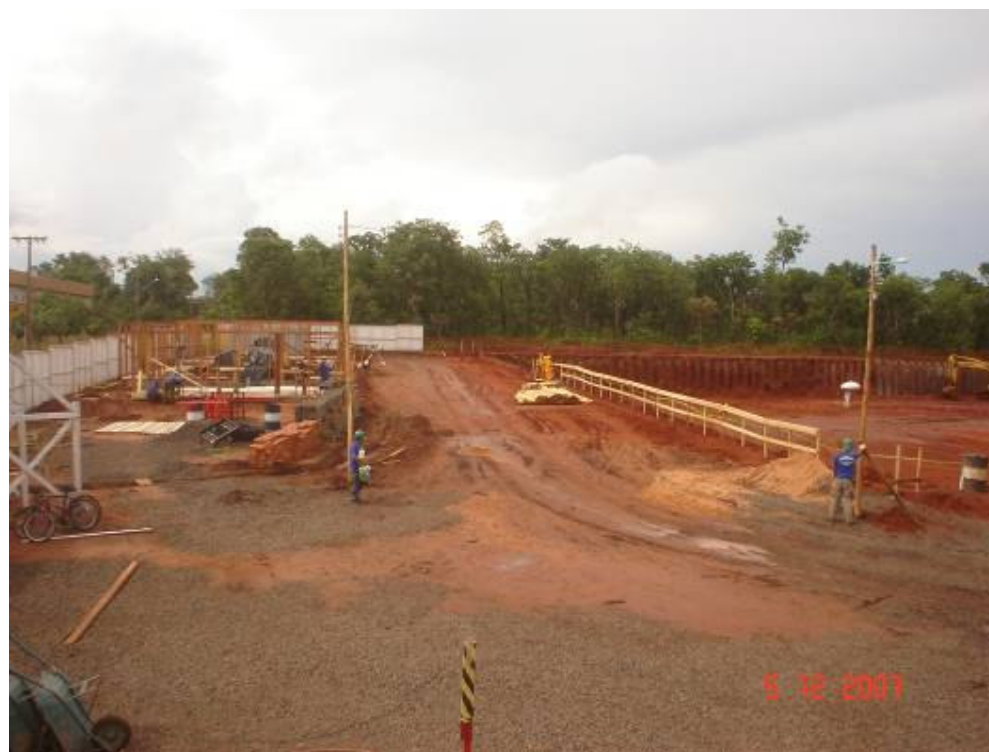
Rede elétrica interna, guarda-corpo de proteção do subsolo escavado e serviços do abrigo cozinha/refeitório/vestiário/banheiros
