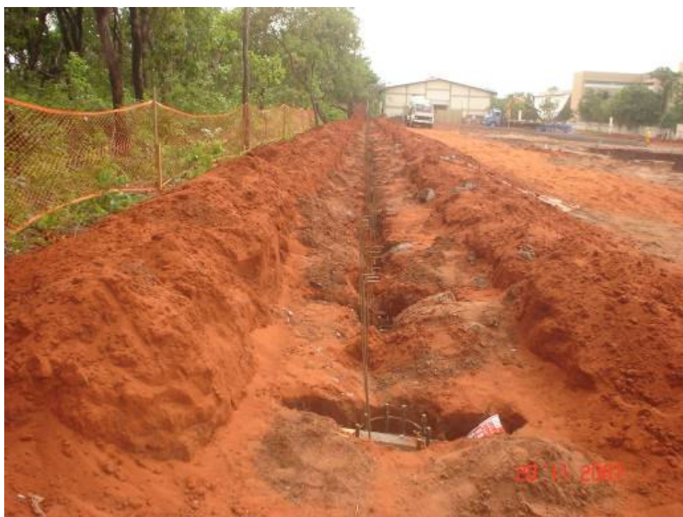
Estacas de contenção vista norte
