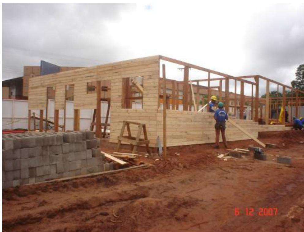
Fechamento do abrigo cozinha/refeitório/vestiário/banheiros
