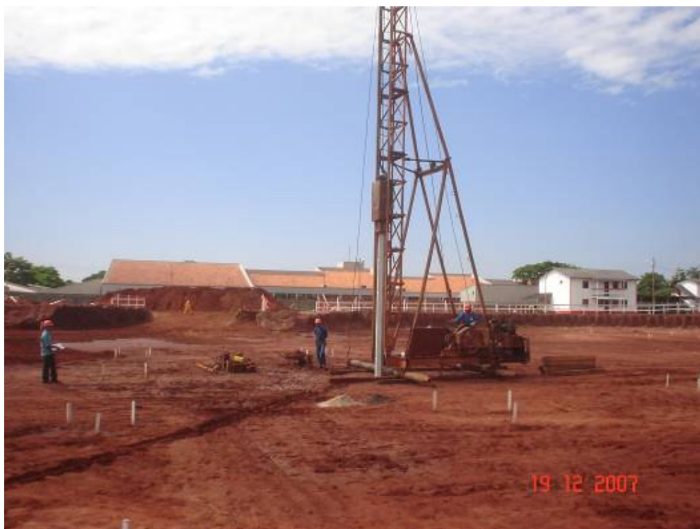
Cravação da primeira estaca pré-moldada de 8 metros, no bloco 48
