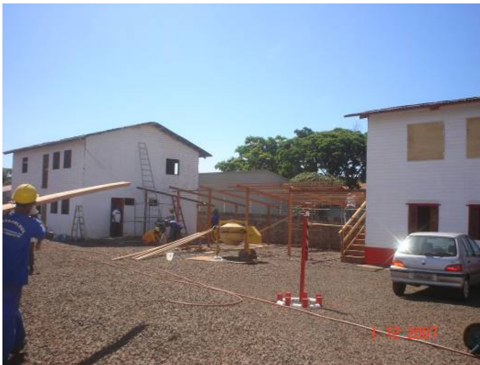
Vista dos abrigos da obra
