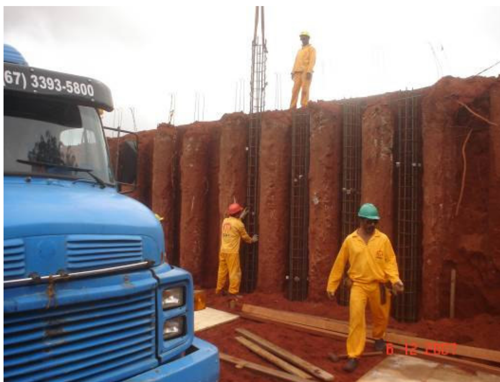
Colocação da ferragem no trecho das estacas de retenção contínua – vista oeste
