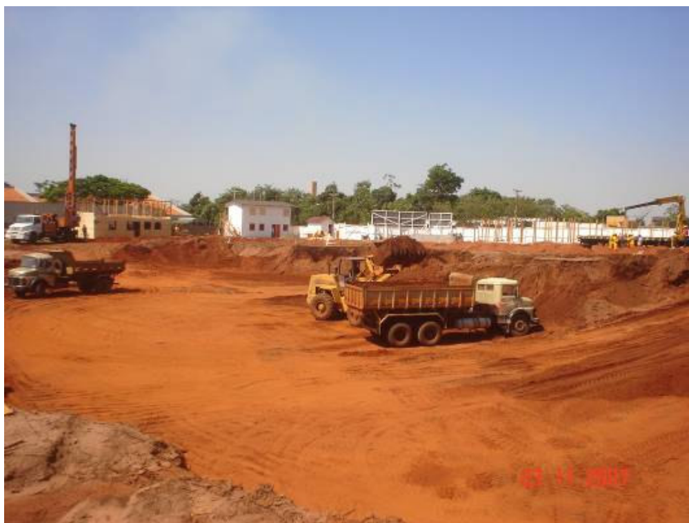
Desenvolvimento da escavação do subsolo e dos abrigos de obra
