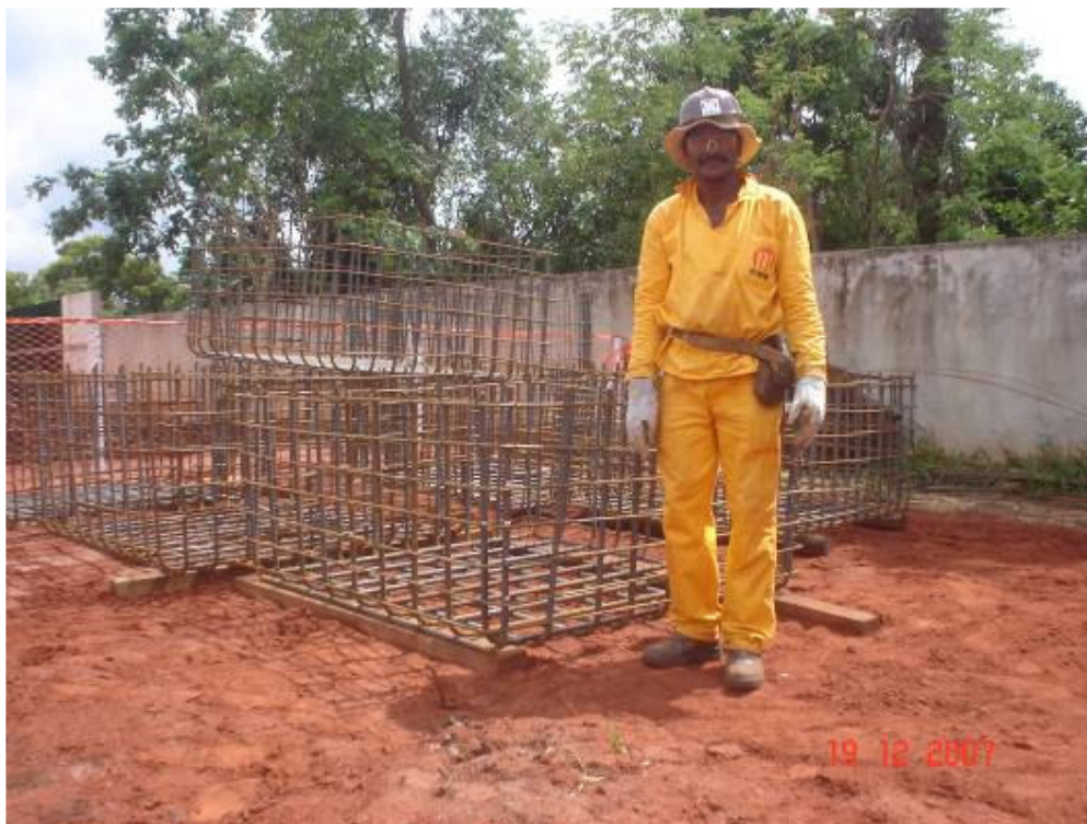
Armadura dos blocos para quatro estacas
