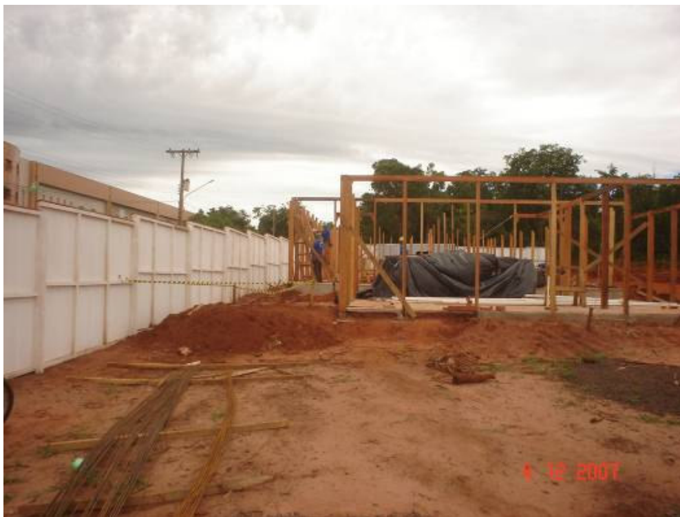
Vista do abrigo cozinha/refeitório/vestiário/banheiros
