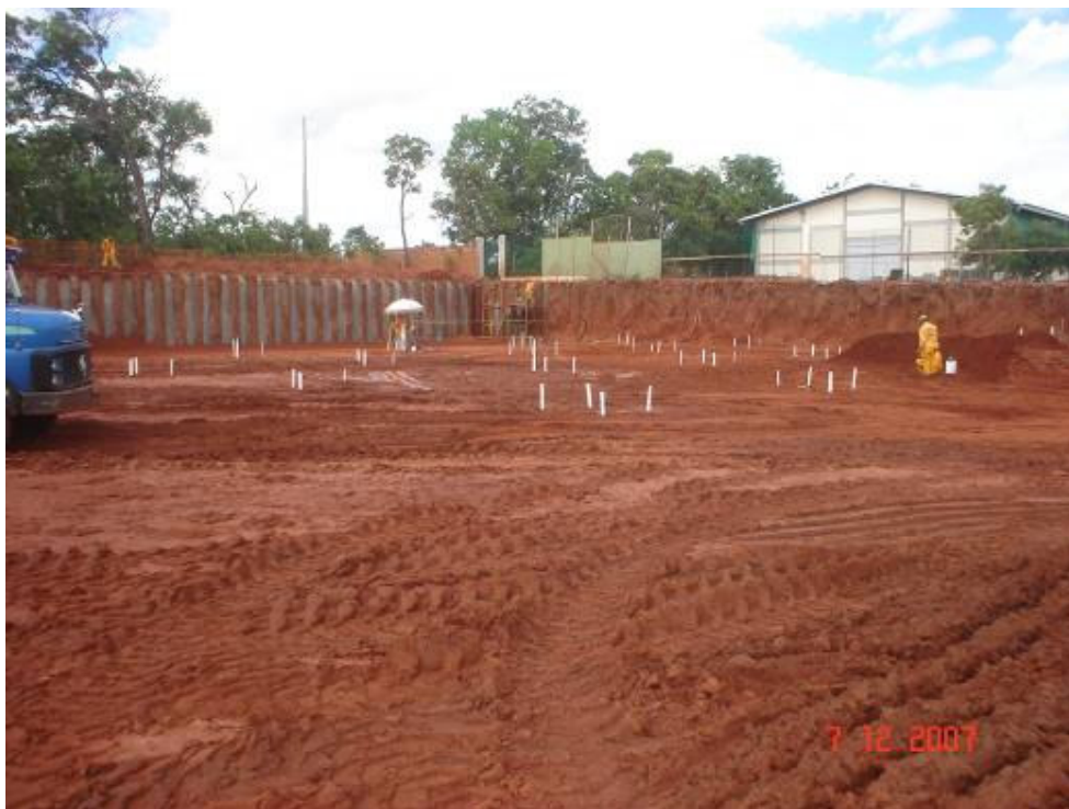
Serviço de topografia – locação dos pilares
