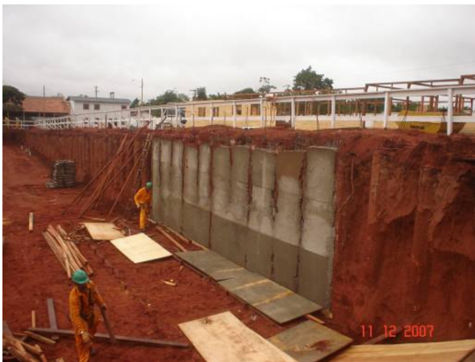
Retirada das fôrmas das estacas de contenção contínuas – vista oeste
