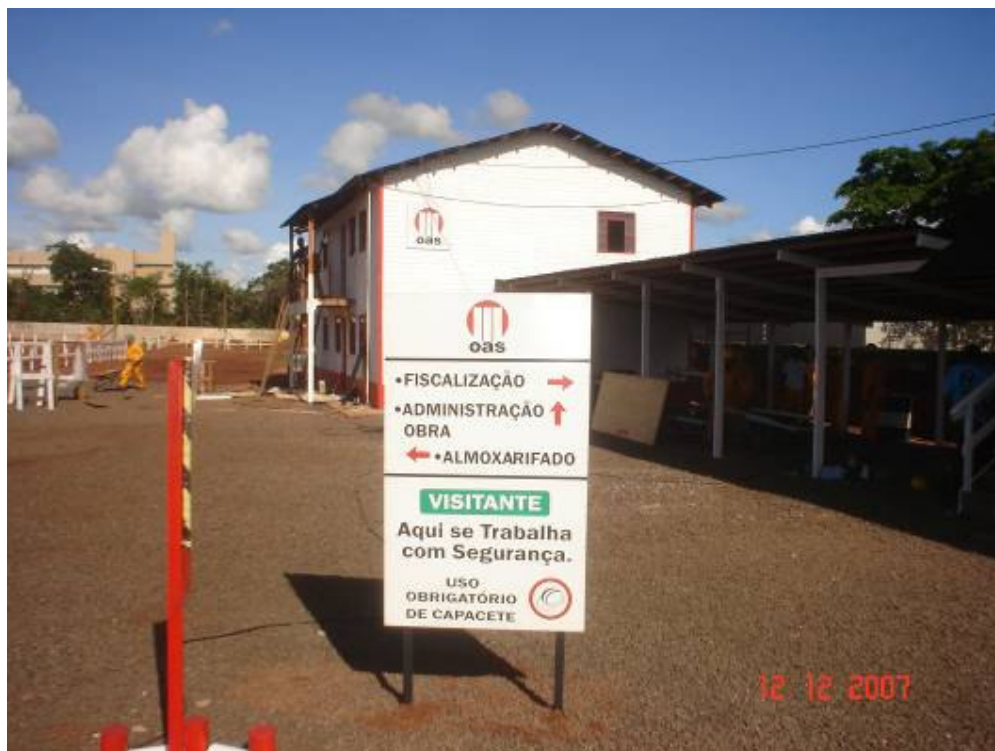
Colocação de placas de sinalização/segurança
