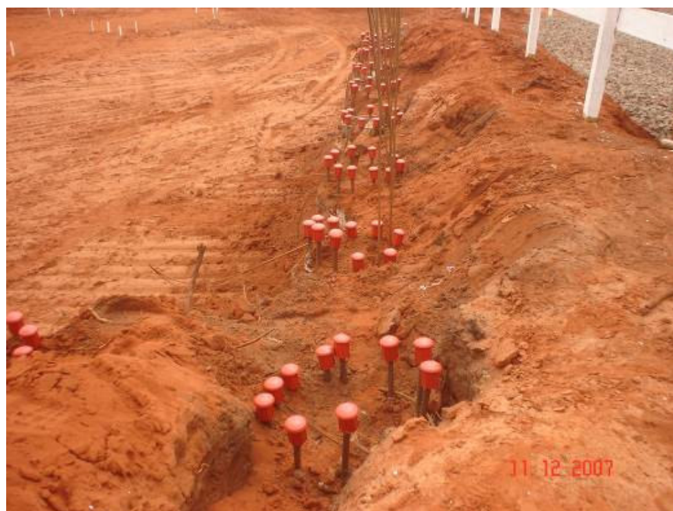
Proteção das pontas da armadura das estacas de contenção
