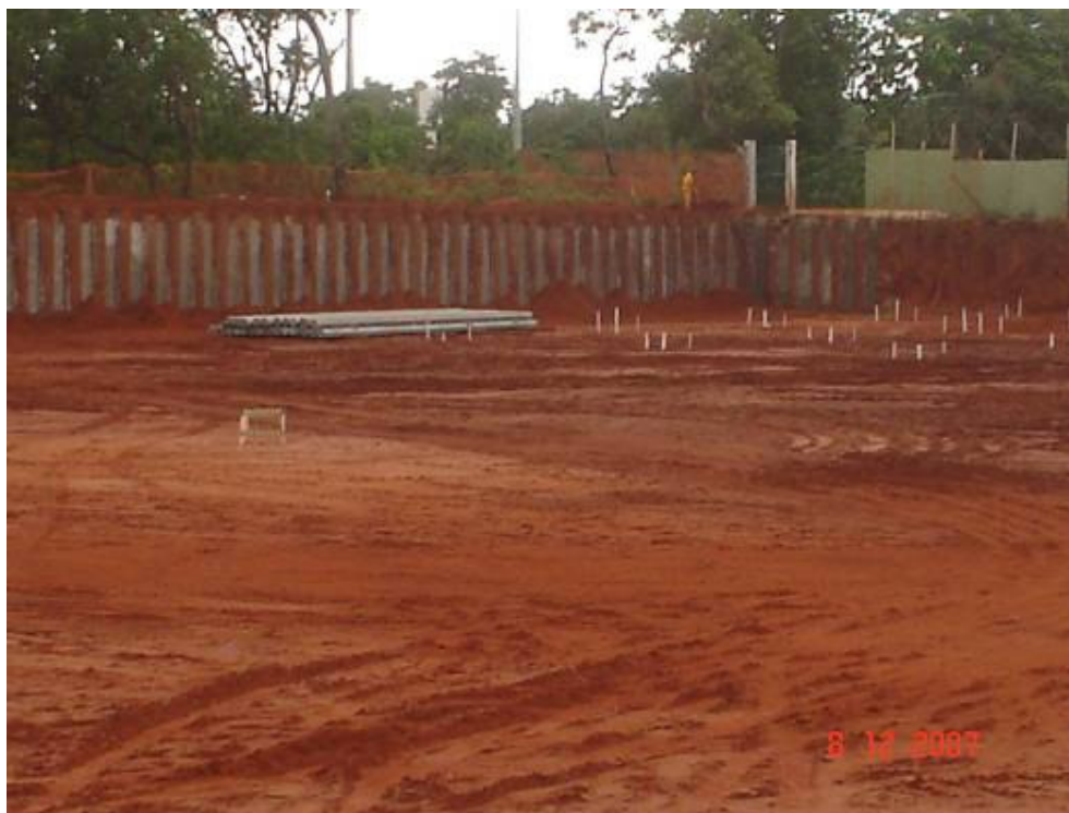
Primeira carga de estacas pré-moldadas
