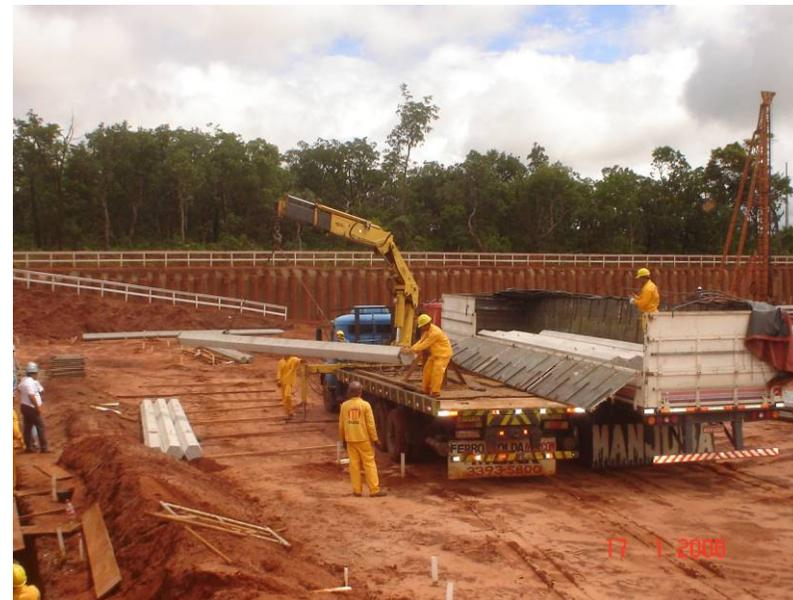
Detalhe da operação de descarga das estacas protendidas de 90 toneladas
