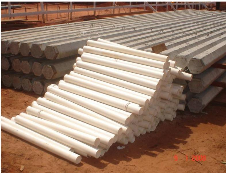
Detalhe da tubulação de drenagem e das estacas pré-moldadas da fundação
