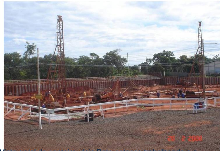
Vista geral do canteiro, dois Bate-estacas trabalhando e o terceiro sendo desmontado.
