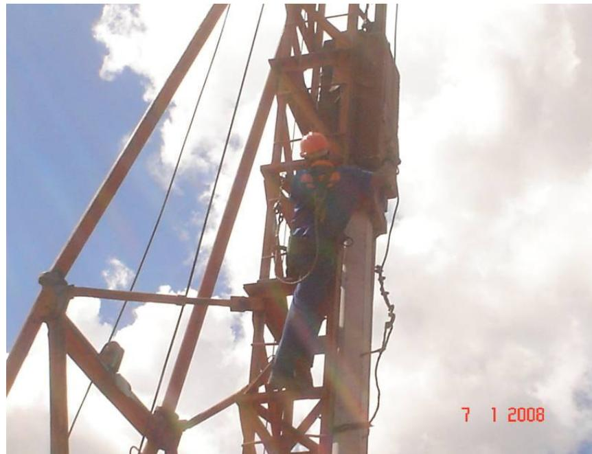
Detalhe do funcionário da Funsolos colocando a estaca em nível, operação necessária para iniciar o procedimento de cravação, note que o mesmo esta utilizando os EPIs necessários para esta tarefas.
