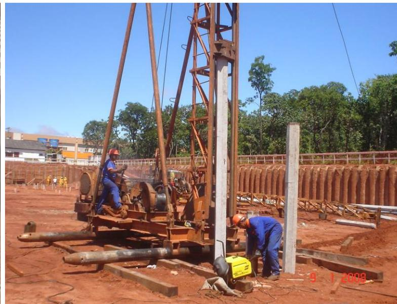
Detalhe da operação de soldagem entre as estacas.
