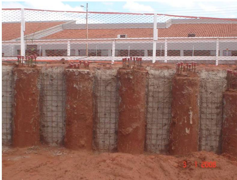
Detalhe da tela de aço sobre o chapisco e entre estacas de contenção
