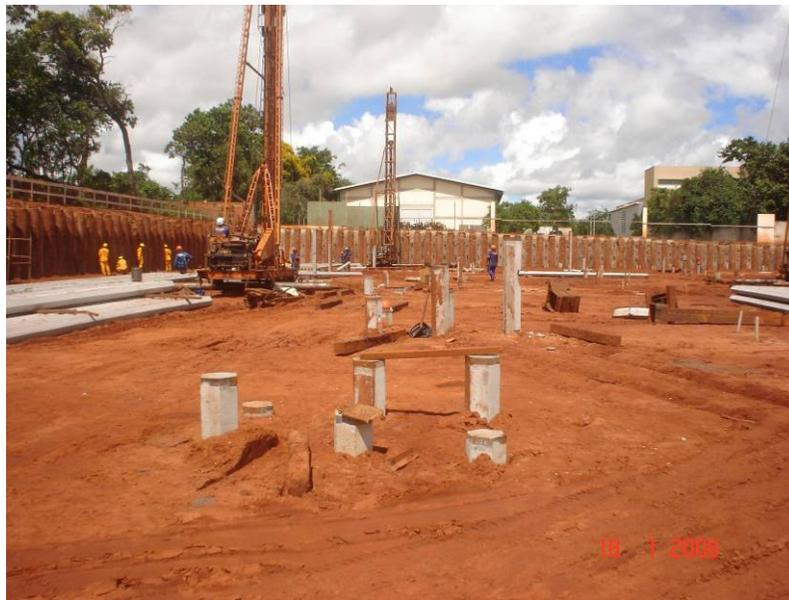
Detalhe das estacas cravadas ao fundo os bate-estacas prossequindo as cravações
