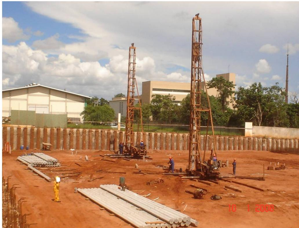
Detalhe dos dois Bate-estacas em operação (estacas de 40 e 50t)
