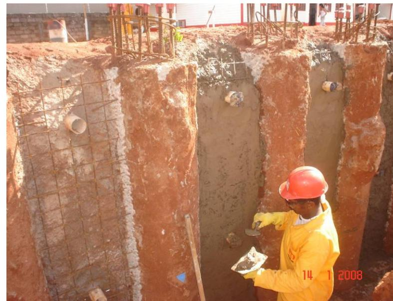
Detalhe do chapisco sobre a tela após a colocação dos tubos de drenagem (sistema de contenção)
