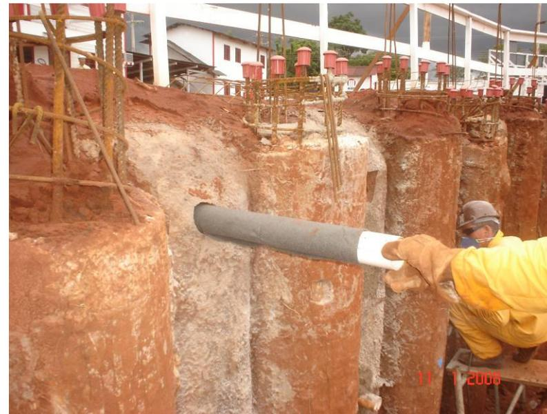
Detalhe do bidim revestindo a tubulação de drenagem com diâmetro de 75mm
