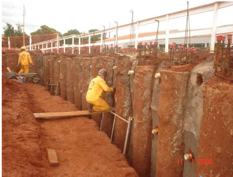
Detalhe da instalação da tubulação de drenagem do sistema de contenção.
