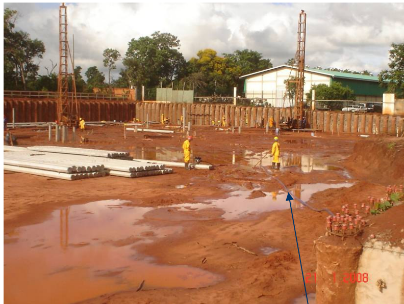
Chuva forte (20mm), retirada de água utilizando bomba, paralisação de duas horas.
