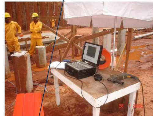
Equipamento de medição de energia transmitida do bate-estaca para a estaca, ligado aos sensores instalados neste elemento estrutural
