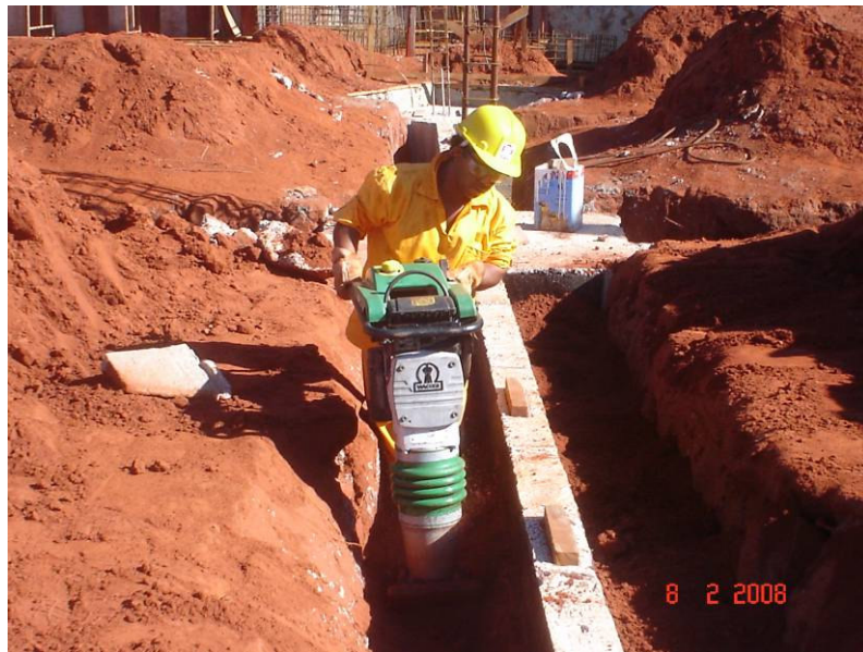
Detalhe do reaterro compactado dos baldrames após impermeabilização com Igol
