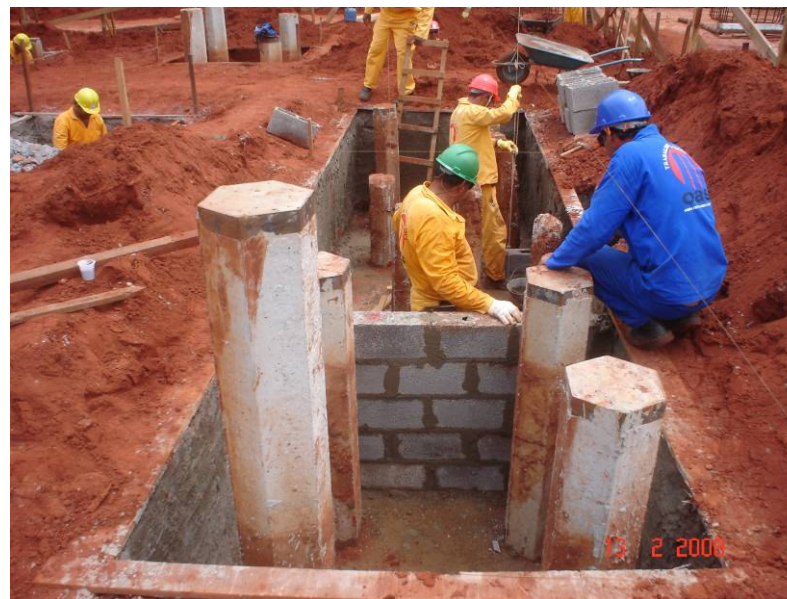
Detalhe de 3 blocos divididos por alvenaria de bloco de concreto, utilizando o método contra-barranco.
