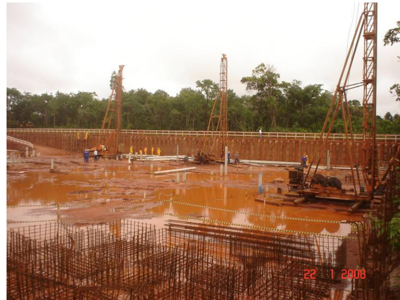
Chuva de 45mm no dia seguinte, solo totalmente encharcado (excedeu o limite de liquidez), comprometeu a produtividade das atividades (cravação de estacas, prosseguimento do sistema de contenção e armação das ferragens).
