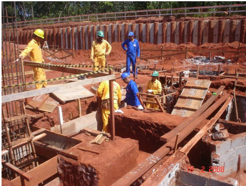
Execução de formas dos baldrames
