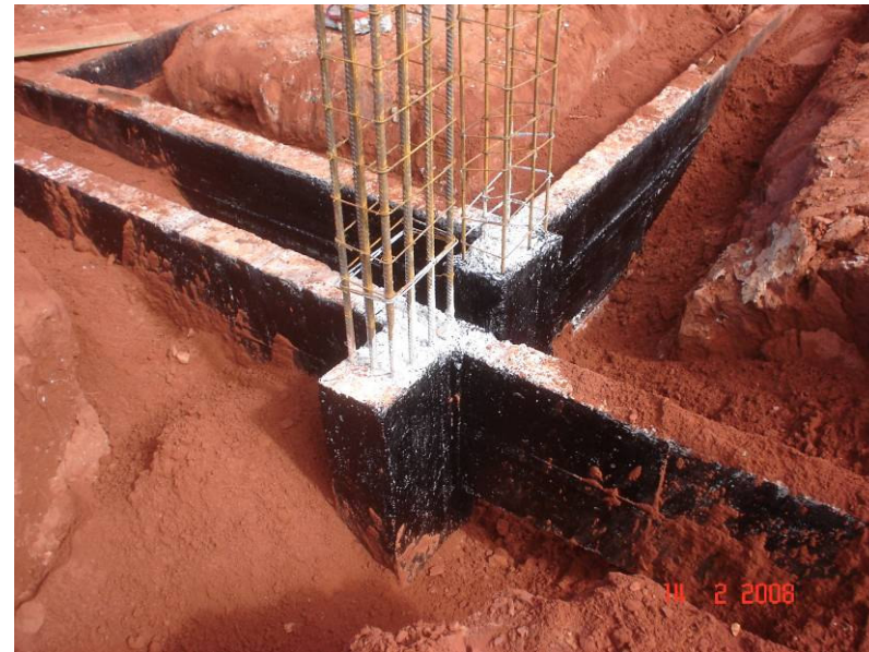
Baldrame concretado, impermeabilizado, reaterrado, compactado e com a ferragem dos pilares.
