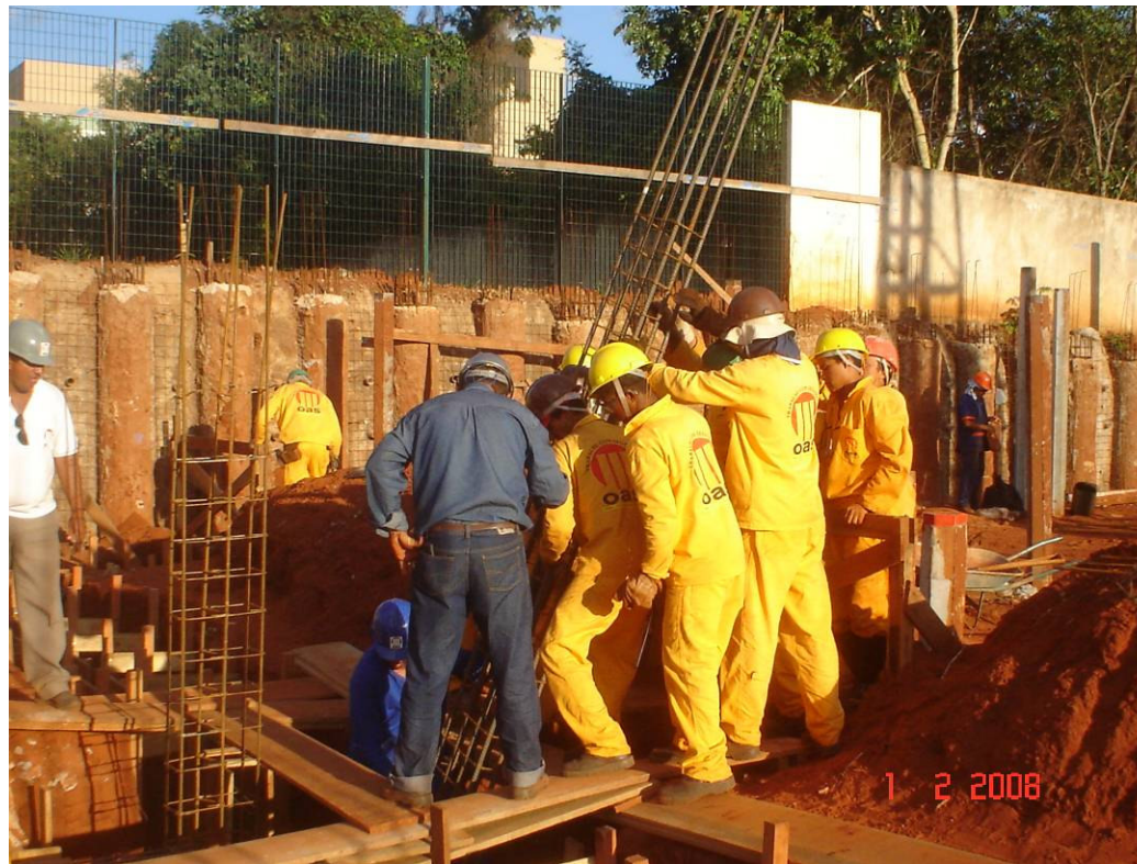
Detalhe da colocação da ferragem de um pilar (aprox. 300kg)
