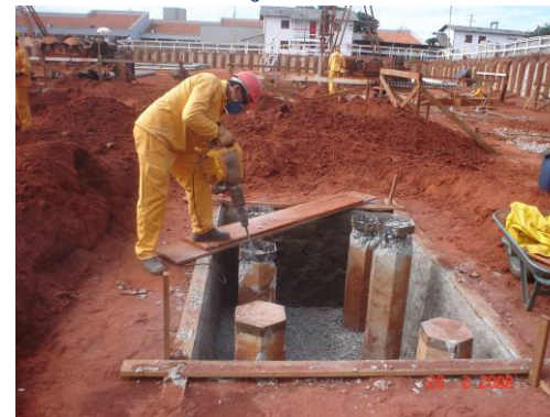
Retirada de cabeça de estacas com marteletores pneumáticos
