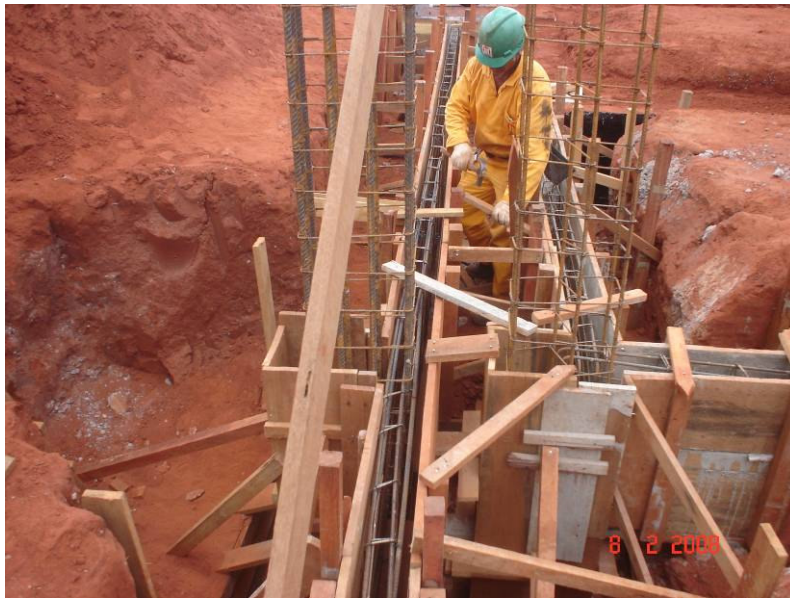
Travamento das formas do baldrame, antes da concretagem
