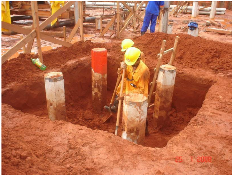
Escavação dos blocos de transição.
