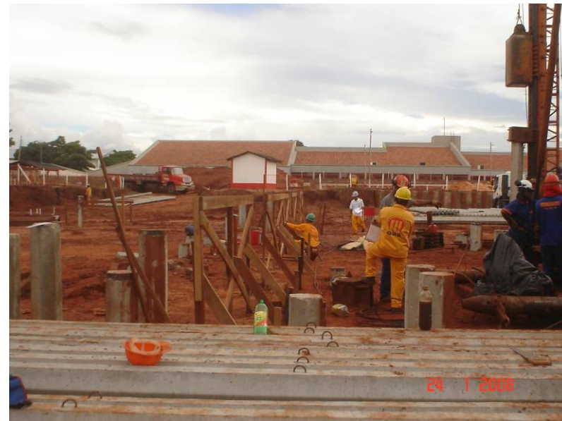
Montagem do gabarito de locação dos blocos e das vigas baldrames
