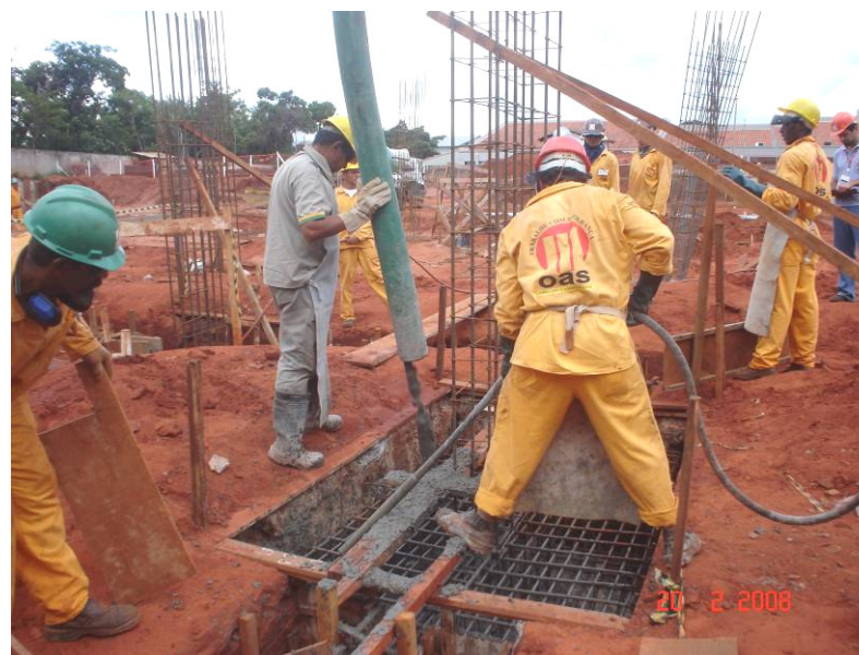
Detalhe do lançamento bombeado de concreto de um Bloco de transição
