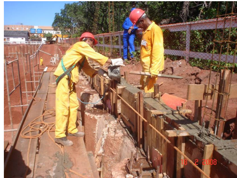
Concretagem da viga baldrame do muro de fechamento sobre as estacas escavadas do sistema de contenção.
