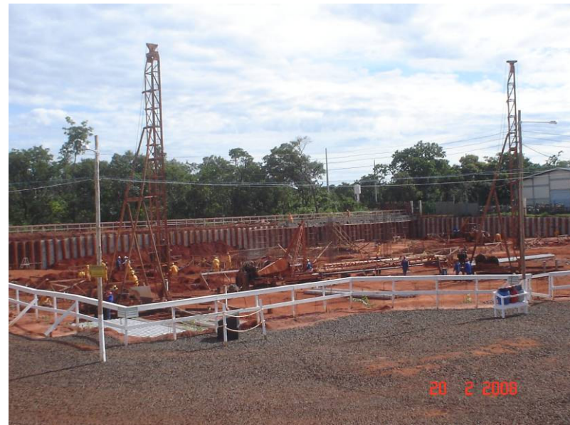
Vista geral do canteiro, dois Bate-estacas trabalhando e o terceiro sendo desmontado.
