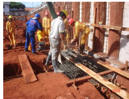
Lançamento de concreto bombeado e vibração nos blocos de transição
