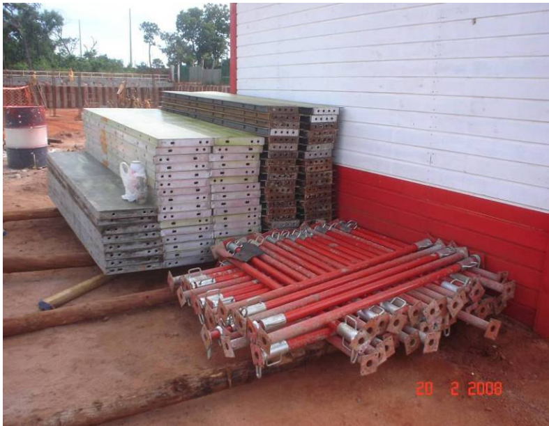
Detalhe das formas dos pilares e do seu contraventamento
