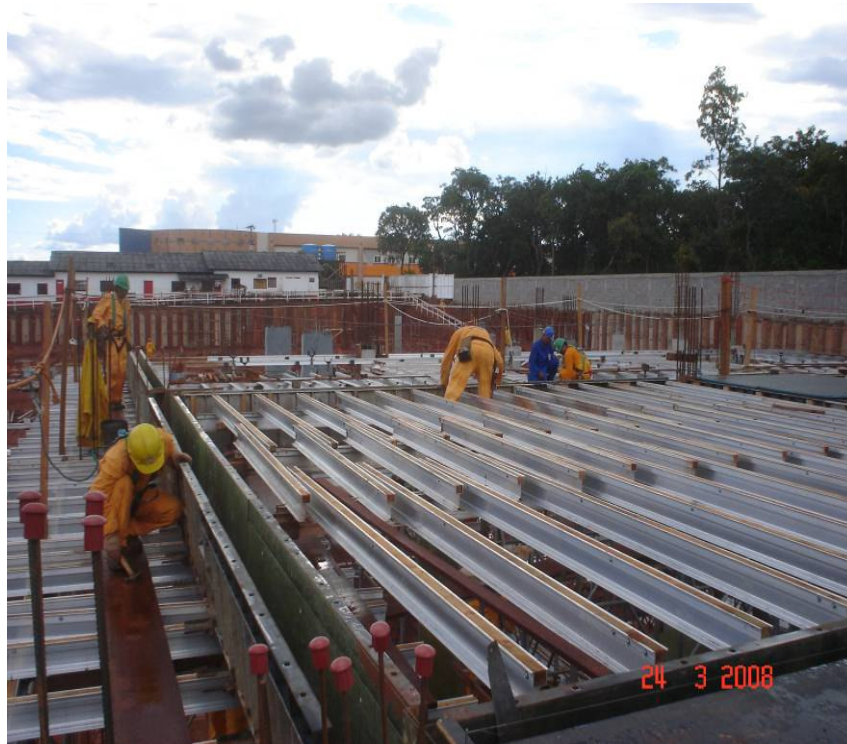
Prosseguimento na montagem da forma da 1ª laje
