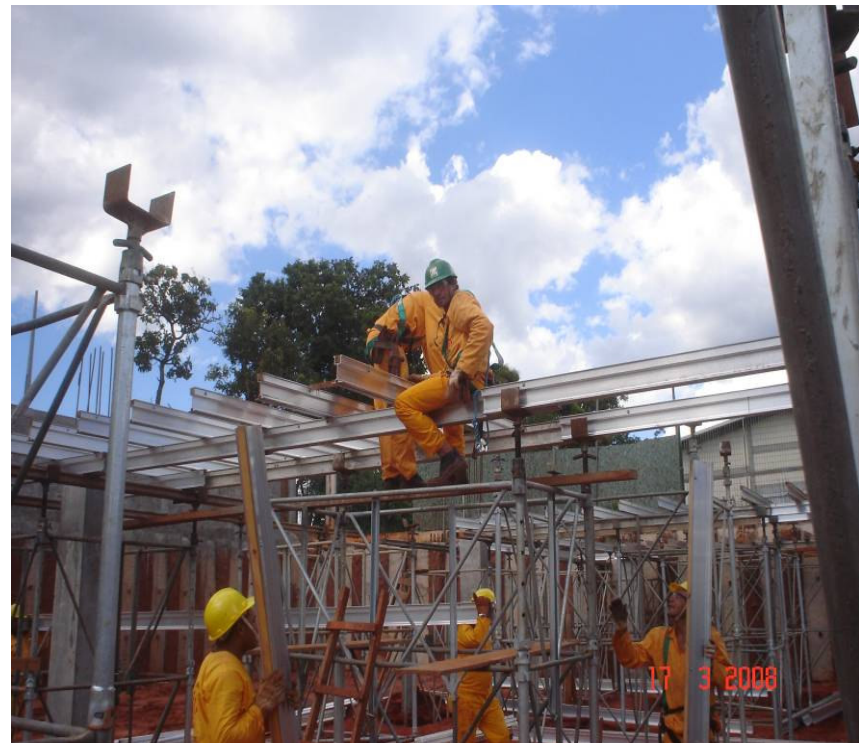
Detalhe da montagem do escoramento da 1ª laje, longarinas e transversinas em alumínio enrijecido.
