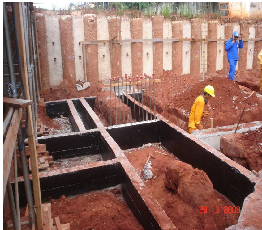
Concretagem da viga baldrame do muro de fechamento sobre as estacas escavadas do sistema de contenção.
