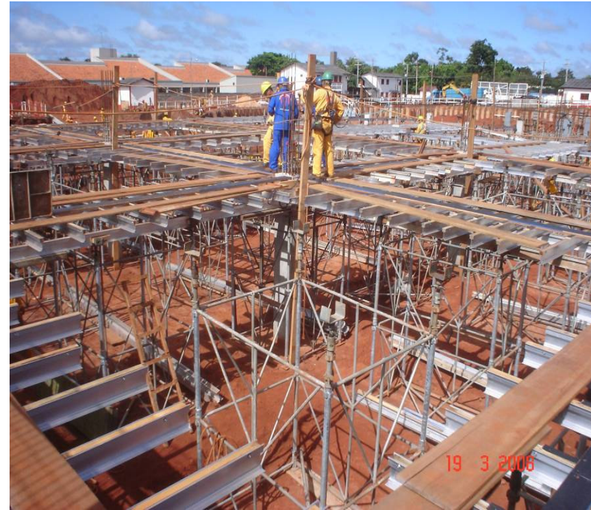
Montagem das longarinas e transversinas do escoramento da 1ª laje do prédio
