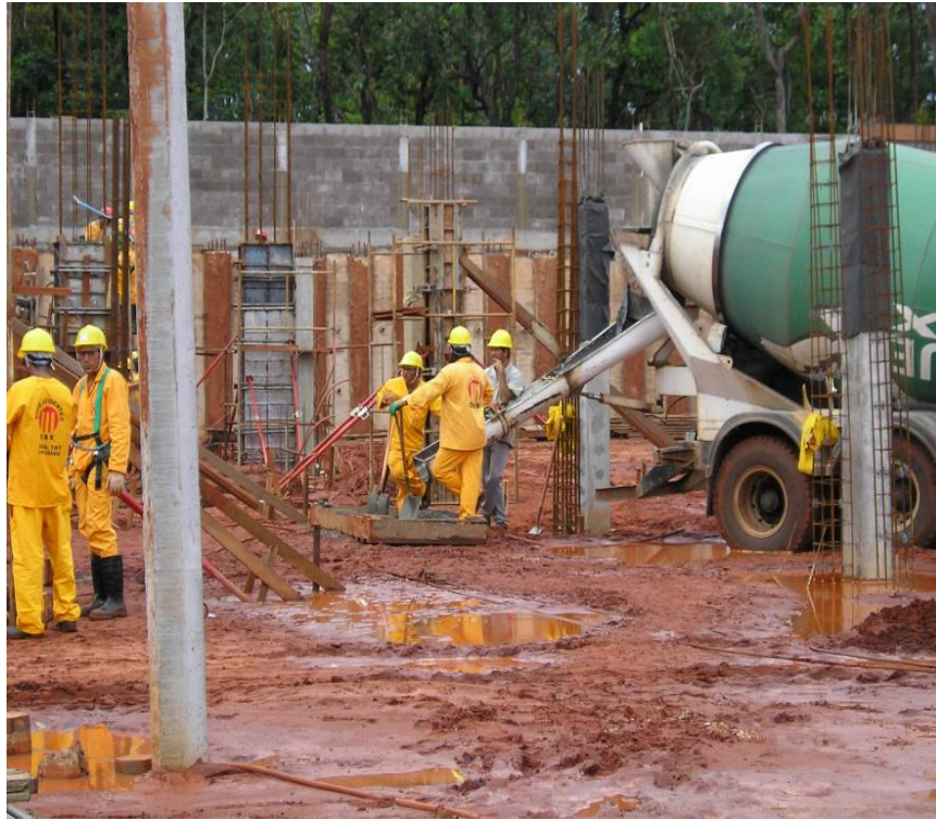
Concretagem dos pilares
