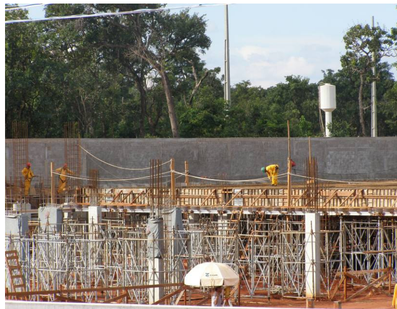
Detalhe da preparação da 1ª laje a ser concretada e o sistema de escoramento
