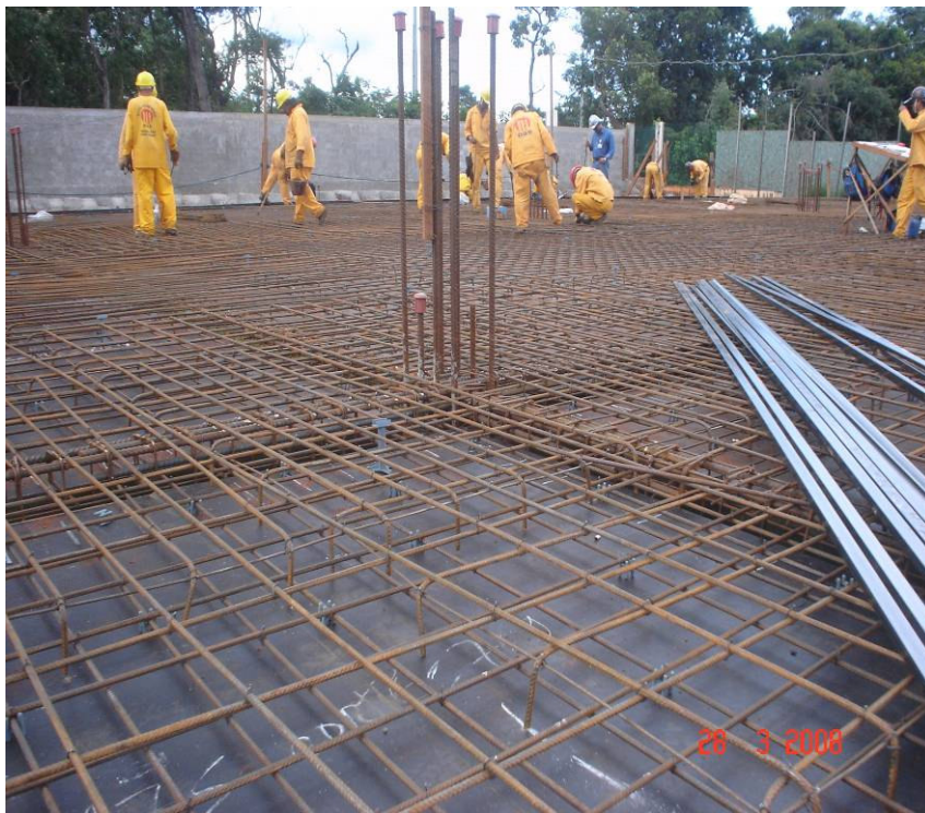
Detalhe das réguas de alumínio para garantir o nível da laje
