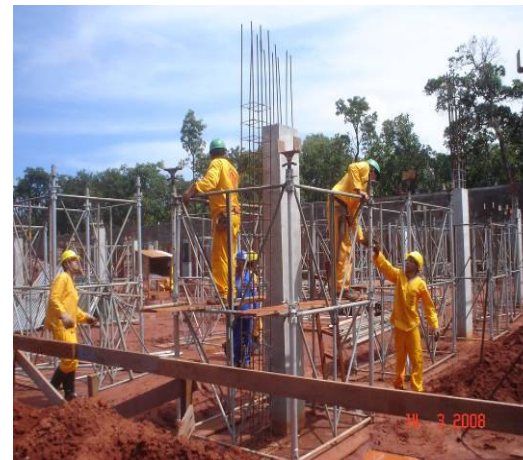
Prosseguimento na montagem do sistema de cimbramento
