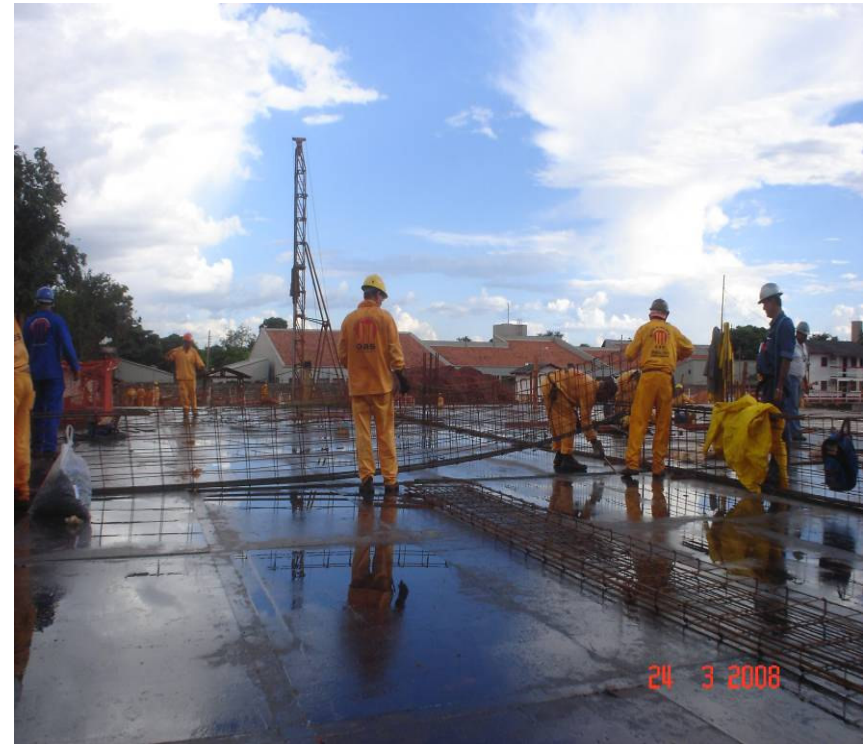
Colocação das ferragens das vigas da 1ª laje
