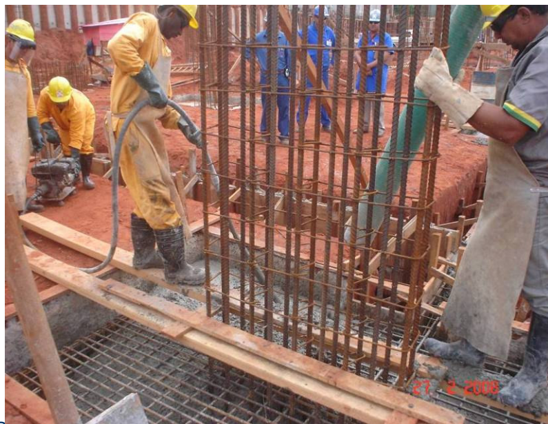
Detalhe da concretagem de um bloco de transição utilizando bomba e processo de vibração com vibrador a gasolina
