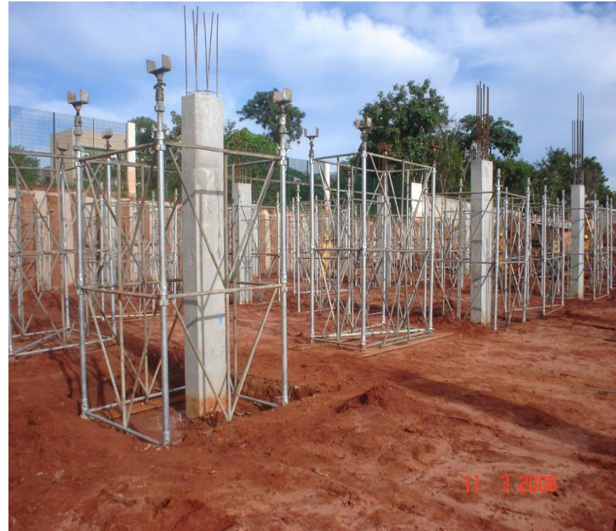
Início da montagem do escoramento da laje
