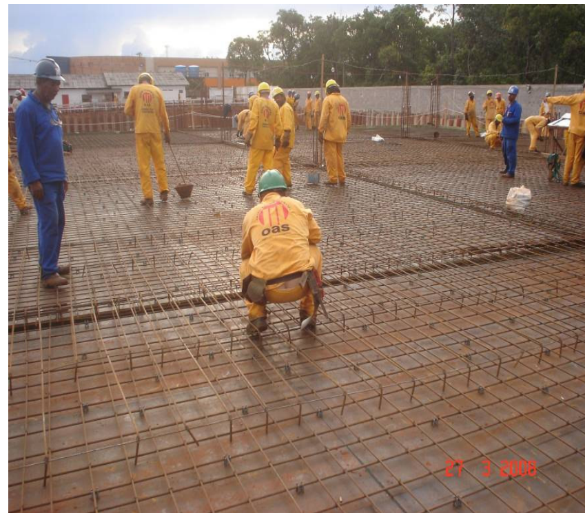
Colocação da armadura negativa da 1ª laje, limpeza e conferência para a liberação da concretagem
