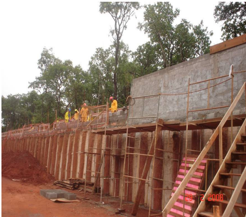
Construção do muro da fachada norte
