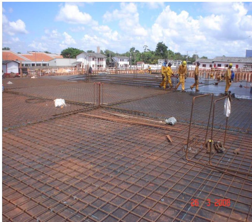
Colocação da armadura positiva da 1ª laje
