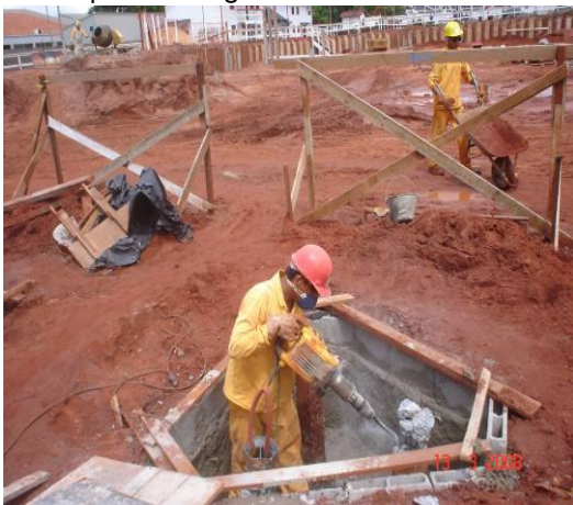
Preparo das cabeças de estacas
