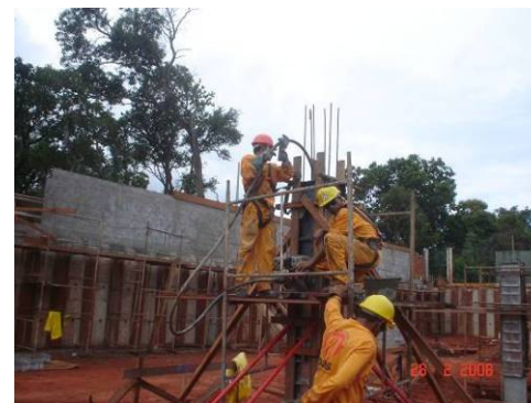
Processo de vibração do concreto de um pilar utilizando vibrador com mangote.
