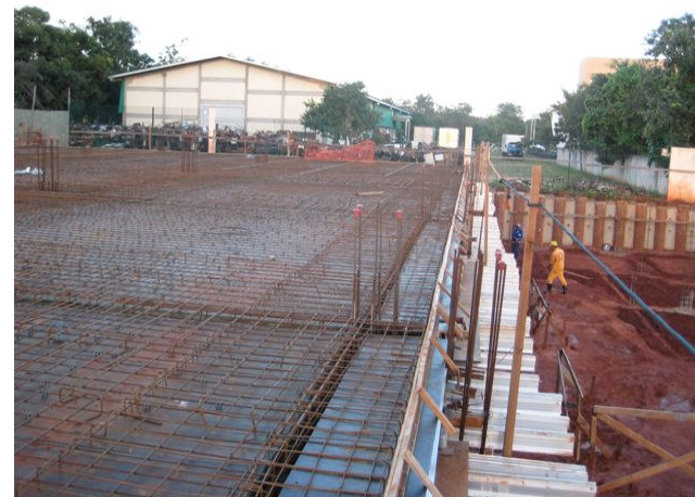
Detalhe da laje esperando a liberação da concretagem
