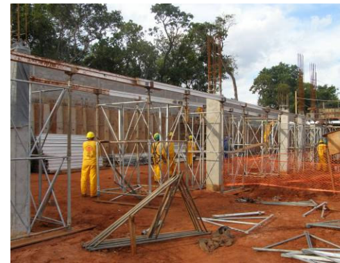
Sistema de forma e cimbramento
