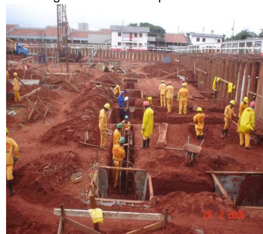
Escavação, preparo das cabeças das estacas, cravação de estacas e chapisco contra barranco
