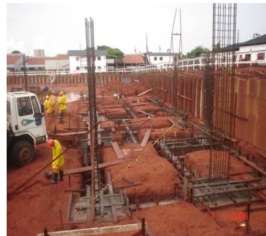
Finalização da concretagem dos baldrame e blocos do trecho B
