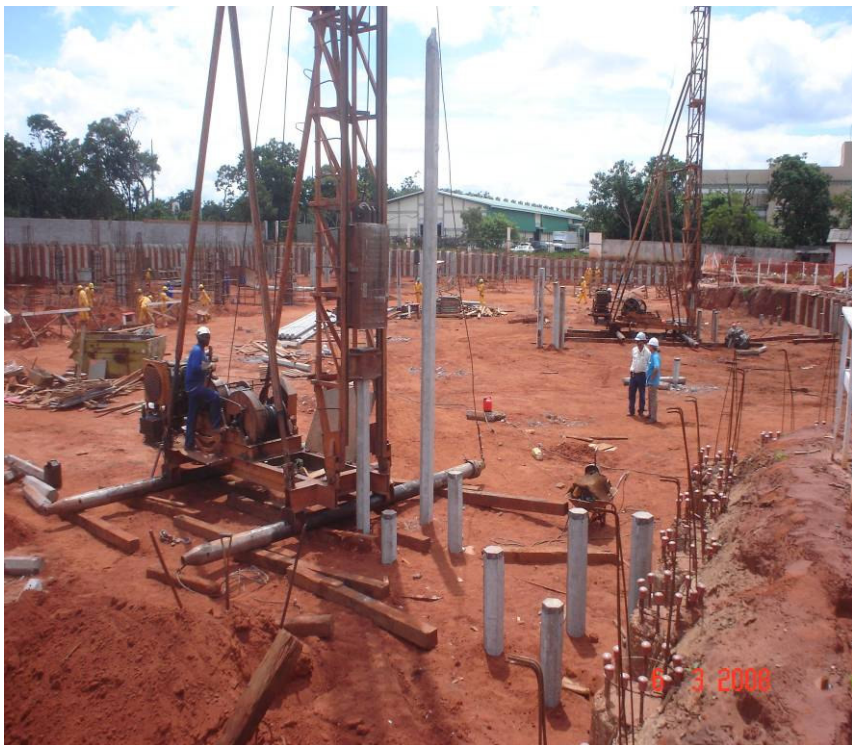
Prosseguimento nas cravações de estacas
