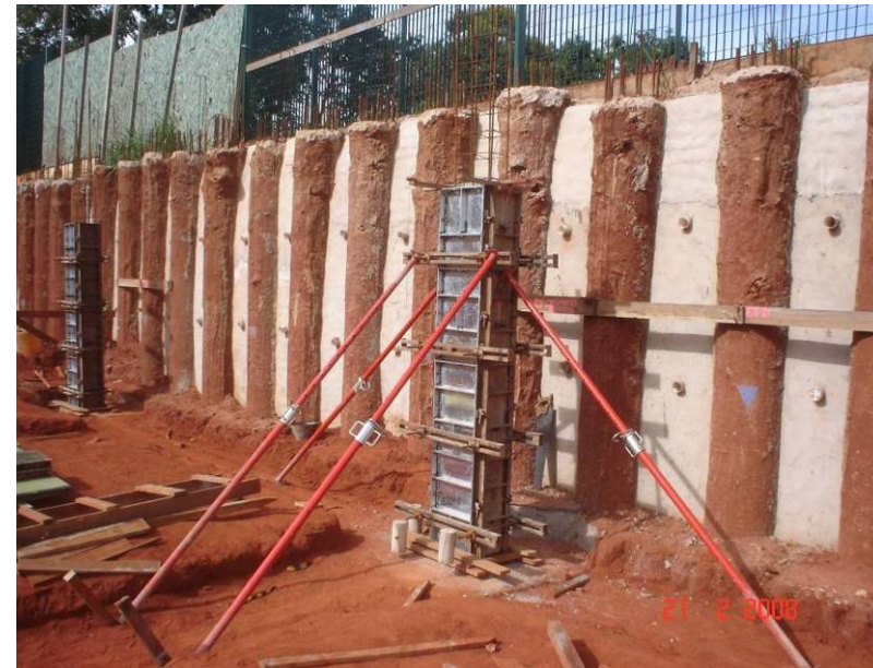
Detalhe do sistema de forma metálica montado
