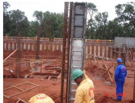
Montagem de fôrma de pilar
