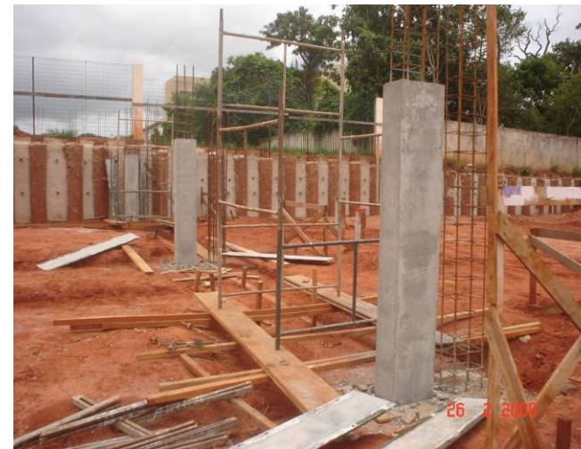
Detalhe da destôrma dos pilares
