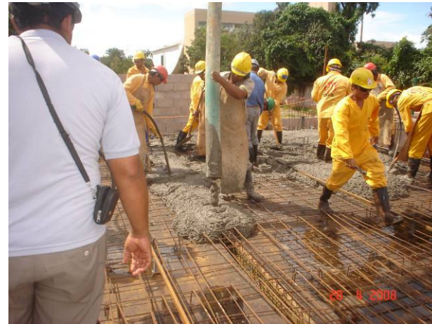
Operador da tromba controlando o lançamento do concreto na viga; ao fundo, observa-se o processo de vibração
