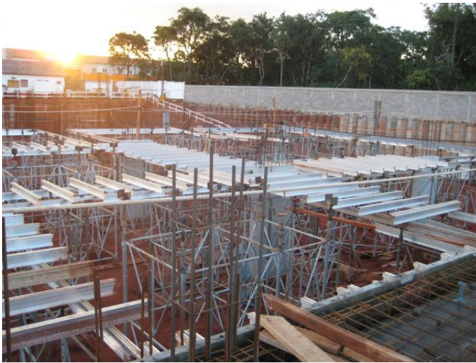
Montagem do escoramento da junta B
