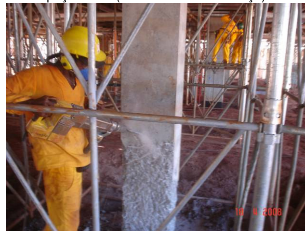
Retirada do cobrimento de concreto dos pilares para adicionar nova armadura (reforço estrutural)
