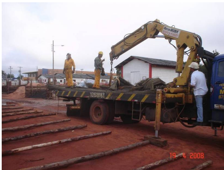
Chegada de barras de ferro para o reforço da estrutura
