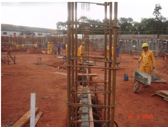
Concretagem com carriola dos baldrames da junta D
