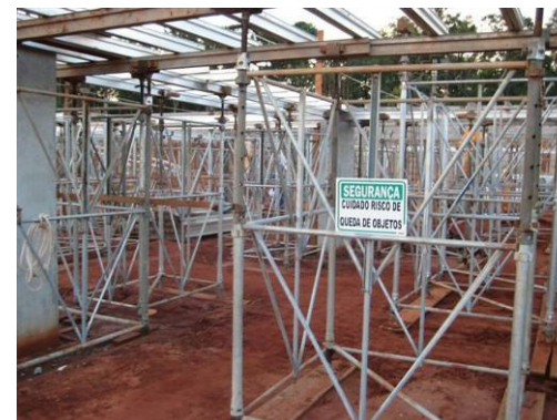
Sistema de escoramento
