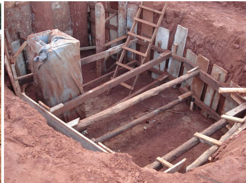
Sistema de contenção da caixa de armazenamento
