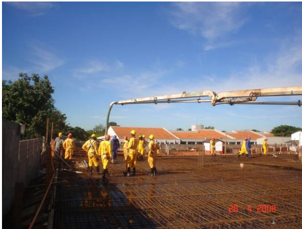
Lançamento do concreto com bomba
