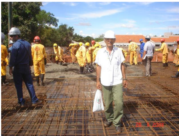
Engº Bitencourt, fiscal da obra verificando a concretagem. Ao fundo, verifica-se a realização dos serviços de espalhamento e adensamento do concreto.
