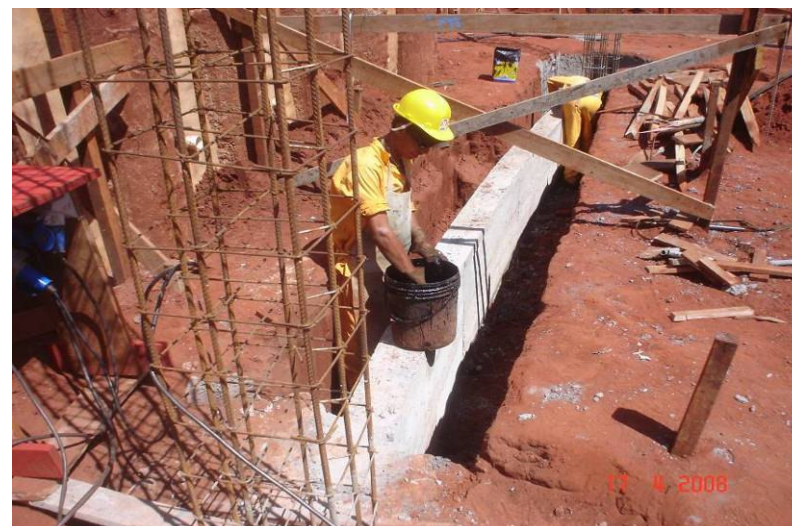
Impermeabilização dos baldrames com emulsão asfáltica
