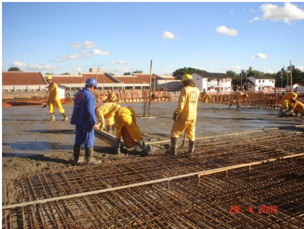
Desempenamento (acabamento) do concreto
