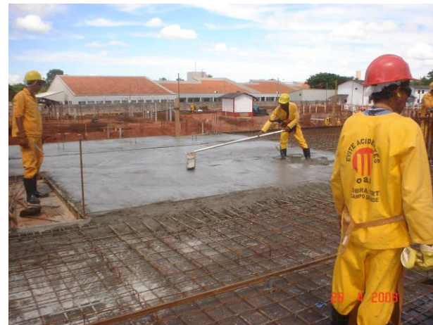
Acabamento do concreto (pé de pato), sarrafeamento com régua.
