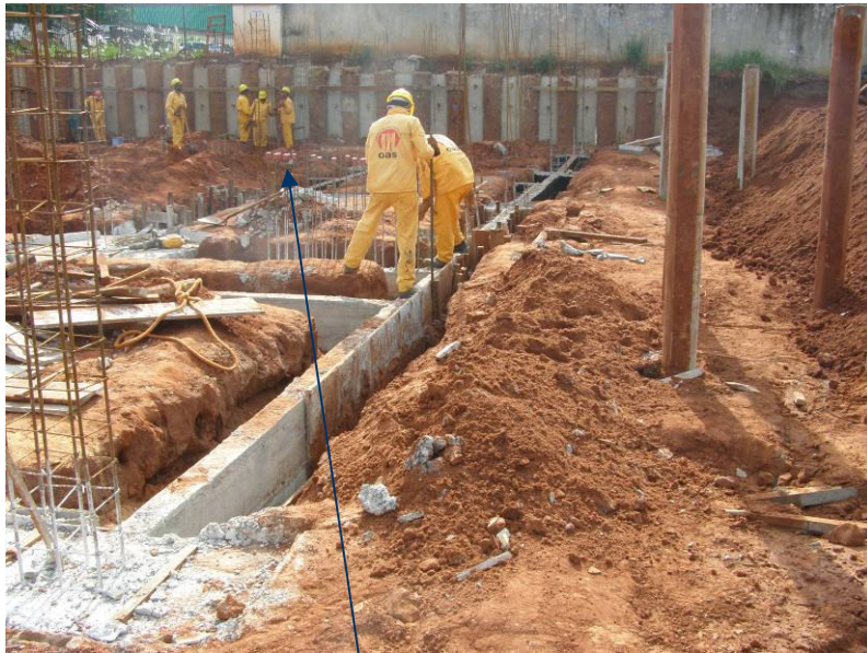
Instalação de protetores de plástico para ponta de ferro nos arranques da escada.
