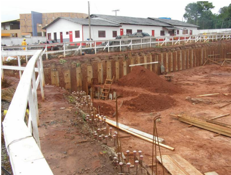
Escavação da caixa de armazenamento de águas pluviais
