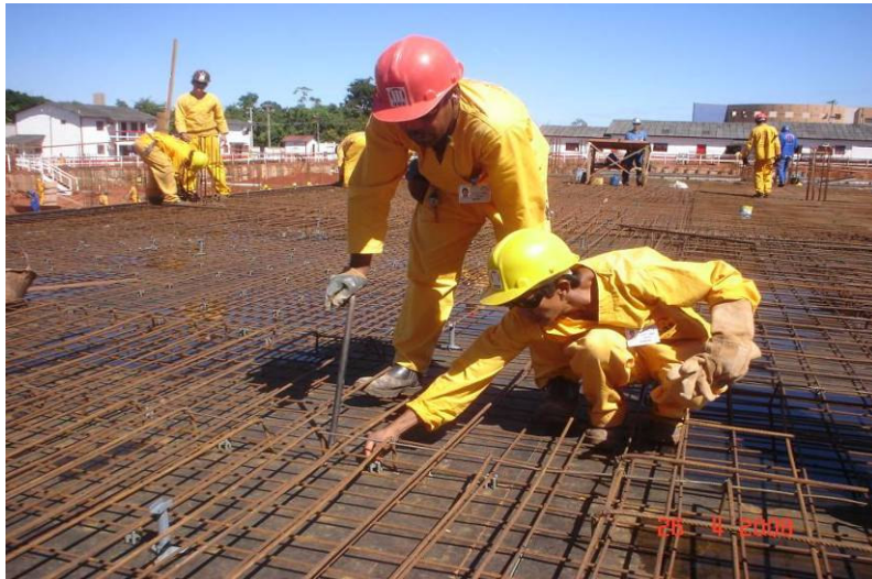
Últimos preparativos para a concretagem, colocação das “cadeirinhas” da armadura positiva.
