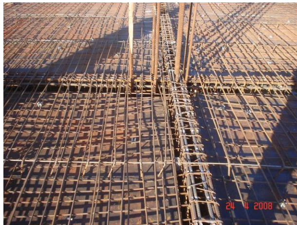
Laje e viga após o reforço de aço
