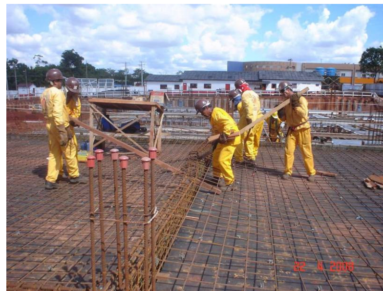
Processo de levantamento de armadura das vigas para o reforço da ferragem positiva
