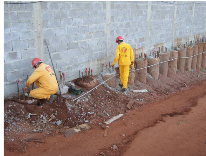
Colocação de protetores para as pontas de ferro das estacas de contenção
