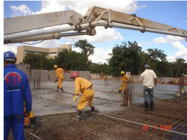
Detalhe da concretagem
