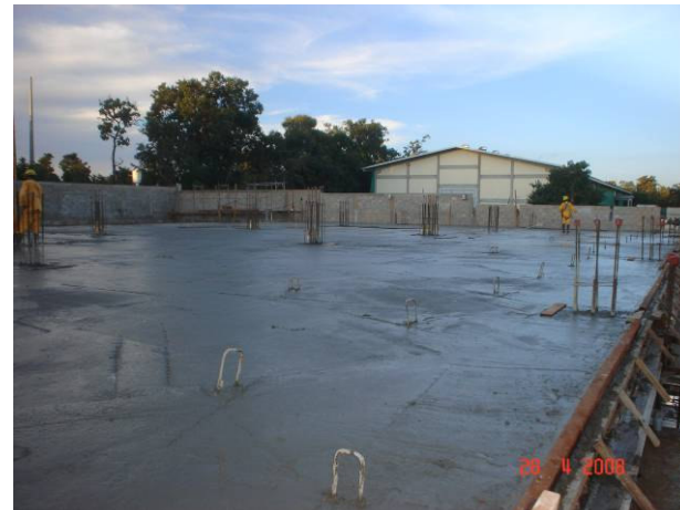
Final da concretagem e início do processo de cura
