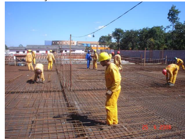
Recolocação da armadura negativa com os espaçamentos reduzidos.
