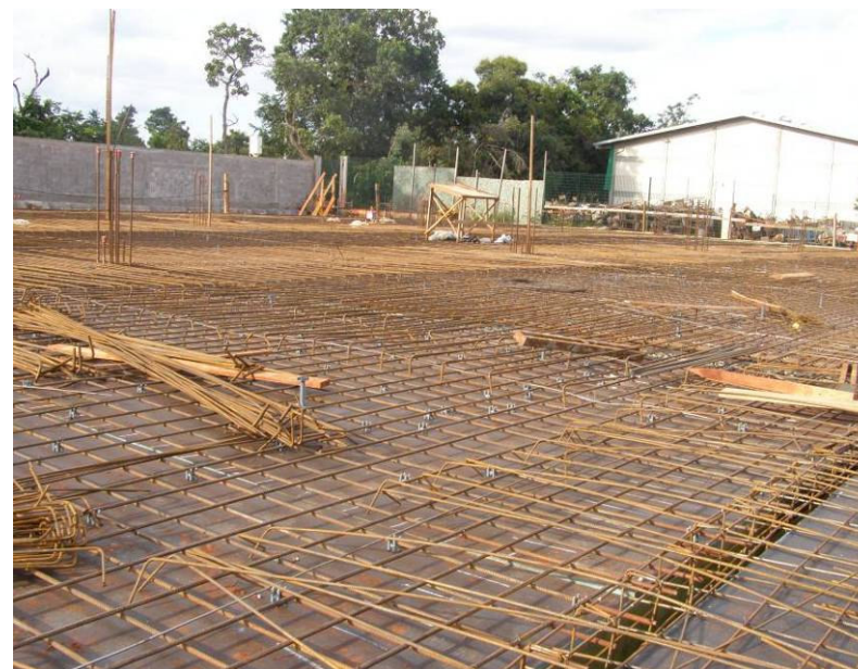
Detalhe da Armação da 1ª laje
