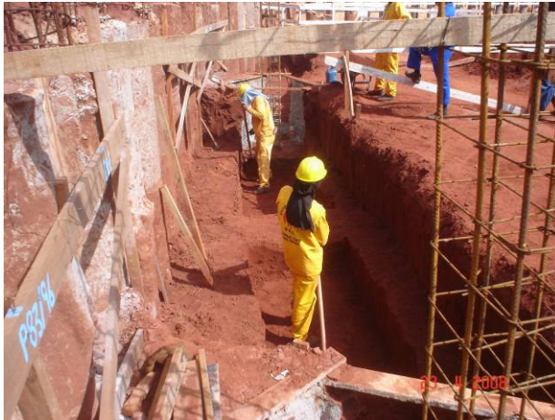
Abertura dos baldramas na região do auditório central
