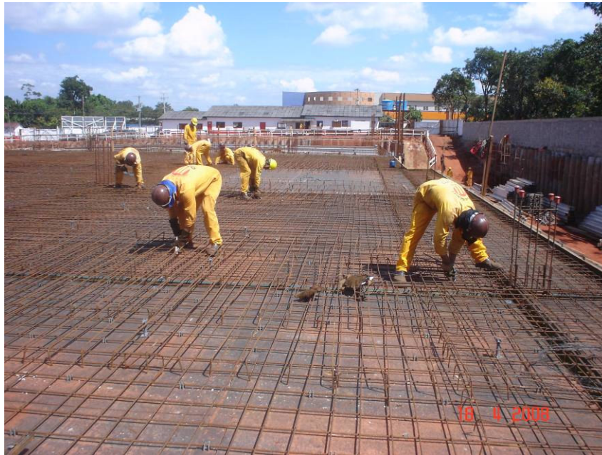
Início do reforço da laje do trecho C (região da biblioteca)
