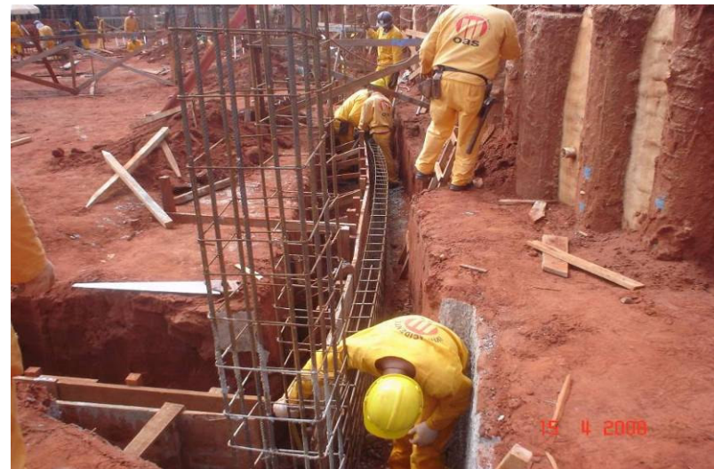
Colocação da ferragem de viga baldrame
