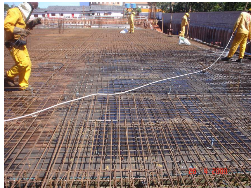
Limpeza da laje antes da concretagem
