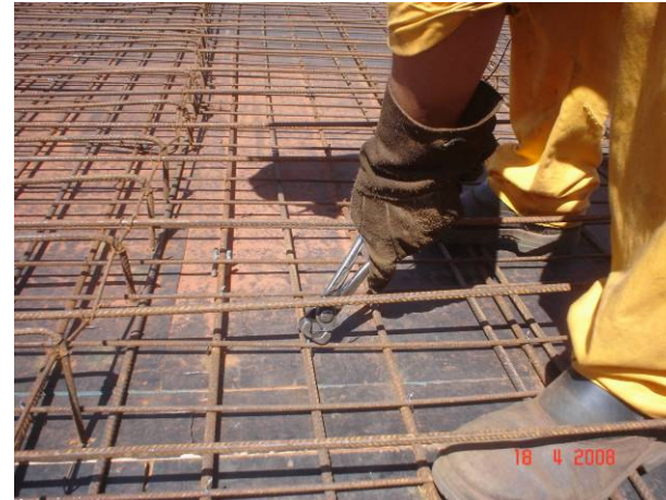
Retirada da ferragem para diminuição do espaçamento (aumento da taxa de aço)
