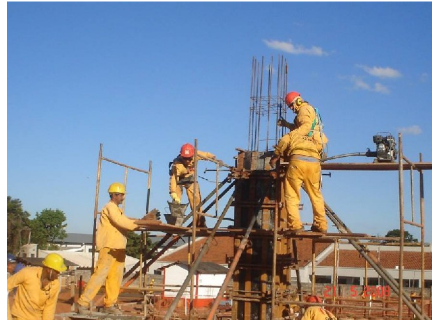
Concretagem dos pilares do 1º teto trecho A, utilizando vibrador a gasolina e lançamento manual (balde).
