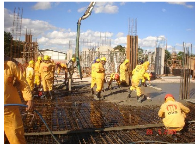
Detalhes da concretagem da laje do trecho A, junta A, lançamento, adensamento, acabamento, limpeza e nivelamento.
