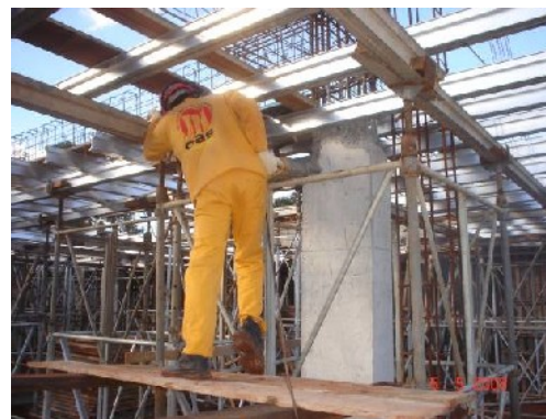
Sistema de escoramento
