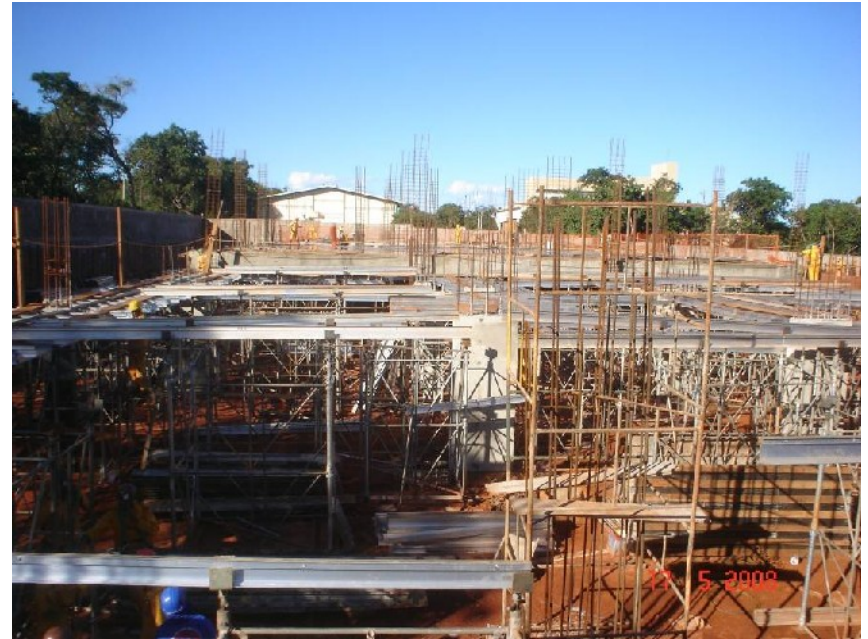
Segue a montagem do sistema de escoramento da junta A
