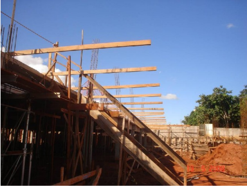
Início da construção da 1ª bandeja
