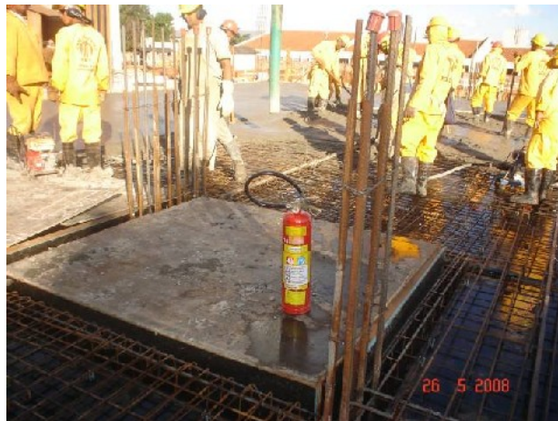
Detalhes da concretagem da laje do trecho A, junta A, lançamento, adensamento, acabamento, limpeza e nivelamento.
