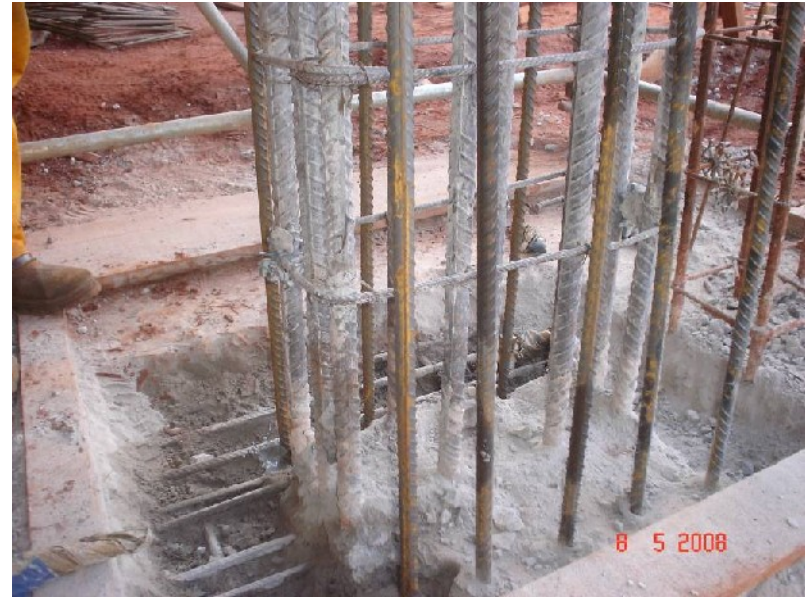
Pilar com o reforço de armadura (ferragem mais escura)
