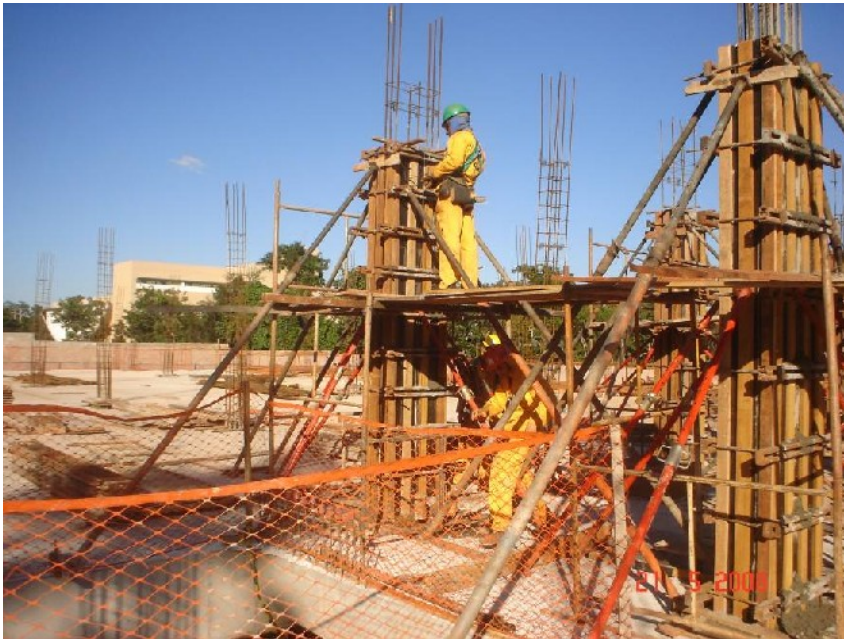
Travamento dos pilares e conferências de prumo e ferragens
