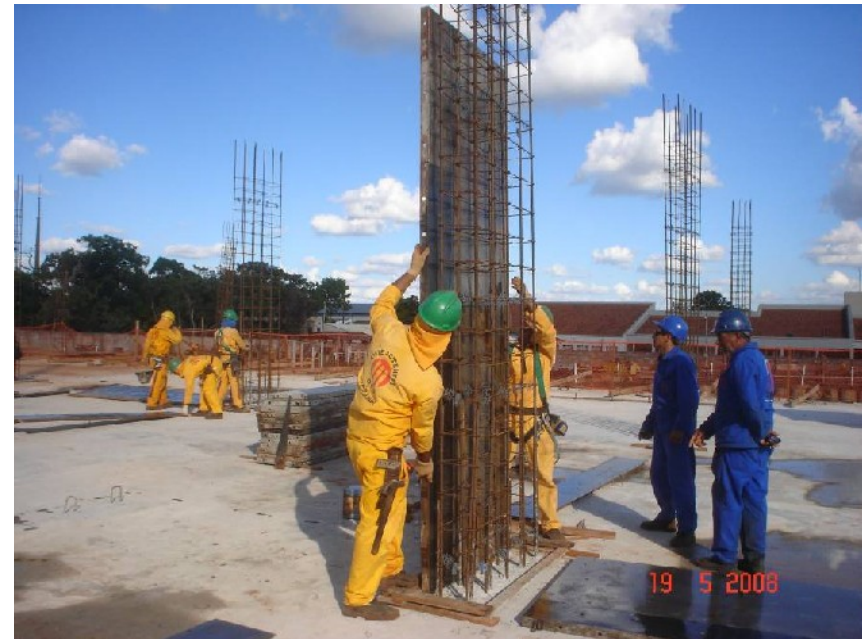
Colocação dos painéis dos pilares do 1º teto
