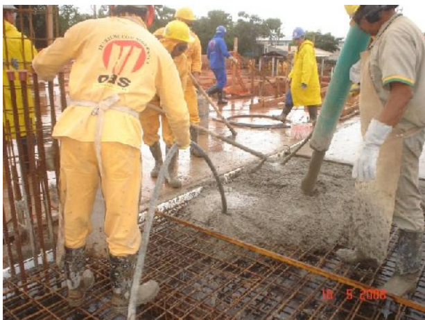
Lançamento de concreto na laje utilizando bomba, vibração utilizando vibrador à gasolina
