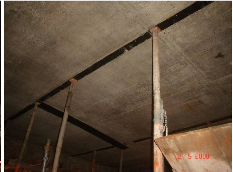
Detalhe do sistema de escoramento retirado, apenas as escoras das vigas e das emendas de lajes que são preservadas.
