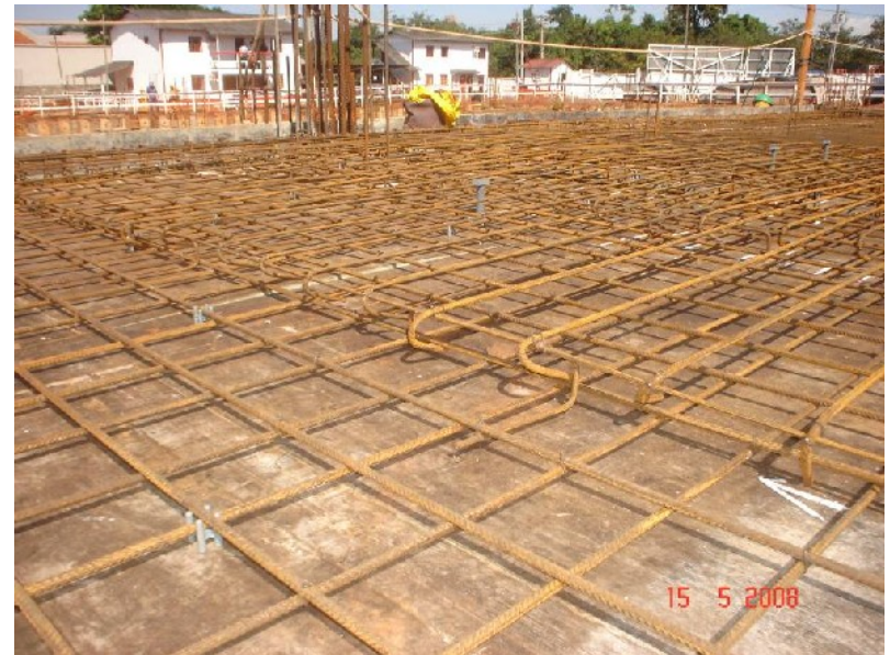
Detalhe da densidade de ferro na laje, observa-se a presença de cadeirinhas, caranguejos e suporte para as régulas de alumínio, além da limpeza e a observância rigorosa dos detalhes estruturais. Exemplo de qualidade de serviços perseguida pela fiscalização.
