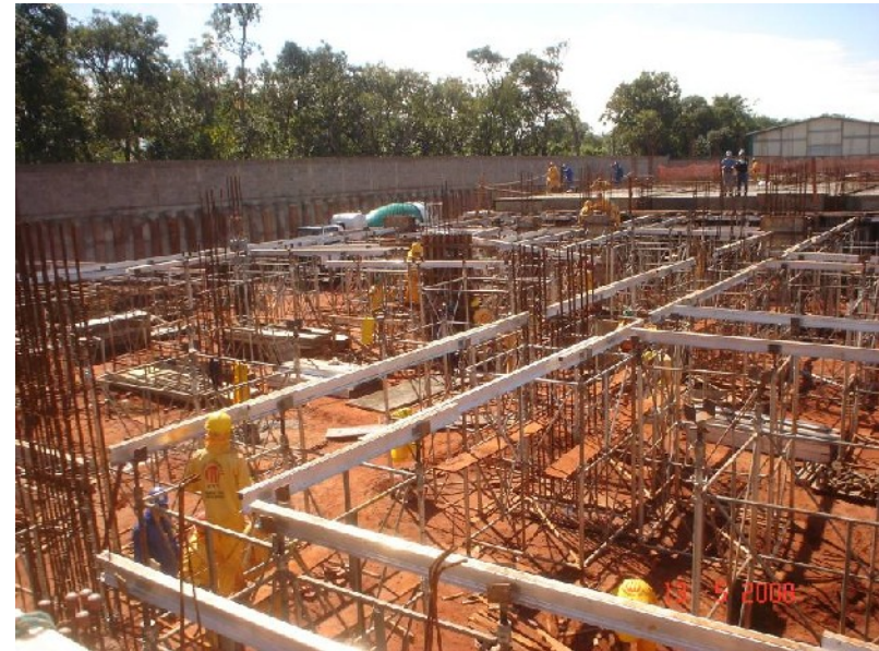
Detalhe da instalação das longarinas do sistema de escoramento
