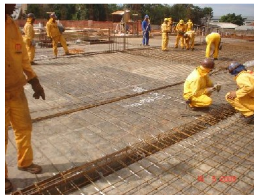
Armação da laje da Junta B
