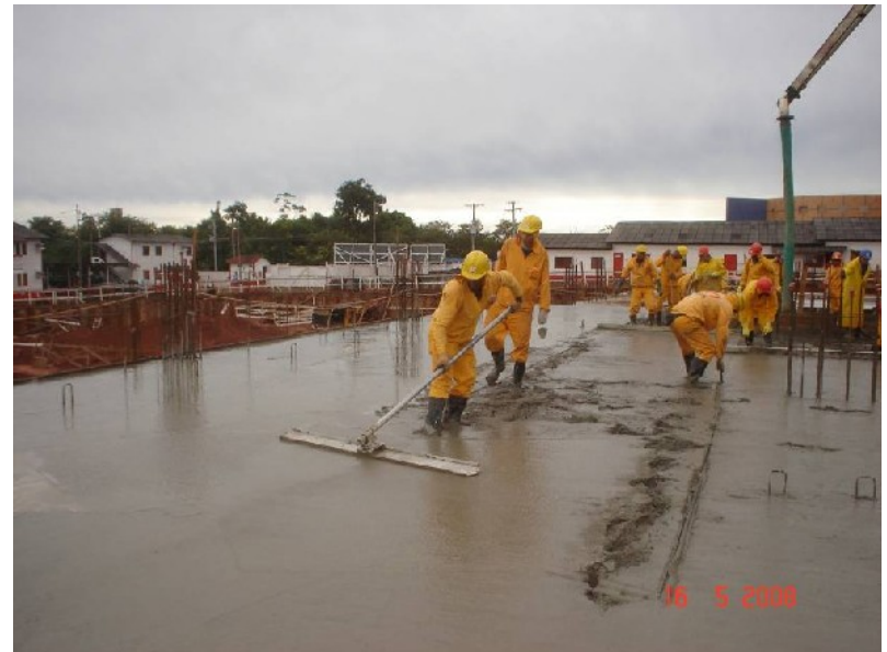
Rodo de alumínio dando acabamento no segundo pano da laje
