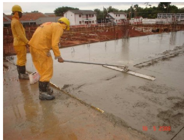
Rodo de alumínio para dar acabamento no concreto
