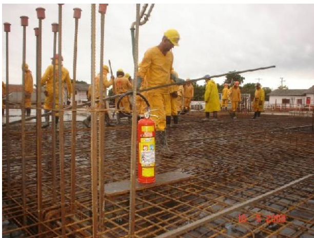
Detalhe da presença de extintor durante a concretagem, segurança é preocupação constante no canteiro
