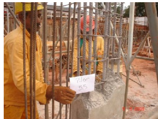
Detalhe de alguns pilares que sofreram reforço de armadura e de seção, (aumento de inércia).
