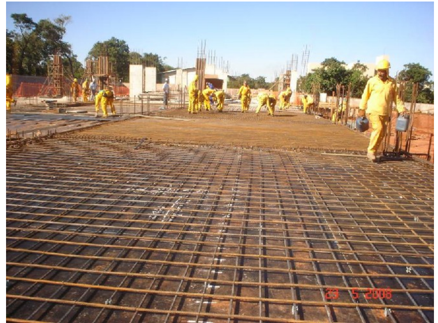
Armação da laje do trecho A e Junta A
