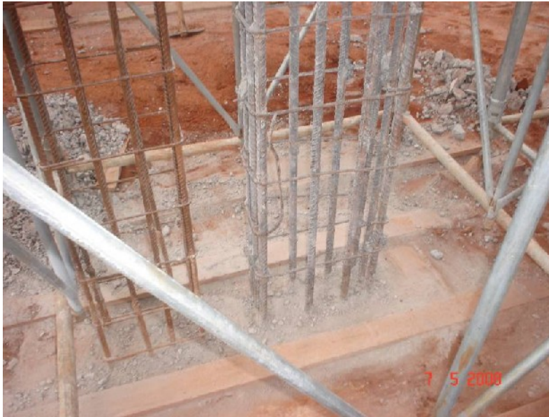
Pilar demolido, preparado para receber reforço de armadura
