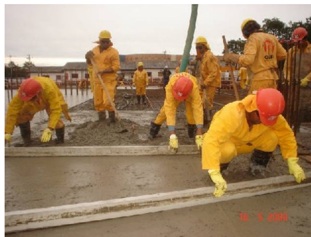
Desempenamento do concreto com réguas de alumínio
