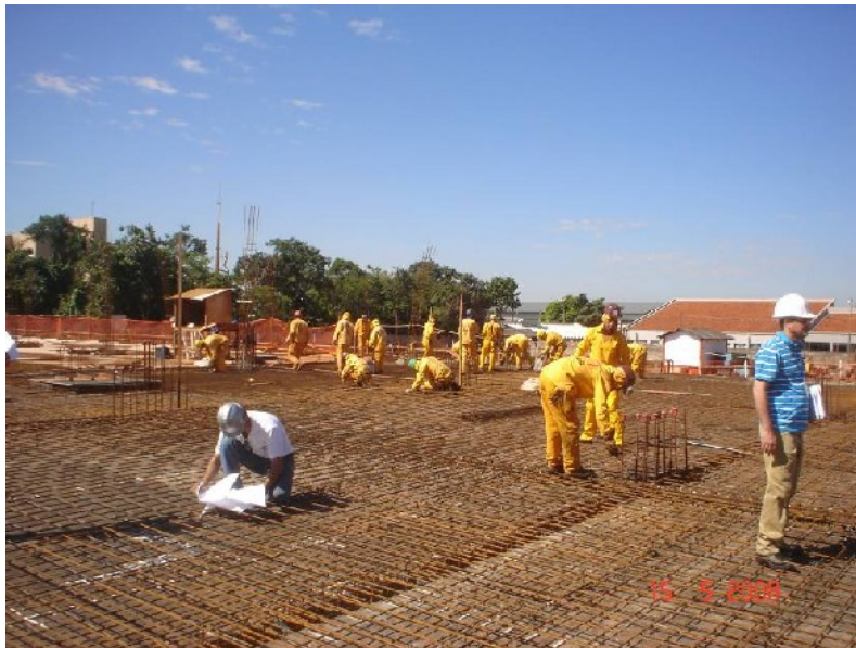
Conferência das armaduras e check list final antes da concretagem
