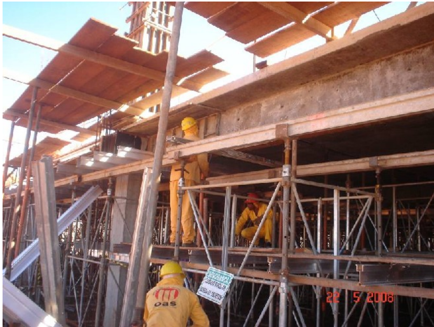
Montagem do escoramento da laje do trecho A e junta A
