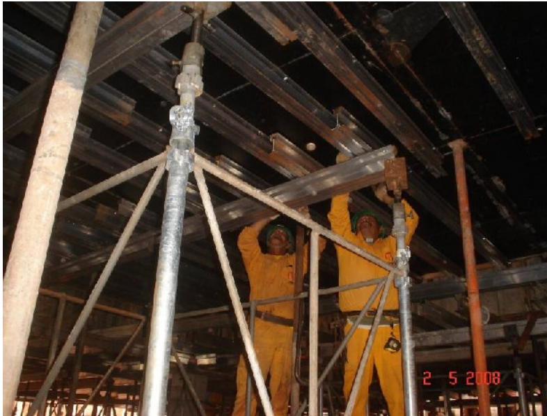
Início da retirada do sistema de escoramento da 1ª laje.
