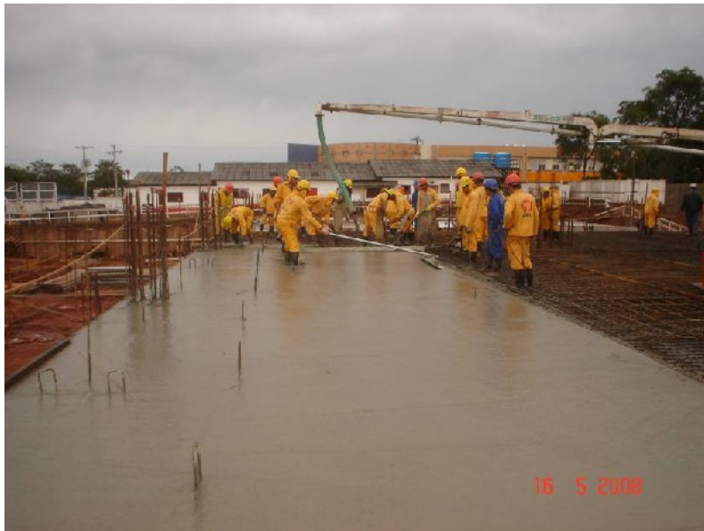
Detalhe do pano da laje concluído o acabamento
