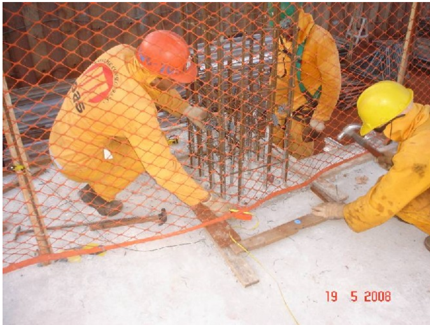
Preparação da base da forma do pilar (gabarito)
