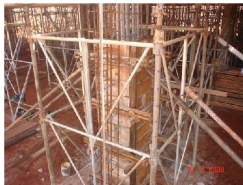
Detalhe de alguns pilares que sofreram reforço de armadura e de seção, (aumento de inércia).
