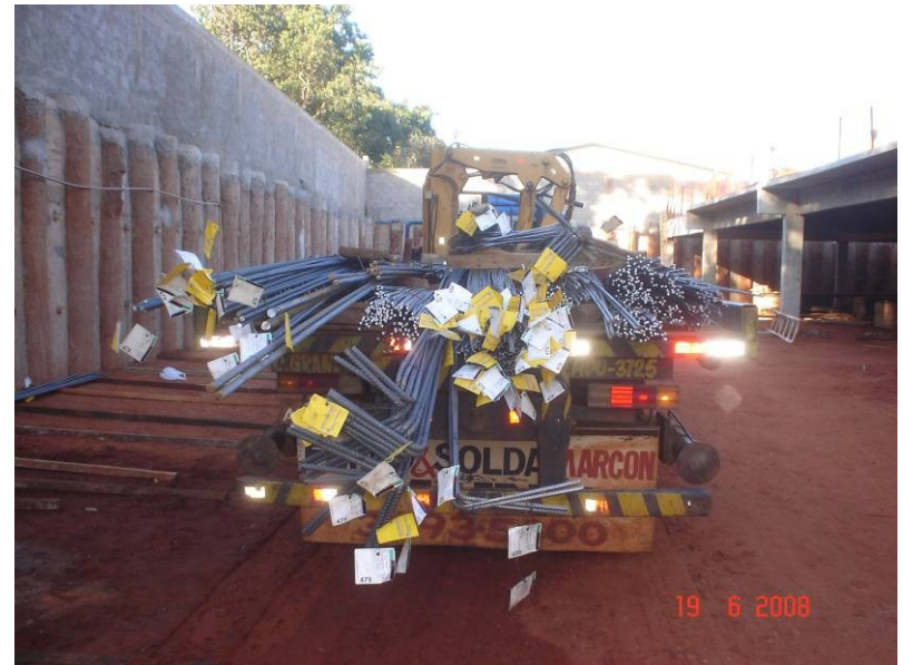
Descarga de aço cortado e dobrado da laje e vigas da junta A da parte A do segundo pavimento (terceiro teto) -13320 kg (note que cada lote tem uma etiqueta de identificação)
