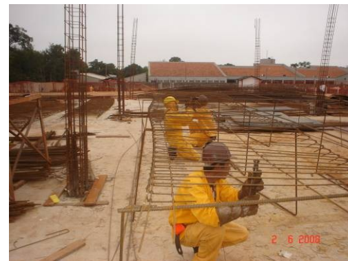
Pré-armação de ferragens negativas da laje do primeiro pavimento
