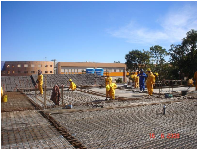
Colocação de armação nas vigas da laje do primeiro pavimento (segundo teto) da junta A da parte A
