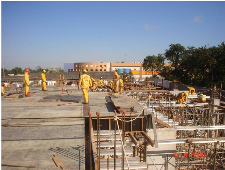
Forração com assoalho da laje do primeiro pavimento (segundo teto) da junta B
