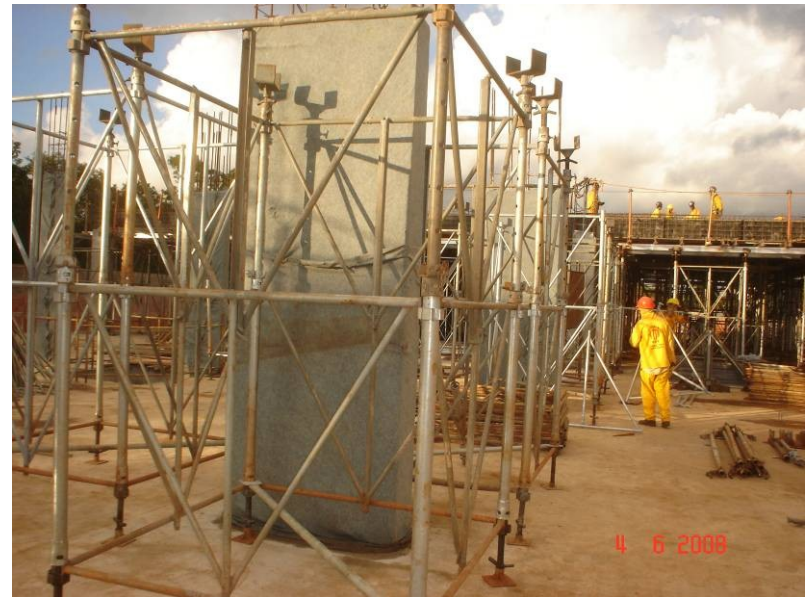
Colocação de escoramento para a laje do primeiro pavimento (segundo teto) da junta B - parte A
