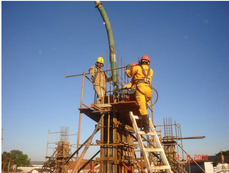
Concretagem de pilares do pavimento térreo da junta A da parte A
