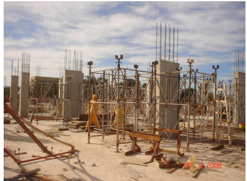
Montagem de escoramentos do primeiro pavimento (segundo teto) da junta B da parte A
