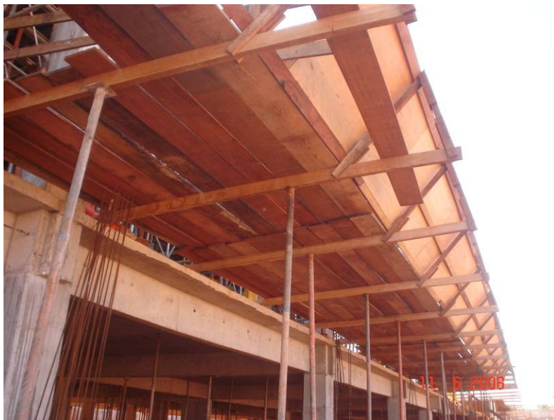
Confecção de bandejas de madeira, no pav. Térreo, na fachada NORTE da junta B da parte A
