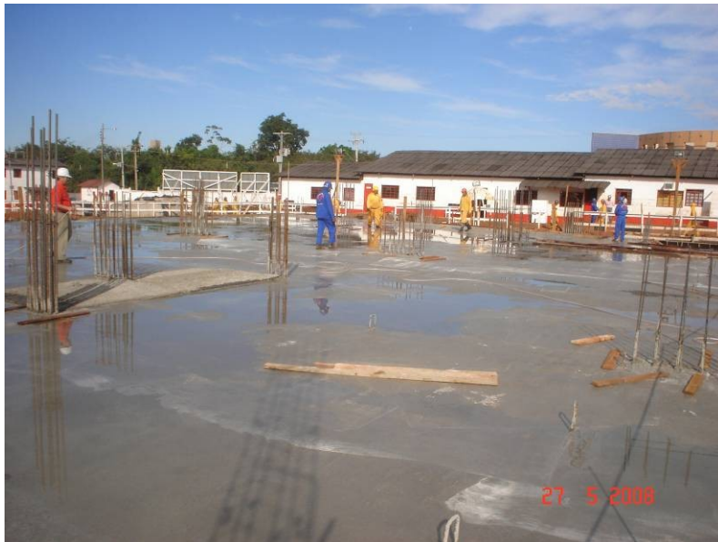
Cura da laje do térreo ( primeiro teto) da junta A da parte A
