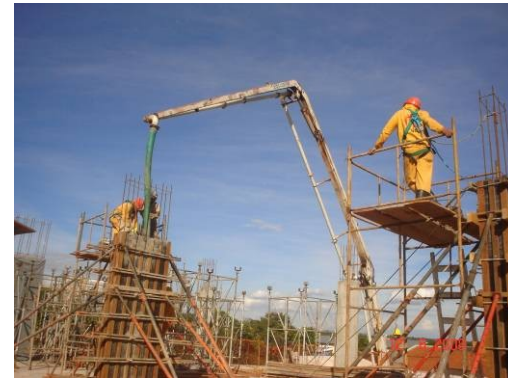
Concretagem de pilares da junta B da parte A do primeiro pavimento (segundo teto)
