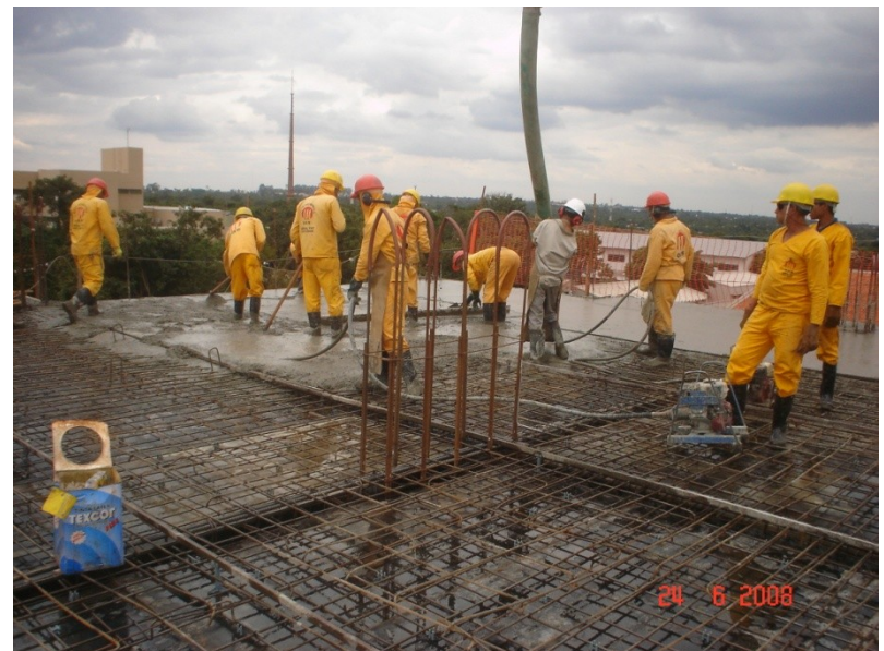
Concretagem da laje do segundo pavimento ( terceiro teto) da junta B parte A com 98 m3 de concreto
