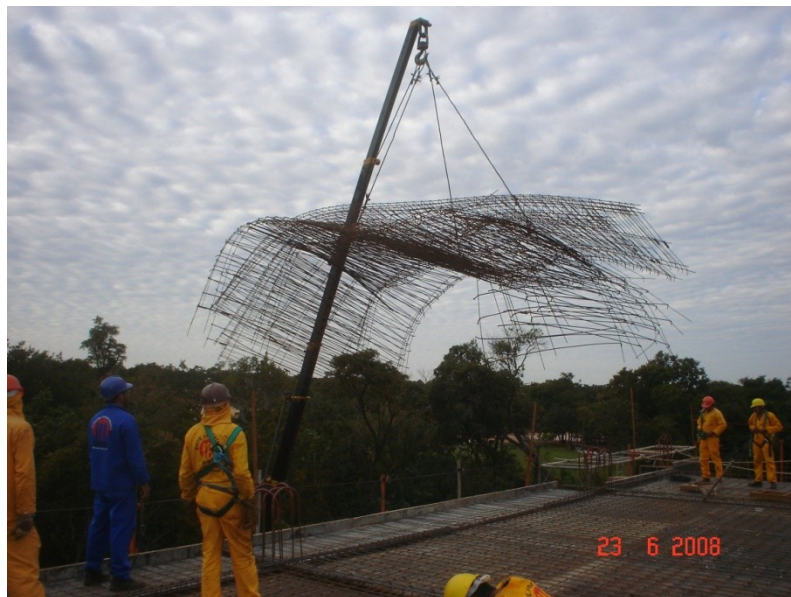
Transporte vertical , com munck, de ferragens negativas para a laje do segundo pavimento ( terceiro teto)
