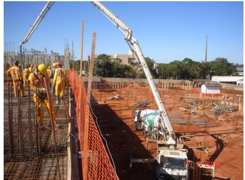
Concretagem de laje do primeiro pavimento (segundo teto) da junta A da parte A
