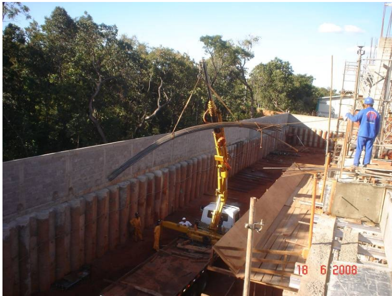
Transporte vertical de ferros positivos, negativos e de vigas com munck para o segundo pavimento, junta B parte A
