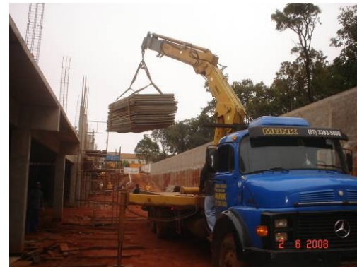
Transporte vertical com munck de escoramento e assoalho de madeirite do sub-solo para o térreo
