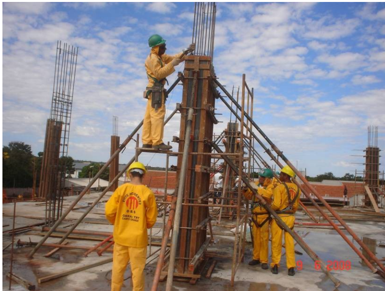
Montagem de formas dos pilares do primeiro pavimento da junta B da parte A
