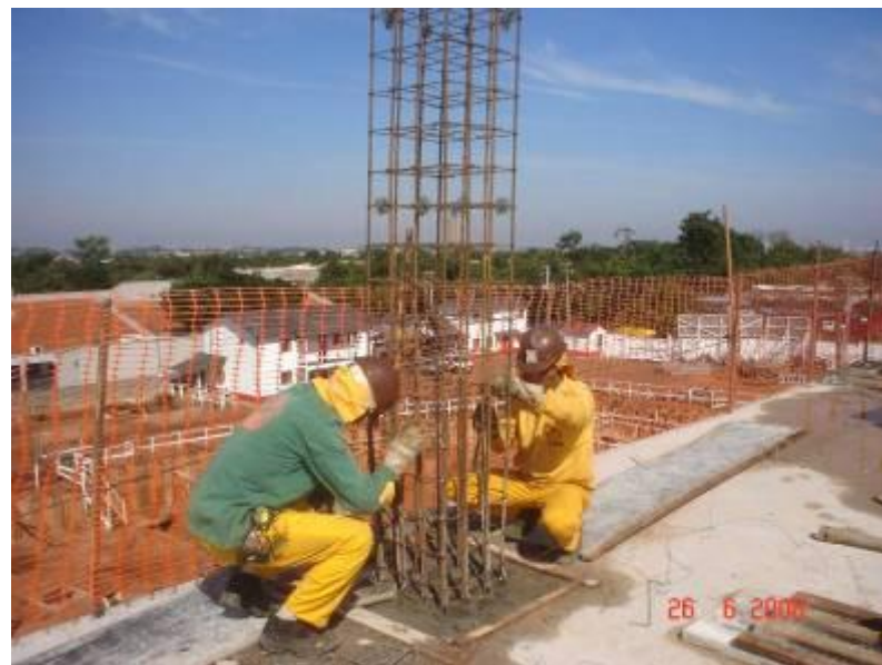
Instalação de armadura de um pilar utilizando gabarito para a montagem da forma
