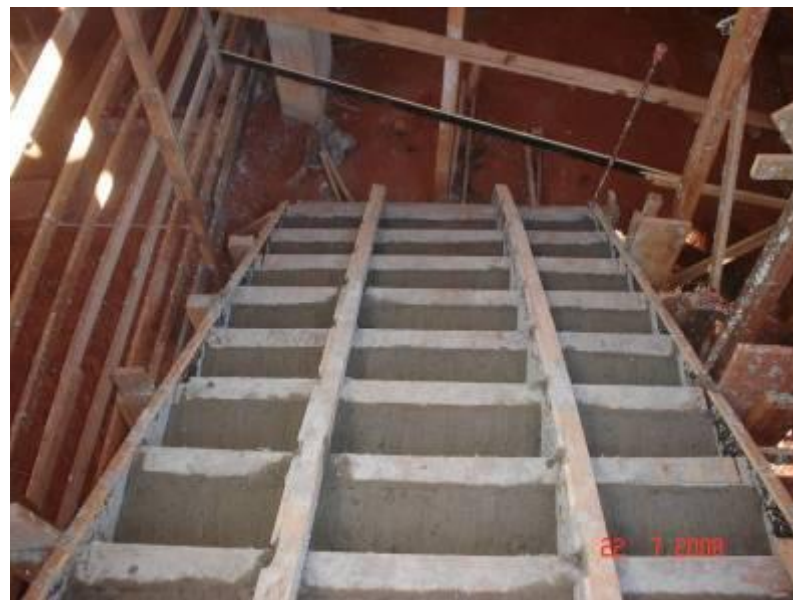
Concretagem da escada do subsolo para o térreo, com a utilização de 4,5 m3 de concreto
