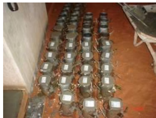
Detalhe do controle tecnológico do concreto
