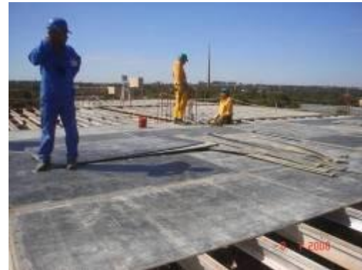
Colocação de formas para a laje do 3º pavimento (4º teto) da Junta B, Parte A.
