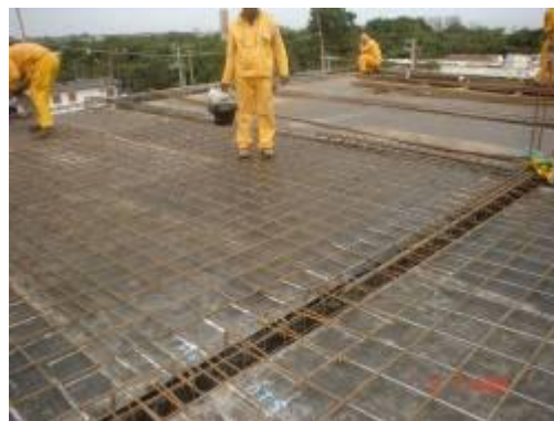
Montagem da 3ª laje, formas e armadura positiva
