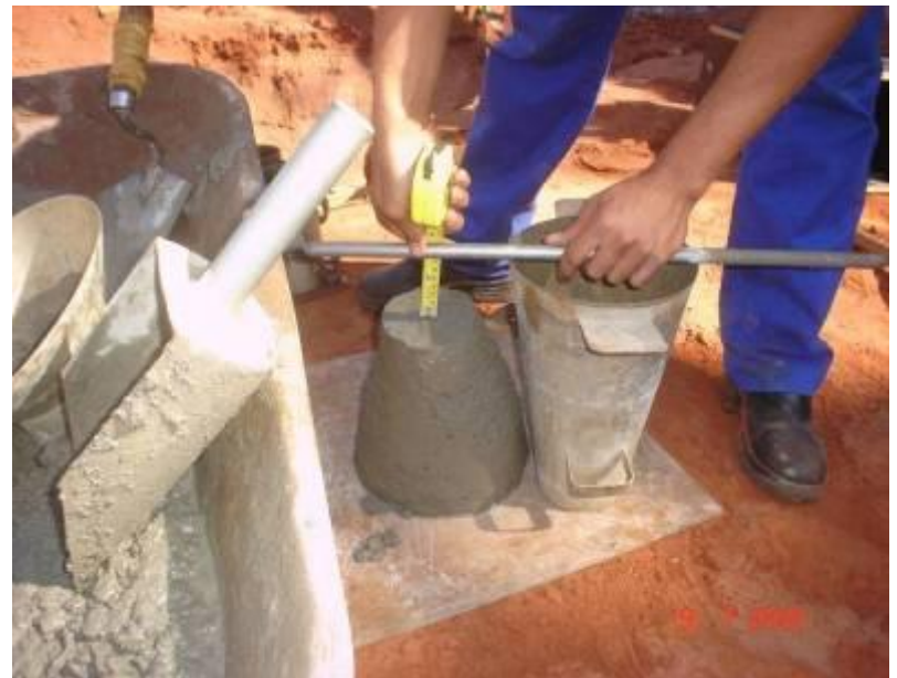
Detalhe do controle tecnológico - medindo o Slump do concreto
