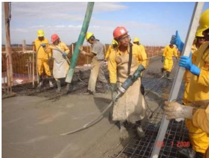
Concretagem da laje do 3º Pavimento (4º Teto) da Junta A, Parte a
