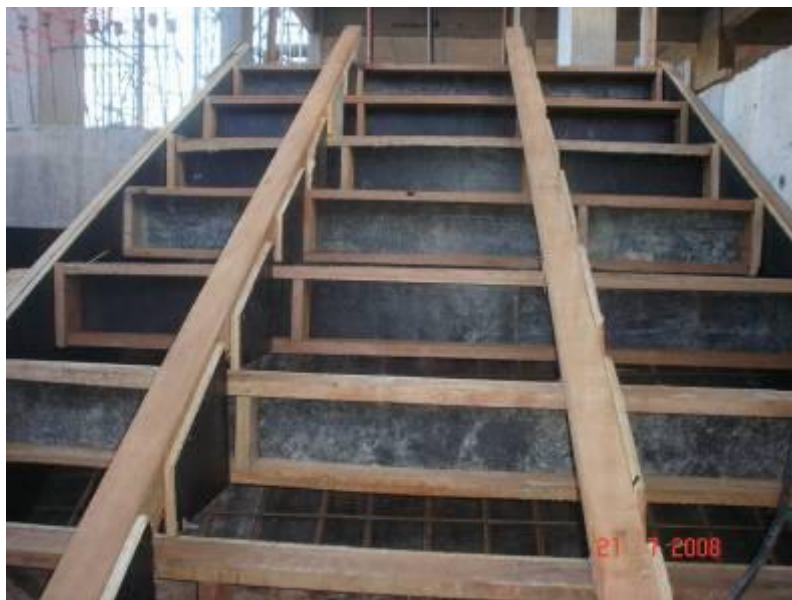
Continuação da confecção de forma da escada do subsolo para o térreo
