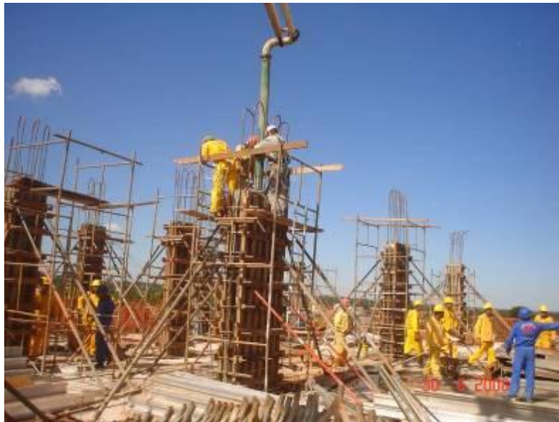
Momento da concretagem dos pilares utilizando bomba
