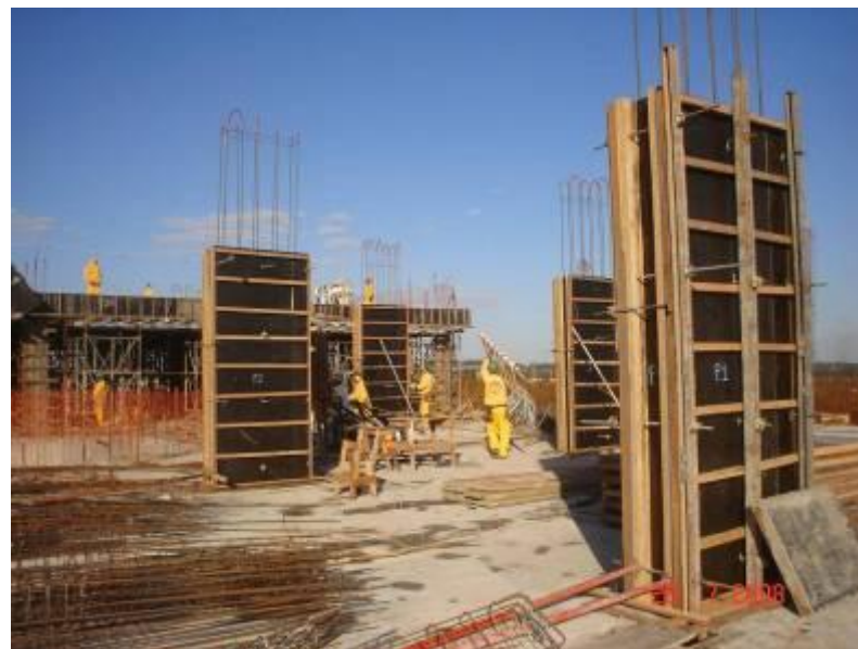
Início de formas para pilares do 3º Pavimento (4º Teto) da Junta A, Parte a
