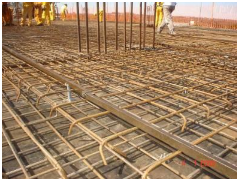
Detalhe da armadura negativa e a guia de metalon para orientar a cobertura do concreto.
