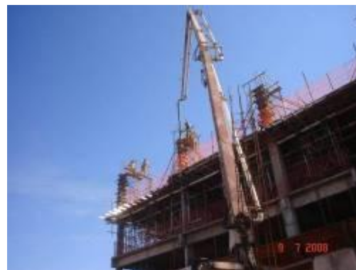
Detalhe da concretagem dos pilares, utilizando bomba
