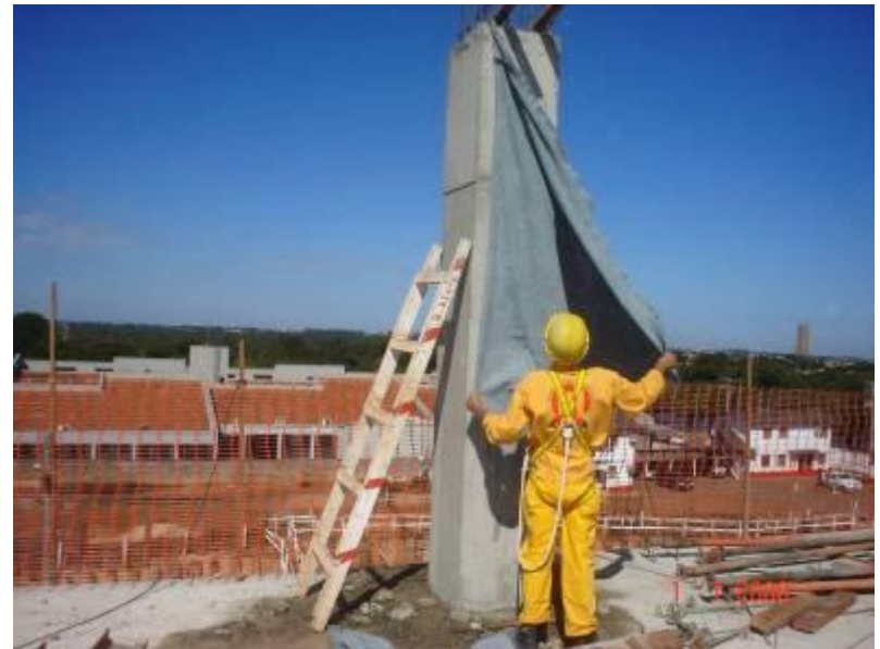
Após a desforma dos pilares são colocadas mantas úmidas para melhorar o processo de cura do concreto, minimizando a retração e, conseqüentemente, o surgimento de fissuras.
