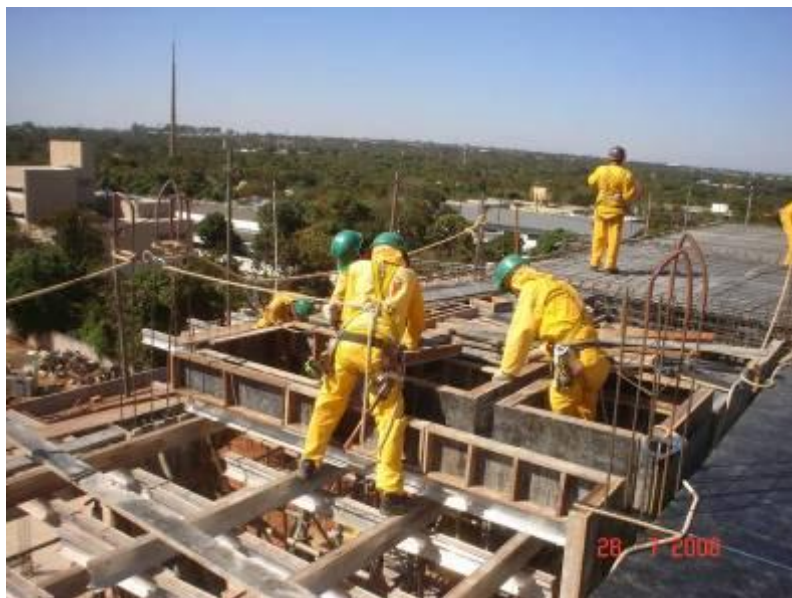
Continuação de colocação de formas para vigas e laje do 4º Pavimento (5º Teto) da Junta B, Parte A.
