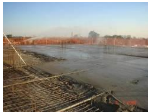
Concretagem da laje do 2º pavimento (3º teto) Junta A, Parte A, com utilização de 119m 3 de concreto
