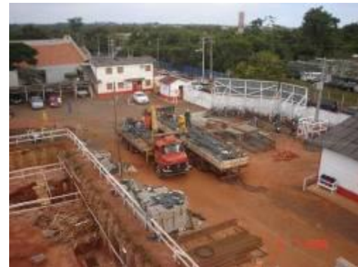
Momento da chegada de mais um carregamento de aço na obra
