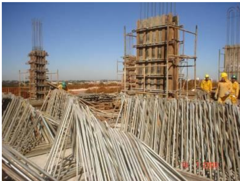
Início da montagem de escoramento do 4º Pavimento (5º teto) da Junta B, Parte A.
