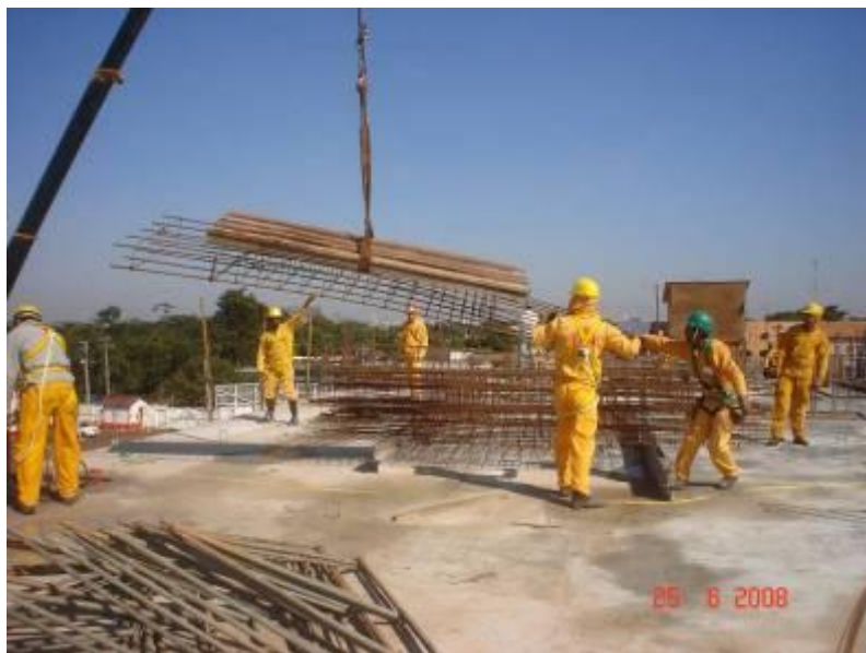
Detalhe do transporte vertical das armaduras dos pilares, utilizando caminhão munk
