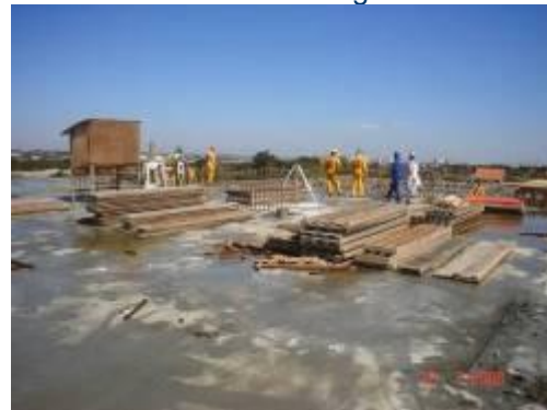
Esfriamento da laje com água, para melhorar o processo de cura do concreto
