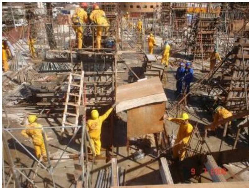
Concretagem de 18 pilares do 2º pavimento (3º teto) da Junta A, Parte A, com a utilização de 16 m3 de concreto.
