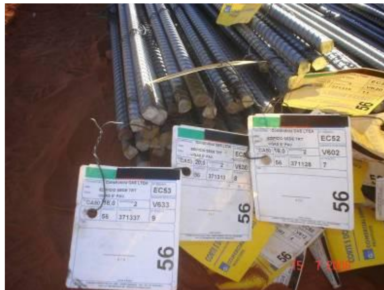
Detalhe de um lote de aço dobrado e cortado conforme projeto da peça identificada na etiqueta
