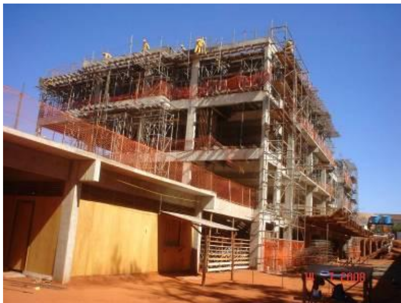
Concretagem da laje e vigas do 3º Pavimento (4º teto) da Junta B, Parte A, com a utilização de 102,5 m 3 de concreto.
