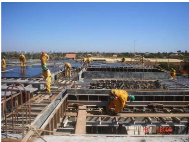
Continuação da forração da laje do 3º Pavimento (4º teto) da Junta A, Parte a
