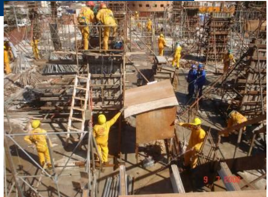
Detalhe da montagem das formas dos pilares da 3ª laje
