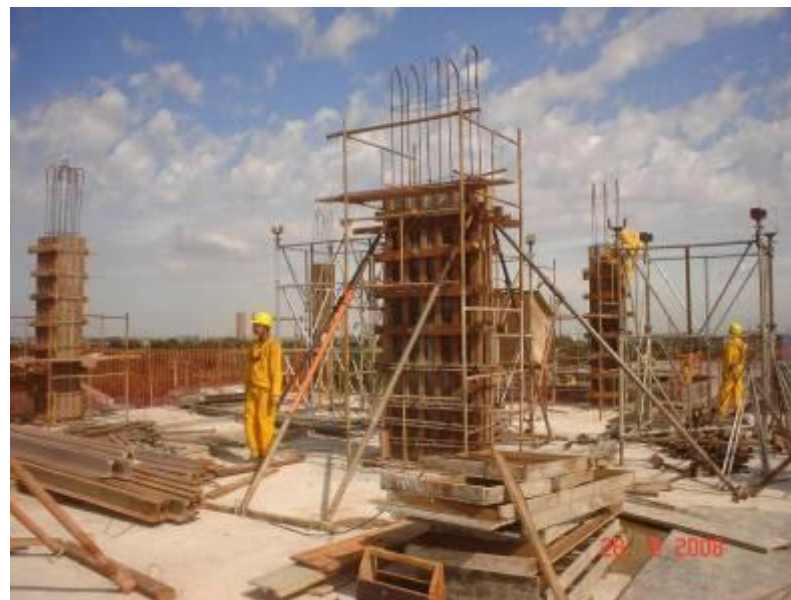
Montagem e travamento das formas dos pilares
