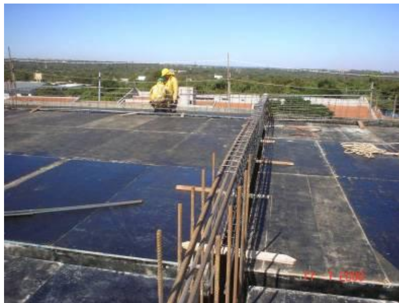
Continuação da armação de vigas para a laje do 3º Pavimento da Junta A, Parte A.
