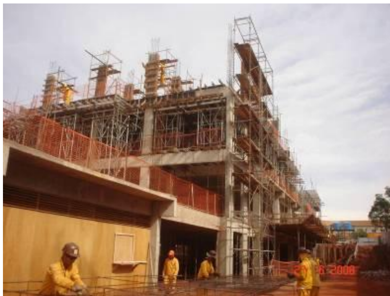
Detalhe do andaime montado para a montagem das formas dos pilares da 4ª laje
