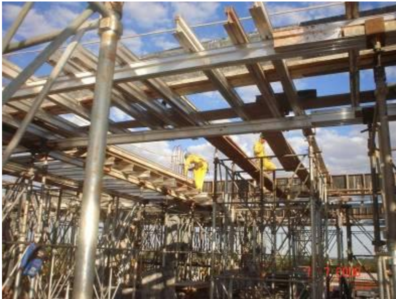
Continuação da montagem de escoramento e colocação de formas de vigas da laje do 3º pavimento (4º teto) da Junta B, Parte A.
