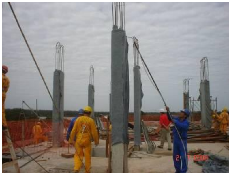
Vista geral dos pilares em processo de cura
