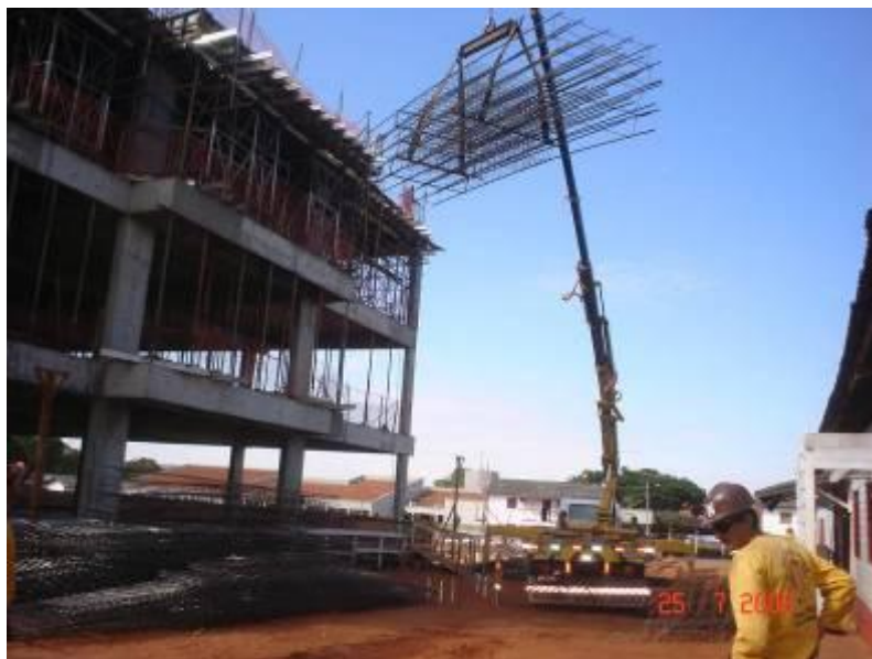
Transporte vertical -com Munk- de vigas do 4º Pavimento (5º Teto) Junta B, Parte A, e de armação e forma de Pilares do 3º Pavimento da Junta A, Parte B.
