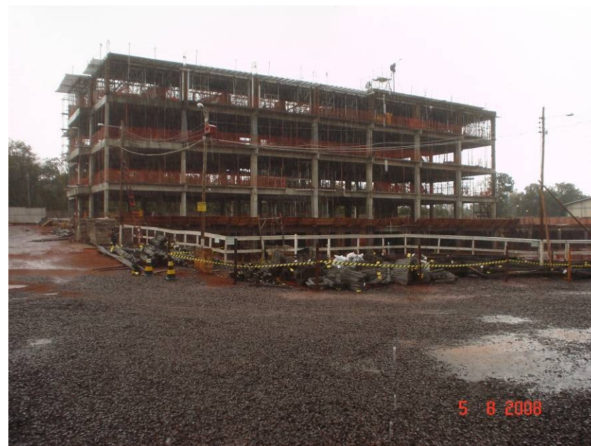
Detalhe da estrutura da obra
