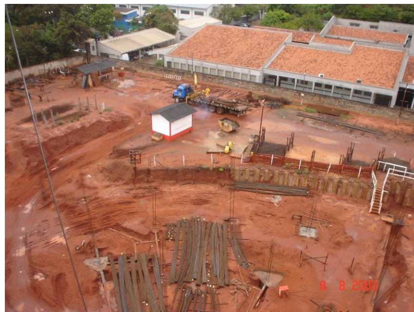
Vista do canteiro observado da 5ª laje
