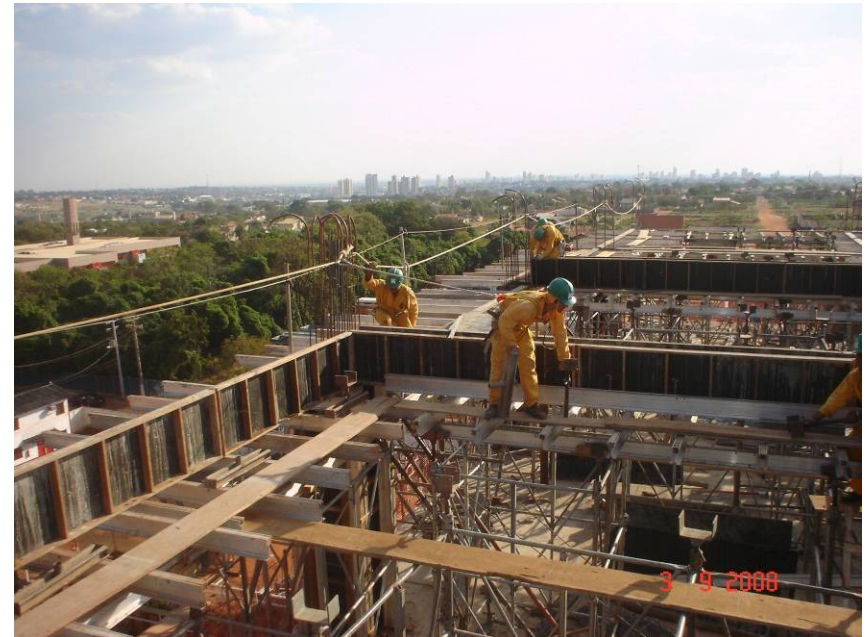
Montagem das fôrmas de vigas da 5ª laje
