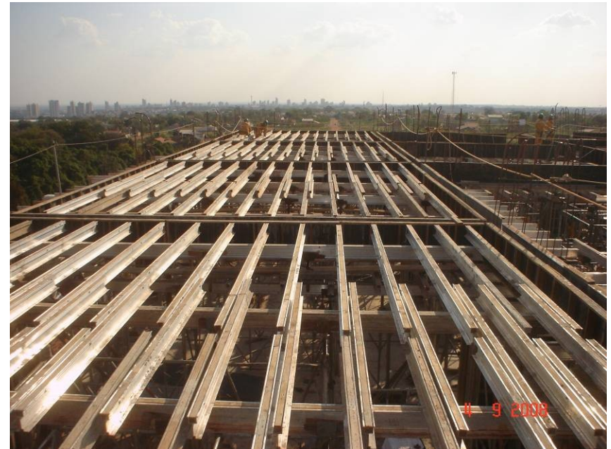
Detalhe das vigas de alumínio do sistema de escoramento na 5ª laje
