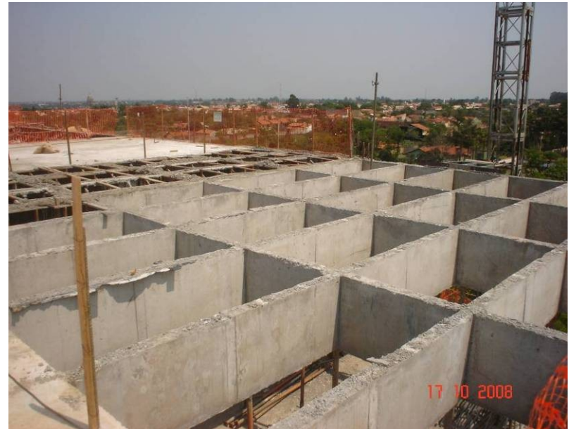
Visita da grelha de concreto na sacada da presidência
