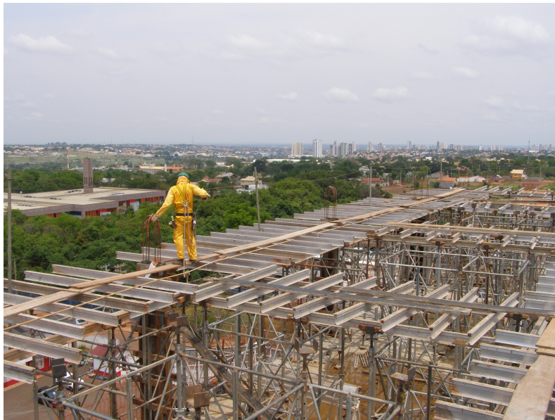
Término do escoramento do 5º pavimento junta A parte A
