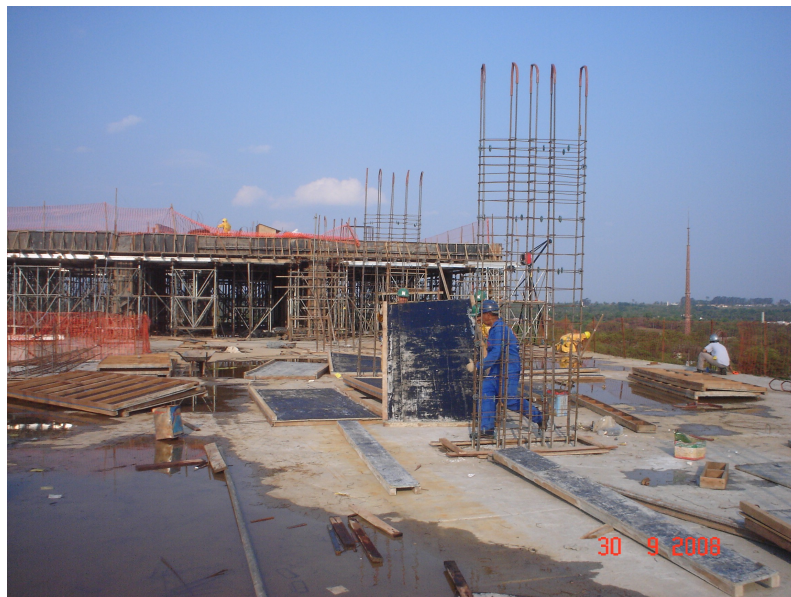
Início do escoramento e fôrmas dos pilares do 5º pavimento junta A parte B
