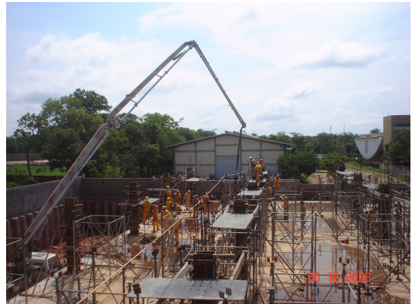
Concretagem dos pilares da junta C
