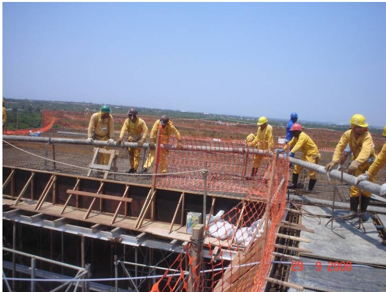
Tubulação de aço para bombeamento de concreto (laje do teto da 5º pavimento)
