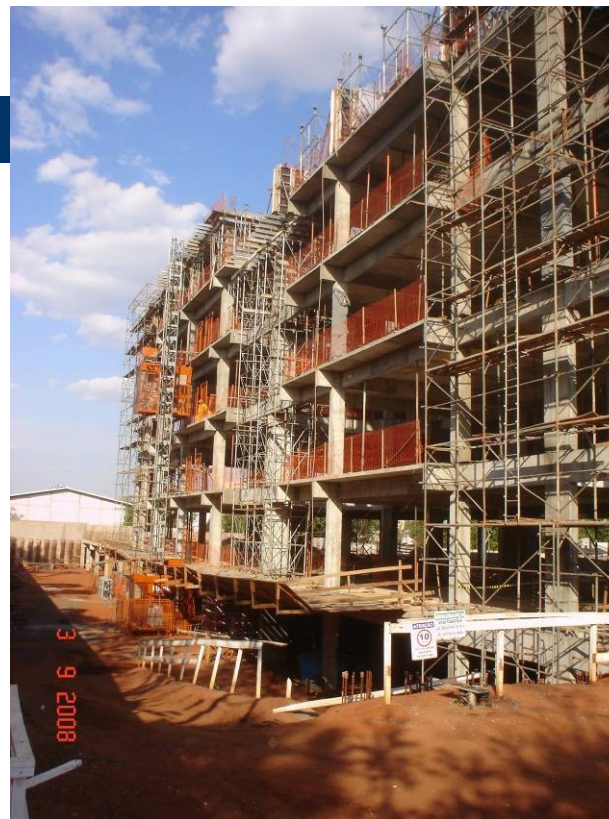
Detalhe da vista lateral norte
