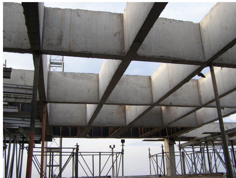
Detalhe da grelha da sacada da presidência
