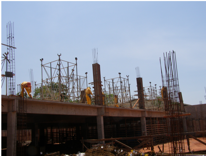
Montagem do escoramento da 2ª laje da junta C
