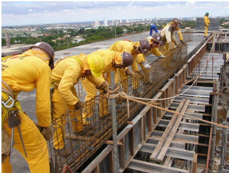
Colocação de armadura de viga na laje do teto do 5º pavimento
