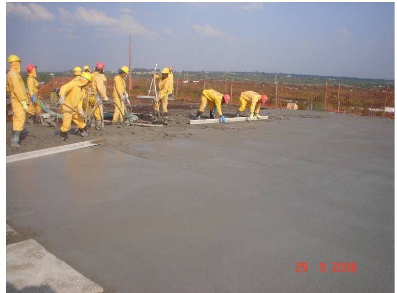
Acabamento no concreto da laje do teto do 5º pavimento
