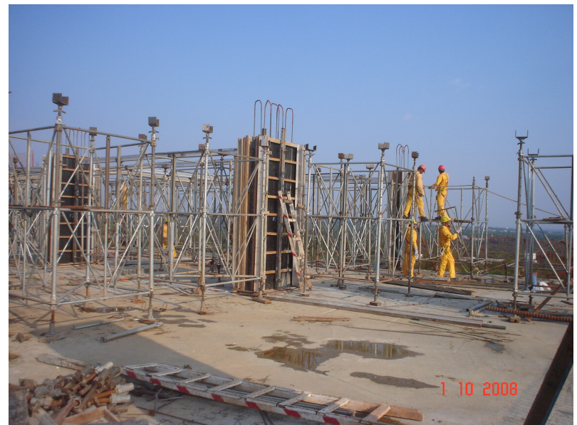
Prosseguimento no escoramento e fôrmas dos pilares do 5º pavimento junta A parte B
