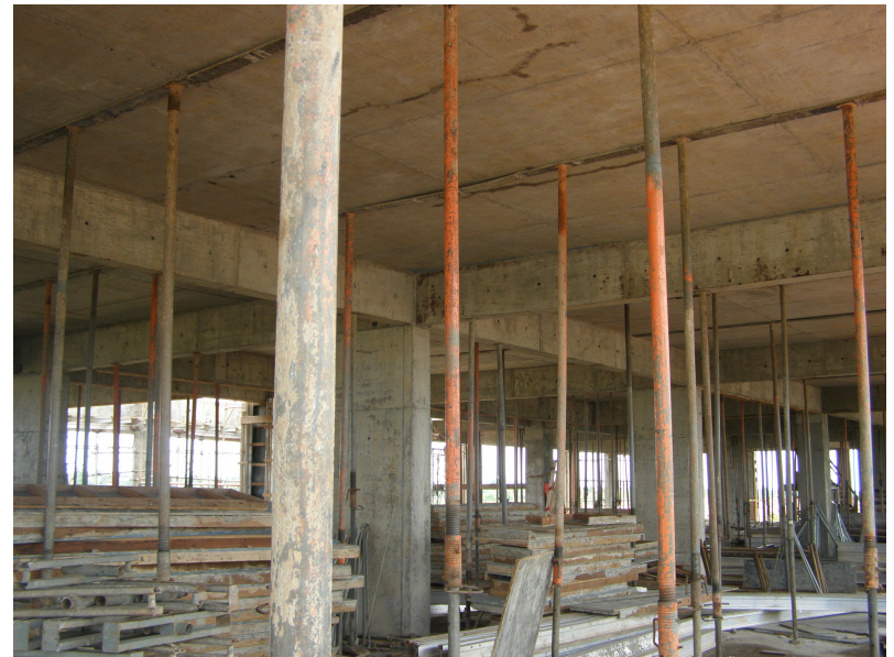
Retirada do escoramento da laje do 5º pavimento junta A parte B
