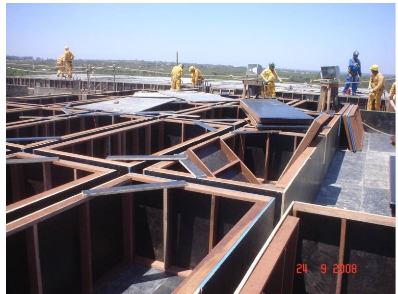
Travamento das fôrmas da grelha da sacada da presidência
