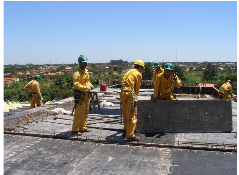
Término da colocação das fôrmas da laje do 5º pavimento junta A parte A
