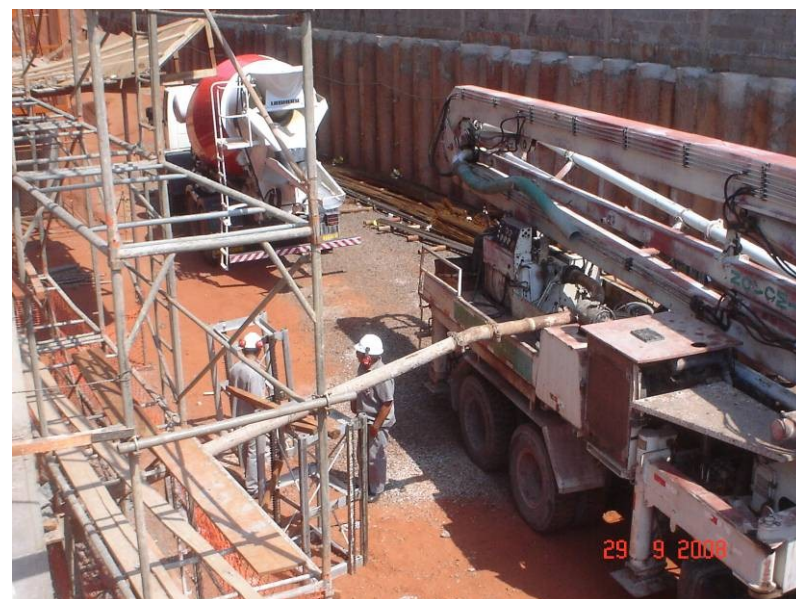
Bombeamento de concreto
