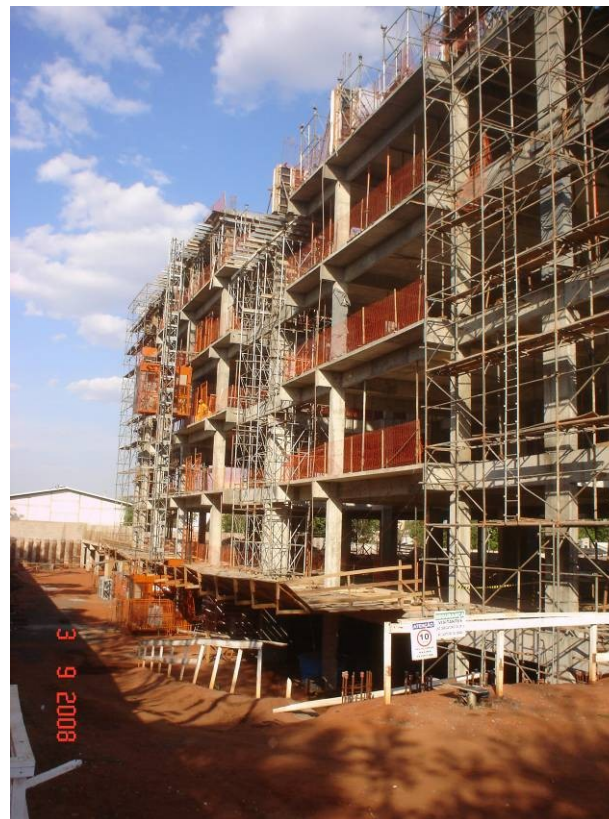
Detalhe da vista lateral norte
