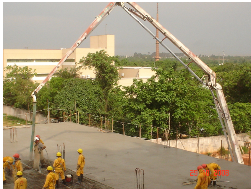
Momento da concretagem do 1º Pav. 2º teto, junta C, parte A.
