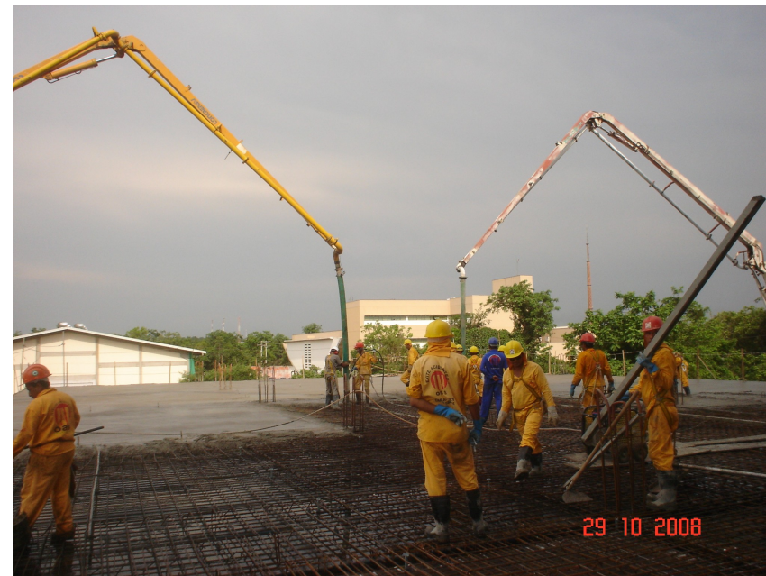
Bombeamento de concreto com duas bombas simultâneas
