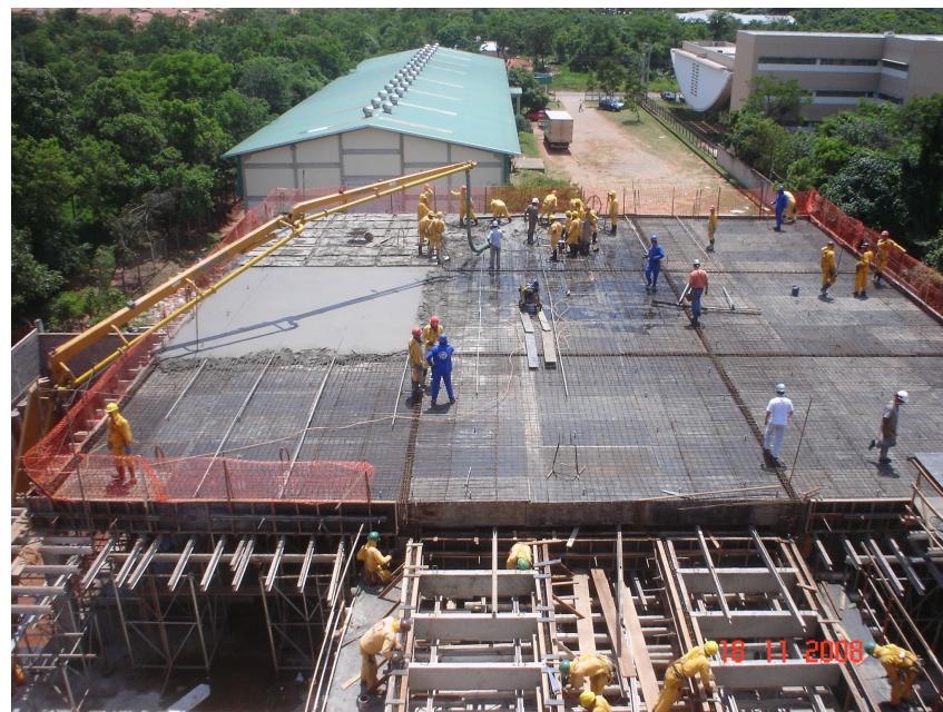
Concretagem da laje do 2º pavimento 3º teto Junta C Parte A
