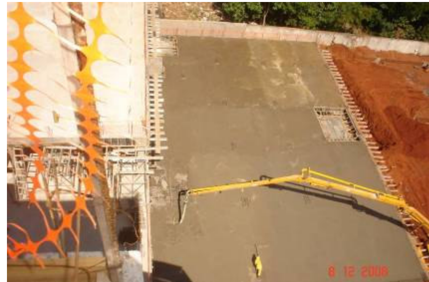
Término da concretagem
