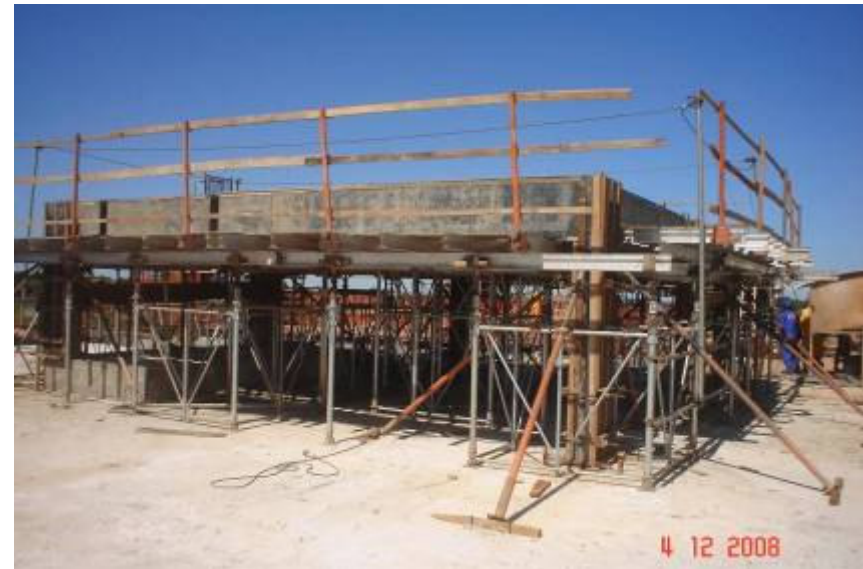
Vista da laje da sala de máquinas na cobertura
