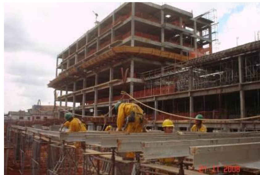
Detalhe da montagem do sistema de escoramento
