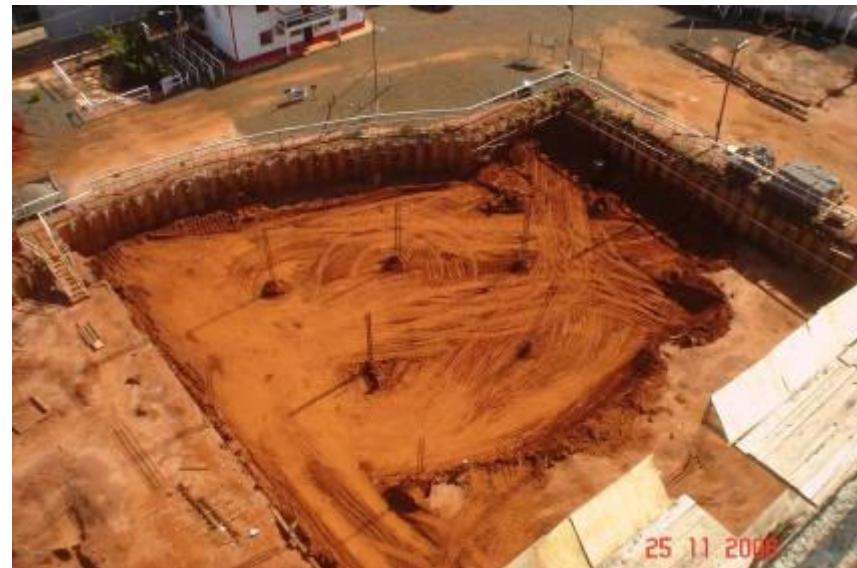
Vista do rebaixamento do nível do subsolo
