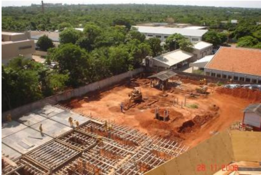
Montagem das formas da laje da Parte B
