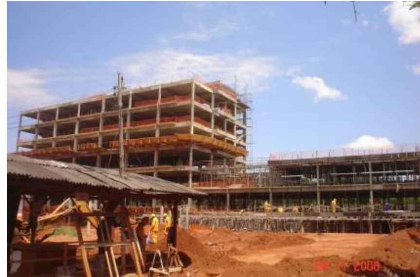
Vista lateral da obra
