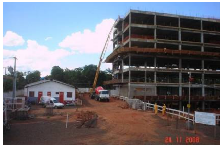
Bombeamento de concreto para a sala de máquinas
