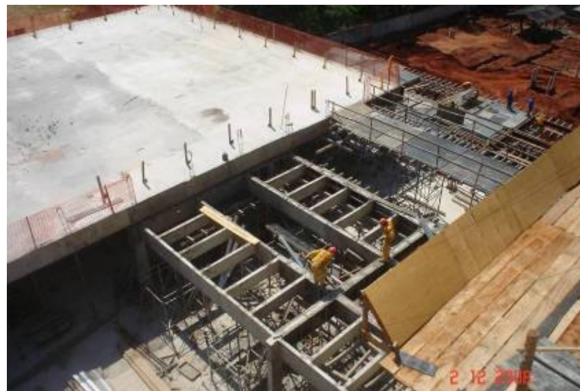
Momento da desforma do pergolado da praça do restaurante
