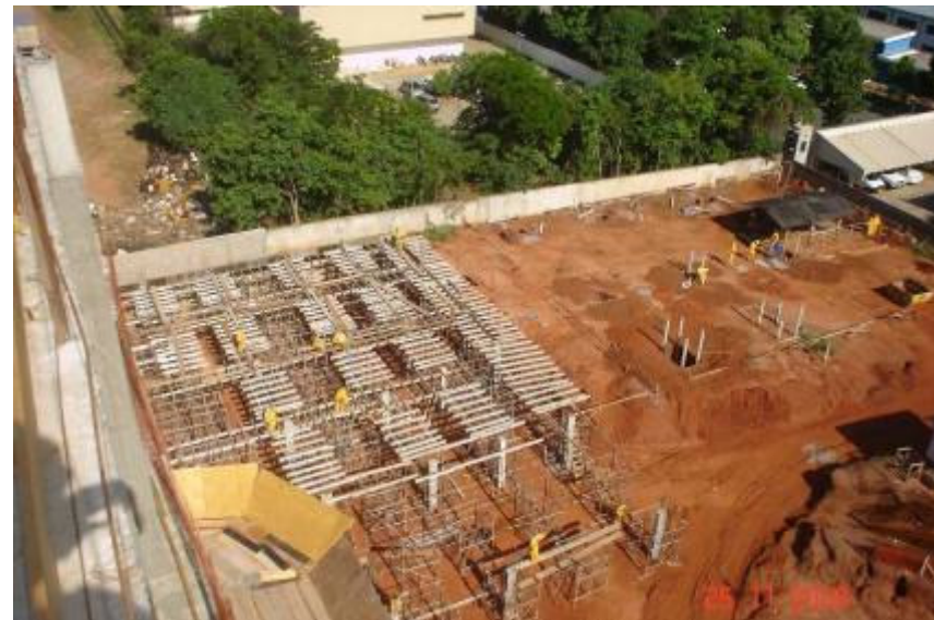
Vista do escoramento da laje da Junta C, Parte B
