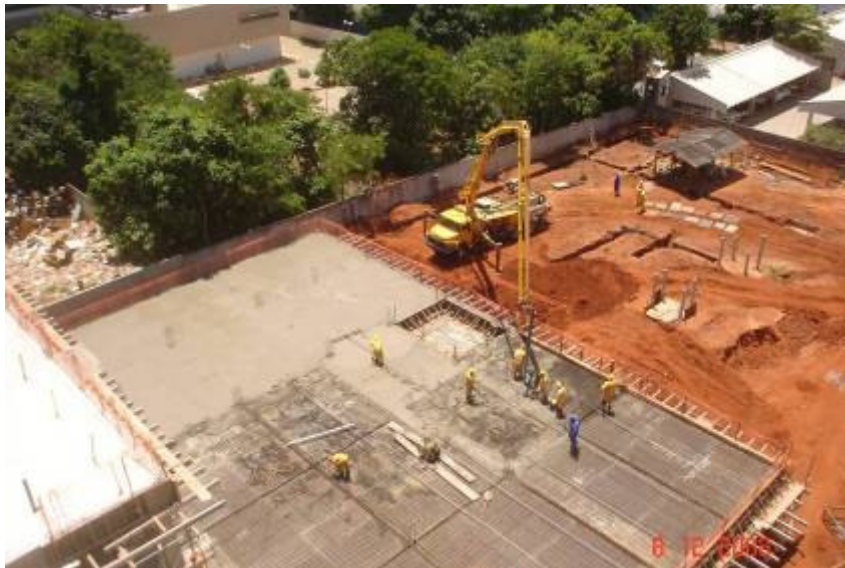
Detalhe do início da concretagem
