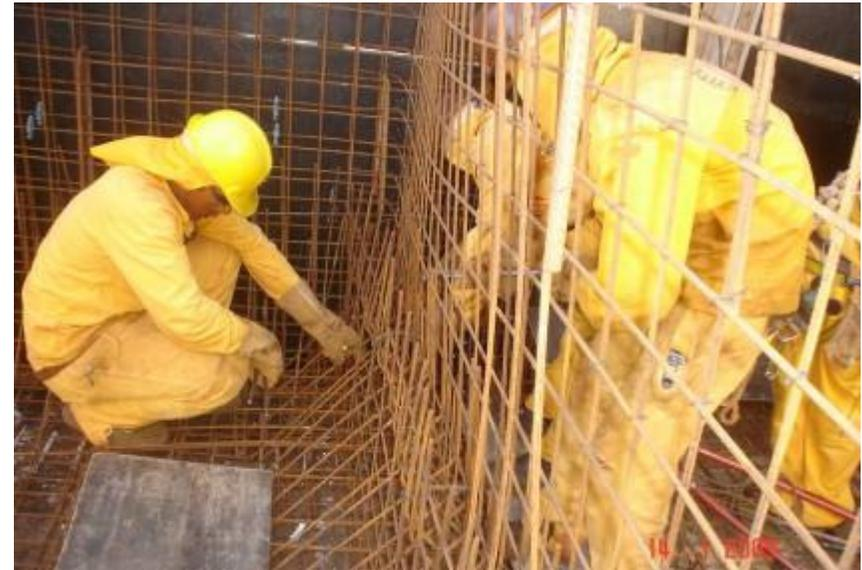
Término da montagem das ferragens do reservatório elevado nas duas células de 48 m<sup>3</sup>
