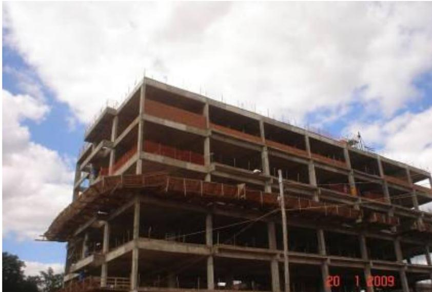
Vista da fachada já com parte da vedação em alvenaria com blocos cerâmicos de 8 furos
