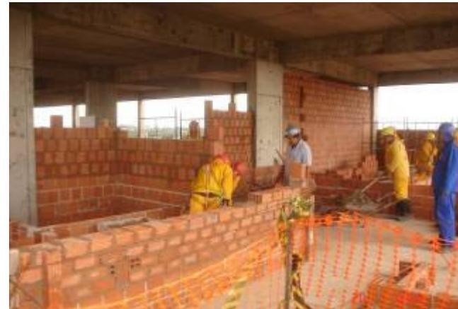
Detalhe do assentamento de blocos cerâmicos de 8 furos para o sistema de vedação
