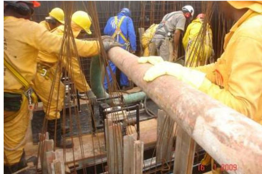
Detalhe da concretagem do reservatório elevado
