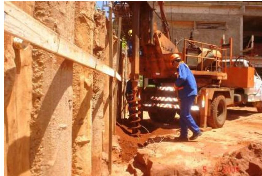
Execução de estaca escavada rotativa da fundação do entorno do reservatório inferior
