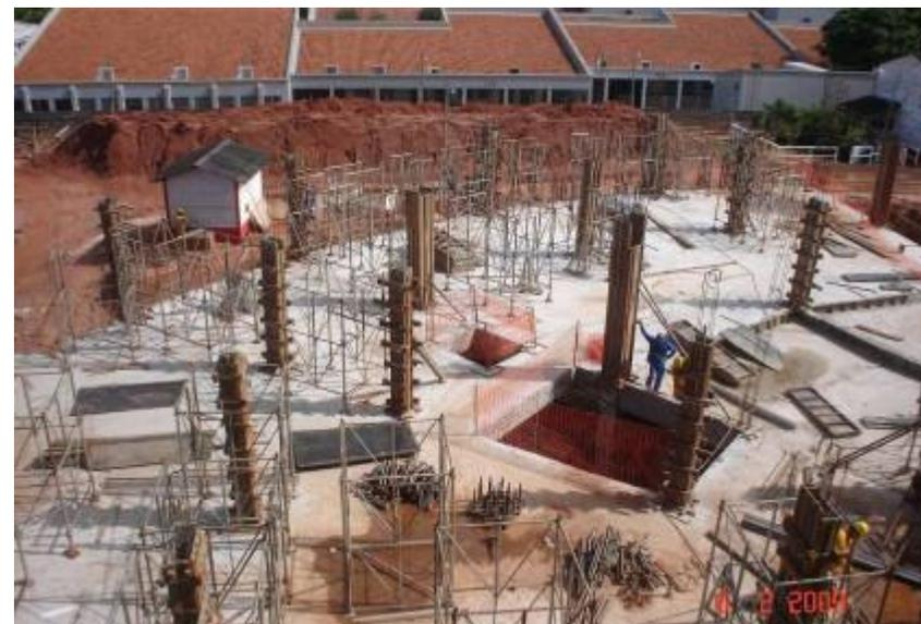
Momento do lançamento do concreto na laje da cobertura do térreo trecho B, e vista da laje do piso dos plenários das duas turmas, já com as fôrmas dos pilares montadas e travadas.
