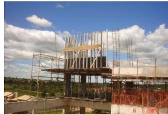
Detalhe da montagem da fôrma do reservatório superior
