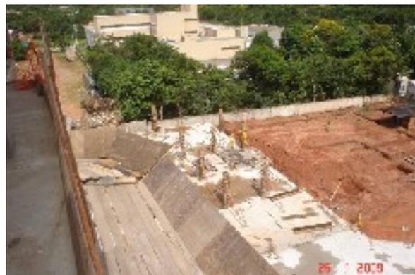
Detalhe da laje do piso dos plenários das turmas e vista das fôrmas dos pilares da junta C parte B
