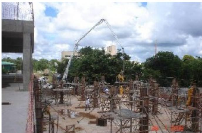
Detalhe do lançamento de concreto nos pilares da junta C parte B
