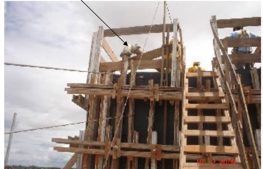
Detalhe da concretagem da 2ª parte do reservatório superior
