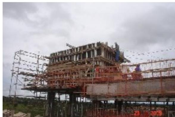
Detalhe da montagem da fôrma da 2ª parte do reservatório superior
