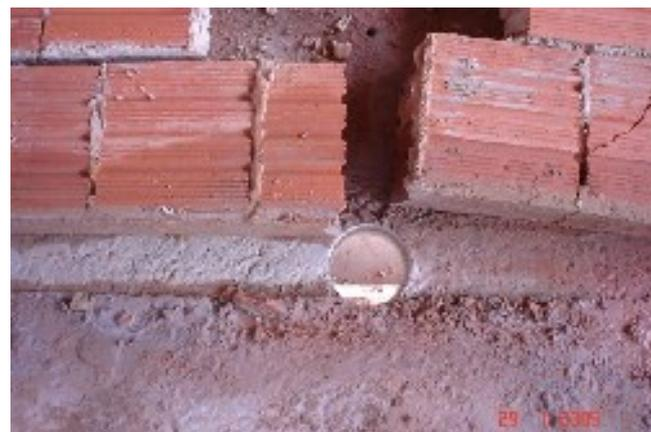
Extratora de concreto, detalhe do furo de 100mm para instalação de prumada de esgoto nos banheiros
