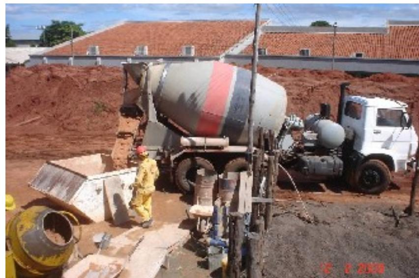
Descarga de argamassa industrial para assentamento de tijolo cerâmico de 8 furos da alvenaria
