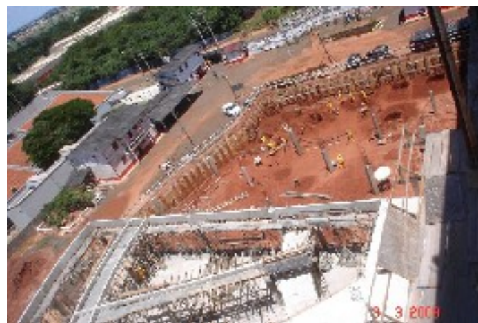
Detalhe do início da montagem do sistema do escoramento da estrutura do plenário principal
