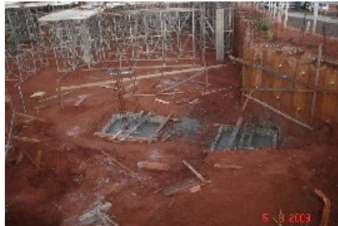
Evolução do escoramento da laje do plenário principal e detalhe da concretagem dos blocos 401,402 e 403
