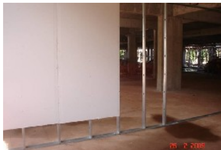
Detalhe da alimentação da betoneira e montagem de parede drywall para teste de fixação
