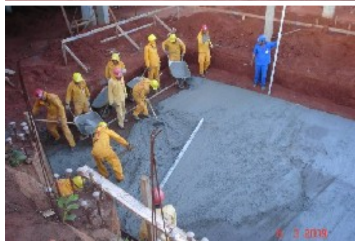
Detalhe da locação e concretagem do lastro do reservatório inferior
