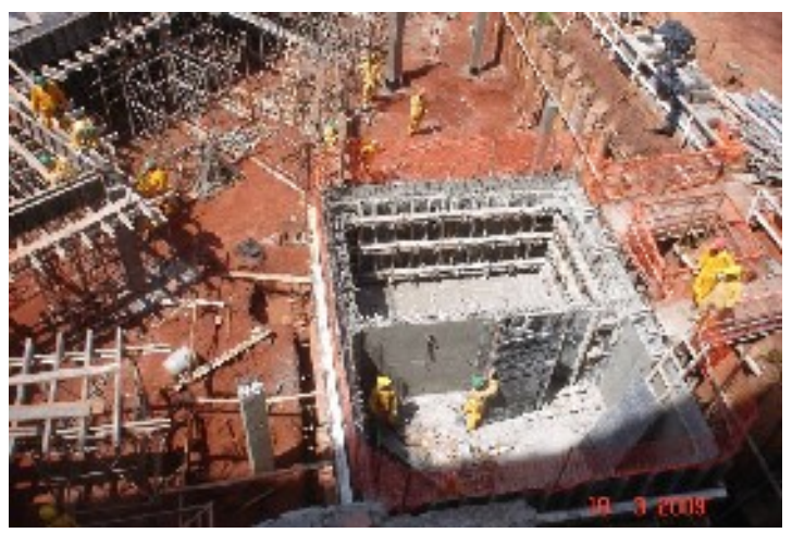
Evolução da execução do reservatório inferior
