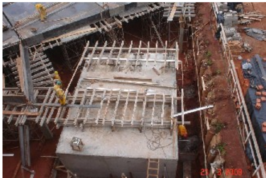
Reservatório inferior concretado e independente da estrutura do plenário
