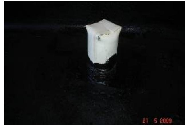
Detalhe da tubulação de esgoto após a aplicação do primer
