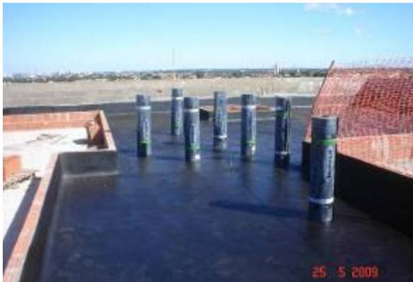
Imprimação com Primer (preparação para aplicação da manta asfáltica)
