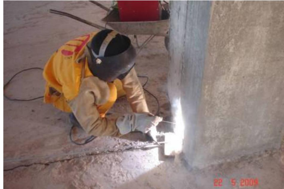
Detalhe da solda para o sistema de aterramento do piso elevado
