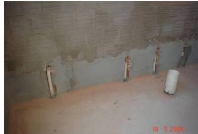
Detalhe da tubulação de esgoto passando pela laje
