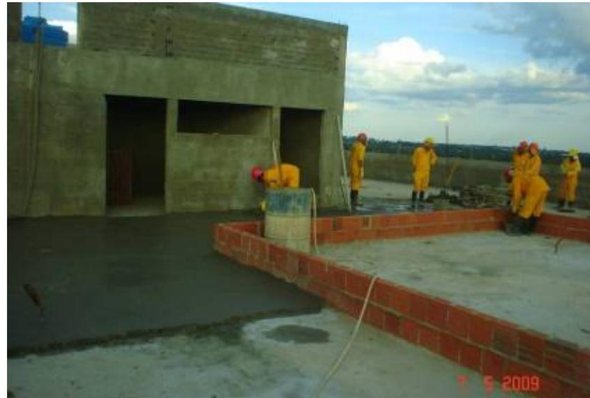
Regularização de piso para impermeabilização com manta asfáltica (cobertura)
