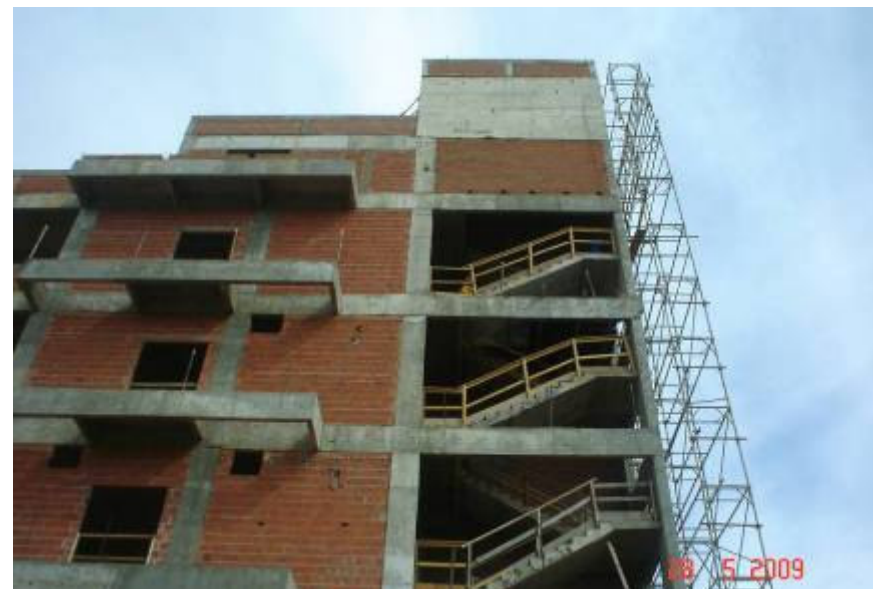
Detalhe do andamento da vedação externa com alvenaria de uma vez
