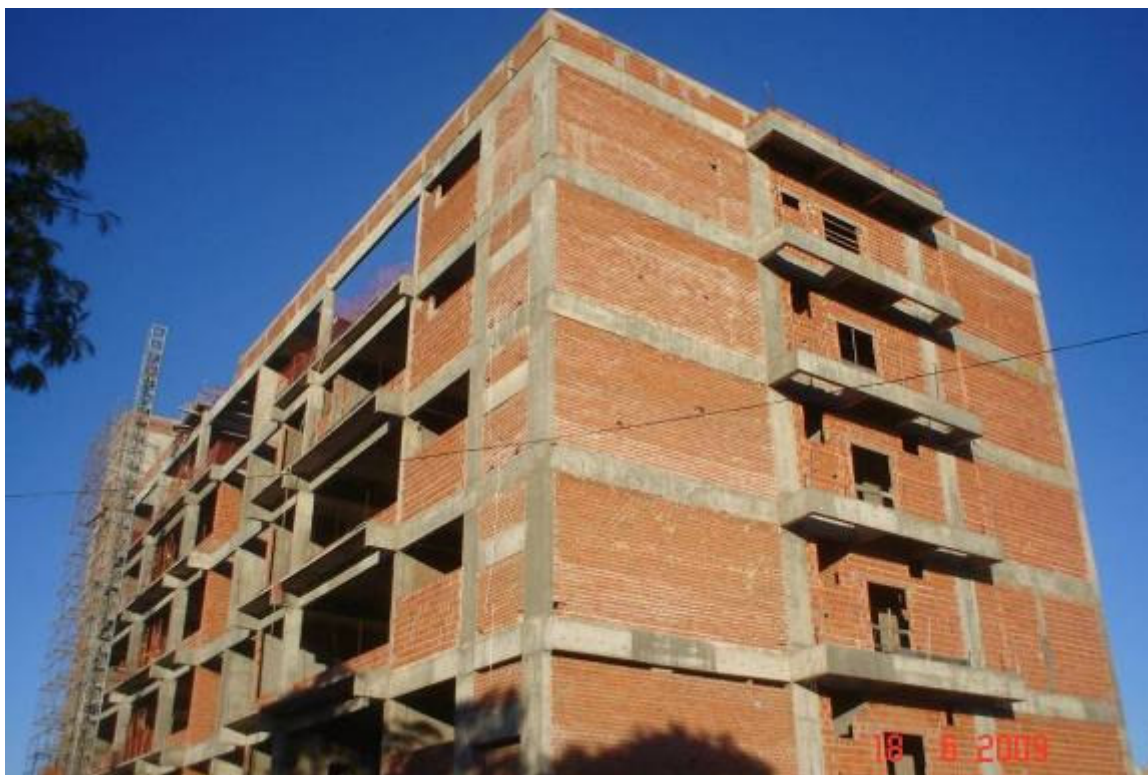
Detalhe da estrutura do prédio encerrada.
