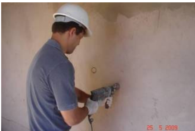
Abertura com serracopo para instalação do extrator
