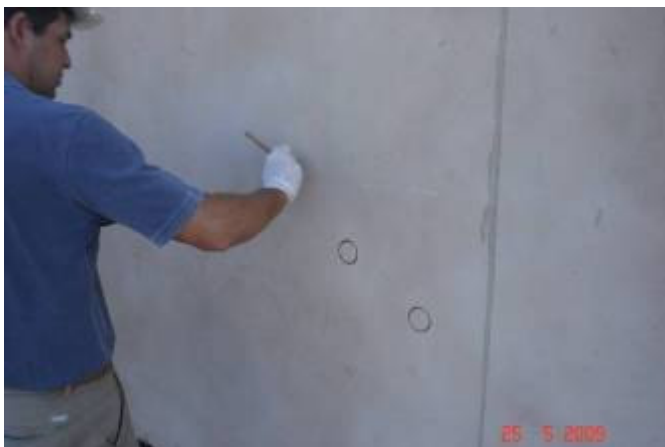
Marcação dos locais de extração do revestimento
