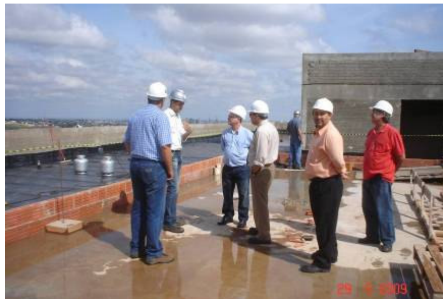
Visita dos Desembargadores da Comissão de Obra, junto com a fiscalização, Diretor Geral e o Engº da OAS.
