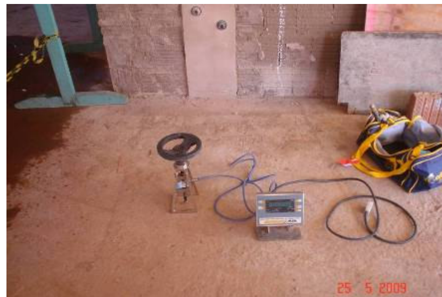
Equipamento de medição da força de resistência do sistema de revestimento
