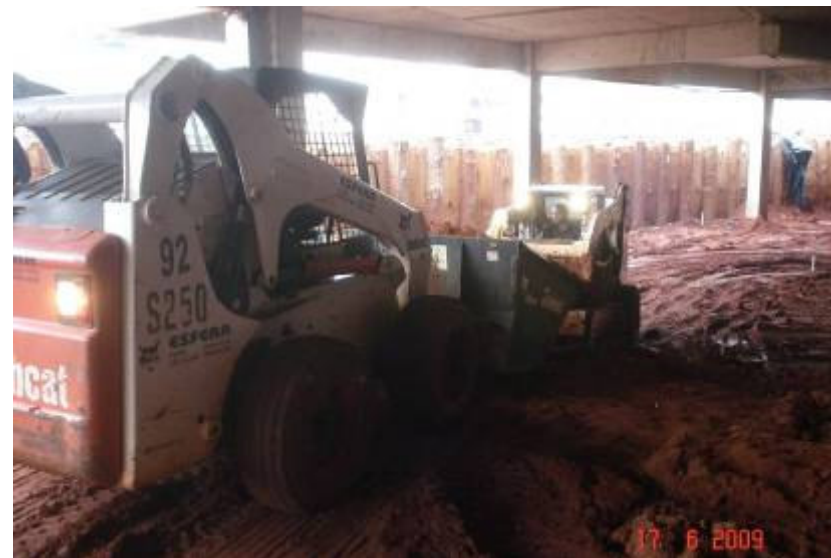
Detalhe do Bobcat executando a terraplanagem do subsolo
