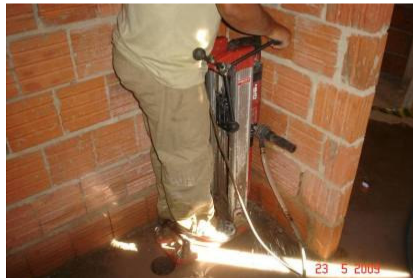
Detalhe da perfuração da laje para passagem de tubulação de esgoto
