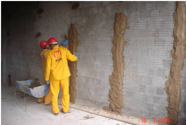
Talisa e execução das guias de massa de reboco
