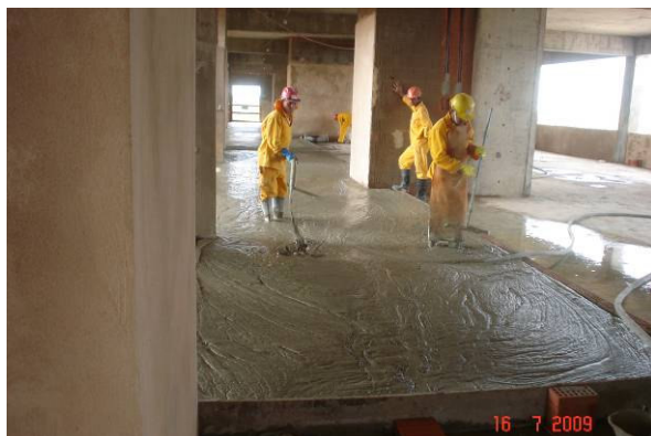
Execução de concreto celular
