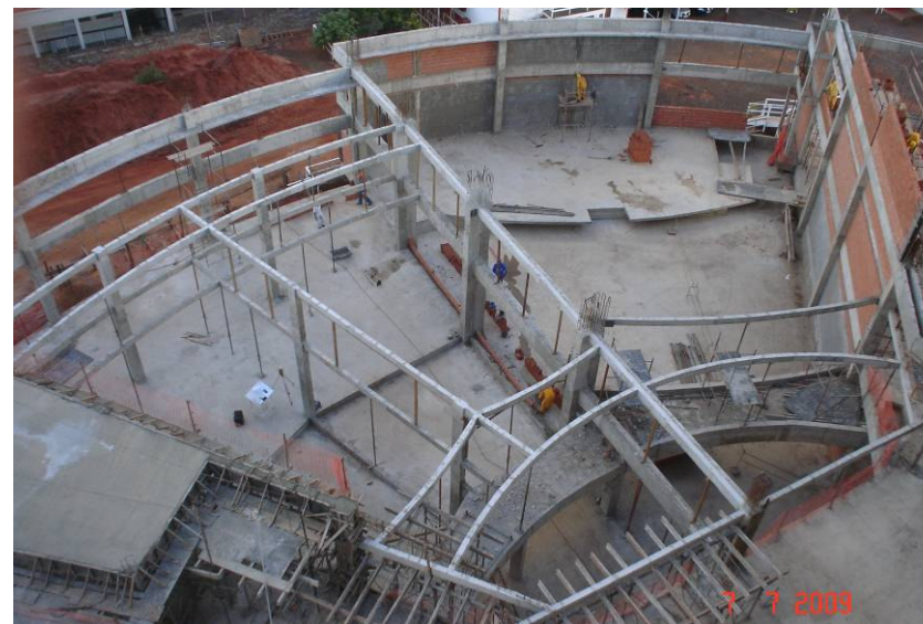
Vista da estrutura dos plenários
