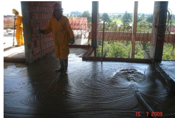
Lançamento de concreto celular
