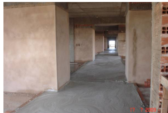
Concreto celular aplicado
