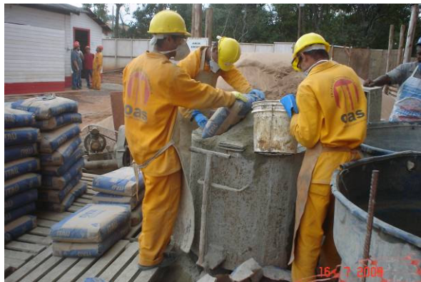
Preparação de concreto celular
