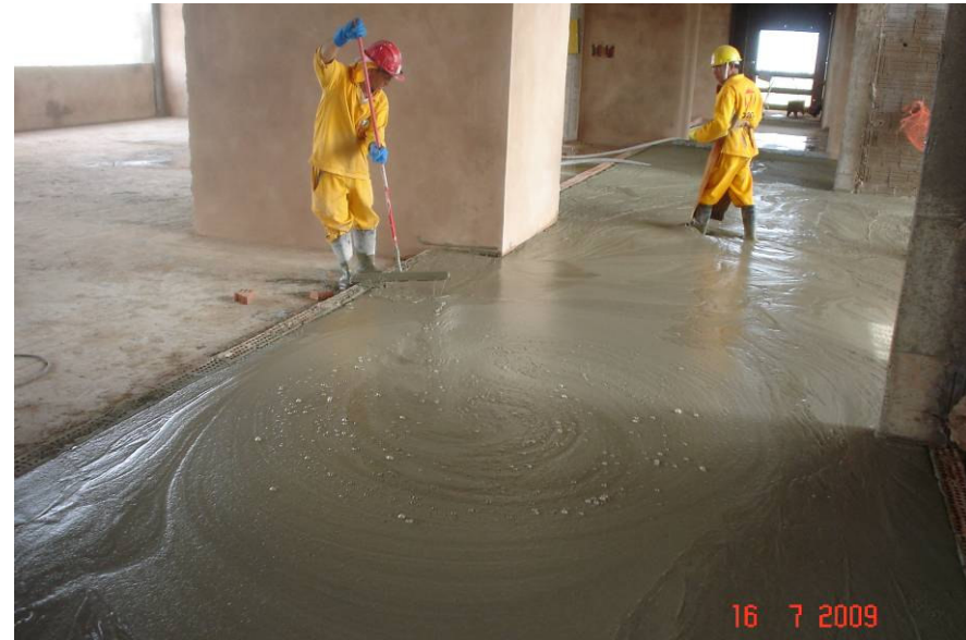
Lançamento e acabamento do concreto celular
