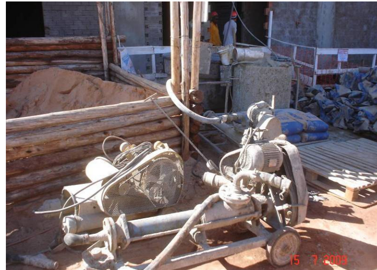
Detalhe da bomba de recalque para o concreto celular
