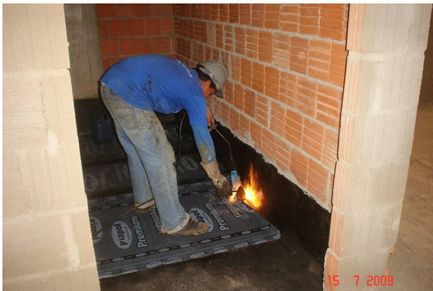
Detalhe de colocação de mantas em banheiros e copas
