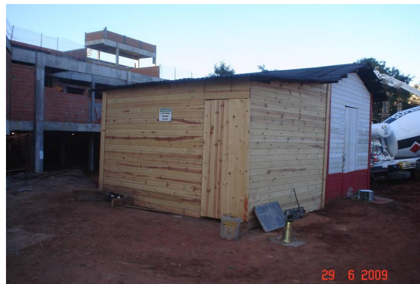
Detalhe do abrigo construído para abrigar o Grupo Moto Gerador
