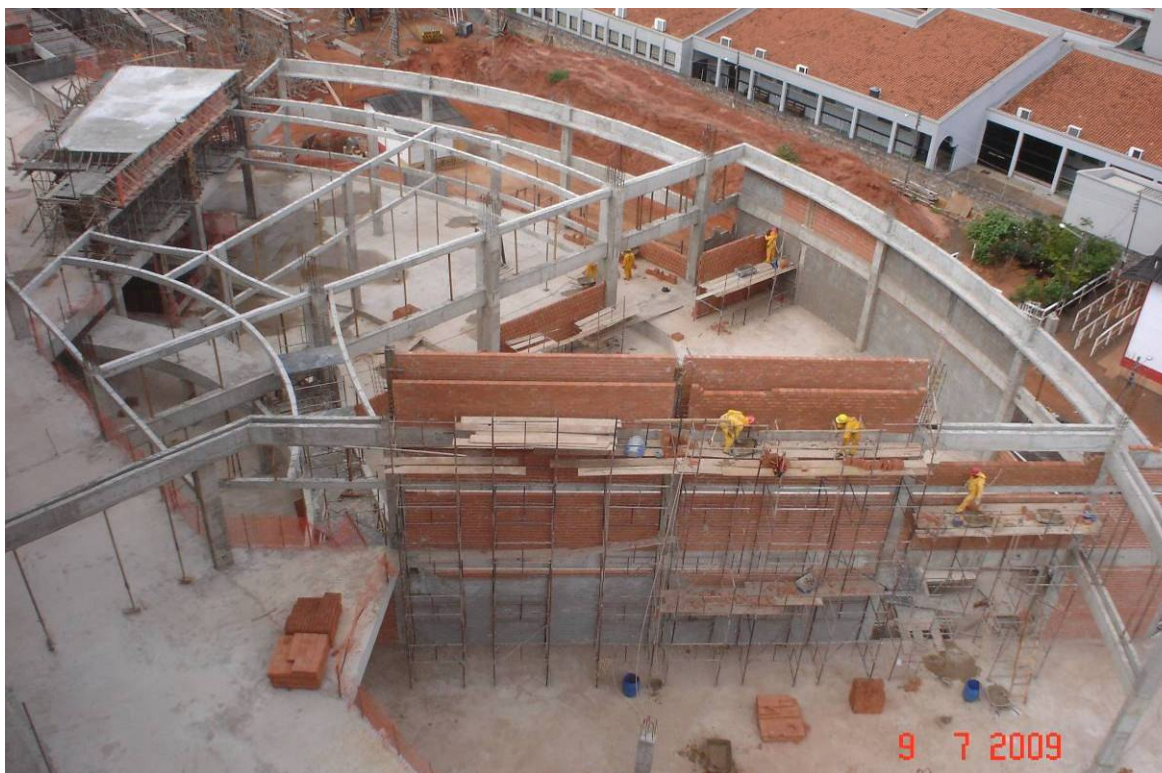
Detalhe da estrutura dos Plenários
