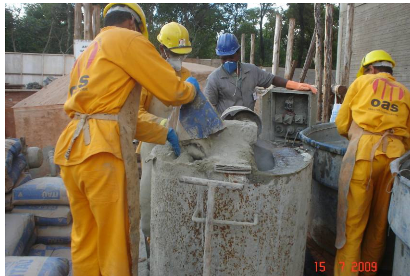
Usina de concreto celular montada no canteiro
