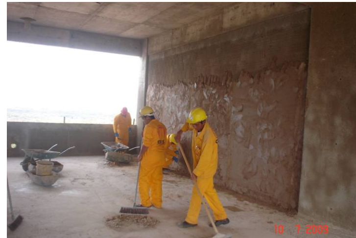
Detalhe da parede com a massa única aplicada
