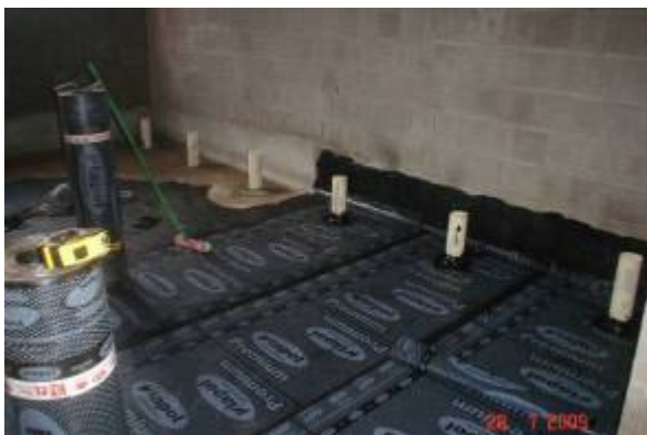
Detalhe de colocação de mantas em banheiros, copas e lajes
