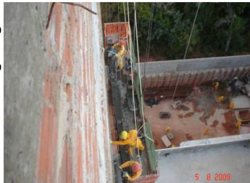
Detalhe da execução do chapisco externo com balancim
