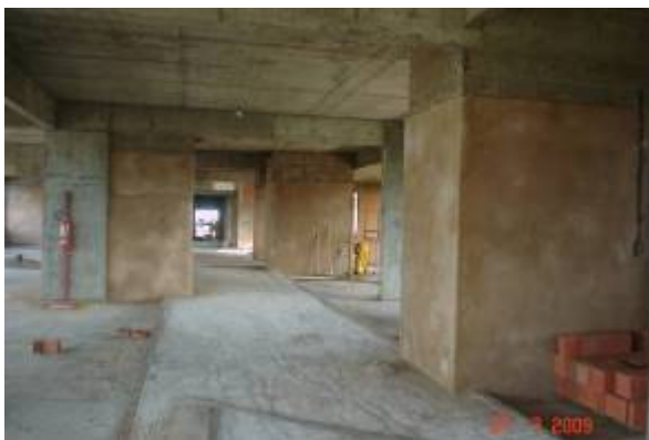
Detalhe da regularização do contra-piso sobre enchimento de concreto celular
