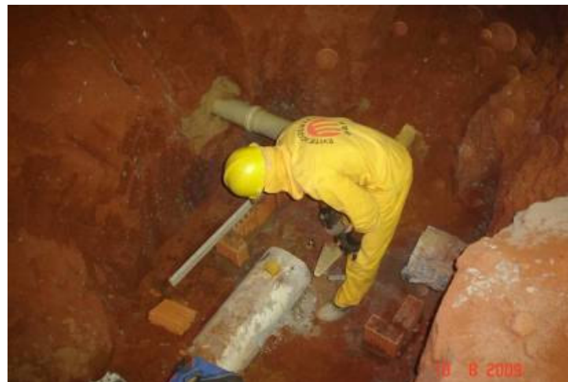
Detalhe da execução de caixa de inspeção no subsolo (sistema de drenagem)
