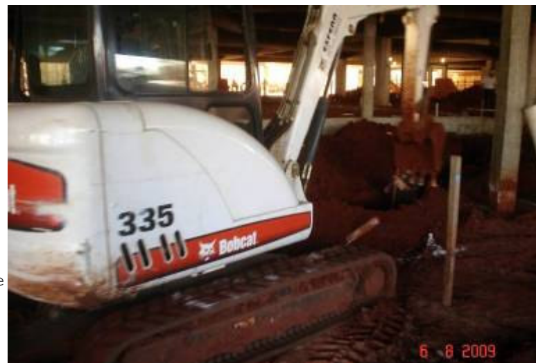
Bobcat de esteira com pá executando as valas para drenagem do subsolo
