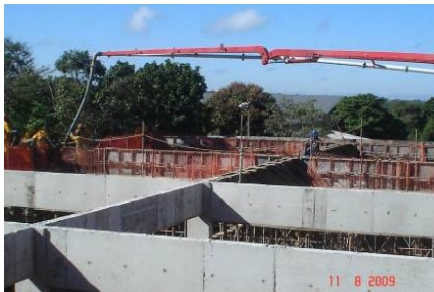
Detalhe da concretagem das vigas do almoxarifado
