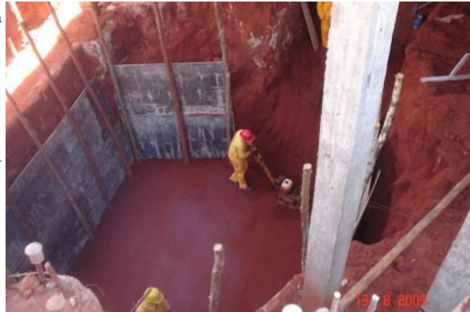
Compactação do fundo do reservatório inferior de águas pluviais com “sapo” (compactador mecânico)
