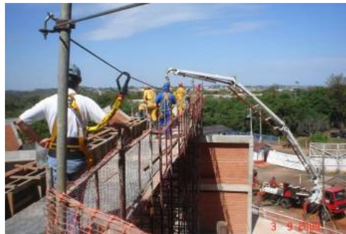
Detalhe da concretagem do pórtico do plenário
