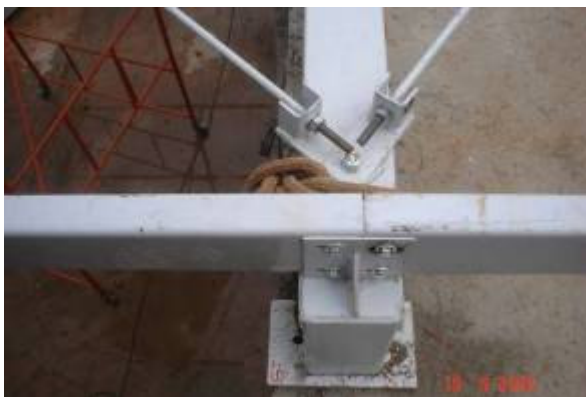
Detalhe da estrutura com as terças e com os tirantes de contra-ventamento
