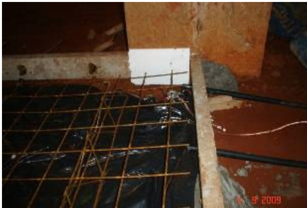
Detalhes do aterramento do piso, da junta de dilatação nos pilares e da tubulação da bomba de concreto
