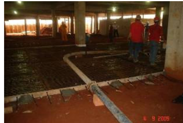
Detalhes do aterramento do piso, da junta de dilatação nos pilares e da tubulação da bomba de concreto
