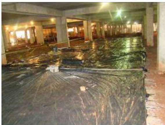
Colocação de lona para isolar o piso do solo e colocação da malha soldada de aço
