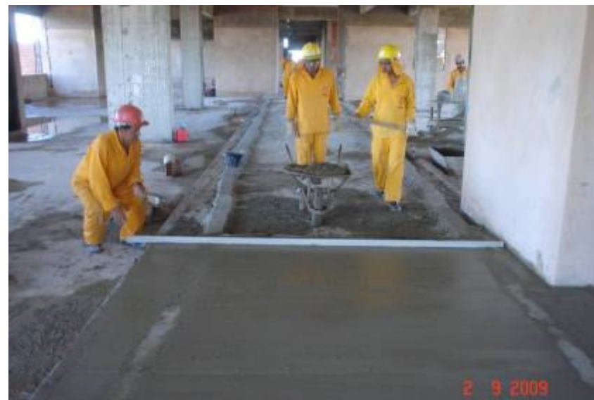
Execução da regularização do contra-piso
