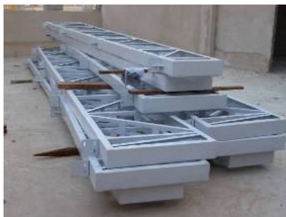
Detalhe das vigas treliçadas descarregadas e da fixação da viga (solda) no chumbador
