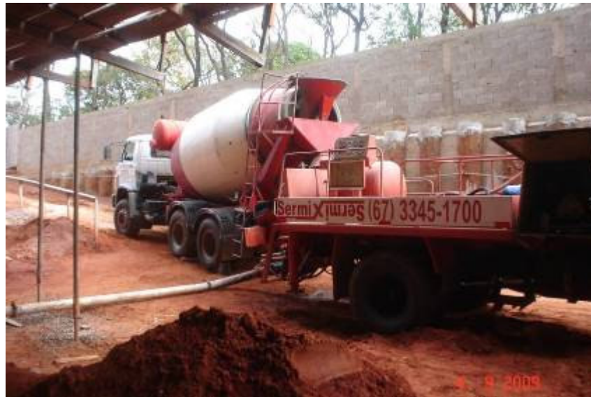
Detalhe da concretagem do piso do subsolo com concreto bombeado
