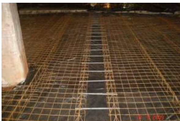
Detalhe de colocação da junta de dilatação e das barras de transição
