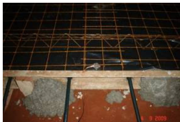
Detalhe de colocação da junta de dilatação e das barras de transição
