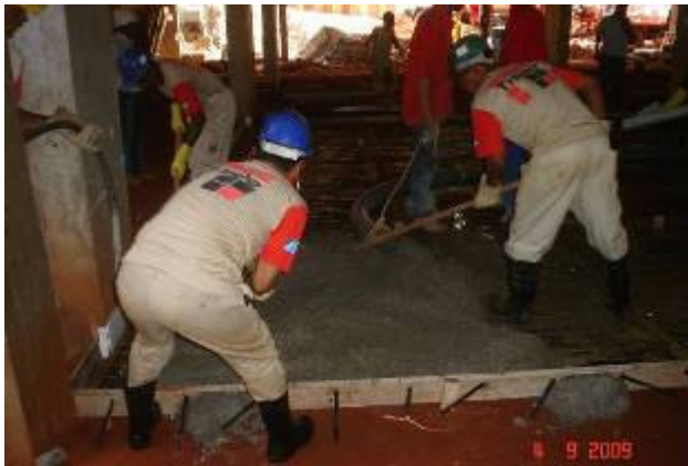
Detalhe do lançamento do concreto e seu acabamento (desempenamento)
