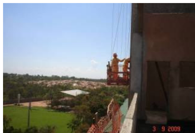
Detalhes do revestimento externo sendo executado em andaimes fachadeiros e balancim
