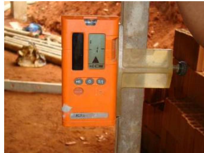
Nível eletrônico utilizado na execução do piso do subsolo
