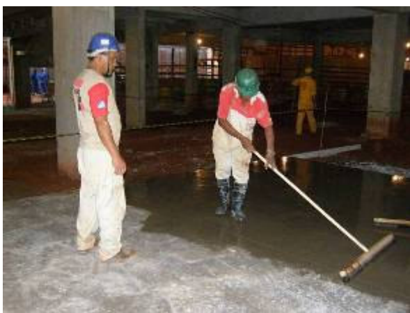
Calafetação do piso e retirada do trilho (guias)
