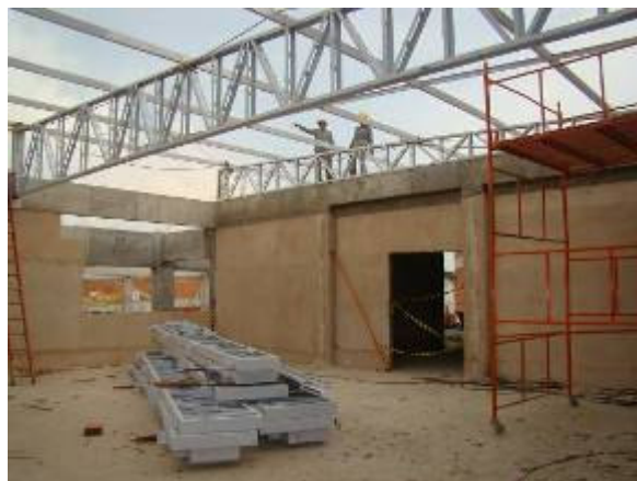
Detalhe das vigas instaladas e das terças na sala de treinamento
