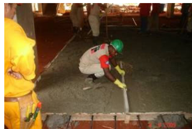
Detalhe do lançamento do concreto e seu acabamento (desempenamento)
