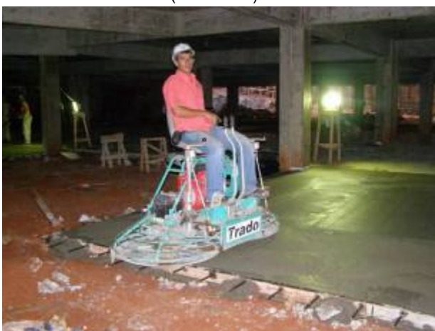
Acabadora (alisadora) dupla de concreto
