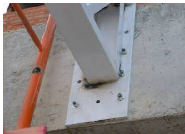
Detalhe das vigas treliçadas descarregadas e da fixação da viga (solda) no chumbador
