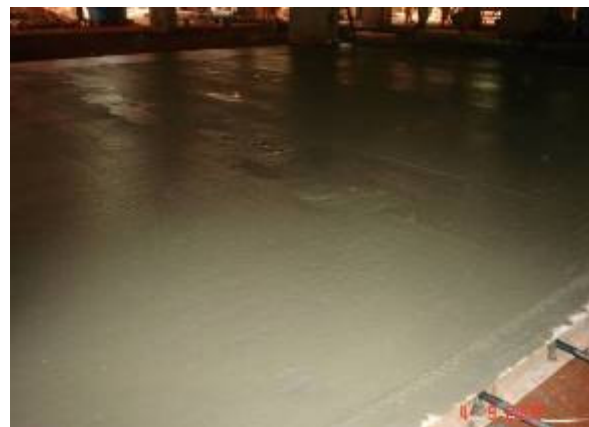
Polimento do concreto após a sua cura
