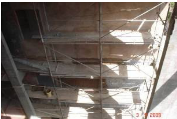
Detalhes do revestimento externo sendo executado em andaimes fachadeiros e balancim
