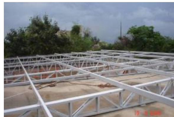
Detalhe da estrutura com as terças e com os tirantes de contra-ventamento
