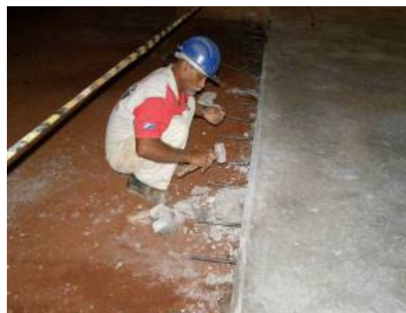
Calafetação do piso e retirada do trilho (guias)
