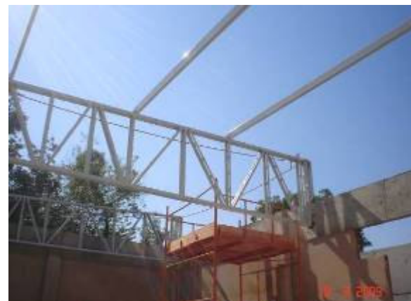
Detalhe das vigas instaladas e das terças na sala de treinamento
