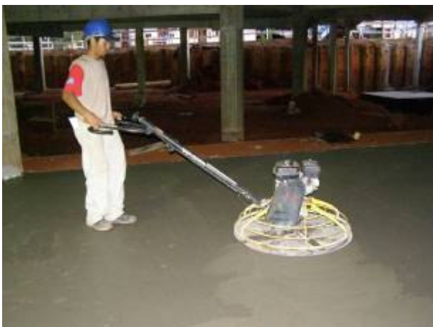
Acabadora (alisadora) de concreto
