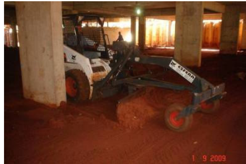
Nivelamento do solo para a execução do piso de concreto polido
