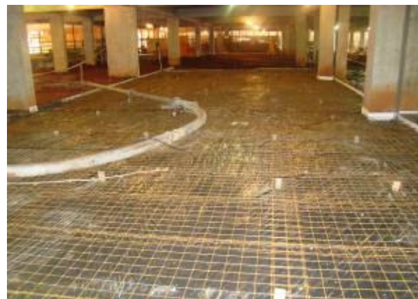
Colocação de lona para isolar o piso do solo e colocação da malha soldada de aço
