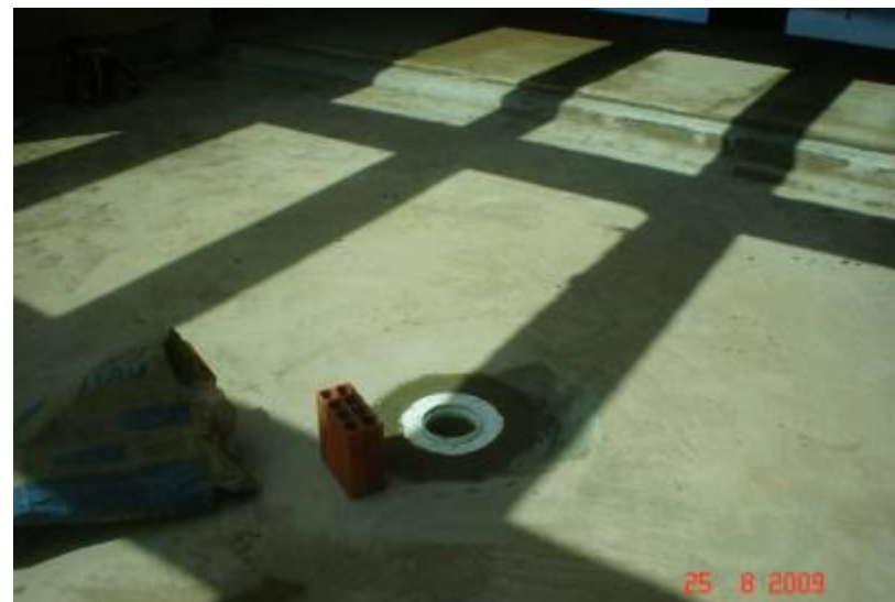
Detalhe do ralo anti-infiltração no terraço da cobertura
