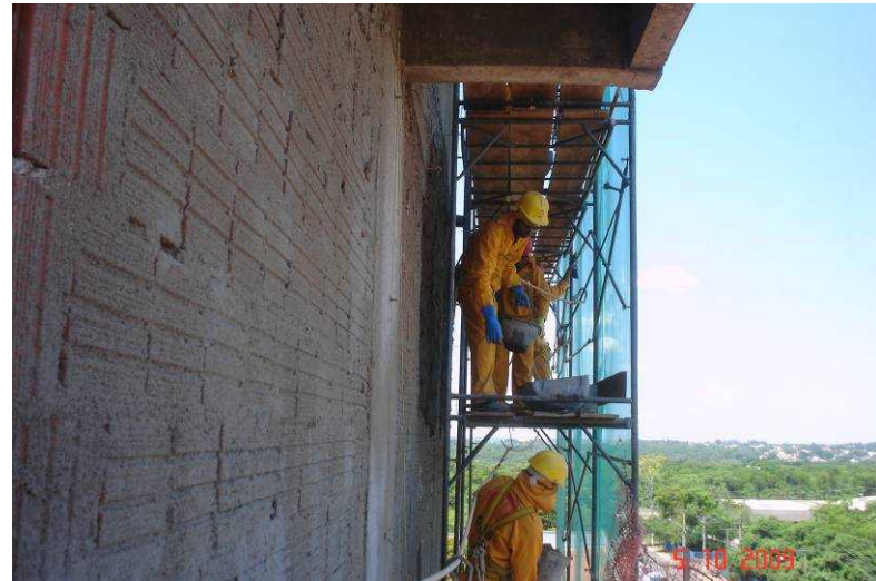
Detalhe do reboco externo, com utilização de andaime fachadeiro
