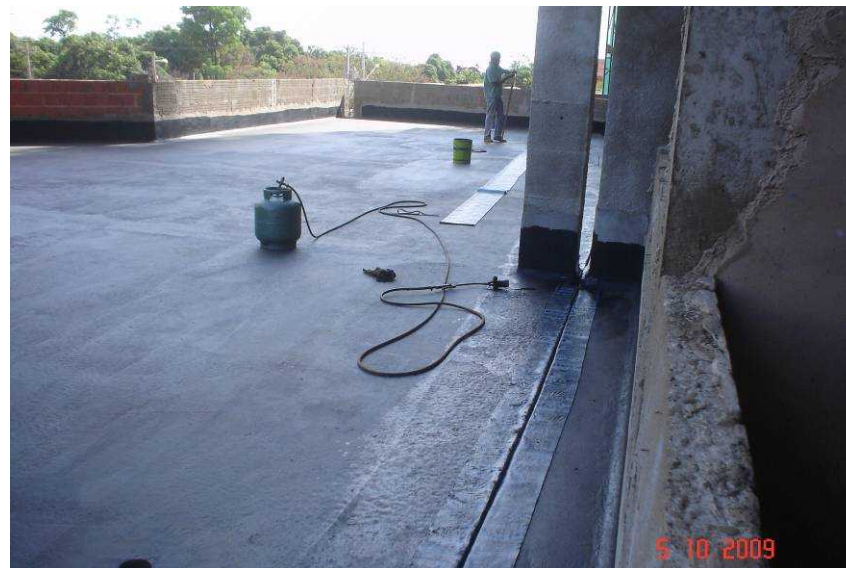
Detalhe da colocação de manta no jardim seco do 1º pavimento e da junta de dilatação
