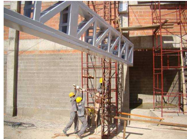
Detalhe das instalações das vigas treliçadas com guindaste e sarrilho
