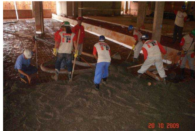
Detalhe da compactação, colocação de formas, armação e concretagem do piso do subsolo
