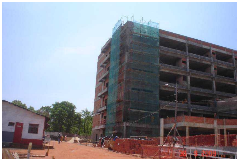
Vista parcial das fachadas sul e leste
