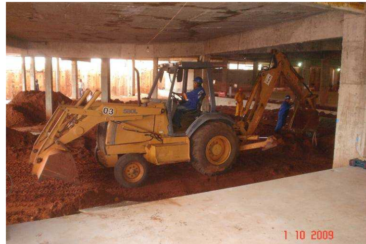
Detalhe da retro-escavadeira executando a regularização do terreno do subsolo
