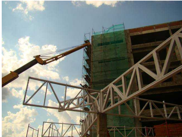
Detalhe das instalações das vigas treliçadas com guindaste e sarrilho
