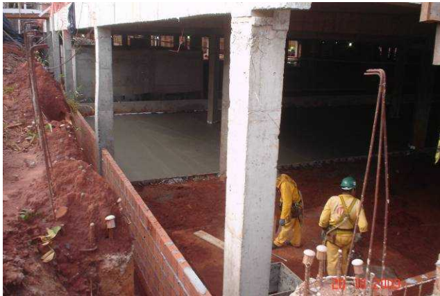
Detalhe da compactação, colocação de formas, armação e concretagem do piso do subsolo
