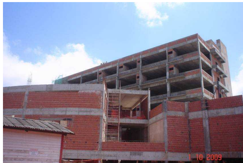
Vista externa do bloco dos Plenários
