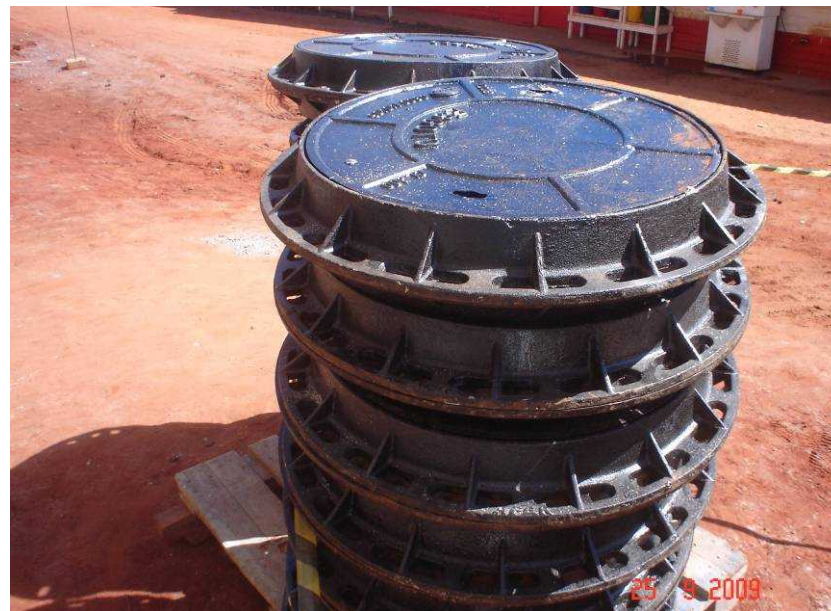
Detalhe das tampas de ferro fundido da rede de esgoto
