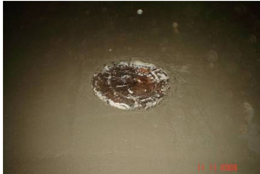
Detalhe da tampa da caixa de esgoto no subsolo
