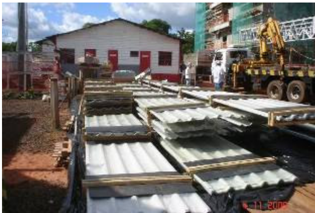
Descarga de telhas, rufos e calhas
