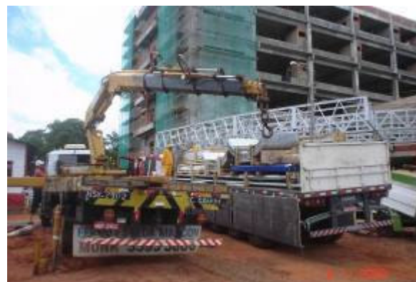
Descarga das telhas, calhas e rufos
