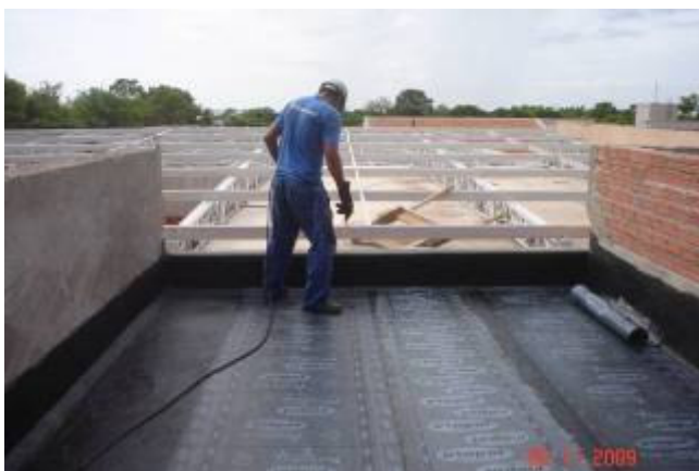
Detalhes da execução da impermeabilização, imprimação e aplicação da manta
