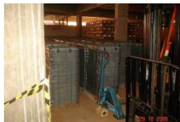
Detalhe do subsolo com o piso elevado e revestimento cerâmico depositado
