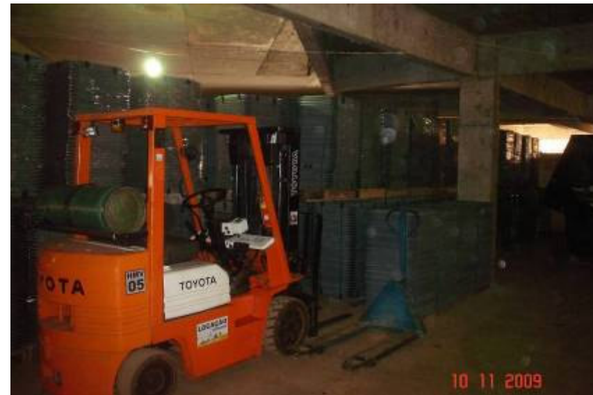
Detalhe da empilhadeira para descarga de pallets de piso elevado
