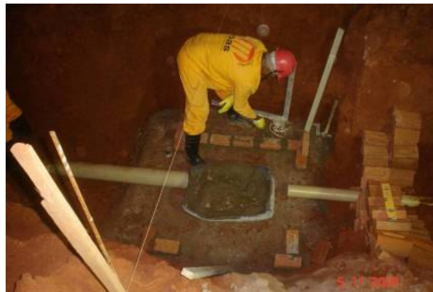
Detalhe da execução de caixa de passagem de águas pluviais
