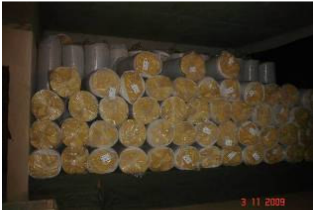
Lã de vidro depositada na obra
