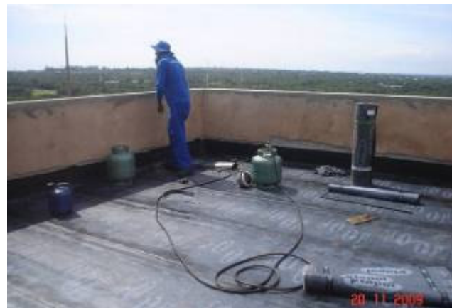
Detalhes da execução da impermeabilização, imprimação e aplicação da manta
