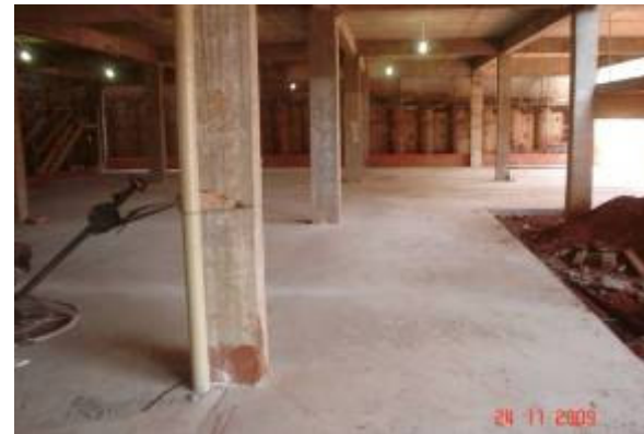
Detalhe do acabamento do piso de concreto
