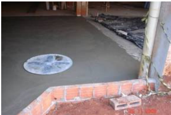
Detalhe do disco de acabamento do piso de concreto polido
