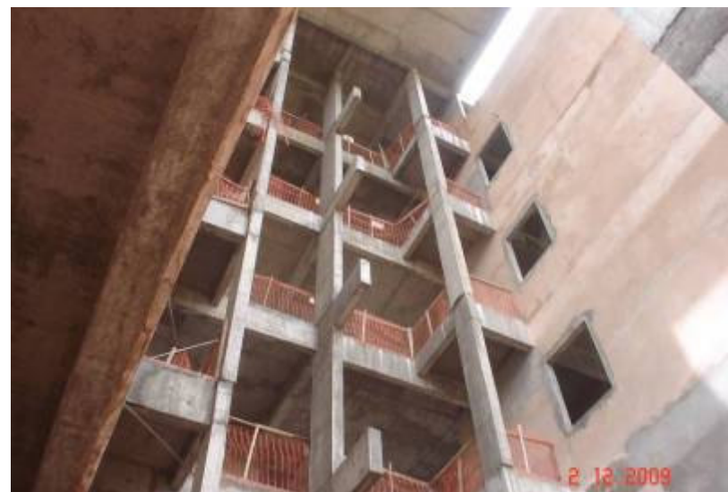
Detalhe da estrutura do hall dos elevadores panorâmicos
