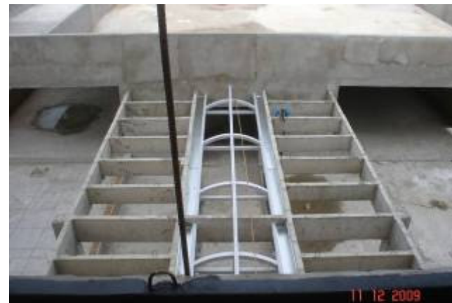
Detalhe da estrutura da cobertura da junta B para a junta C parte A
