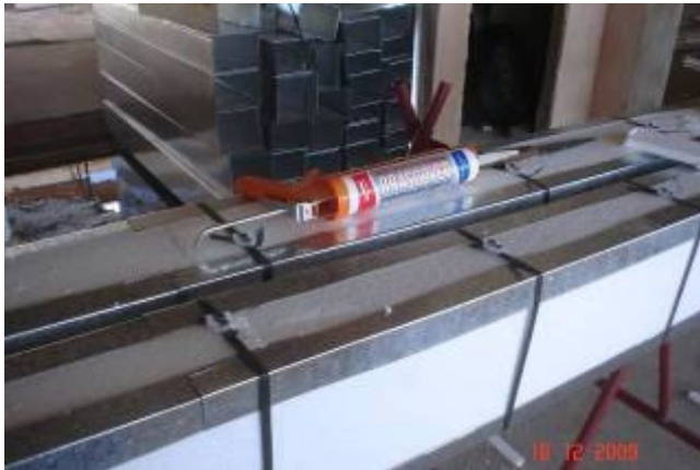
Montagem dos dutos de exaustão/insuflamento de ar
