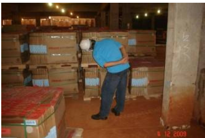
Detalhe da fiscalização conferindo o porcelanato
