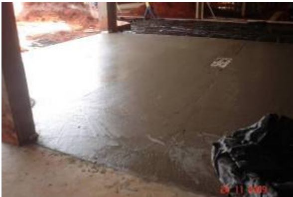
Detalhe do piso de concreto polido no subsolo
