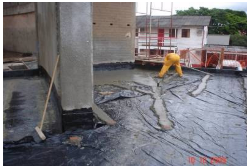
Detalhes da impermeabilização do espelho d'água do plenário principal e do espelho d'água e jardim seco do hall dos elevadores panorâmicos
