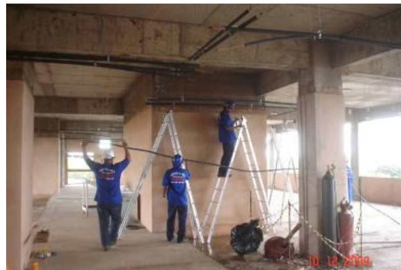
Detalhe da equipe de execução do sistema de climatização (Aeroclima)
