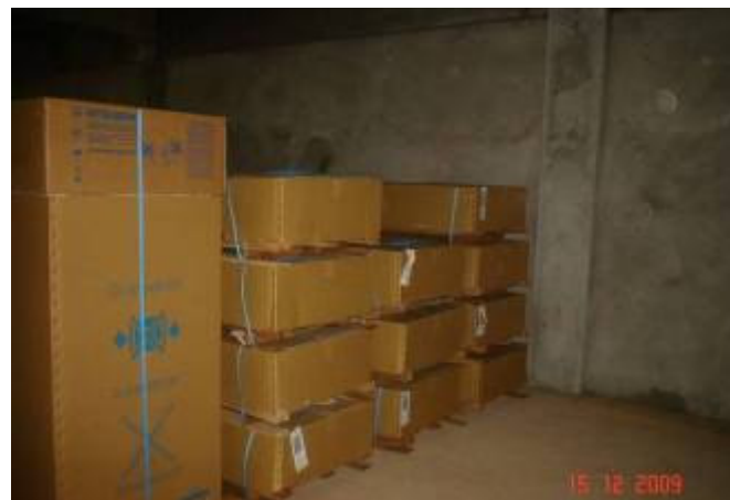
Detalhe dos equipamentos de ar condicionado (condensadoras e outros) depositados na obra
