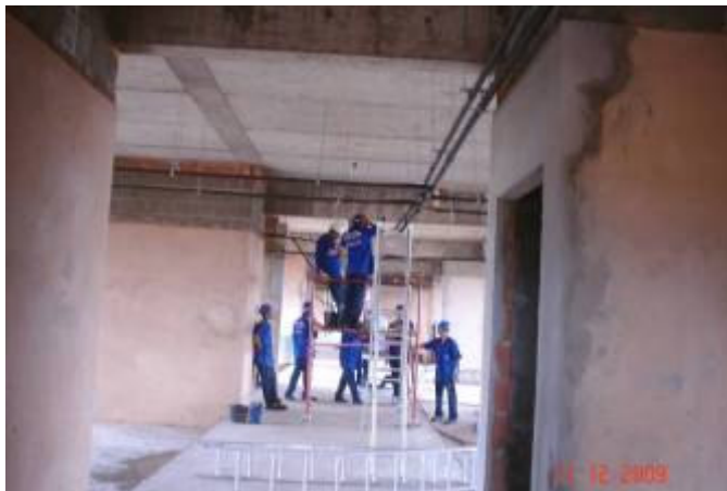
Detalhe da instalação da tubulação frigorígena
