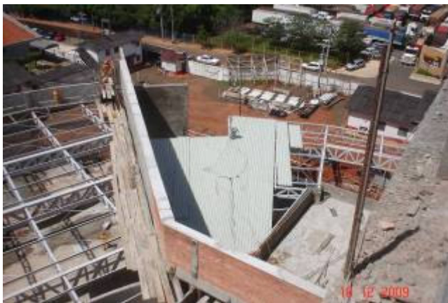
Início da colocação de telhas do hall de entrada
