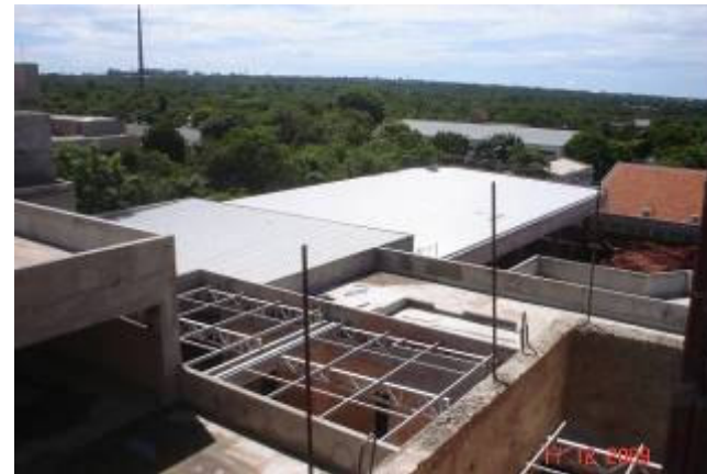
Cobertura concluída do almoxarifado/sala de treinamento
