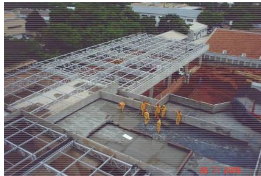
Detalhe da estrutura do almoxarifado, sala de treinamento e do lobby
