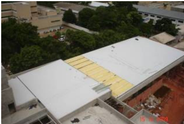
Detalhe da cobertura do almoxarifado/sala de treinamento com a proteção térmica/acústica
