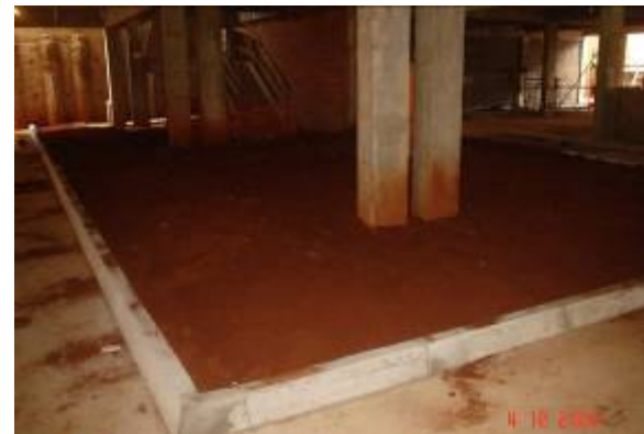
Detalhe do meio fio
