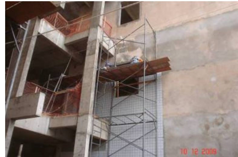
Detalhe do revestimento cerâmico interno (hall dos elevadores panorâmicos)
