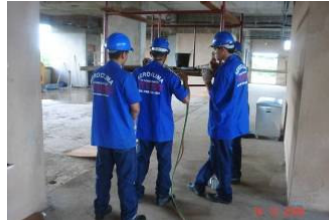
Solda em oxiacetileno de tubulação frigorígena
