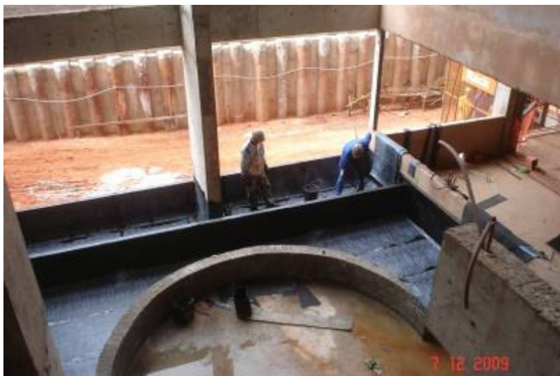
Detalhes da impermeabilização do espelho d'água do plenário principal e do espelho d'água e jardim seco do hall dos elevadores panorâmicos
