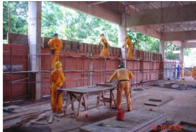
Detalhes da alvenaria de fechamento do almoxarifado
