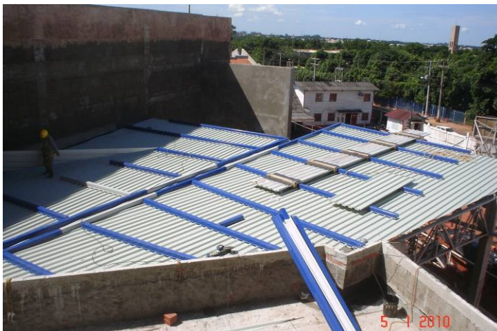
Detalhe da execução da cobertura no hall de entrada principal (pavimento térreo).
