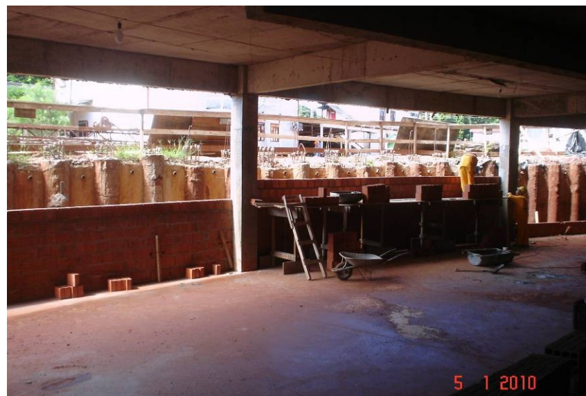
Detalhe da alvenaria no perímetro externo do subsolo.
