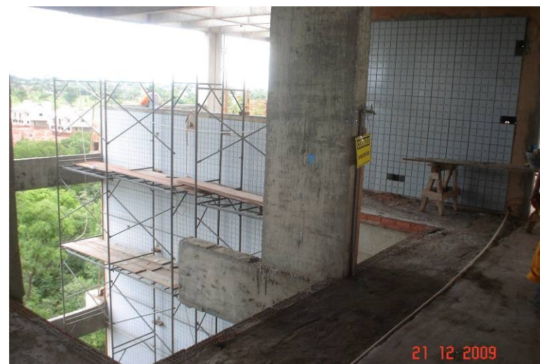
Detalhe do revestimento cerâmico aplicado na parede interna do 5º andar, junto aos vãos laterais dos elevadores panorâmicos.
