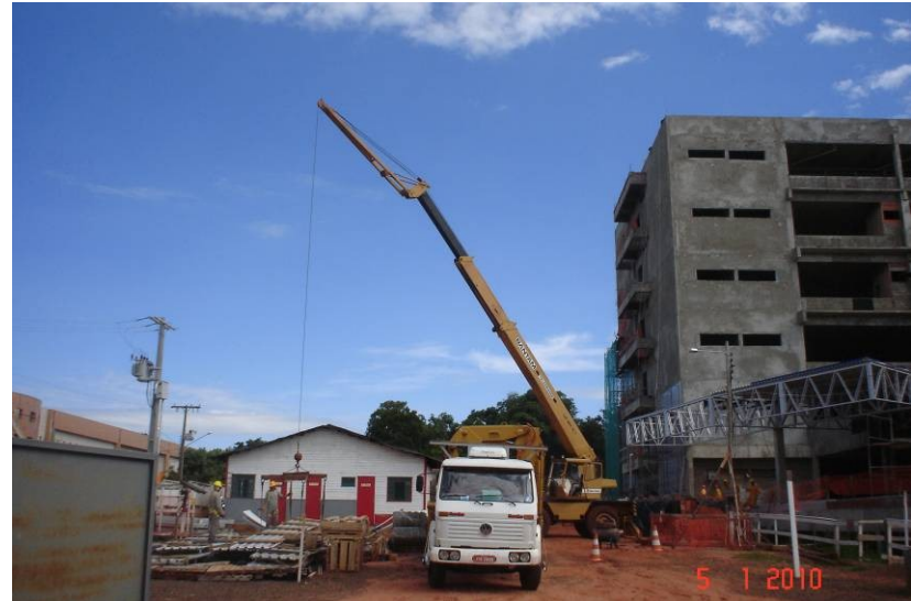
Detalhe do guindaste para içamento de telhas para cobertura.
