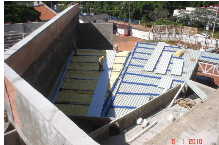
Aplicação de lâ de vidro e segunda camada de telha na cobertura no hall de entrada principal.
