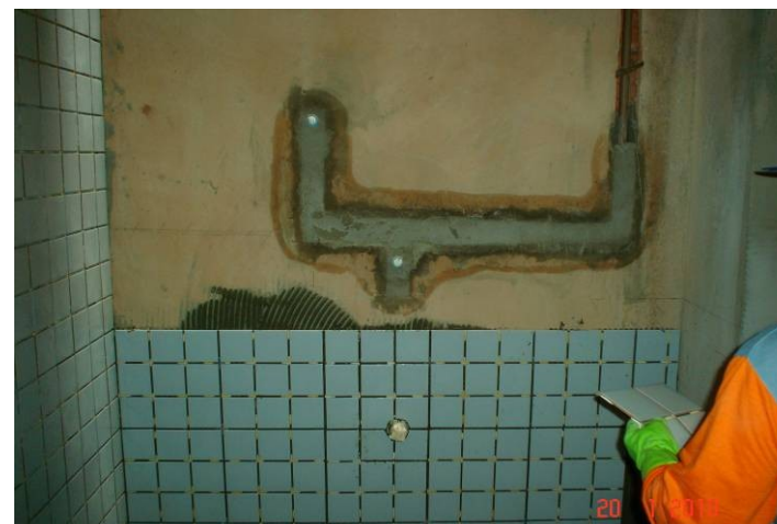
Detalhe do revestimento interno em cerâmica no espaço de lanche da sala de treinamento.
