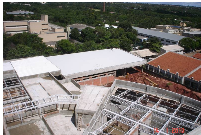
Detalhe da estrutura metálica (plenários) e cobertura do almoxarifado e sala de treinamento.
