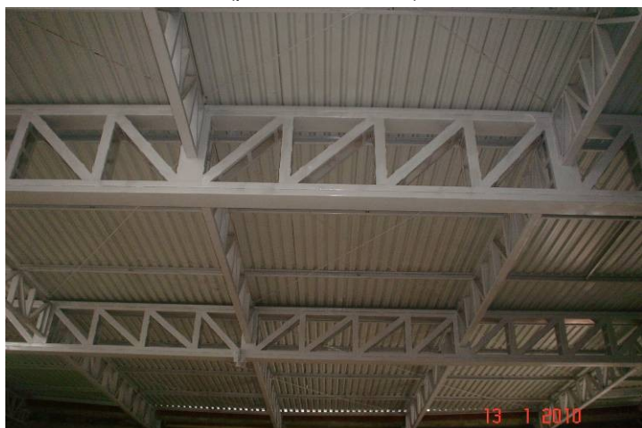
Detalhe da estrutura e da cobertura do plenário principal.
