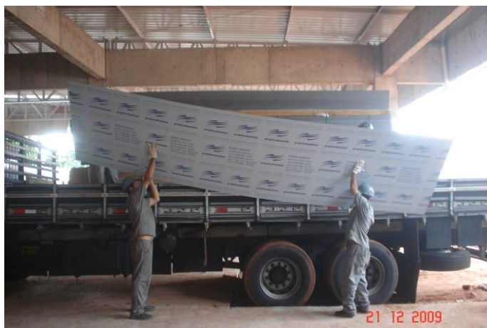
Detalhe da descarga de placas do revestimento em alumínio composto.
