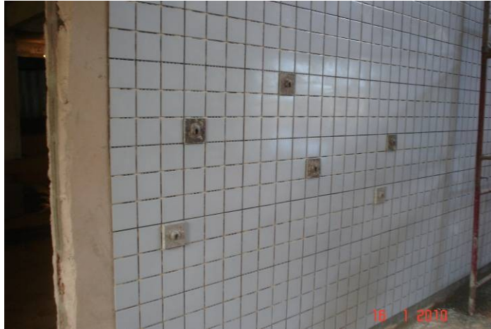
Detalhe do preparo da fixação das placas de arrancamento.
