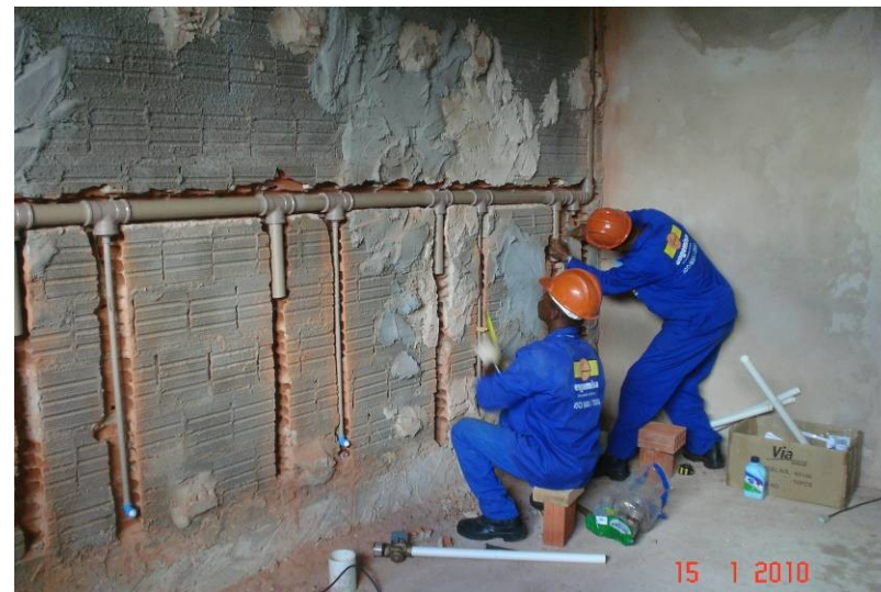
Detalhe da execução de tubulação de água fria nos banheiros.
