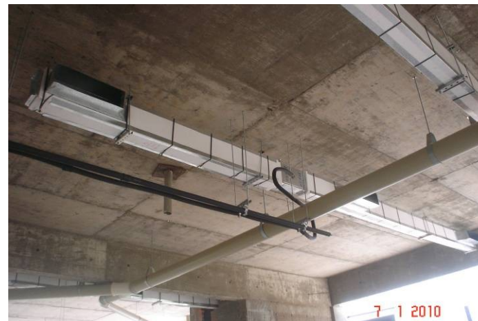
Detalhe da tubulação de águas pluviais no entre-forro do 5º pavimento.
