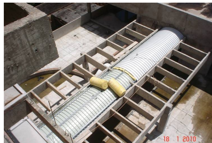
Detalhe da cobertura da passarela da junta B para a junta C da parte A.
