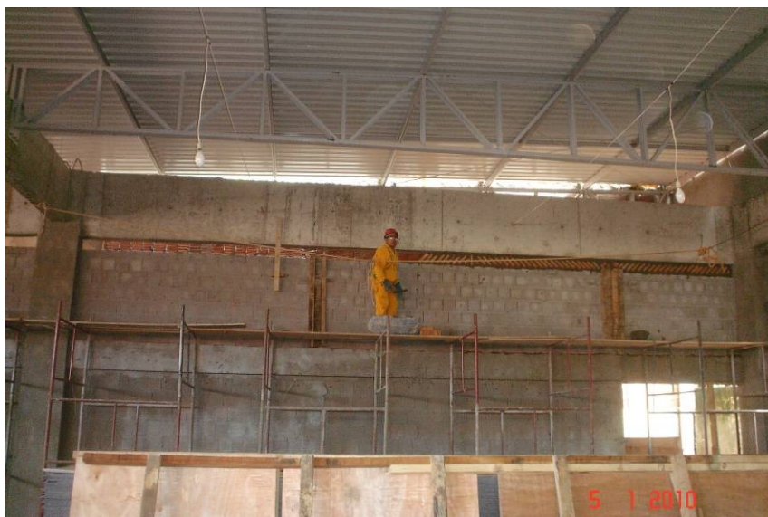
Detalhe da alvenaria de encunhamento do almojarifado.
