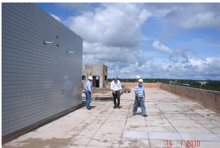
Detalhe do revestimento externo em cerâmica da casa de máquinas dos elevadores panorâmicos e da subestação na cobertura.
