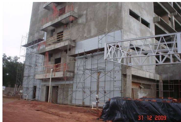
Detalhe da aplicação do revestimento cerâmico na fachada principal.
