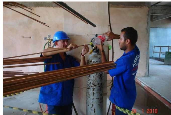
Limpeza interna da tubulação frigorígena.
