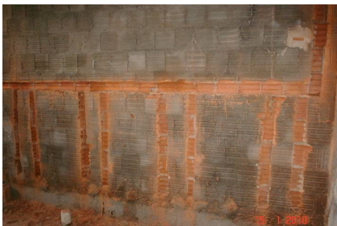
Detalhe de rasgos em alvenaria para colocação de tubulação de água fria.
