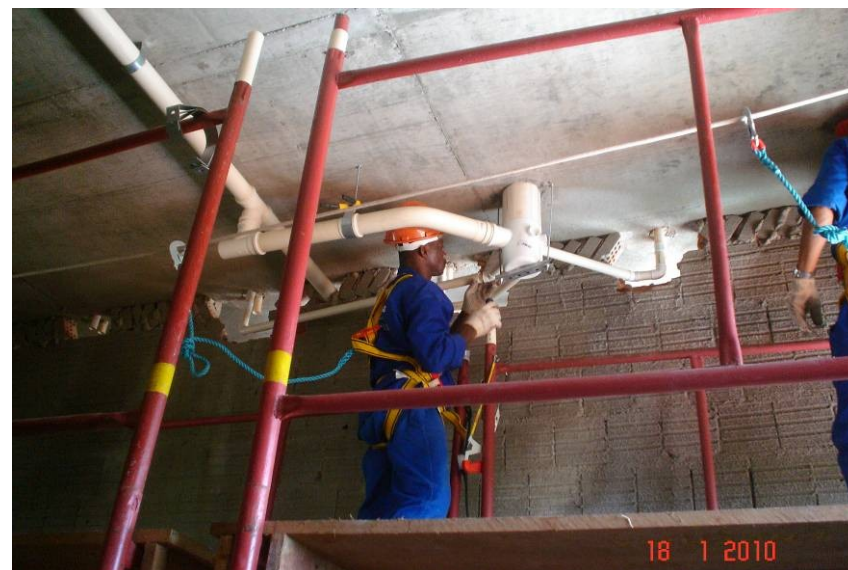
Detalhe da montagem da tubulação do ramal de descarga e ramal de esgoto dos banheiros da obra (equipe da Engemisa).
