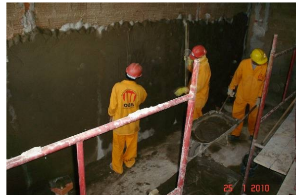
Detalhe do reboco interno no subsolo.
