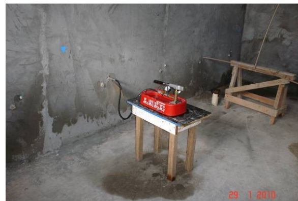
Detalhe do teste de pressão na tubulação de água fria (6 m.c.a.)
