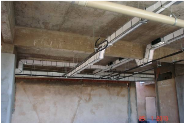
Detalhe dos dutos de exaustão/insuflamento e tubulação frigorígena.
