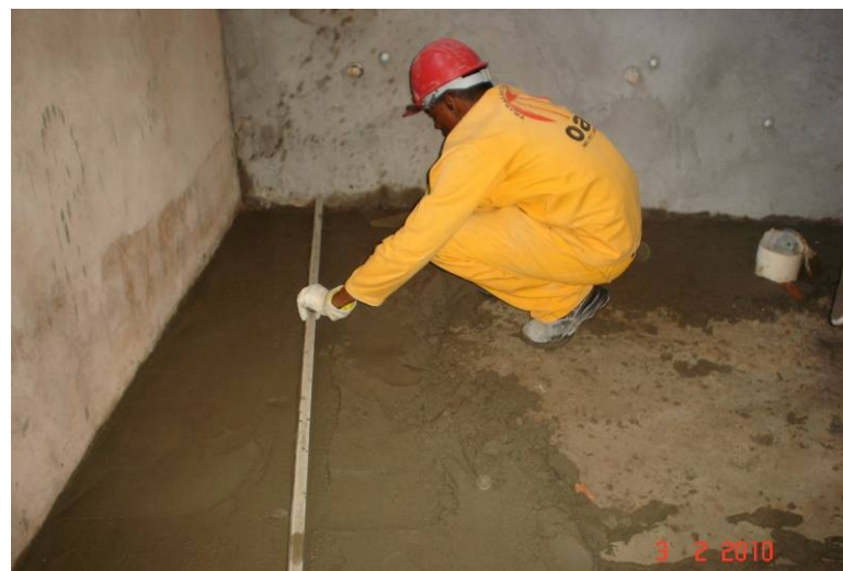
Detalhe da regularização de contra-piso das copas.
