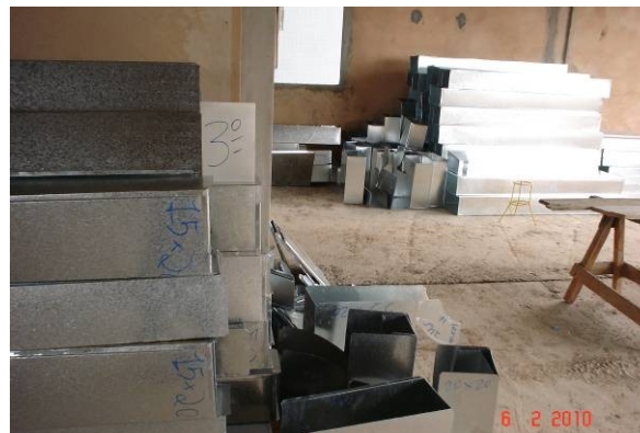
Detalhe dos dutos de exaustão/insuflamento fabricados e depositados na obra (3º pavimento).
