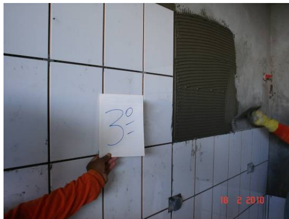
Detalhe do revestimento interno em banheiros coletivos.
