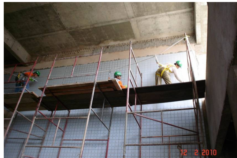
Detalhe do revestimento cerâmico aplicado na parede interna do hall da recepção no andar térreo.
