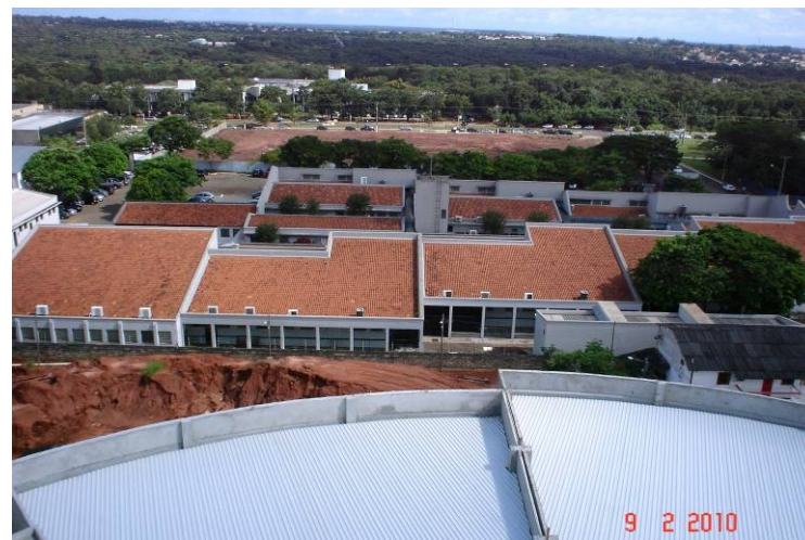
Vista geral das coberturas dos plenários.
