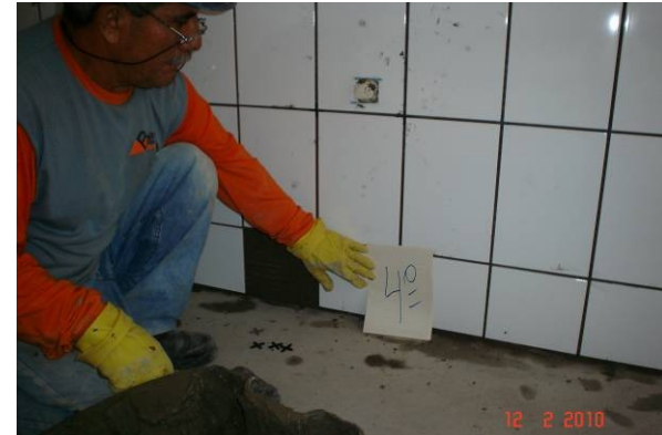
Detalhe do revestimento interno em banheiros coletivos.
