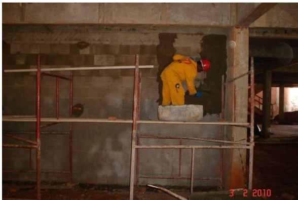
Detalhe do reboco interno no subsolo.
