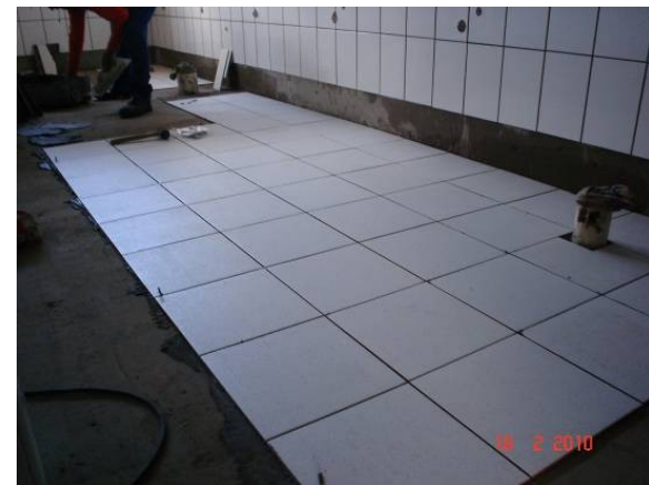
Detalhe do piso interno em banheiro coletivo.
