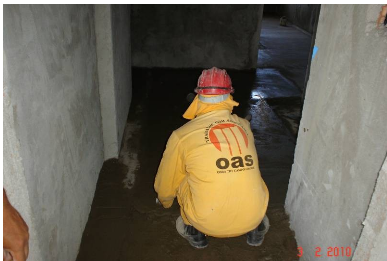
Detalhe da regularização de contra-piso dos banheiros internos.
