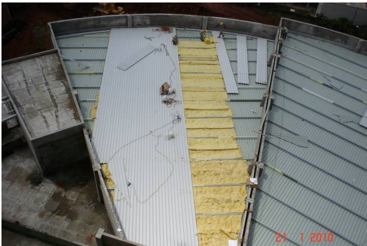
Aplicação de lã de vidro e segunda camada de telha na cobertura dos plenários das turmas.
