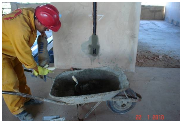
Detalhe do chumbamento de eletroduto rígido e caixa 2"x4" para instalações elétricas.
