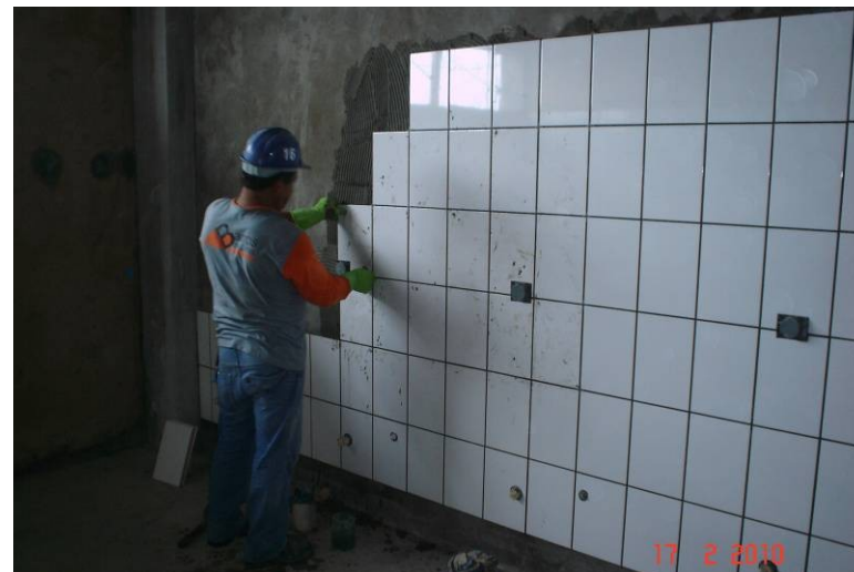
Detalhe da aplicação do revestimento cerâmico (azulejo) dos banheiros.
