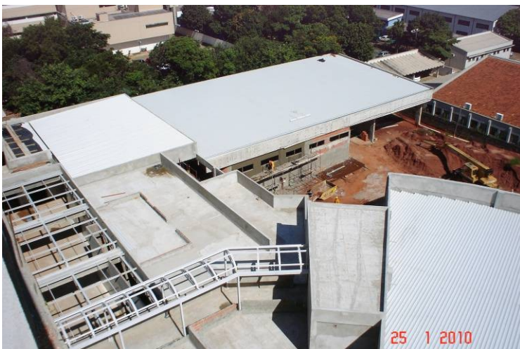
Vista geral das coberturas.
