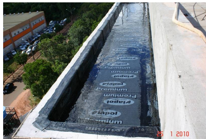
Detalhe da manta de impermeabilização em laje da cobertura
