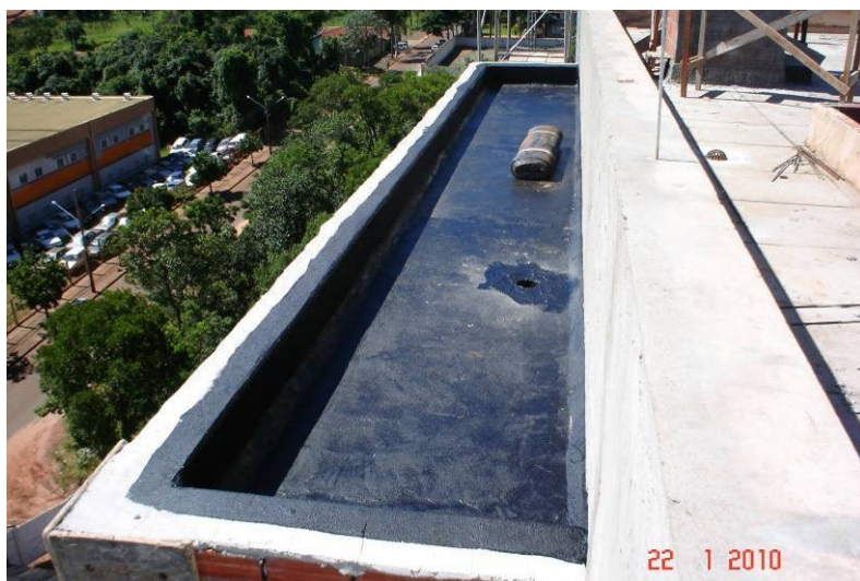
Detalhe da imprimação em laje da cobertura
