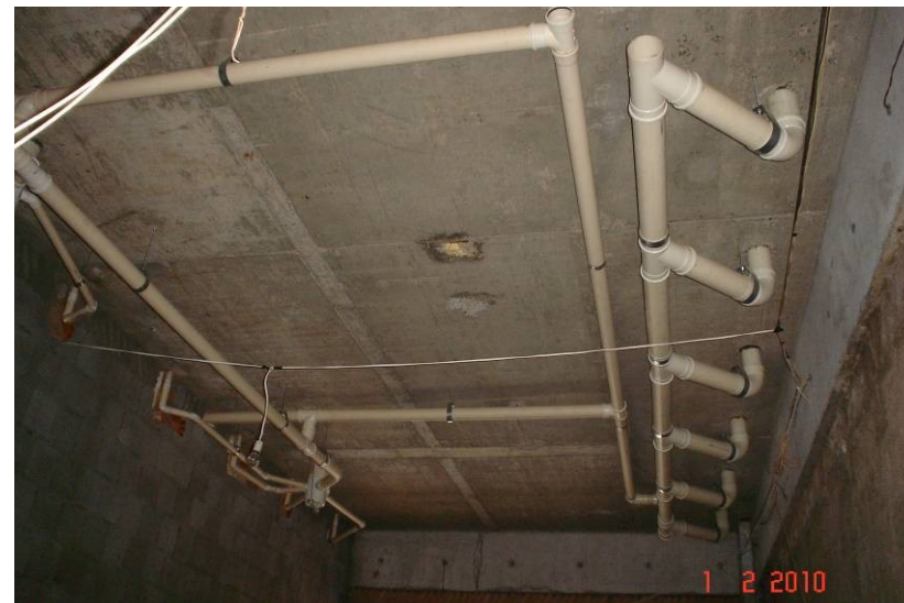
Detalhe da tubulação de esgoto sanitário dos banheiros.
