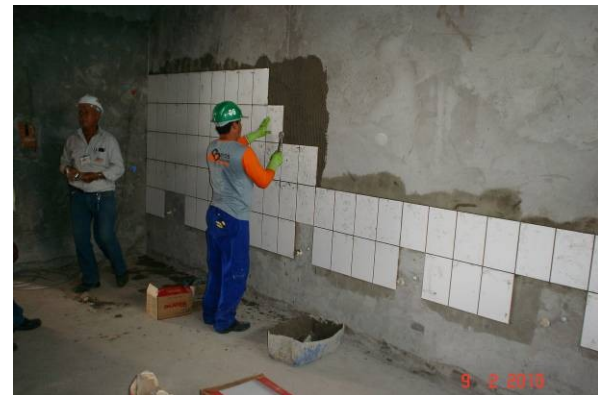
Detalhe do revestimento interno em banheiros coletivos.
