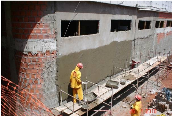
Detalhe do reboco externo do almoraxarifado.
