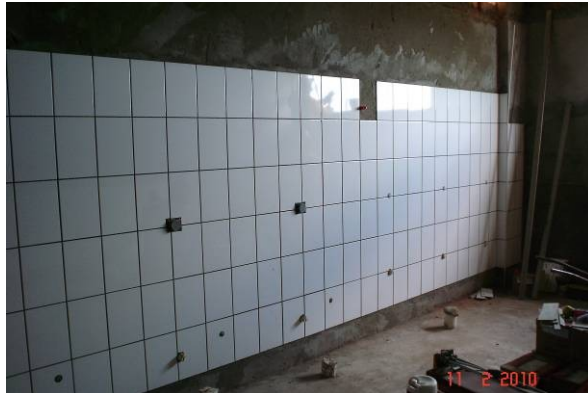
Detalhe do revestimento interno em banheiros coletivos.
