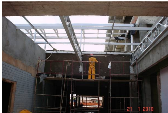
Detalhe do reboco interno na área dos sheds.
