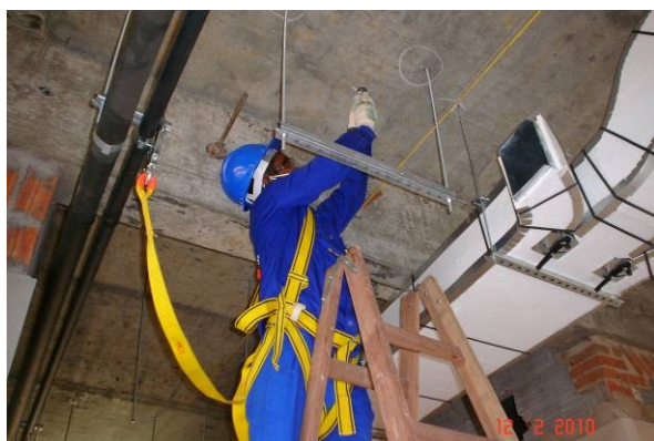
Detalhe da fixação na laje de suporte para eletrocalha.
