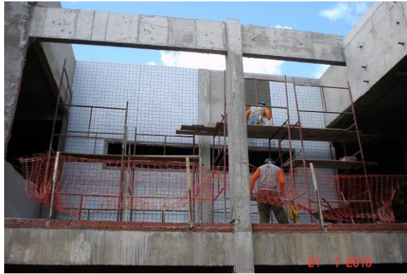
Detalhe do revestimento externo da junta C parte B.
