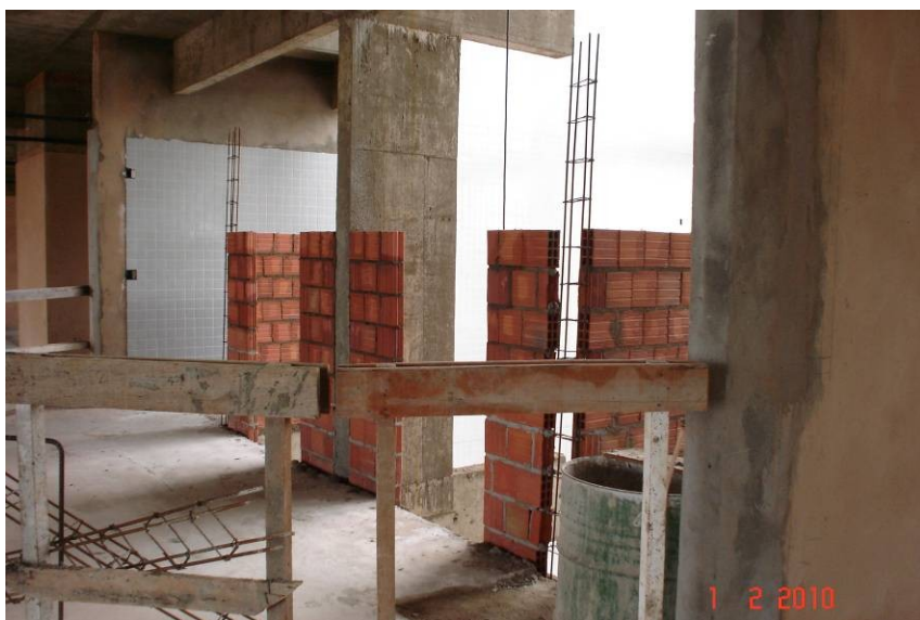
Detalhe da alvenaria da caixa de elevador panorâmico.
