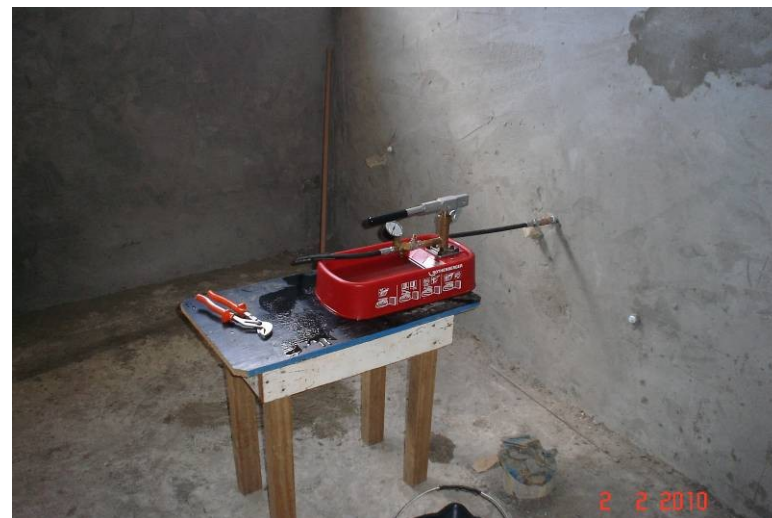
Detalhe da máquina de teste de pressão da tubulação de água fria.
