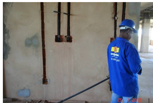
Detalhe do posicionamento dos eletrodutos rígidos e caixas 2"x4" para instalações elétricas.
