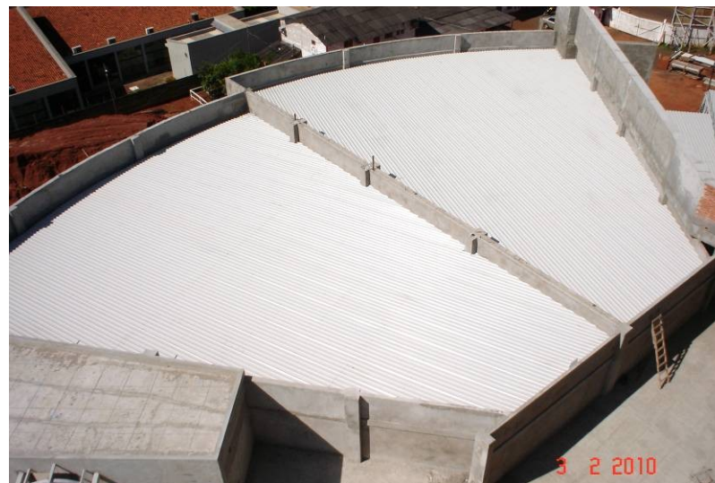
Detalhe da cobertura dos plenários.
