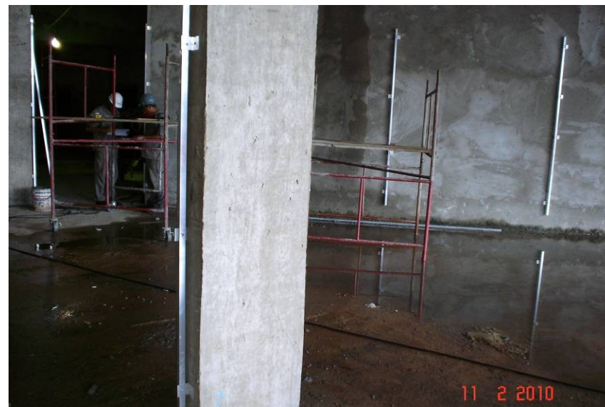
Detalhe dos suportes para alumínio composto de paredes e pilares do térreo (junta A parte B).
