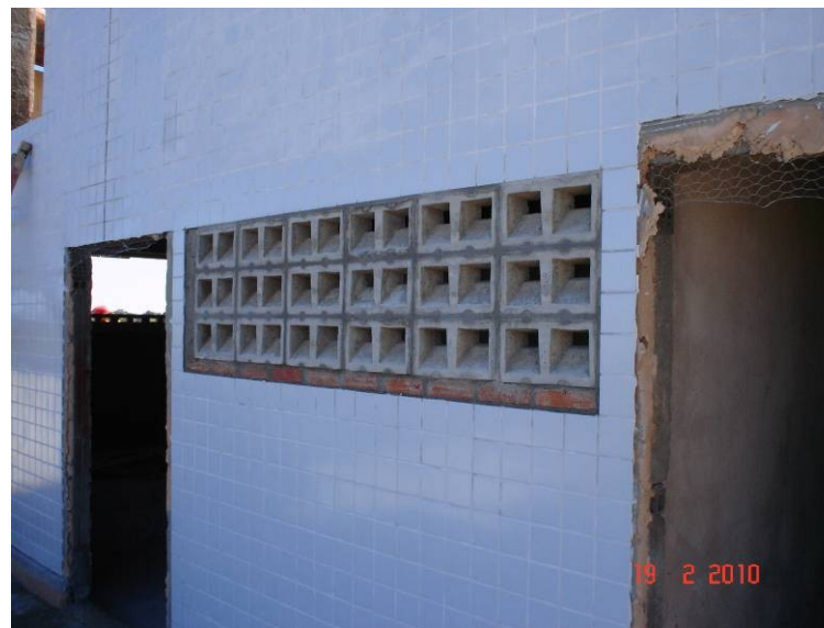
Detalhe do elemento vazado em concreto.
