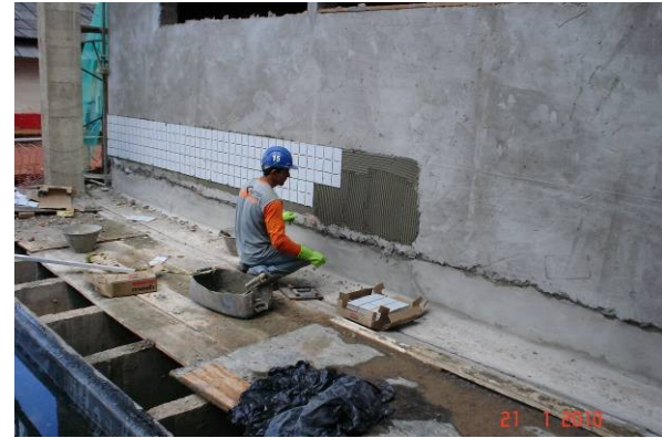
Detalhe do revestimento externo da junta A parte A (térreo).
