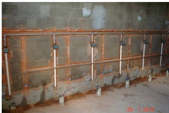
Detalhe da tubulação de água fria para válvulas de descarga dos banheiros.
