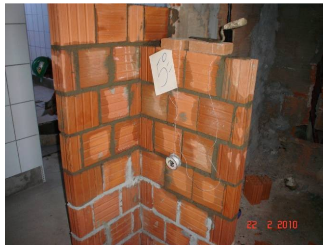
Detalhe da alvenaria do banheiro dos Portadores de Necessidades Especiais.
