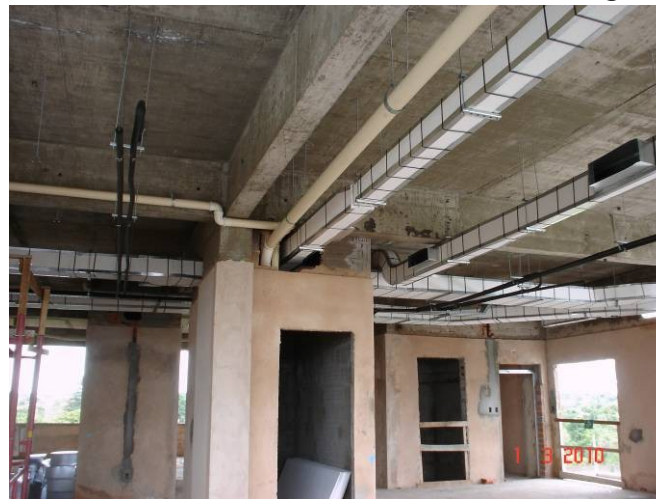
Detalhe dos dutos de exaustão/insuflamento e tubulação frigorígena (3º pavimento).
