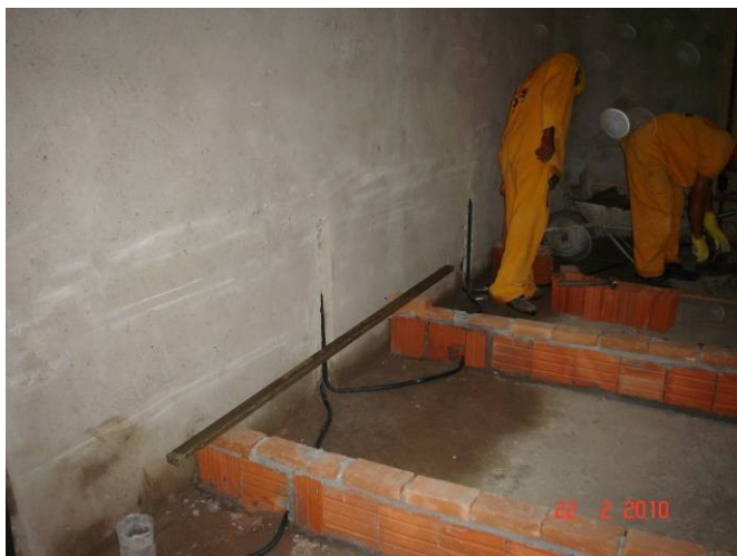
Detalhe da alvenaria do desnível das fileiras das poltronas do Plenário.
