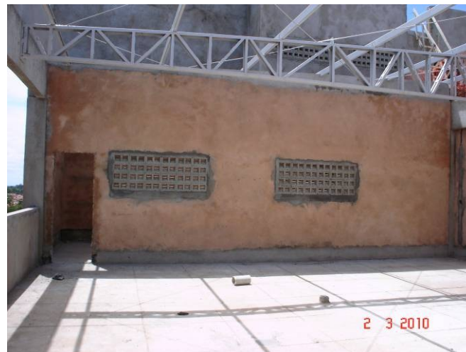
Detalhe da alvenaria em Combogó (elemento vazado) na casa de bombas da cobertura.
