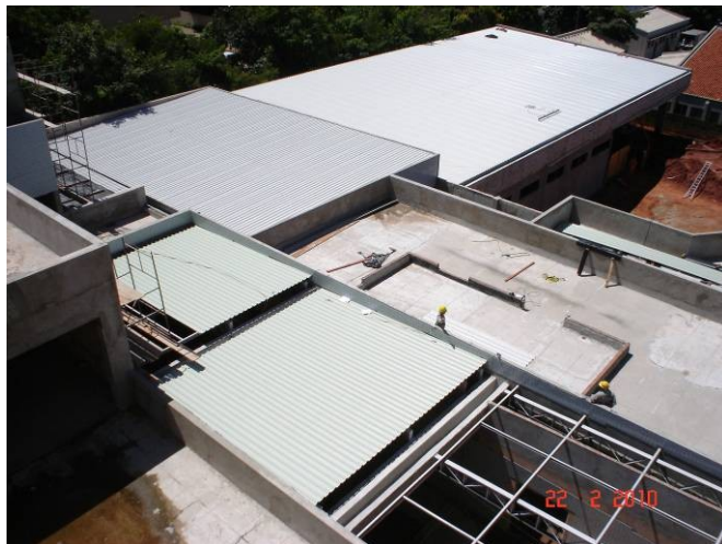
Detalhe da cobertura da junta C, parte B (área dos shads).
