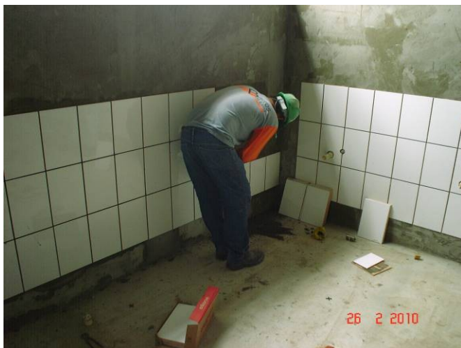
Detalhe da colocação do azulejo em banheiro coletivo.
