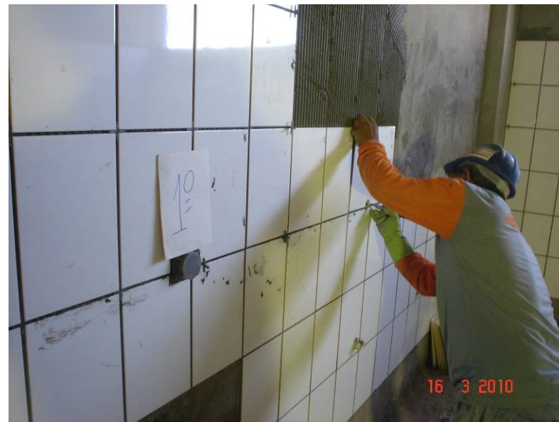
Detalhe do assentamento de azulejo em banheiros do 1º pavimento
