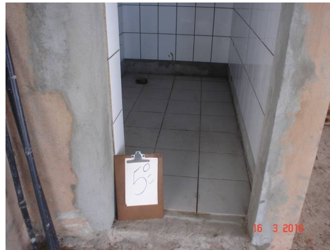
Detalhe do piso de banheiro individual do 5º pavimento.
