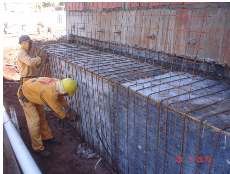
Detalhe da armação do fechamento entre o prédio e as estacas de contenção.
