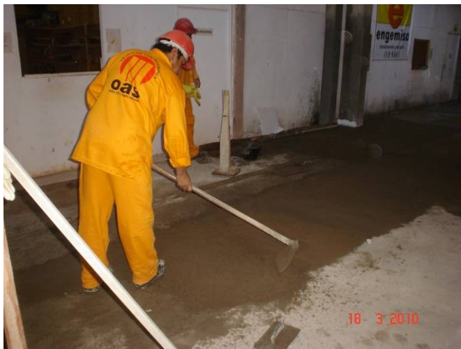
Detalhe da regularização de contra-piso do corredor da entrada principal.
