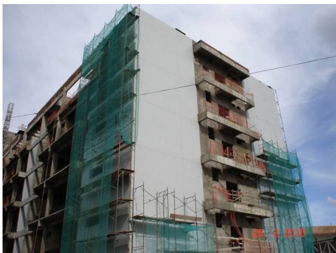
Detalhe do revestimento externo em pastilha cerâmica.
