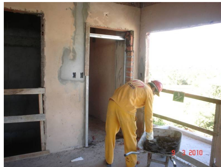
Detalhe do assentamento do batente de porta corta-fogo.
