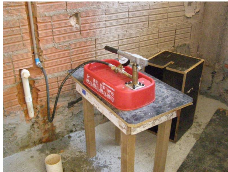
Detalhe do equipamento de pressurização da tubulação de Água Fria para teste de estanqueidade.
