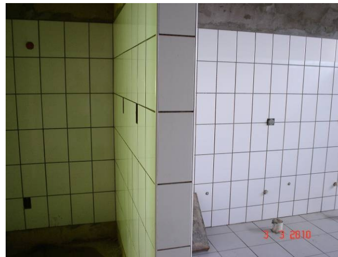
Detalhe do piso do banheiro coletivo.
