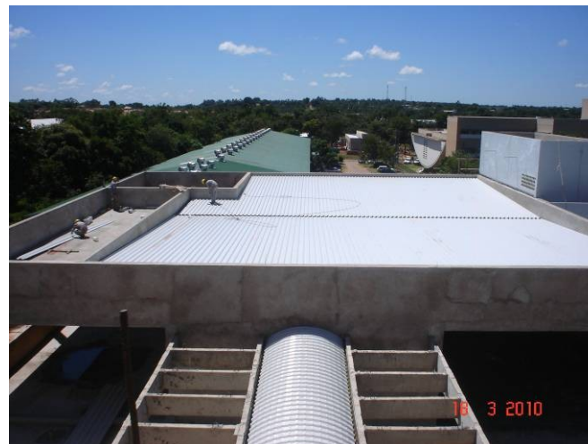
Detalhe da cobertura da junta C, parte A.
