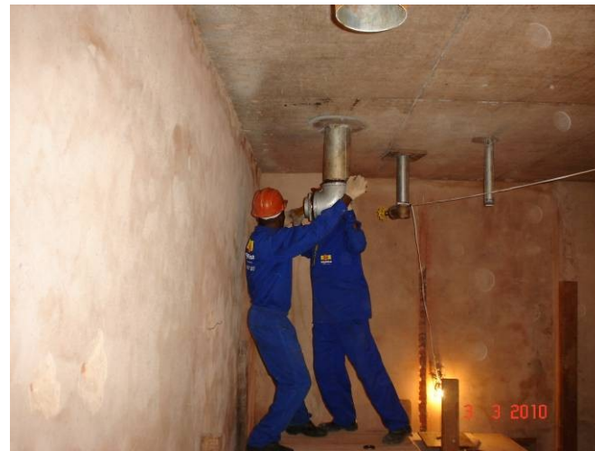
Detalhe da tubulação do barrilete no fundo do reservatório elevado.
