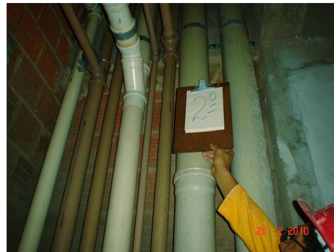
Detalhe da tubulação de águas pluviais e esgoto na prumada do shaft .
