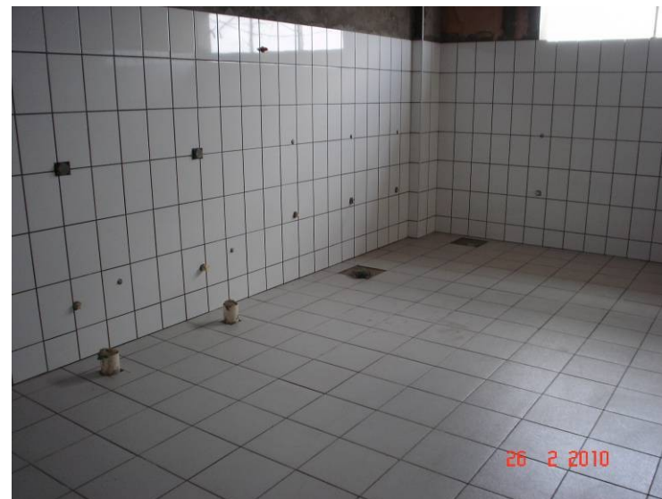
Detalhe da aplicação do revestimento cerâmico (piso e azulejo) dos banheiros coletivos.
