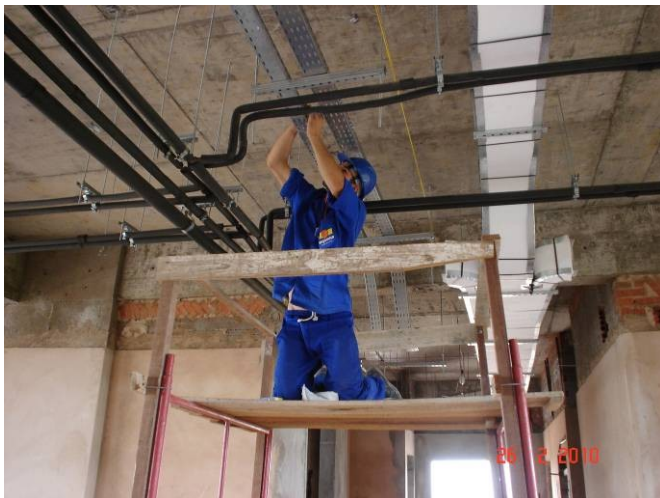
Detalhe da colocação de eletrocalha para instalações elétricas.
