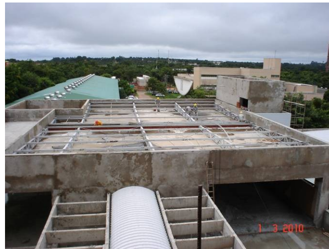
Detalhe da estrutura metálica para cobertura da junta C, parte A.
