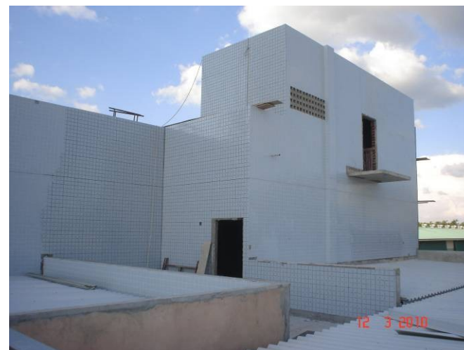
Detalhe do revestimento externo em pastilha cerâmica.
