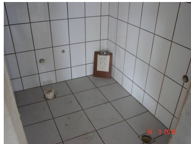
Detalhe do azulejo em banheiro individual do 5º pavimento.
