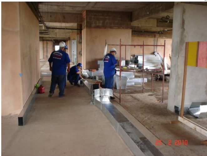
Detalhe da confecção dos dutos de exaustão/insuflamento (2º pavimento).
