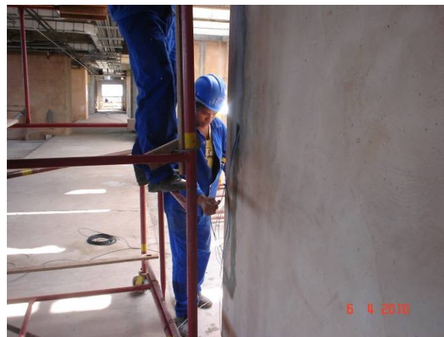
Detalhe de colocação de cabos flexíveis para tomadas e interruptores no 5º pavimento.
