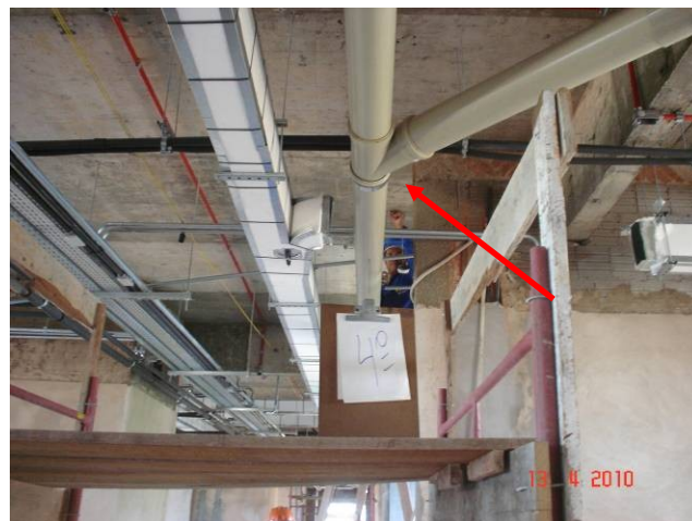
Detalhe da tubulação de águas pluviais do 4º pavimento.
