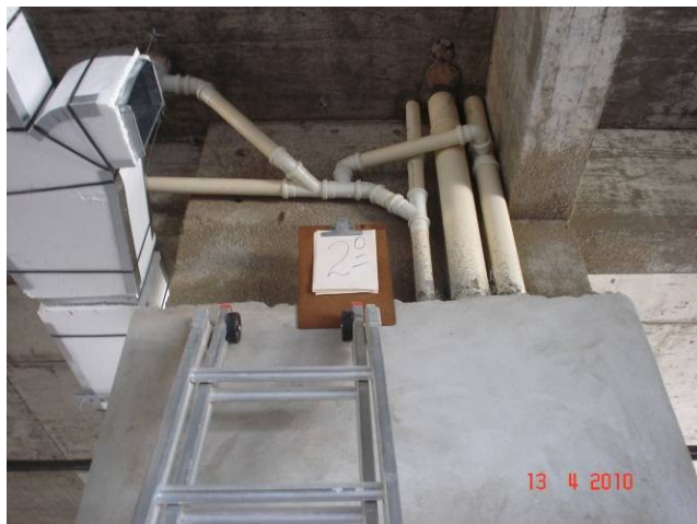
Detalhe da tubulação de ramal de esgoto e tubos de queda do 2º pavimento.
