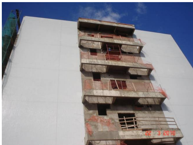
Detalhe do revestimento externo em pastilha cerâmica da fachada oeste.
