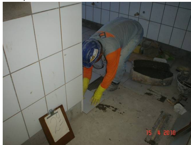
Detalhe da execução de piso cerâmico em banheiro coletivo do 2º pavimento.
