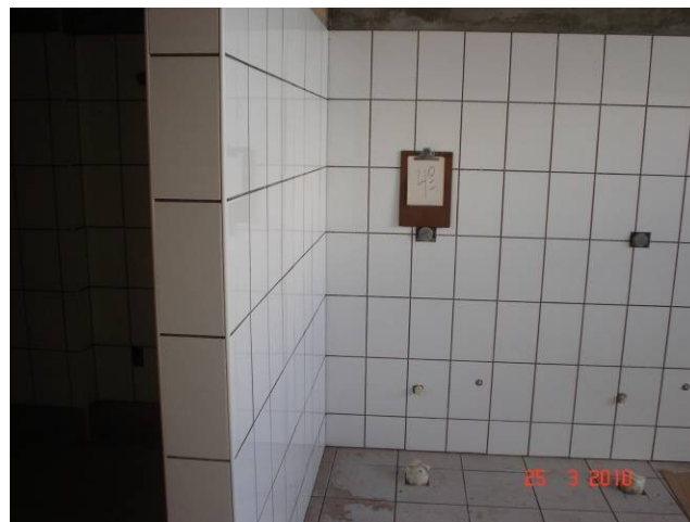
Detalhe dos pontos instalados de saída para válvulas de descarga em banheiros coletivos do 4º pavimento.
