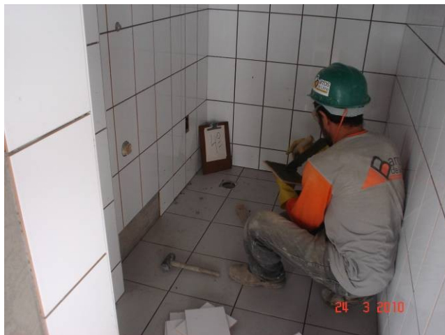
Detalhe da execução da regularização de contra-piso em banheiro individual do 3º pavimento.
