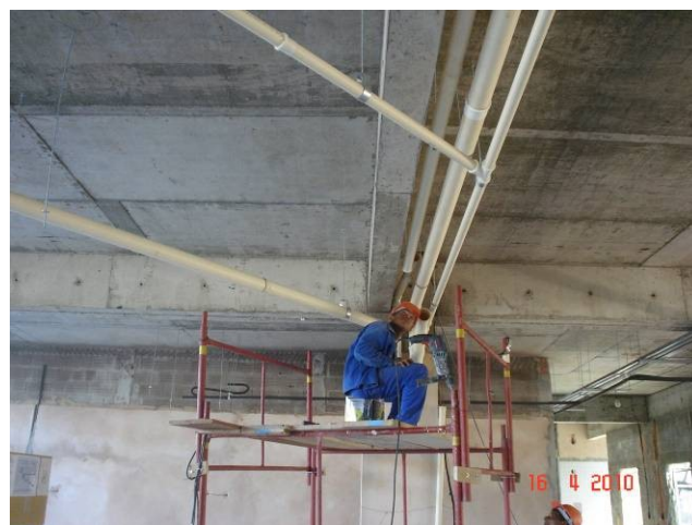
Detalhe da tubulação de águas pluviais e de esgoto no 2º pavimento.
