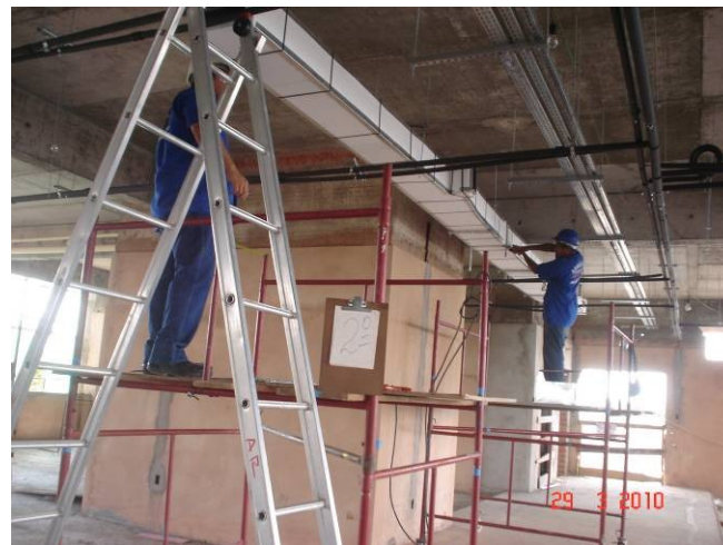
Detalhe da instalação de dutos de exaustão/insuflamento do 2º pavimento.
