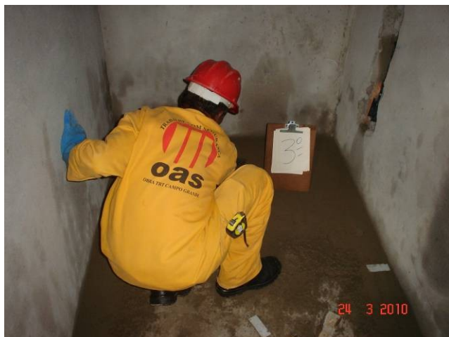
Detalhe da execução da regularização de contra-piso em banheiro individual do 3º pavimento.
