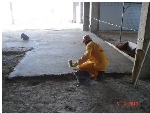
Detalhe da execução da regularização de contra-piso no hall de entrada no pavimento térreo.
