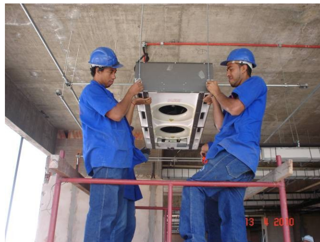
Detalhe da instalação da unidade evaporadora do 5º pavimento.
