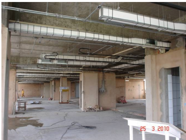
Detalhe dos dutos de exaustão/insuflamento do 2º pavimento.
