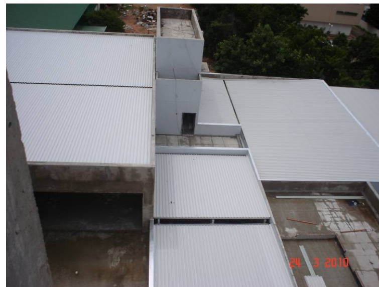
Detalhe de parte das coberturas das partes A e B.
