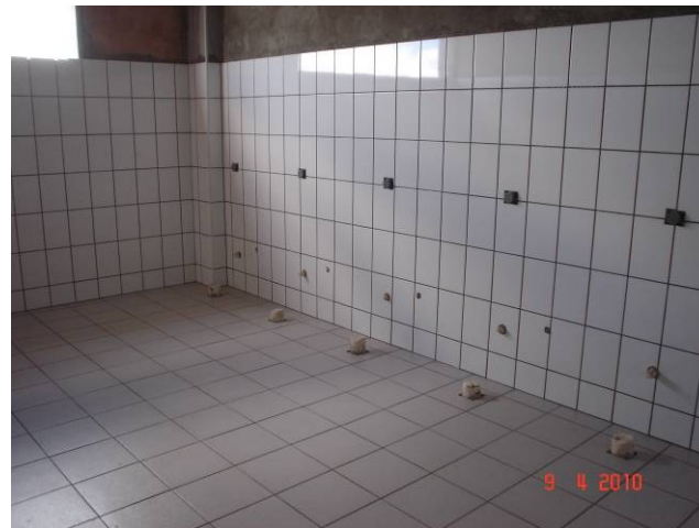
Detalhe do azulejo colocado em banheiro coletivo no 3º pavimento.
