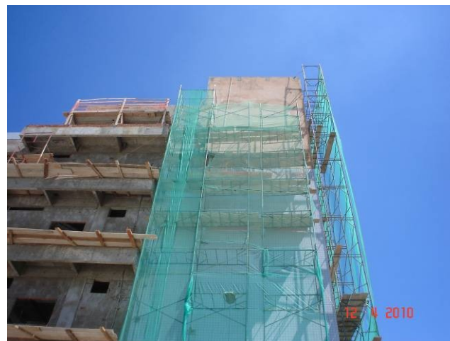
Detalhe da execução do revestimento externo em pastilha cerâmica da fachada leste.
