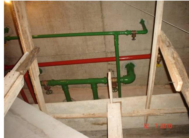
Detalhe da saída do barrilete para a tubulação de hidrantes (tubulação vermelha)
