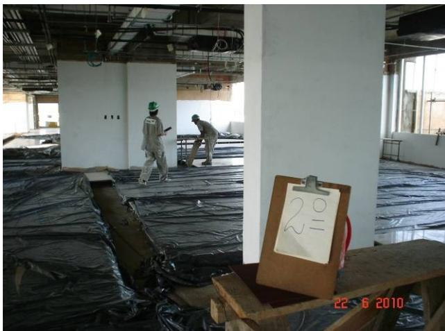
Aplicação de massa acrílica sobre paredes e pilares no 2º pavimento
