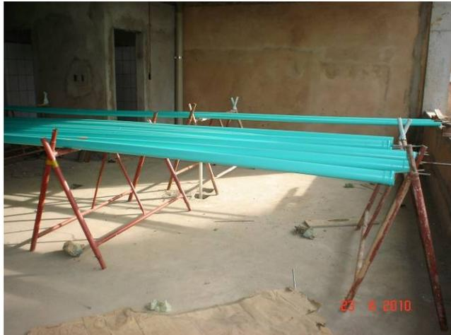
Pintura da tubulação para instalações de águas pluviais
