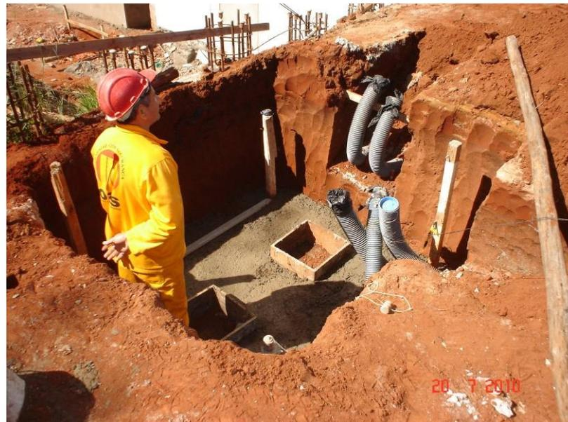
Detalhe da execução da caixa de passagem e tubulação da entrada de energia em média tensão (13,8kV)
