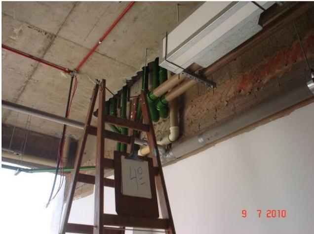
Detalhe da tubulação interna do barrilete, identificado com pintura, no 4º pavimento
