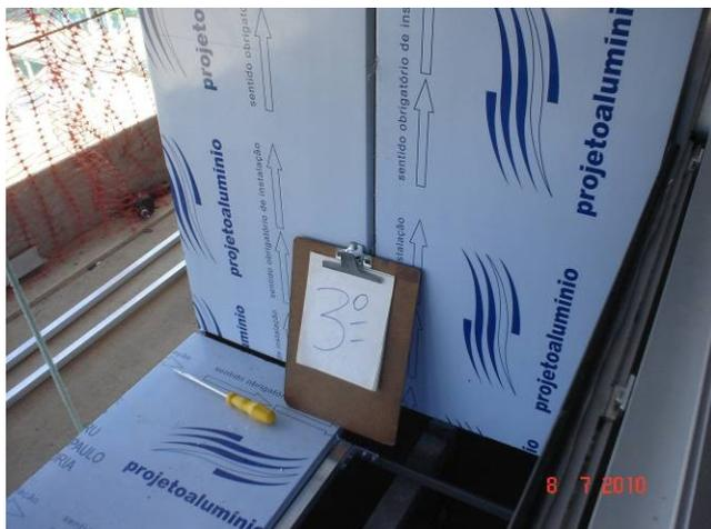
Detalhe do alumínio composto na fachada sul do 3º pavimento
