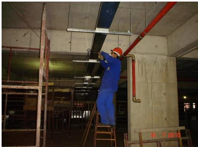
Detalhe da tubulação de alimentação de hidrantes no subsolo
