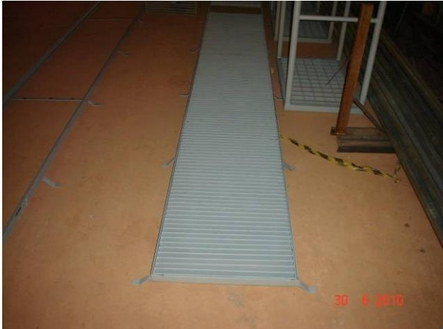
Detalhe da grelha de águas pluviais, depositada no canteiro
