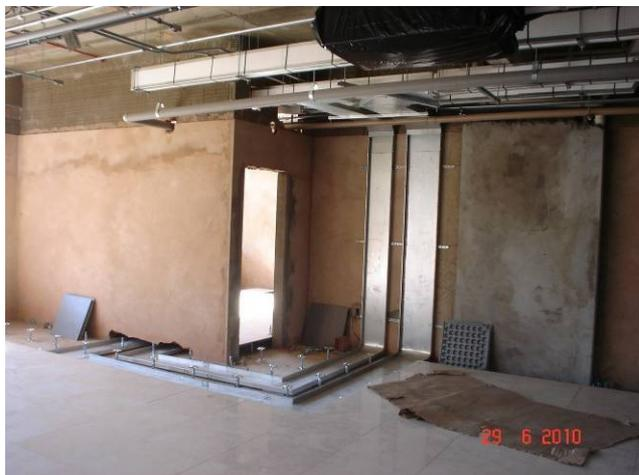
Detalhe da eletrocalha no teto, paredes e pisos
