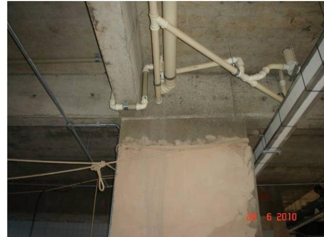
Detalhe de ramal de descarga e ramal de esgoto em banheiros do térreo
