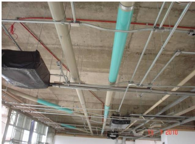
Tubulação de águas pluviais com pintura de identificação
