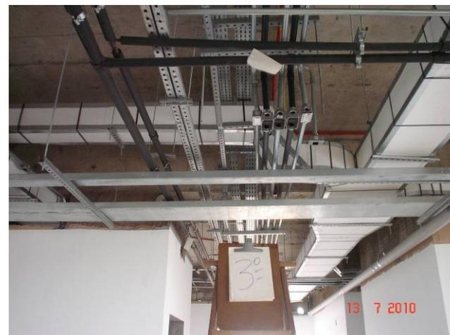
Detalhe das eletrocalhas e fiação elétrica no 3ª pavimento
