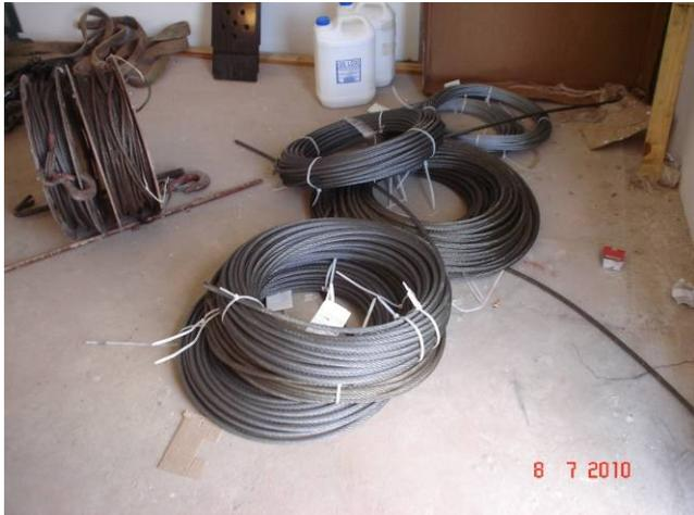
Detalhe dos cabos de aço para instalação dos elevadores
