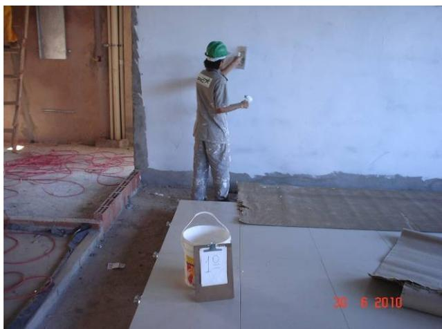
Aplicação de massa acrílica sobre paredes no 1º pavimento
