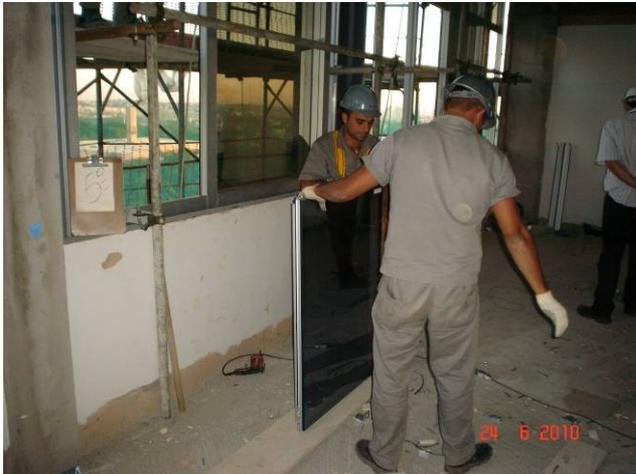
Detalhe da execução de esquadria em pele de vidro, sistema "structural glazing" no 5º pavimento
