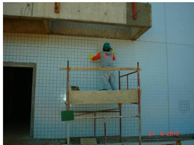
Rejunte de revestimento cerâmico externo na fachada oeste no térreo
