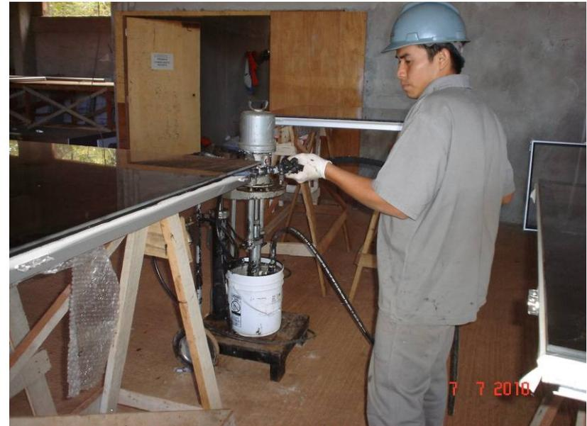
Detalhe da colagem do vidro no quadro em alumínio para composição das fachadas
