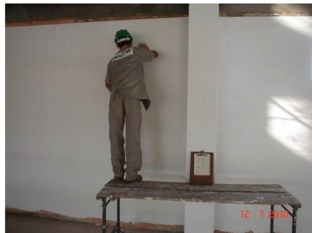
Aplicação de massa acrílica sobre paredes e pilares no 1º pavimento
