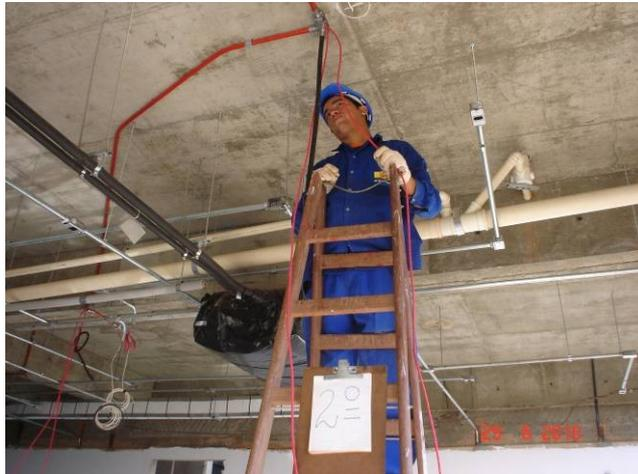
Detalhe da tubulação (vermelha) de detecção de fumaça no 2º pavimento
