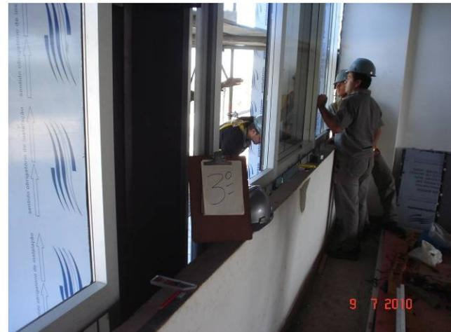
Detalhe da execução de esquadria em pele de vidro, sistema "structural glazing" no 3º pavimento
