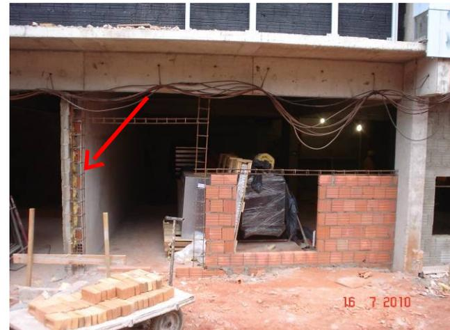
Vista externa do revestimento das paredes (lã de rocha) da subestação no subsolo
