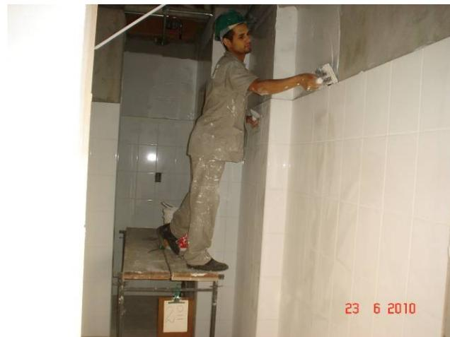
Aplicação de massa acrílica sobre paredes acima do revestimento em azulejo nos banheiros do 2º pavimento
