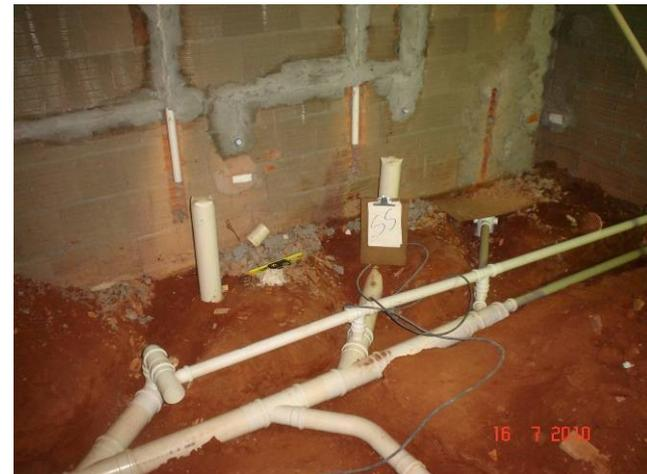
Detalhe de ramal de descarga e ramal de esgoto em banheiros do subsolo
