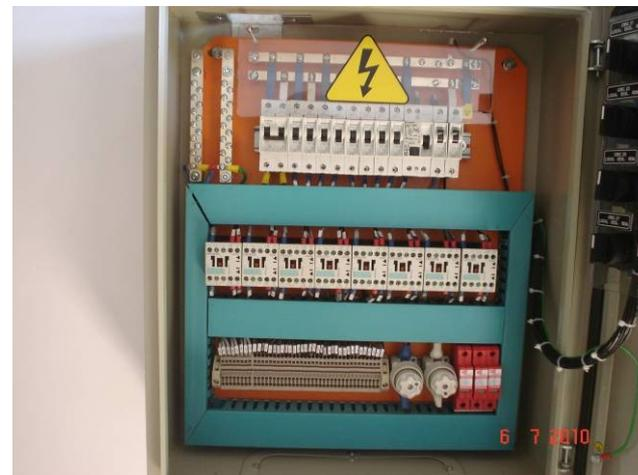
Detalhe do quadro de luz dos pavimentos
