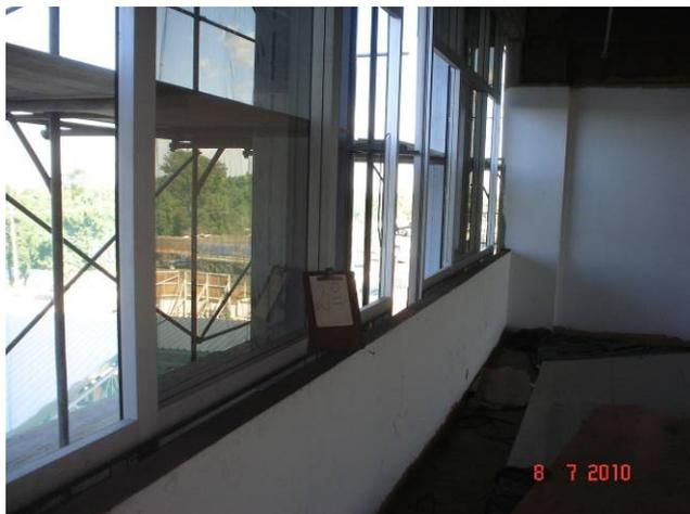
Detalhe da execução de esquadria em pele de vidro, sistema "structural glazing" no 2º pavimento
