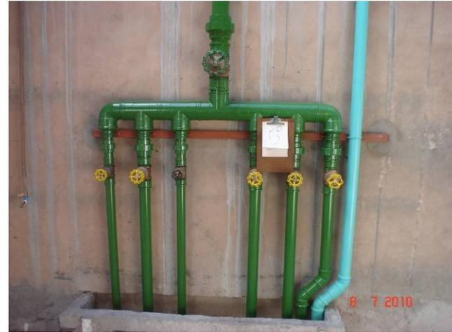
Detalhe da tubulação interna do barrilete identificado com pintura (verde – água potável; azul – águas pluviais)
