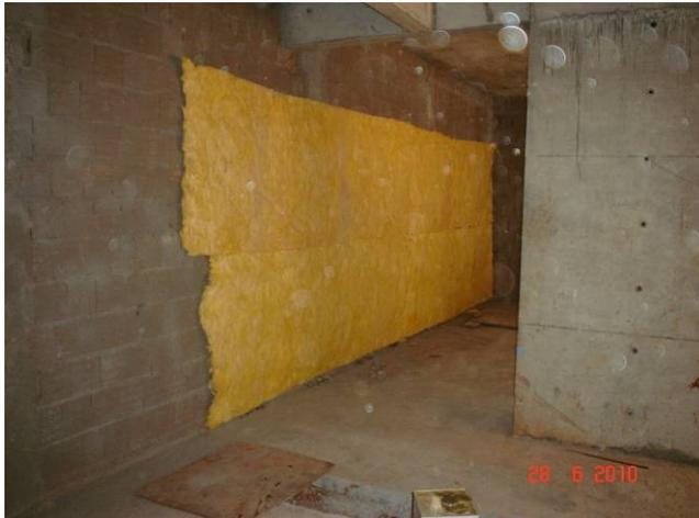
Revestimento das paredes (lã de rocha) da subestação no subsolo
