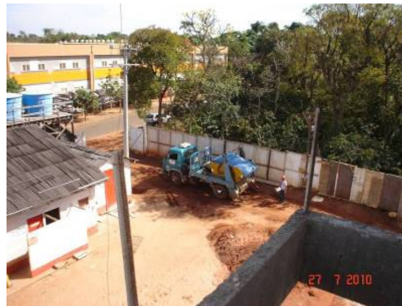
Detalhe da retirada de entulho do canteiro da obra.
