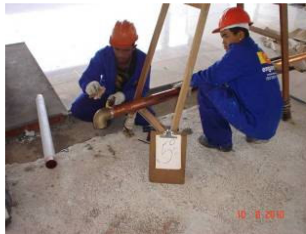
Detalhe da execução de tubulação para hidrante no 5º pavimento.
