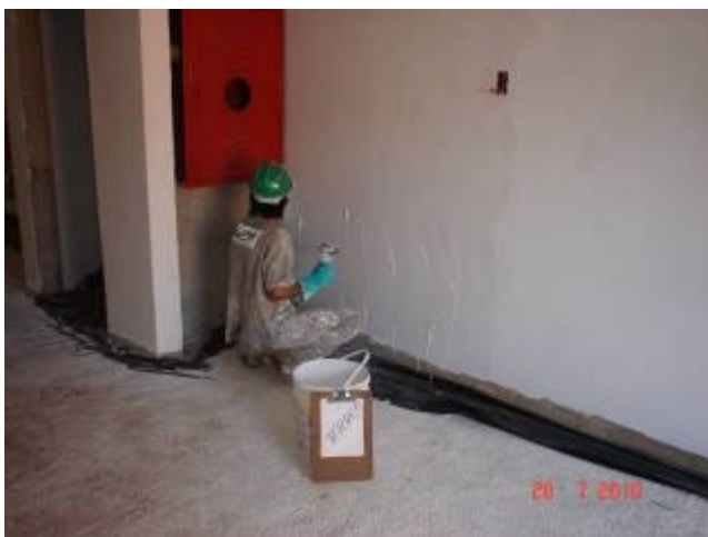
Detalhe da aplicação de massa acrílica sobre parede do térreo.
