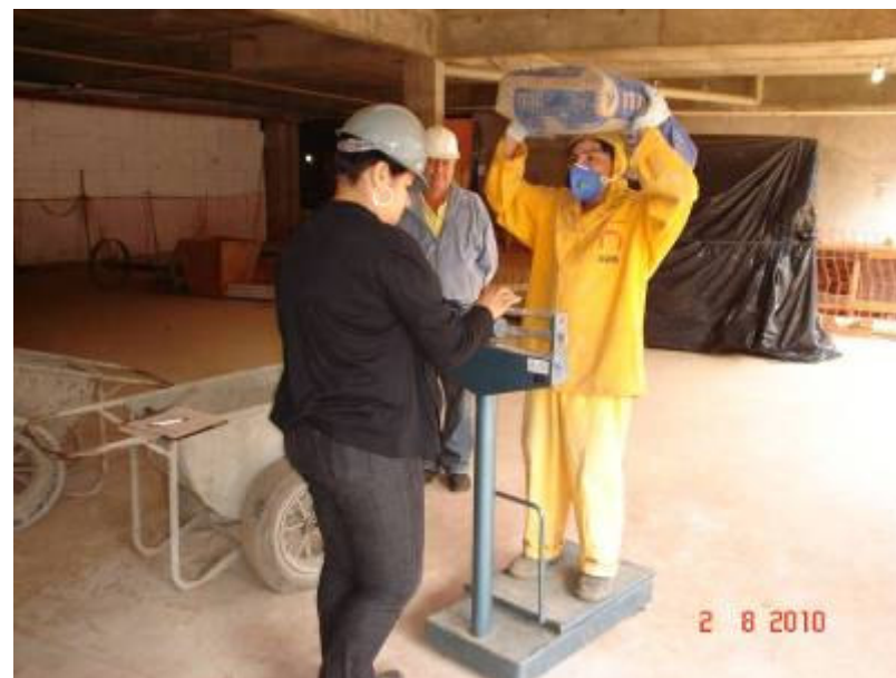
Controle de qualidade do cimento descarregado na obra.
