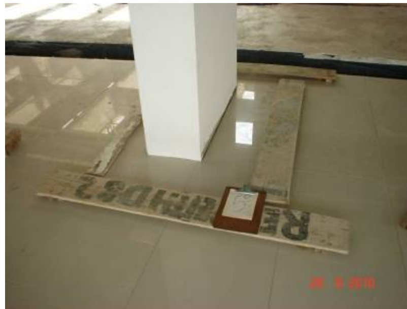
Acabamento do piso elevado junto aos pilares.
