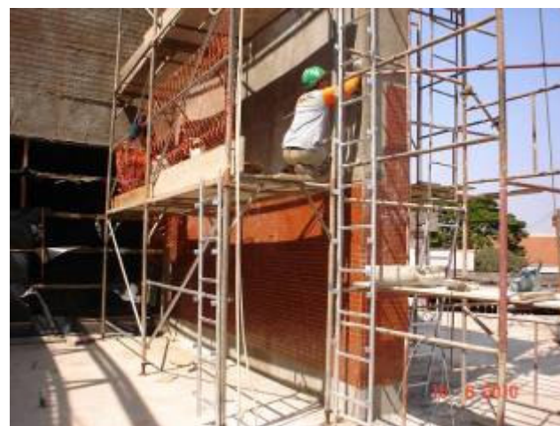
Detalhe do assentamento da pastilha cerâmica externa “vermelho madri”.
