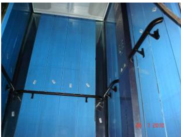
Vista interna da cabine de um dos elevadores.
