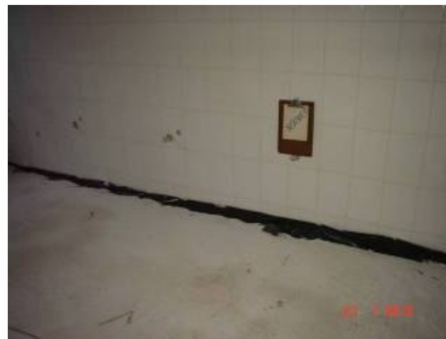
Detalhe do revestimento de parede em banheiro coletivo do térreo.
