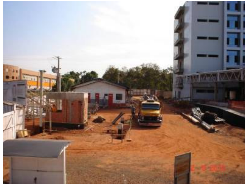
Detalhe da descarga de andaime fachadeiro para utilização na colocação da vidraçaria.
