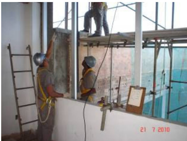
Detalhe da fixação de perfis de alumínio para colocação de esquadria em pele de vidro no 2º pavimento, fachada sul.
