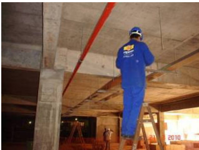
Colocação de eletrocalha para instalações no subsolo.
