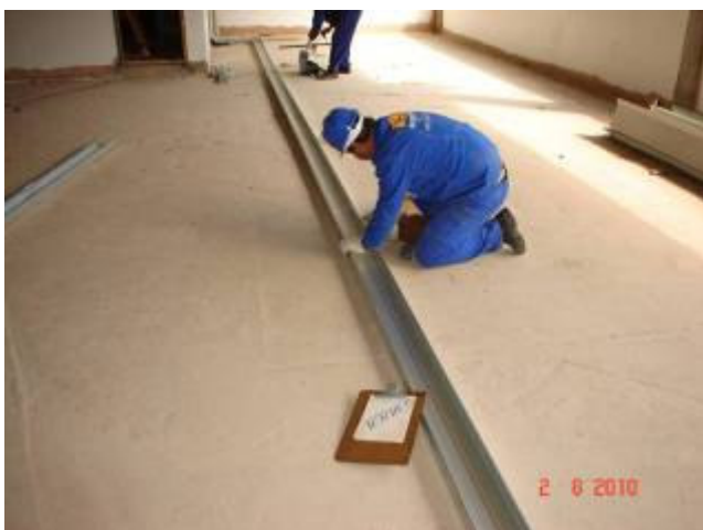
Colocação de eletrocalha de piso para passagem de fiação no pavimento térreo.
