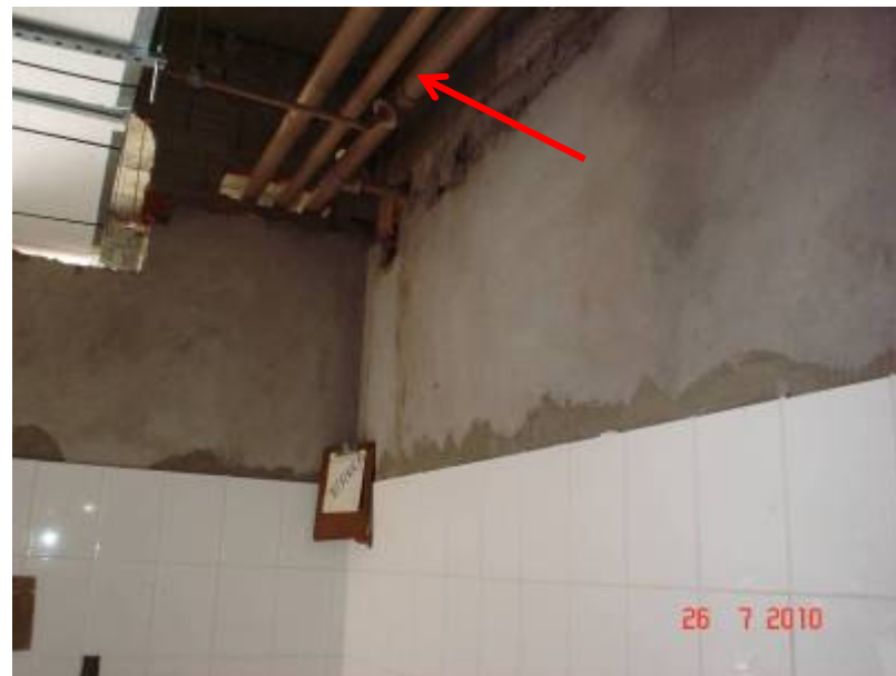
Detalhe da tubulação de água fria no entreforro de banheiro coletivo do térreo.
