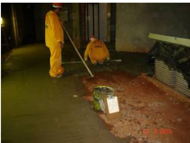
Detalhe da execução de piso cimentado rústico no subsolo.
