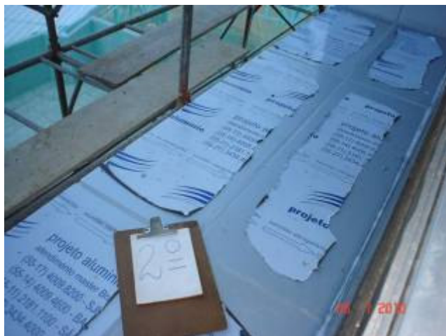
Detalhe do revestimento externo em alumínio composto no 2º pavimento – fachada sul.
