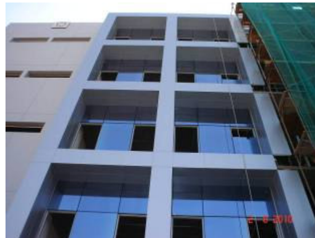
Vista de parte da esquadria em pele de vidro instalada na fachada sul.
