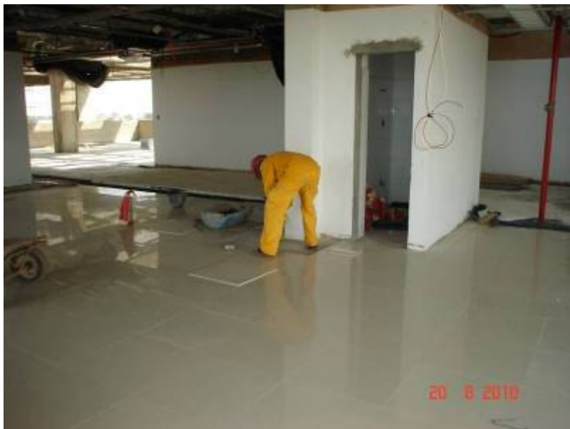
Acabamento do piso elevado junto às paredes internas.
