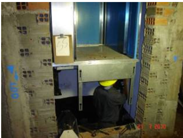
Instalação de cabine de um dos 5 elevadores do prédio.
