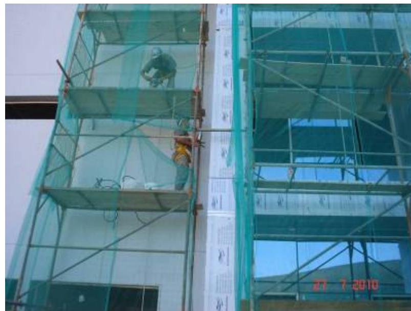
Detalhe da aplicação de silicone estrutural nas juntas do revestimento em alumínio composto da fachada sul.
