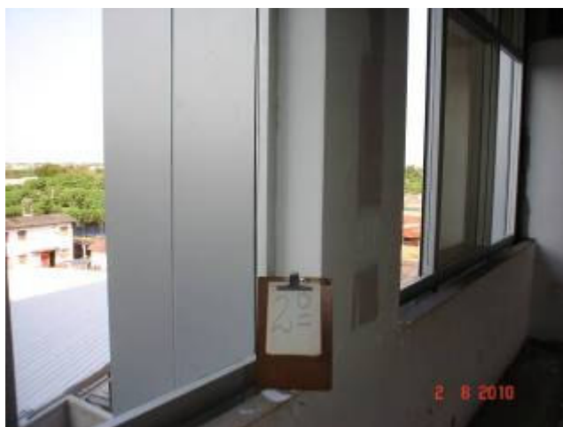
Detalhe da esquadria em pele de vidro instalada em parte da fachada sul no 2º pavimento.
