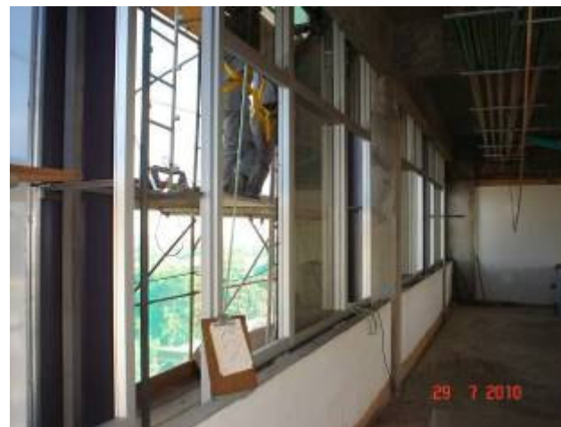
Detalhe da esquadria em pele de vidro instalada em parte da fachada sul no 5º pavimento.
