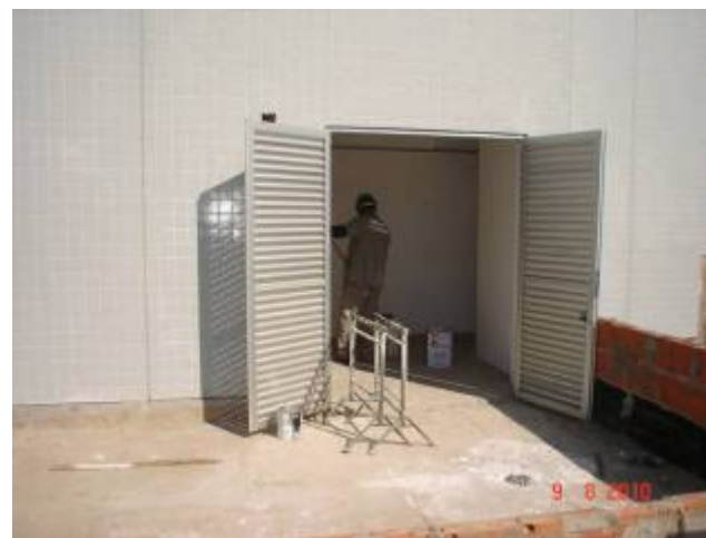
Detalhe da pintura interna da subestação da cobertura.
