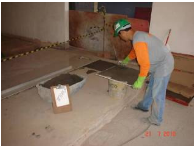
Assentamento de porcelanato sobre contrapiso desempenado no pavimento térreo.
