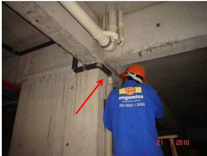
Ligação da tubulação de dreno de climatização na tubulação de águas pluviais.
