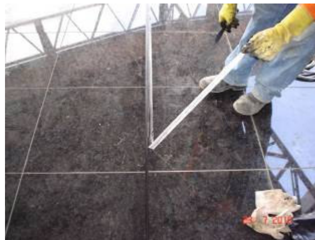
Detalhe do tratamento de juntas do piso em granito "blue star" com silicone estrutural.
