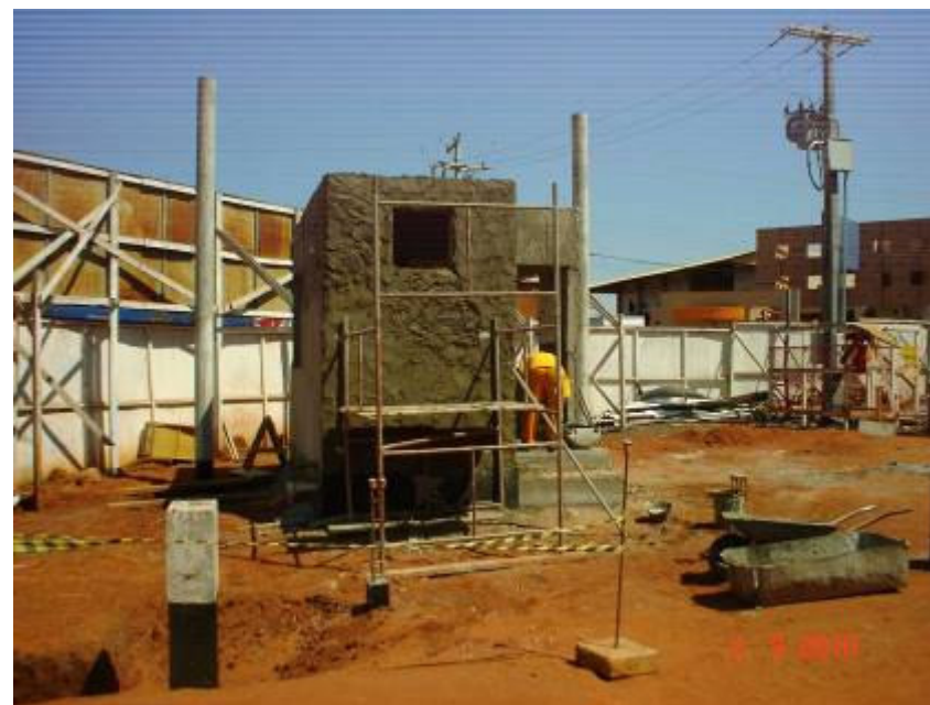
Revestimento externo em reboco da guarita de entrada
