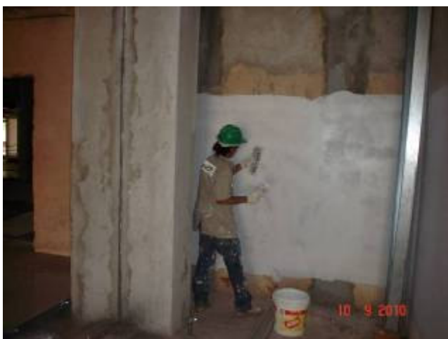
Detalhe do emassamento com massa acrílica em paredes internas
