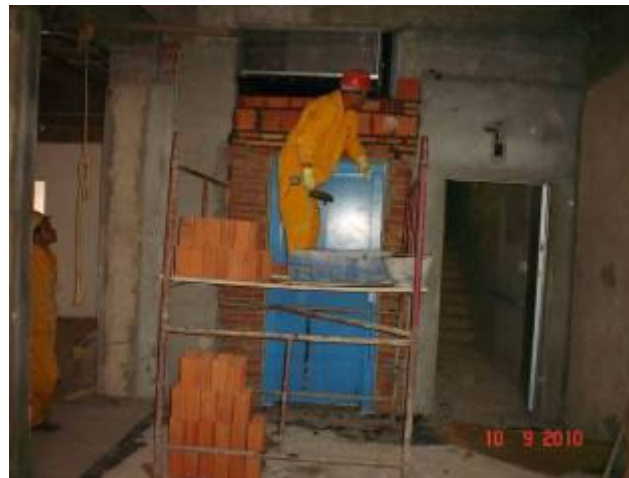
Fechamento em alvenaria no entorno dos batentes dos elevadores
