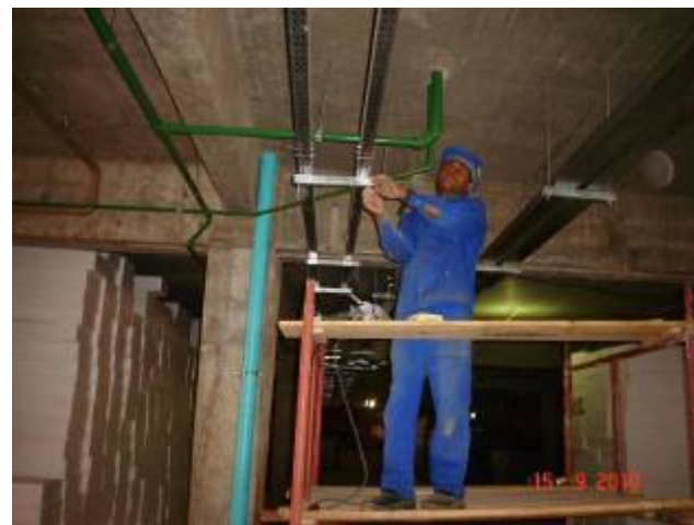
Detalhe da colocação de eletrocalha no subsolo
