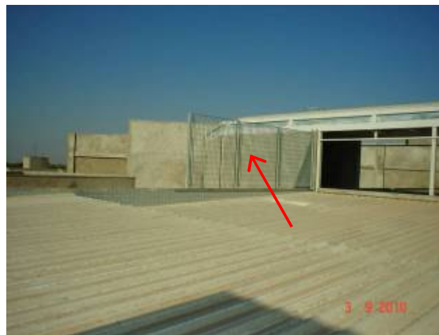
Detalhe da colocação de gradil em aço carbono em parte externa
