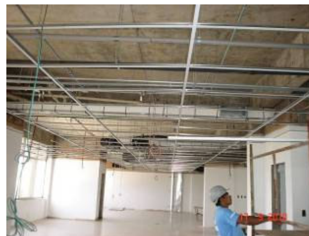
Detalhe da colocação da estrutura do forro interno no 4º pavimento
