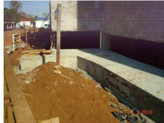
Vista entre as estacas de contenção e o prédio já concretado
