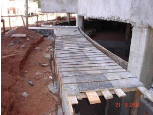
Vista da colocação de formas para concretagem do fechamento entre o prédio e as estacas de contenção
