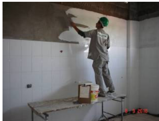
Vista do emassamento com massa acrílica em paredes internas de banheiros, acima dos azulejos (2º pavimento)
