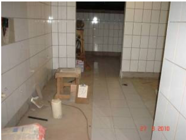
Detalhe do revestimento cerâmico (azulejo) no subsolo
