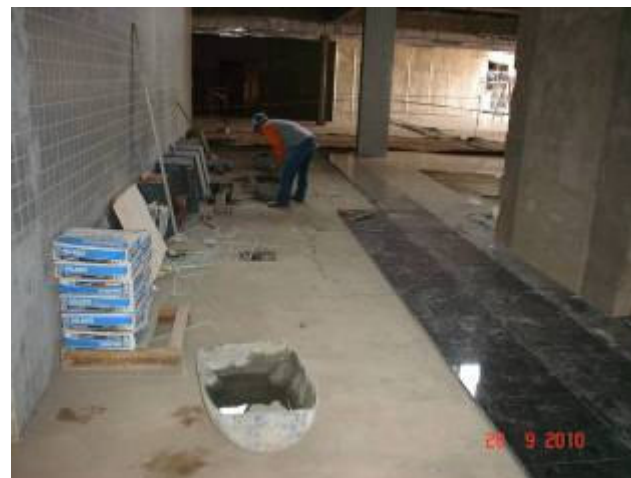
Detalhe do assentamento de piso em granito "blue star" na recepção do térreo
