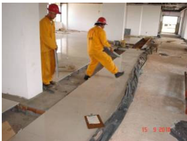
Detalhe do acabamento do piso porcelanato junto aos corredores internos
