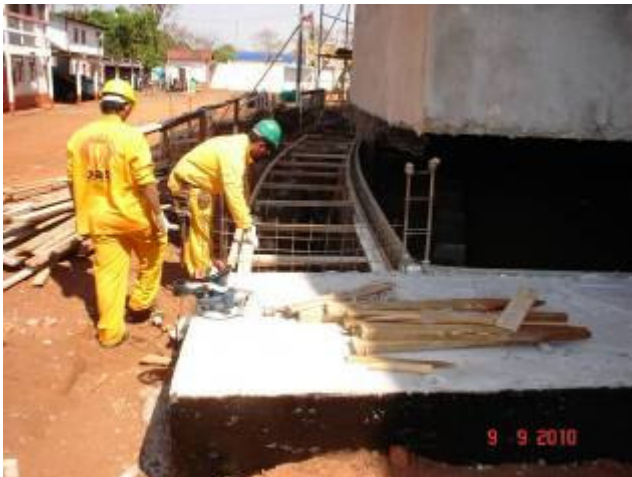
Vista da colocação de formas para a concretagem entre as estacas de contenção e o prédio
