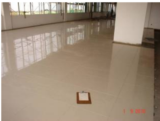
Vista do porcelanato sobre piso elevado no 3º pavimento.
