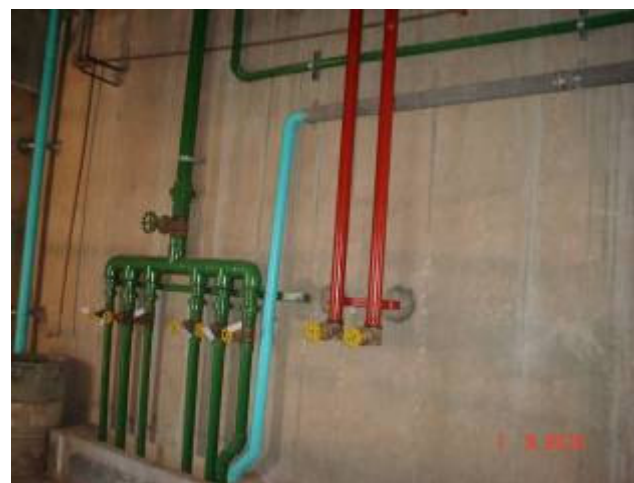
Detalhe da pintura das tubulações da saída do barrilete
