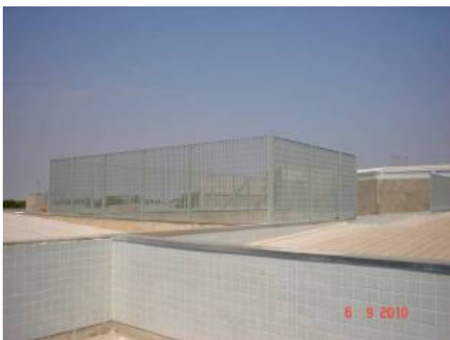
Vista detalhada do gradil em aço carbono instalada
