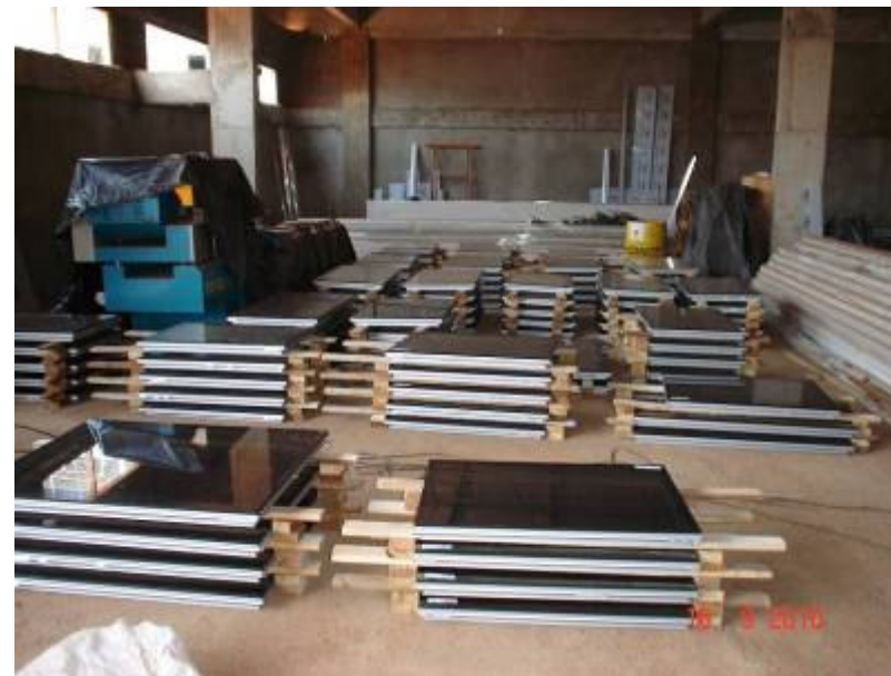
Vista dos vidros das fachadas colados e estocados para aplicação
