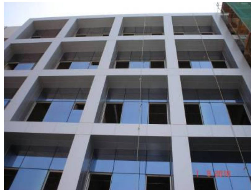
Vista da esquadria em vidro, tipo structural glazing (pele de vidro) na fachada sul
