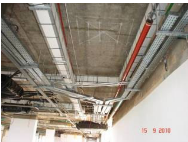
Detalhe da marcação na laje do ponto de saída dos dutos de exaustão e insuflamento
