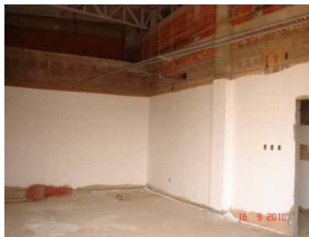
Vista do emassamento das paredes internas (térreo)
