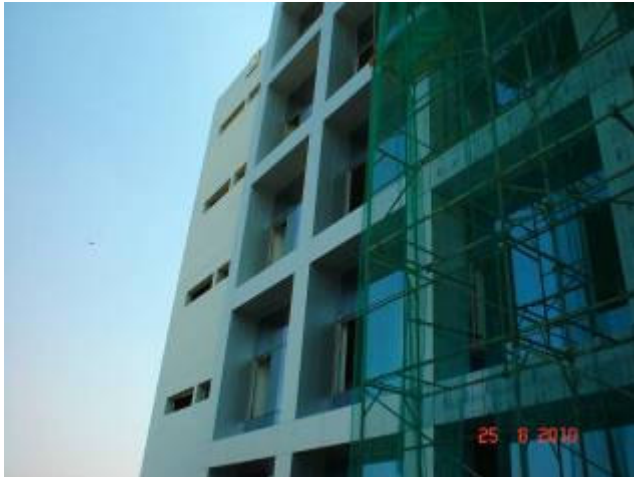
Detalhe do revestimento em alumínio composto externo (fachada sul)
