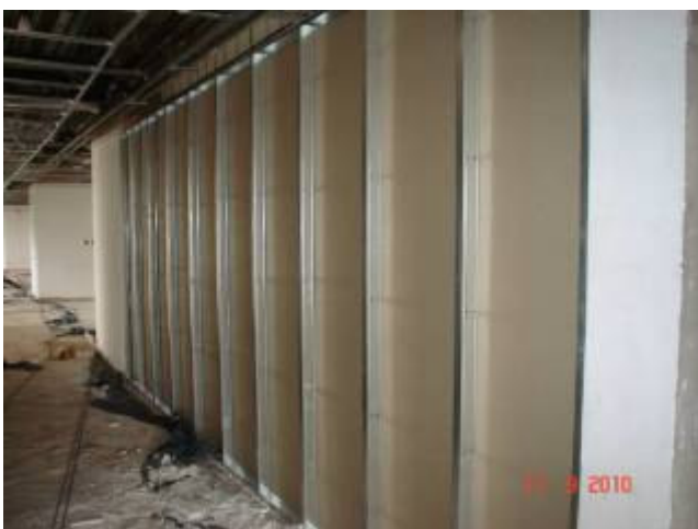
Vista das paredes em drywall (gesso acartonado) no 4º pavimento
