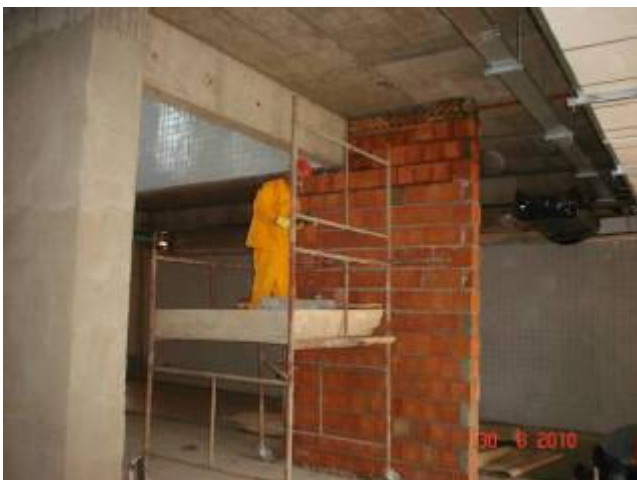
Vista da execução de pilar falso na recepção do térreo
