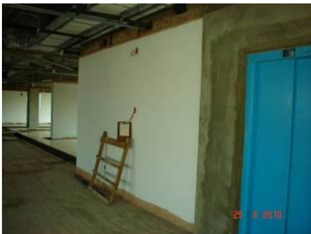
Vista do emassamento com massa acrílica em paredes internas (1º pavimento)
