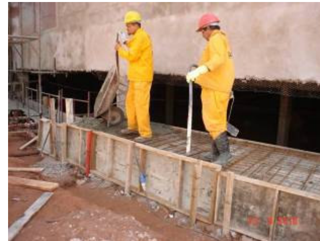
Concretagem entre as estacas de contenção e o prédio
