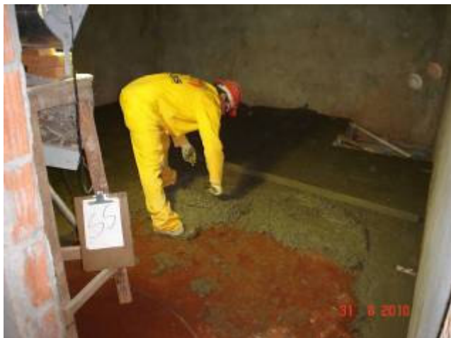
Detalhe da execução de contra piso no subsolo
