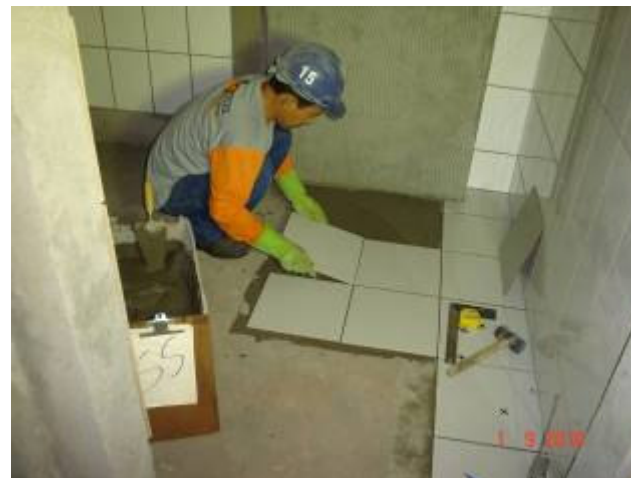
Execução de piso cerâmico no subsolo
