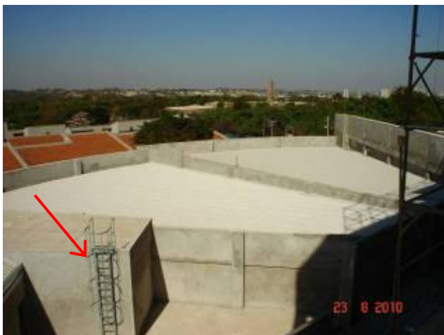
Detalhe da colocação de escada tipo marinheiro em área externa
