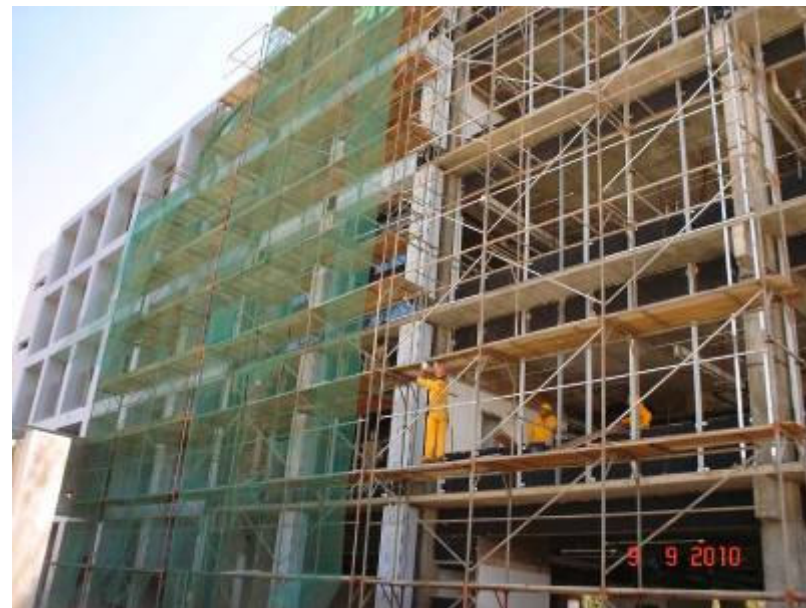
Vista do andaime fachadeiro para colocação de alumínio composto e vidros da fachada sul
