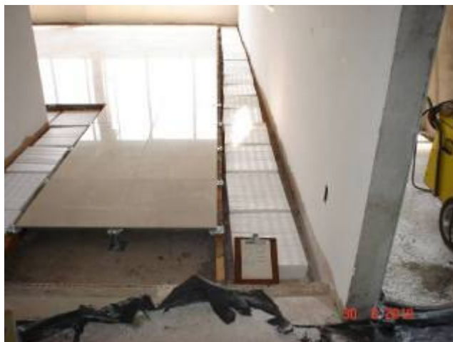
Detalhe do acabamento do piso porcelanato junto às paredes e pilares no 2º pavimento
