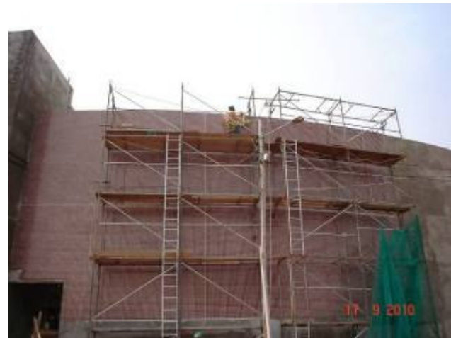
Detalhe do revestimento externo em pastilha cerâmica na cor vermelho madri (fachada sul)
