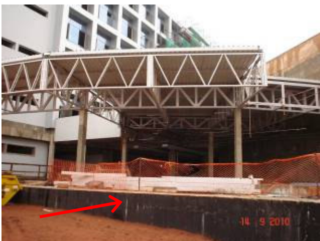
Imprimação das laterais do fechamento da contenção entre o prédio e as estacas
