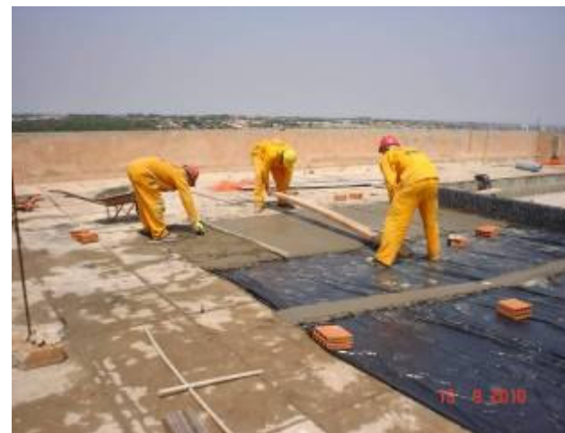
Proteção mecânica sobre manta de impermeabilização da cobertura junto à casa de máquina do ar condicionado
