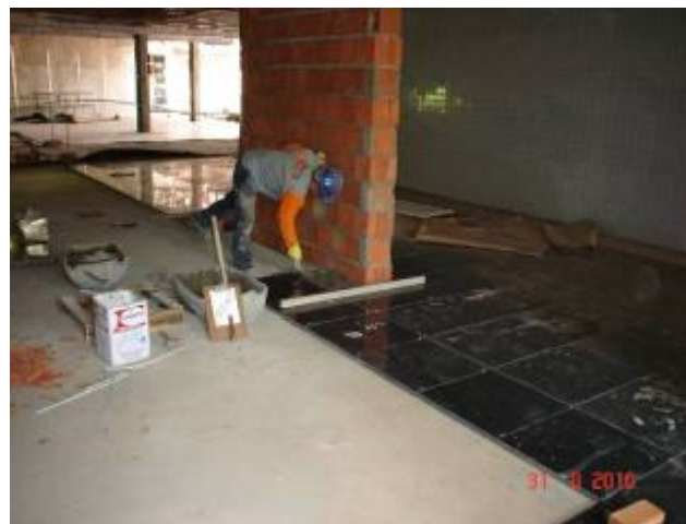
Vista da execução de pilar falso na recepção do térreo
