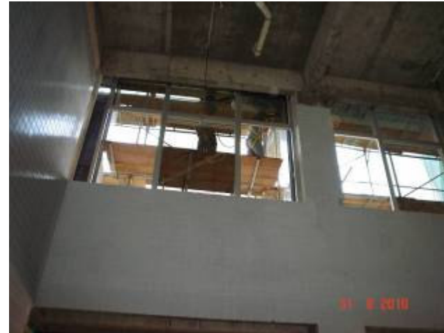
Detalhe do revestimento interno em pastilha cerâmica no hall da recepção
