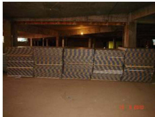
Detalhe de estoque, no canteiro de obras, de gesso acartonado para paredes Dry-wall
