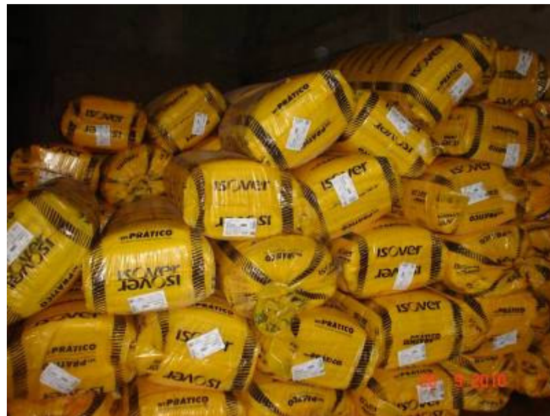
Material estocado na obra para isolamento acústico do sistema Dry Wall .
