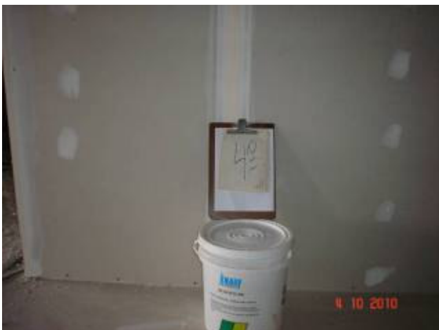
Detalhe da colocação de fita telada entre as placas de gesso acartonado.
