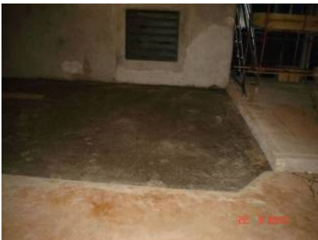
Detalhe do piso em concreto polido no subsolo.
