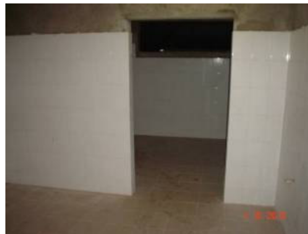
Detalhe de piso cerâmico em banheiros e vestiário do subsolo.
