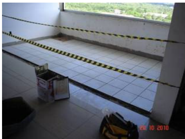
Instalação de piso cerâmico na área externa no 5º pavimento (sacada).
