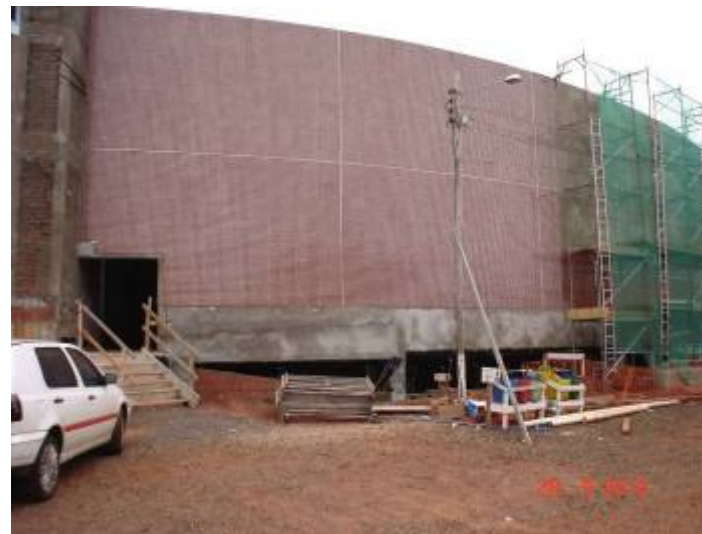
Detalhe da pastilha cerâmica instalada na parte externa.
