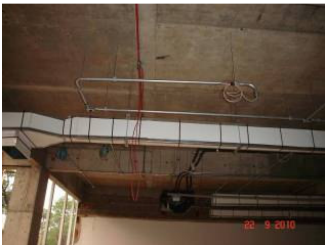
Vista das instalações elétricas no entre-forro do 1º pavimento.
