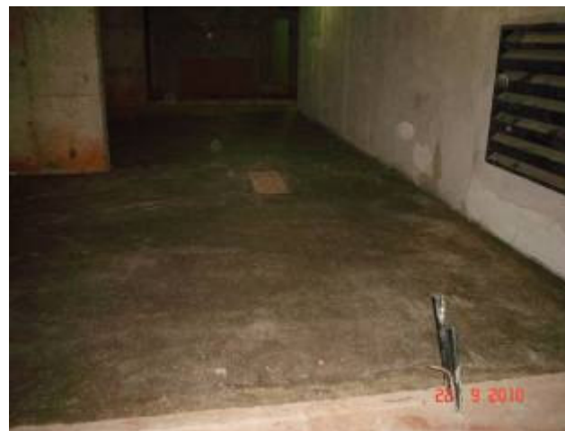
Detalhe do piso em concreto polido no subsolo.
