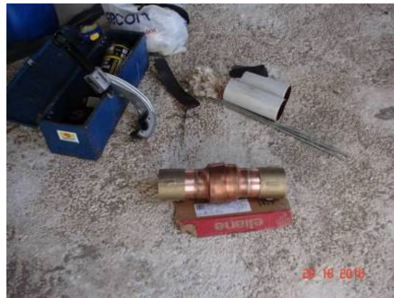
Detalhe da conexão da tubulação de hidrante, para transposição nas juntas de dilatação.
