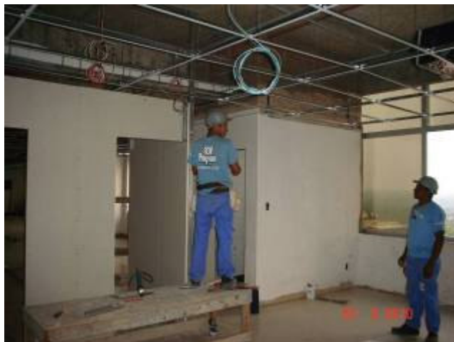
Vista da instalação da estrutura do forro removível em fibra mineral.
