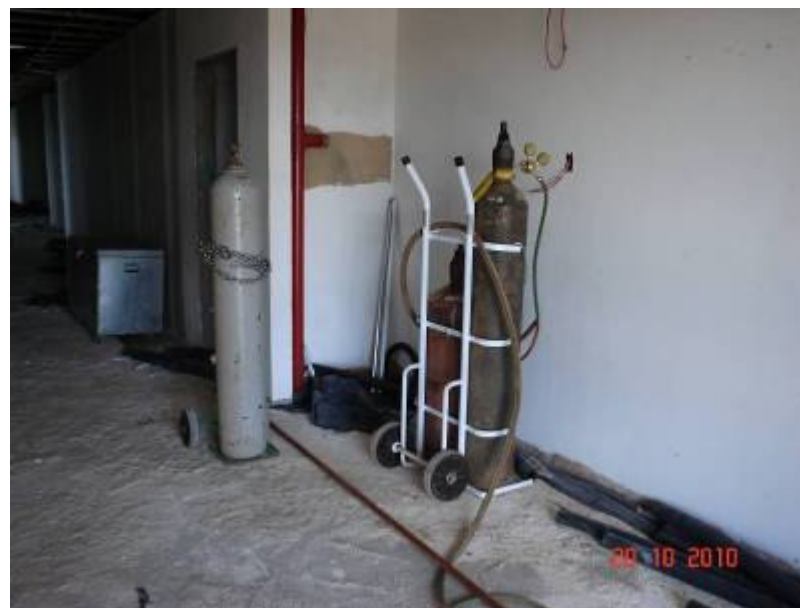
Equipamento para solda de tubulação frigorígena de ar condicionado.
