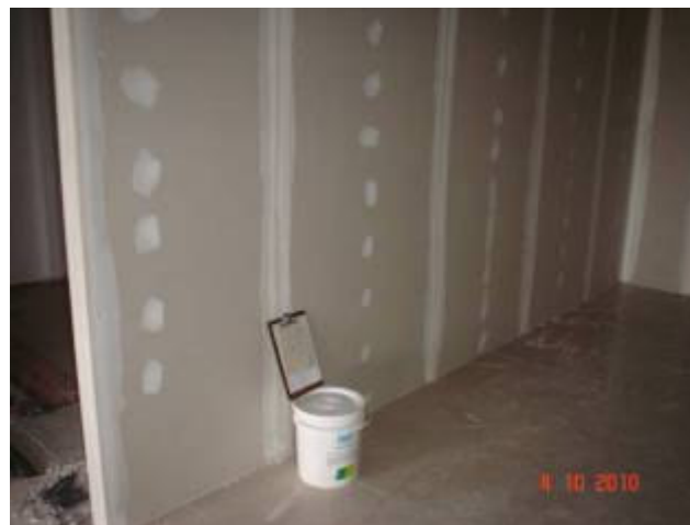
Detalhe das divisórias em Dry Wall no 4º pavimento.
