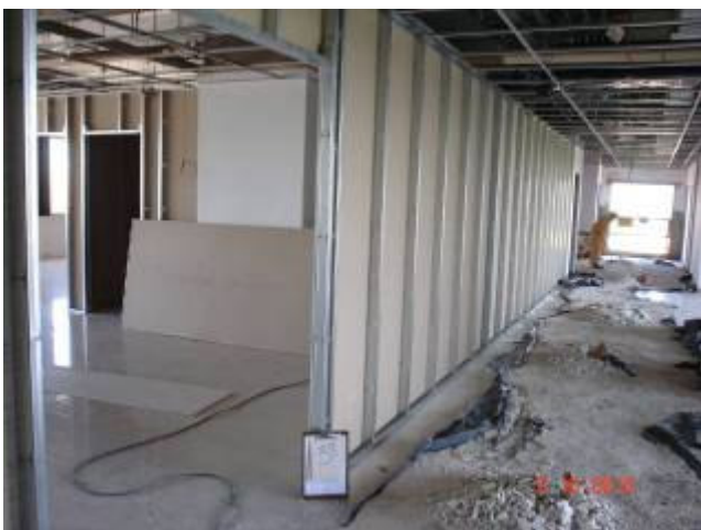
Detalhe das divisórias em Dry Wall no 3º pavimento.
