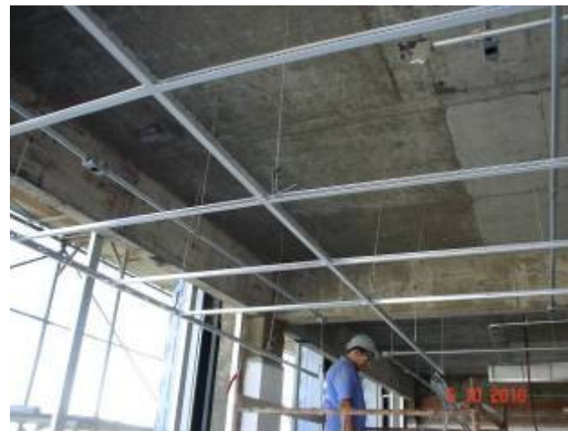
Detalhe dos tirantes para fixação da estrutura do forro removível em fibra mineral no 2º pavimento.
