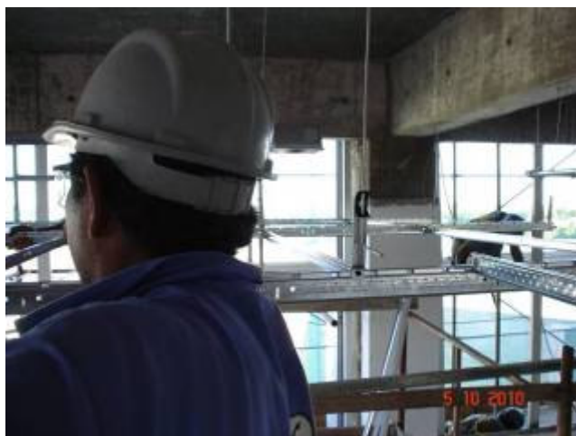
Detalhe dos tirantes e estrutura de fixação do forro removível em fibra mineral no 2º pavimento.
