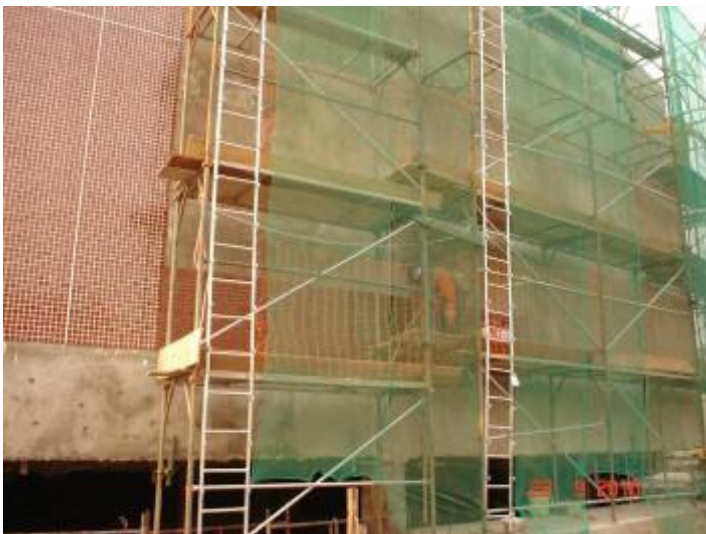
Detalhe da pastilha cerâmica instalada na parte externa.
