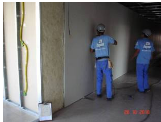
Detalhe da divisória em "Dry Wall" no 2º pavimento.
