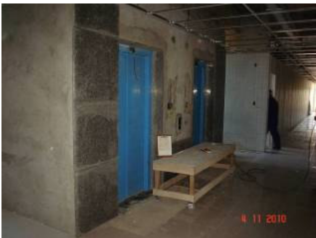
Detalhe do assentamento em granito na parte frontal dos elevadores panorâmicos do 2º pavimento.
