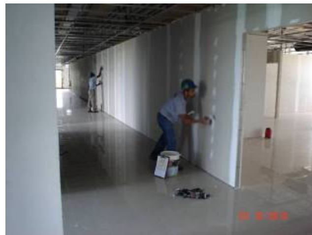
Aplicação de massa acrílica sobre divisória de "Dry Wall" no 3º pavimento.
