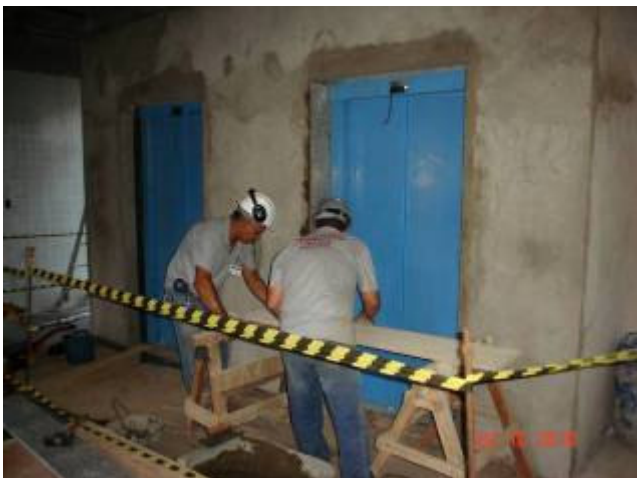
Colocação de granito na parte frontal dos elevadores panorâmicos do térreo.
