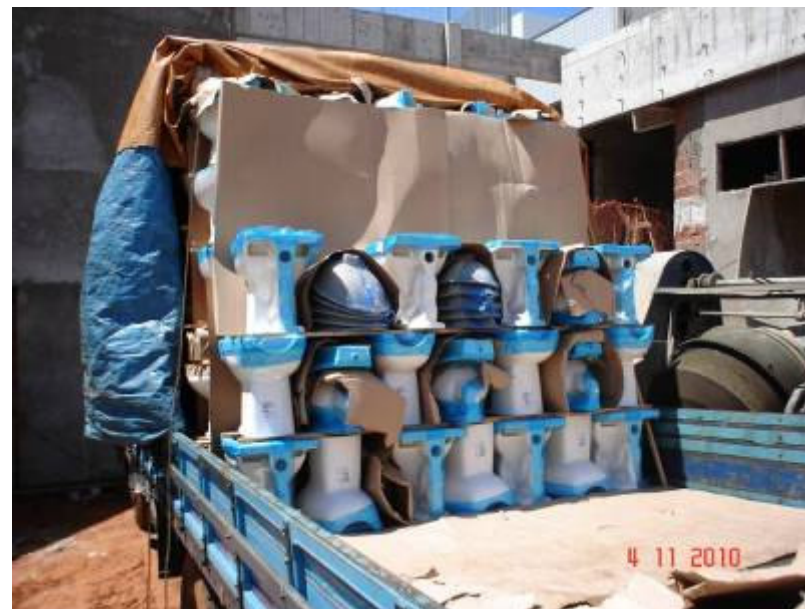
Detalhe da descarga de louças sanitárias no canteiro de obras.
