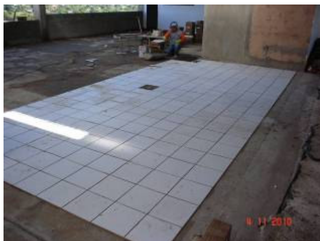
Detalhe da colocação de piso cerâmico nas áreas externas do 5º pavimento.
