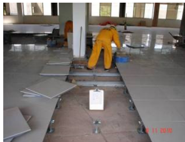
Detalhe da execução de piso elevado no 1º pavimento.
