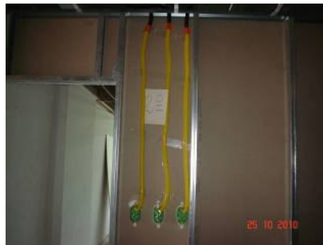
Instalação de eletroduto e caixas para interruptores nas paredes de "Dry Wall" no 2º pavimento.
