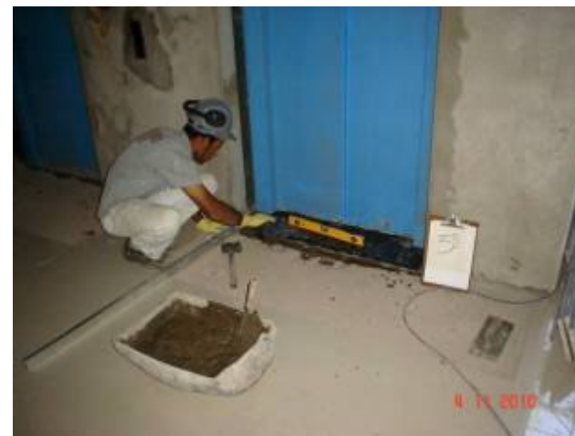
Detalhe da colocação de soleira nas portas dos elevadores panorâmicos no 3º pavimento.
