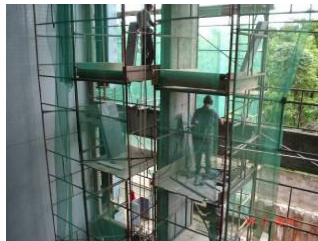
Revestimento em granito no pilar do hall dos elevadores panorâmicos (sistema de encaixe).
