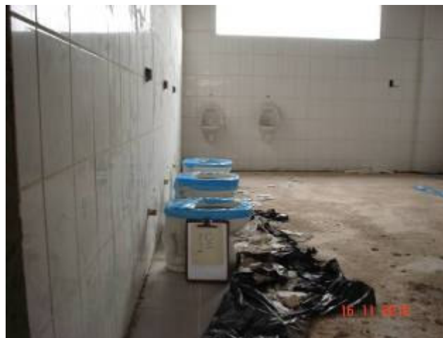
Detalhe da instalação de bacias sanitárias e mictórios em banheiros coletivos do 1º pavimento.
