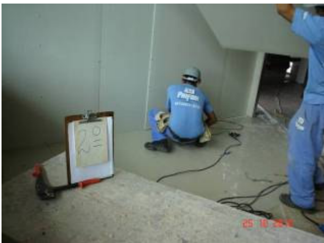
Instalação de divisória "Dry Wall" no 2º pavimento.
