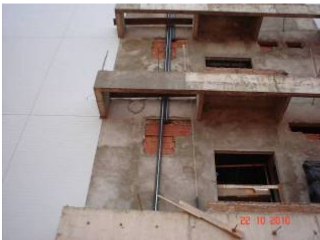
Instalação de tubulação frigorígena de ar condicionado dos andares para as máquinas na cobertura, pelos shafts.
