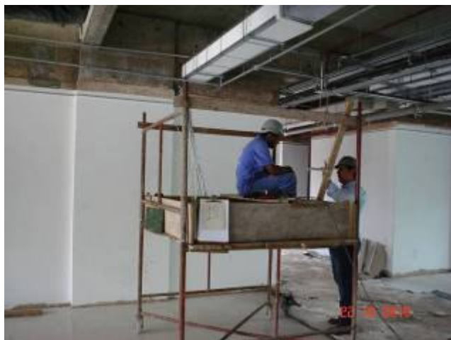
Instalação de tirantes para colocação de estrutura de forro no 1º pavimento.
