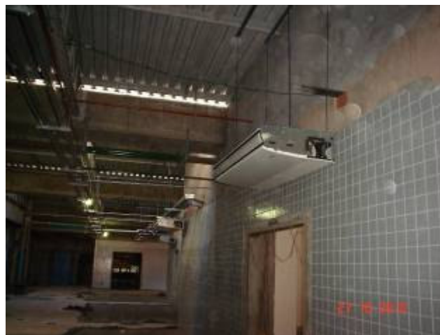
Instalação de unidades evaporadoras no lobby de entrada.
