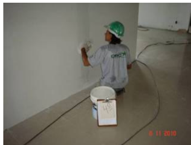
Detalhe da aplicação de massa acrílica sobre divisória de "Dry Wall" no 4º pavimento.
