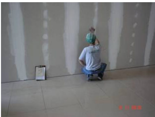
Aplicação de massa acrílica sobre divisória de "Dry Wall" no 3º pavimento (juntas).
