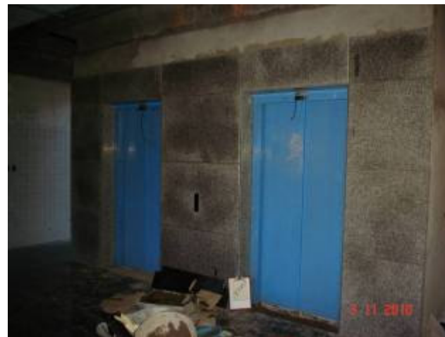
Detalhe do revestimento em granito na parte frontal dos elevadores panorâmicos do térreo.
