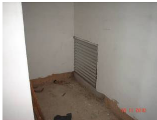
Detalhe da instalação de veneziana em alumínio, nos dutos internos de ar, nas escadas à prova de fumaça.
