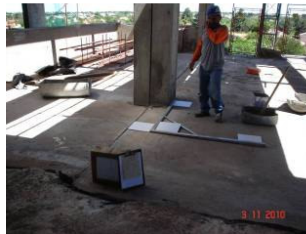
Detalhe da colocação de piso cerâmico nas áreas externas do 5º pavimento.
