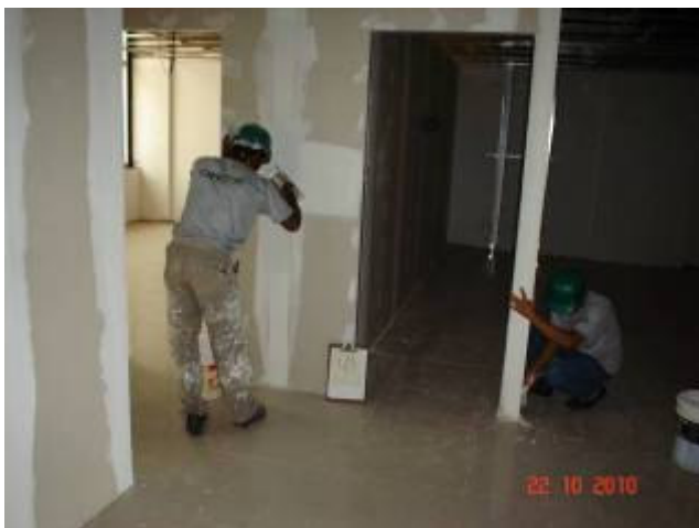
Aplicação de massa acrílica sobre parede de gesso acartonado no 4º pavimento.
