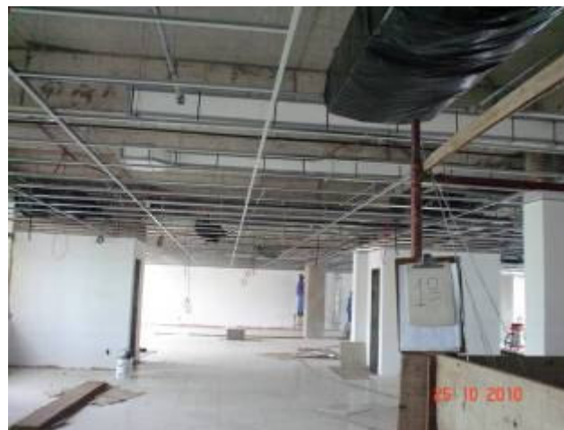
Instalação de estrutura para fixação de forro no 1º pavimento.
