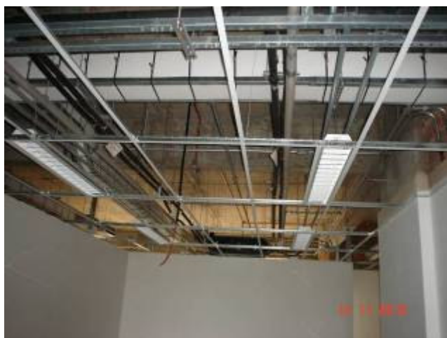
Detalhe da instalação de estrutura para fixação de forro, inclusive com recorte para luminárias.
