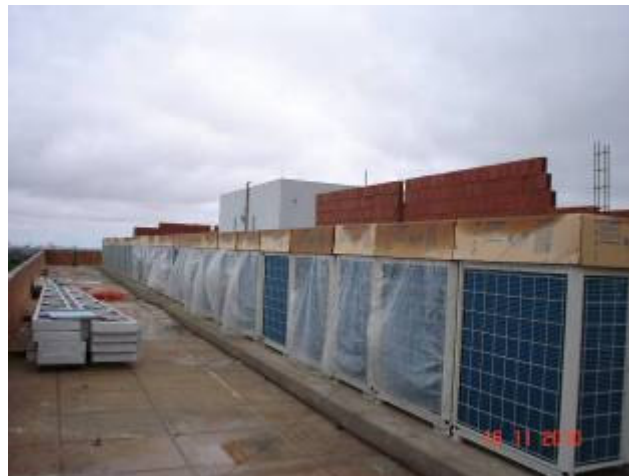
Instalação das unidades condensadoras do ar condicionado na laje da cobertura.
