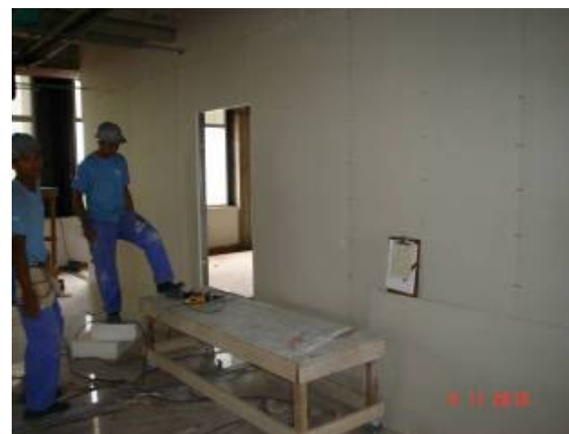
Detalhe da instalação de divisórias em "Dry Wall" no 5º pavimento.
