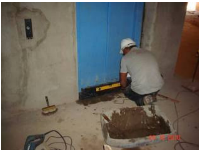
Detalhe da aplicação de soleira nas portas dos elevadores.
