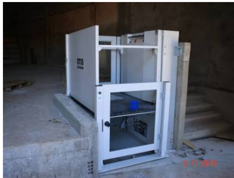
Detalhe da instalação da plataforma elevatória para Portador de Necessidades Especiais (PNE) no plenário grande.
