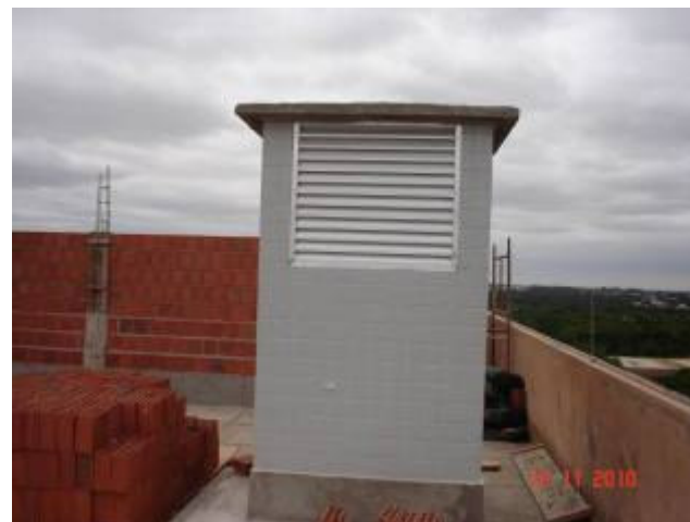
Detalhe de veneziana em alumínio, no duto de ar da cobertura.
