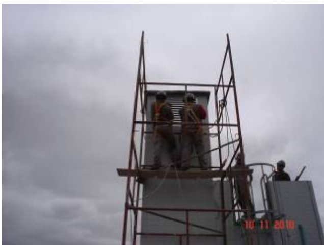
Detalhe da colocação de veneziana em alumínio, no duto de ar na cobertura.
