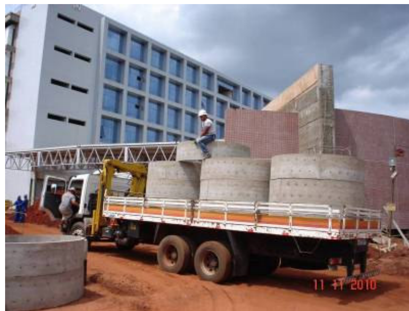
Detalhe dos tubos para infiltração de águas pluviais no solo.
