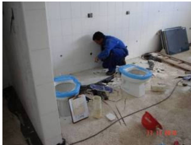
Detalhe da instalação de bacias sanitárias em banheiros coletivos do 2º pavimento.
