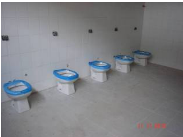
Detalhe da instalação de bacias sanitárias em banheiros coletivos.
