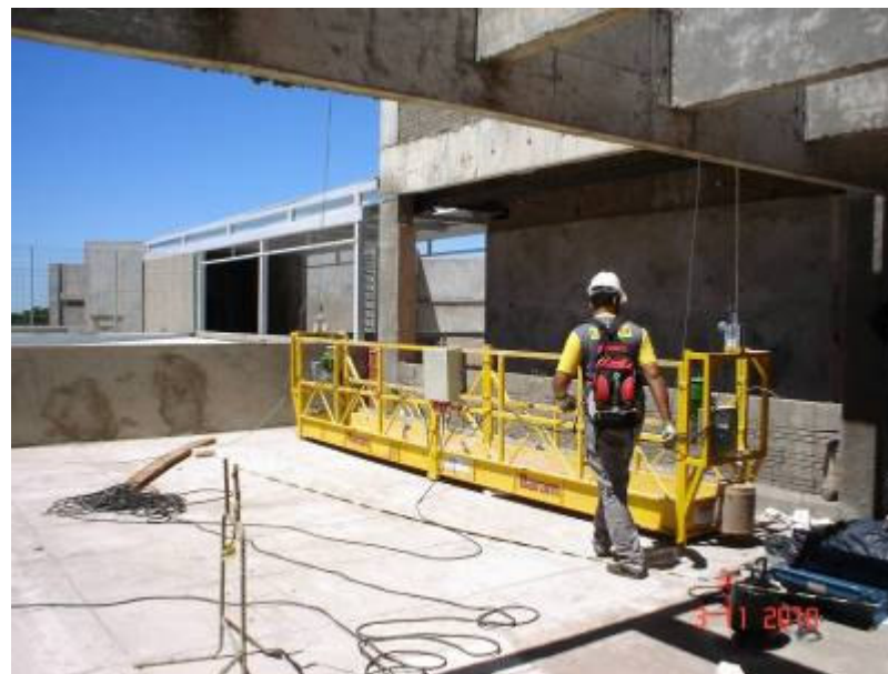
Detalhe de instalação de balancim na fachada leste para instalação de vidro.
