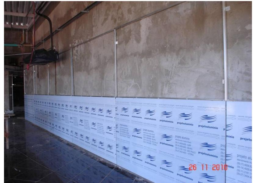
Detalhe do revestimento interno de parede em alumínio composto (ACM) no térreo.
