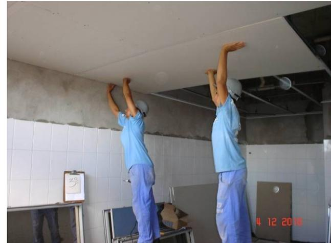
Detalhe da instalação do forro de gesso acartonado no 3º pavimento.
