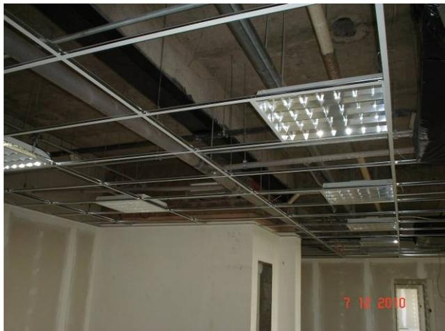
Suporte para fixação de luminárias no teto do 5º pavimento
