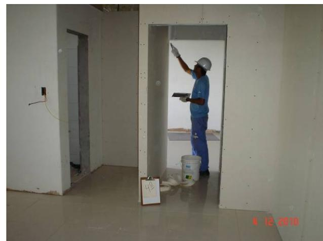
Aplicação de fita de fixação das placas de dry wall, para posterior aplicação de massa acrílica .
