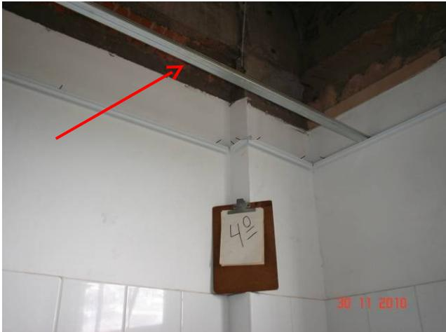
Detalhe da estrutura para suporte do forro de gesso acartonado no 4º pavimento.
