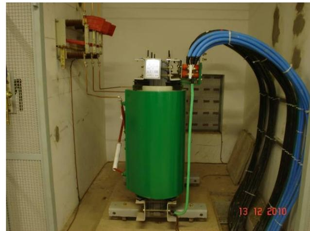
Detalhe da interligação dos vergalhões de cobre e dos cabos de 240mm do transformador da subestação do subsolo.
