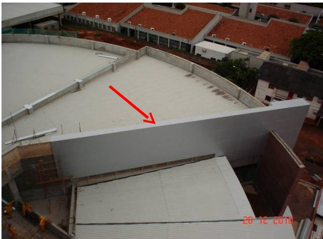
Revestimento externo, em alumínio composto (ACM), do pórtico da fachada
