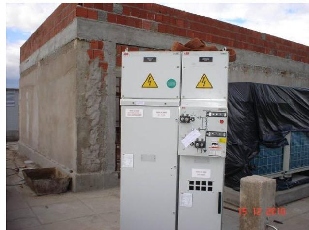
Cubículo (K01 e K02) – entrada dos cabos e do transformador.
