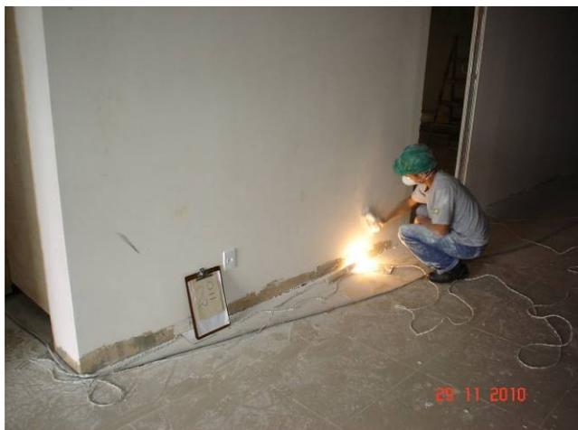
Lixamento de paredes com massa acrílica no 2º pavimento.
