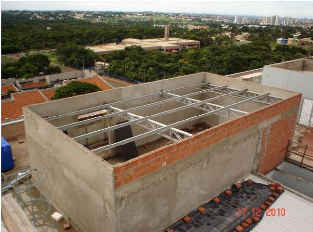
Vista da estrutura de cobertura de uma das casas de máquinas do ar condicionado na laje de cobertura.
