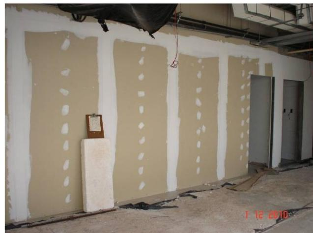
Detalhe da instalação de divisórias em "Dry Wall" no 5º pavimento.
