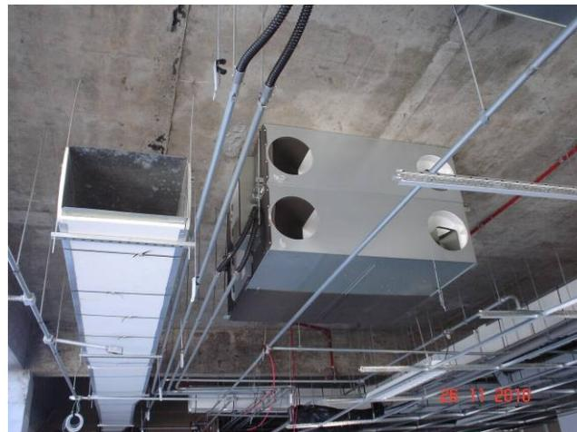
Detalhe da tubulação de exaustão e insuflamento instalada e do equipamento trocador de calor (Lossnay) no 1º pavimento.
