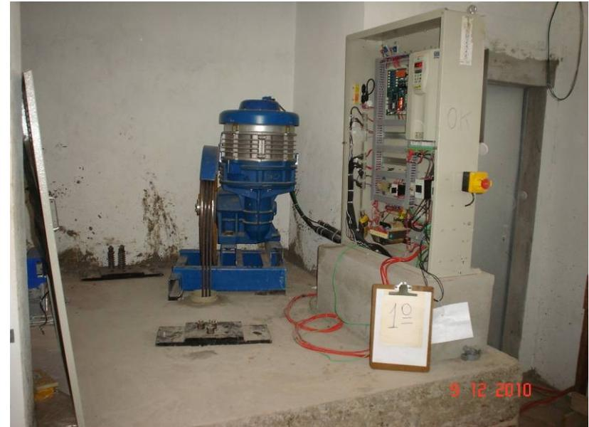
Detalhe do quadro de comando e motor do elevador do subsolo ao 1º pavimento.
