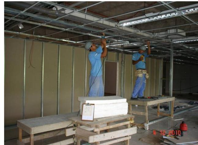
Detalhe da fixação da estrutura para suporte do forro de gesso acartonado no 1º pavimento.
