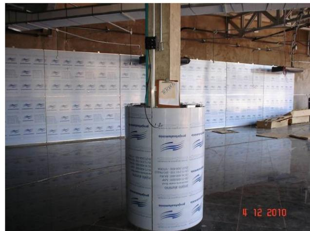
Revestimento interno, em alumínio composto (ACM), em paredes do saguão.
