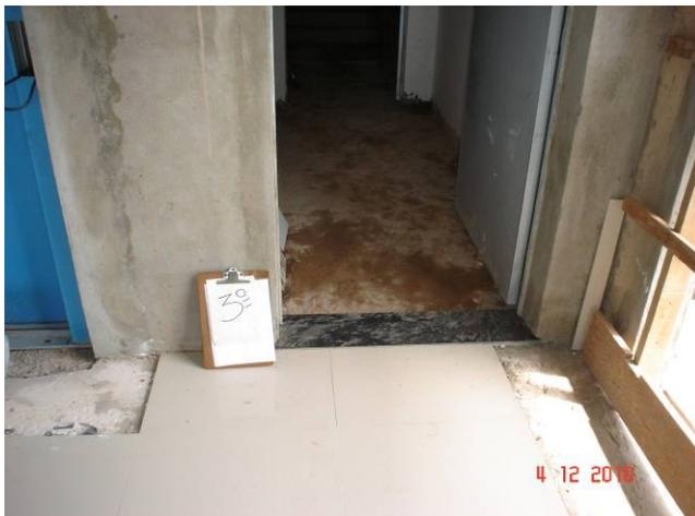
Detalhe da soleira em granito junto à porta corta-fogo do 3º pavimento.
