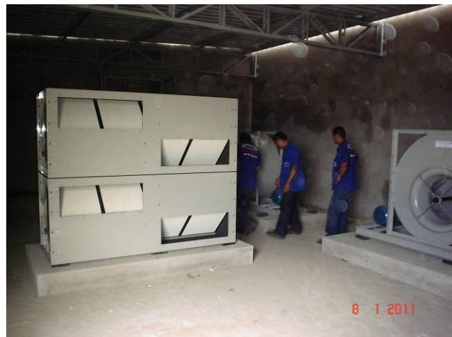
Detalhe do "Lossnay" (trocador de calor) e ventiladores instalados sobre base em concreto na casa de máquina de ar condicionado.
