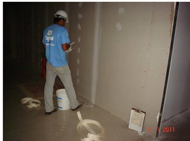
Tratamento de juntas com fita própria e massa pronta na junção das placas de "Dry Wall".
