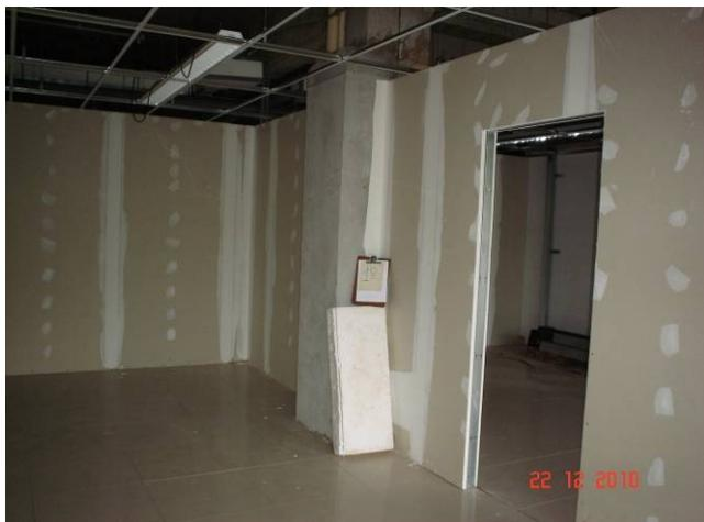
Divisória de divisória em "Dry Wall" instalada no 1º pavimento.
