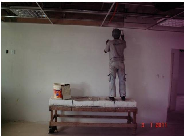
Detalhe do emassamento em paredes de "Dry Wall" no 5º pavimento.
