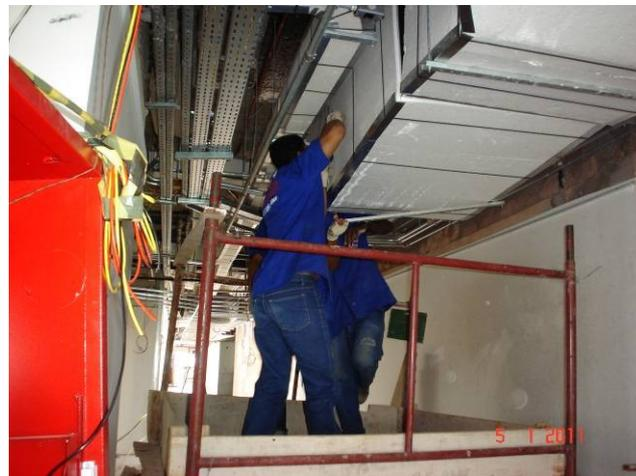
Interligação dos dutos de exaustão/insuflamento do 5º pavimento para a casa de máquinas da cobertura.
