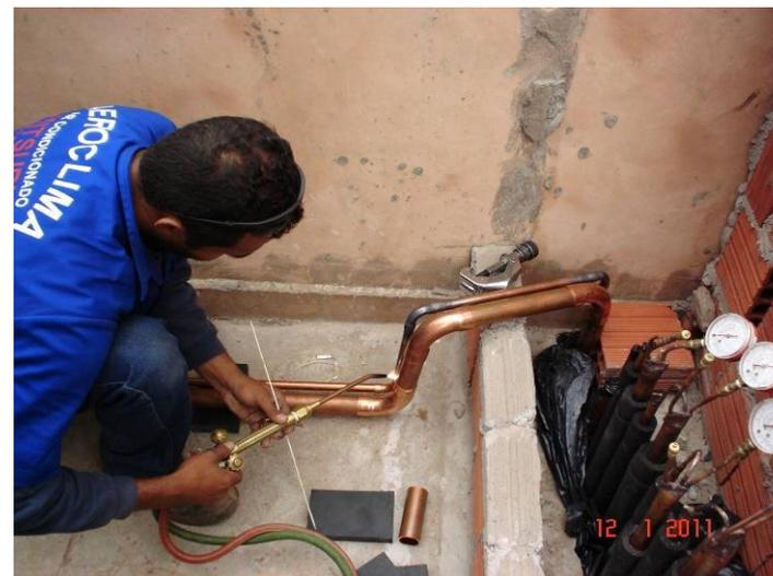
Detalhe da solda de tubulação frigorígena das máquinas condensadoras de ar condicionado.
