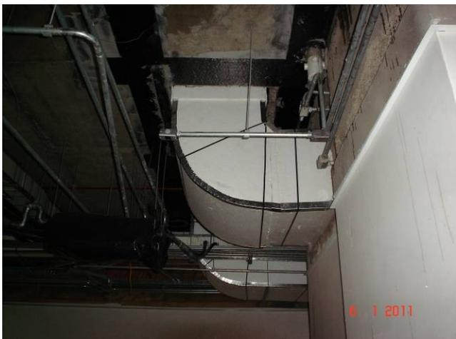
Detalhe da interligação dos dutos de exaustão/insuflamento do 5º pavimento para a casa de máquinas da cobertura.
