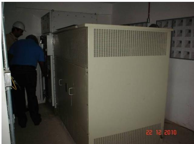
Instalação do transformador (750KVA) enclausurado na subestação da cobertura.
