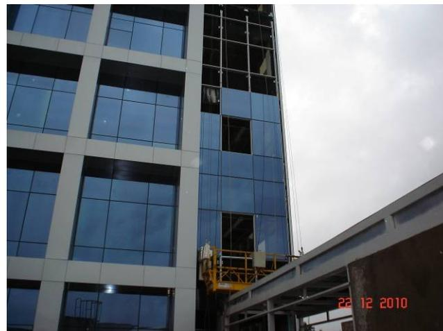
Vista da fachada Sul em pele de vidro “*structural glazing*”.
