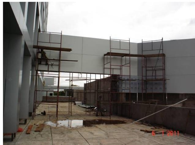
Detalhe do revestimento externo em alumínio composto.
