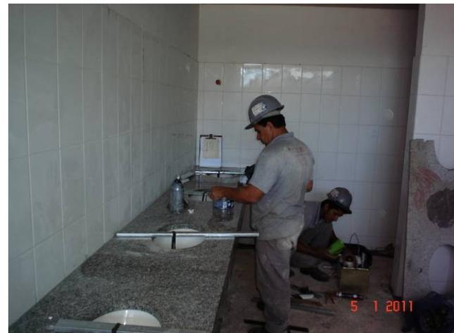
Detalhe da colocação de cuba em bancada de granito em banheiro coletivo do 1º pavimento.
