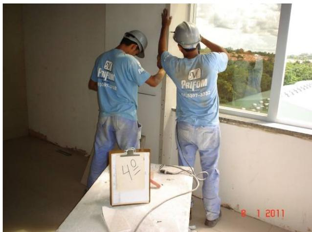
Detalhe do acabamento interno em gesso acartonado junto aos pilares
