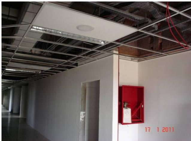
Detalhe dos sonofletores instalados no forro mineral do 4º pavimento.
