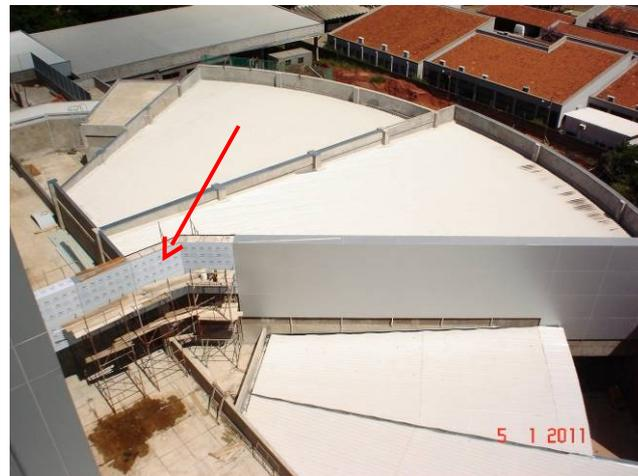
Detalhe do revestimento externo em alumínio composto.
