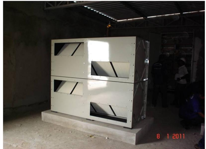
“Lossnay” (trocador de calor) instalado na casa de máquina de ar condicionado da cobertura fachada leste.
