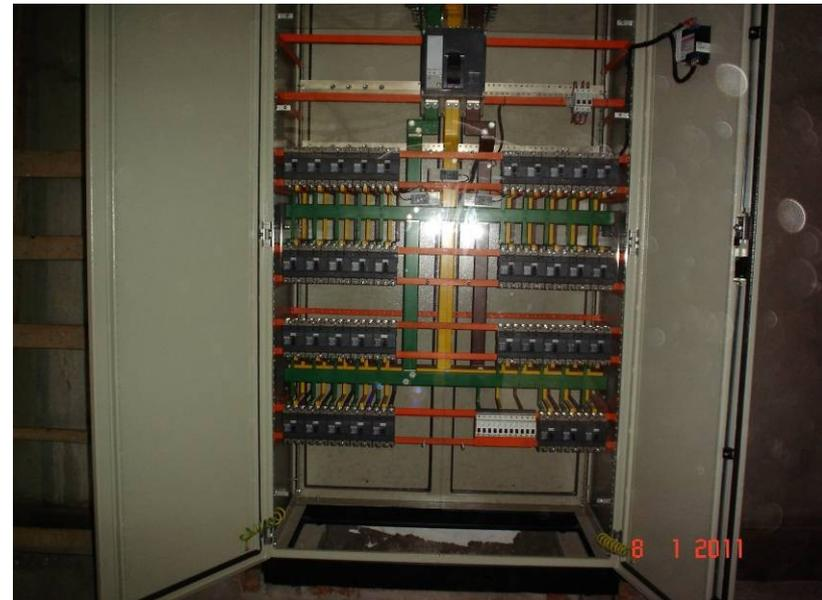
Detalhe do Quadro Geral de Distribuição QDG dos equipamentos de ar condicionado na sala de equipamentos da cobertura na fachada leste.
