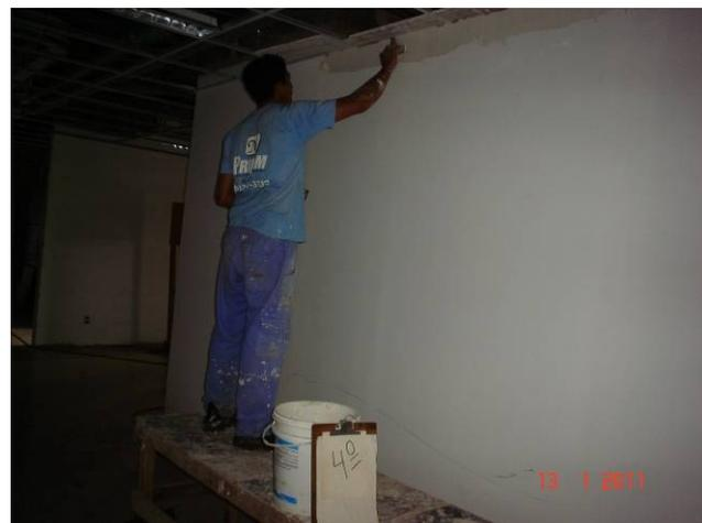
Detalhe do emassamento das paredes junto à estrutura do forro mineral.
