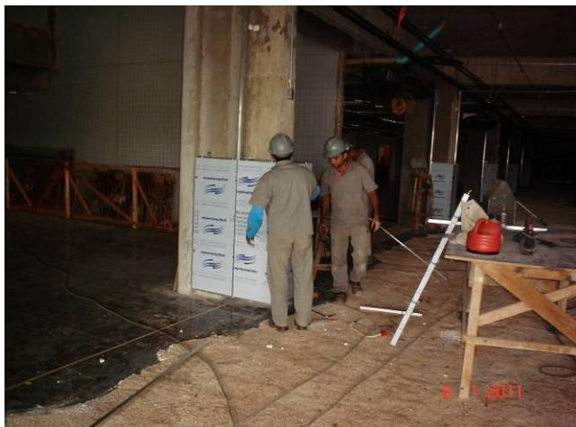
Detalhe do revestimento interno em alumínio composto.
