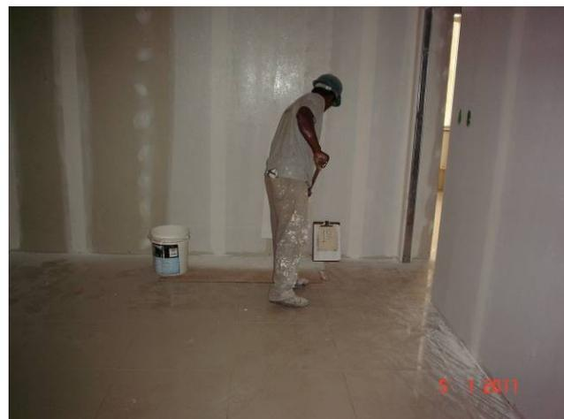
Detalhe da aplicação de selador sobre parede de "Dry Wall" no 1º pavimento.
