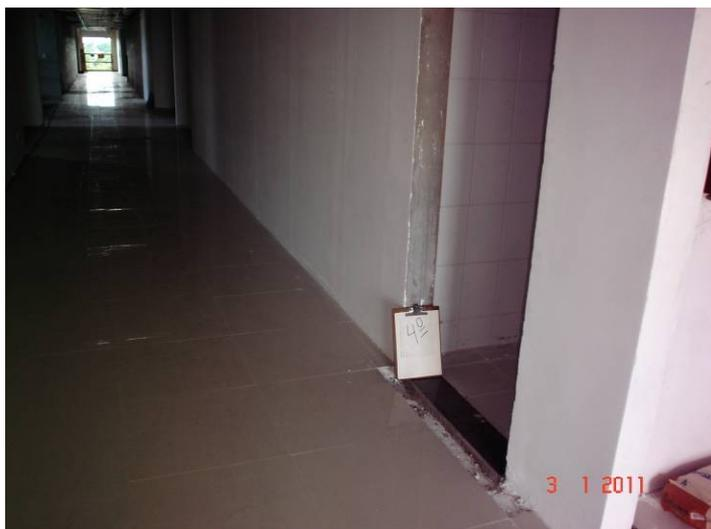
Detalhe de soleira em granito blue star instalada na entrada do sanitário coletivo no 4º pavimento.
