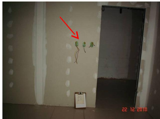
Detalhe da instalação de caixas para interruptores das salas do 1º pavimento.
