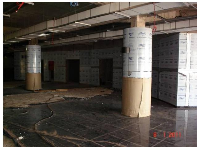
Detalhe do revestimento interno em alumínio composto.
