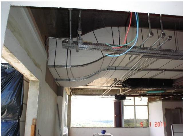
Detalhe dos dutos de exaustão/insuflamento no 5º pavimento próximo ao shaft da fachada leste.
