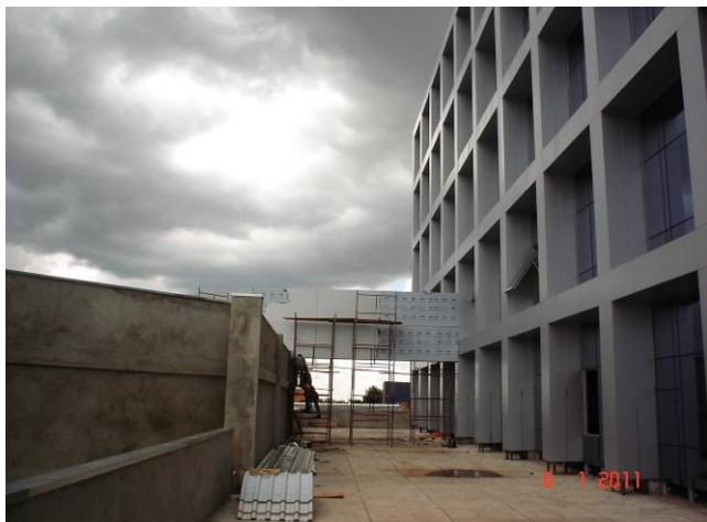
Detalhe do revestimento externo em alumínio composto.
