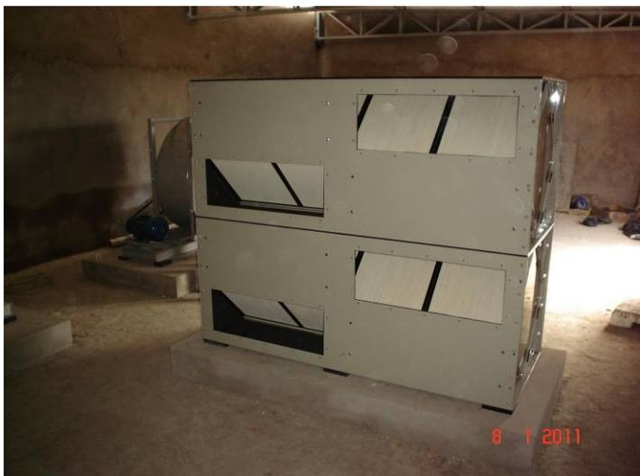
Detalhe do “Lossnay” (trocador de calor) instalado na casa de máquina de ar condicionado.
