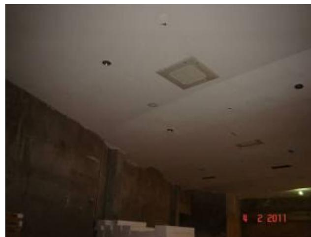
Vista do forro curvo e de gesso acartonado especial no plenário grande. Detalhe de unidade evaporadoras e de luminárias instaladas.
