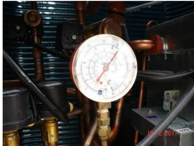
Manômetro instalado nas unidades condensadoras do sistema de ar condicionado.
