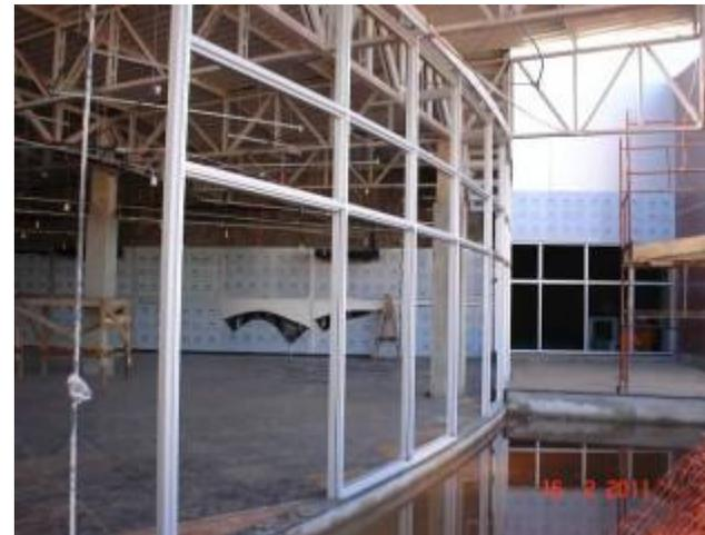
Colocação de estrutura em alumínio para fixação do vidro de fechamento tipo “*structural glazing*” na fachada oeste no térreo.
