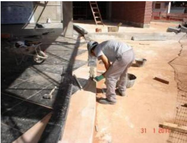
Detalhe da instalação de soleira em granito no térreo junto ao hall da entrada principal.
