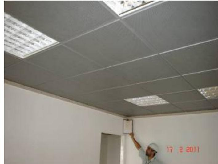
Detalhe do forro em placas de alumínio perfurado no 5º pavimento.
