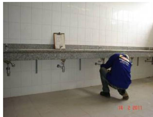
Detalhe de torneiras e sifões instalados em bancada de granito em banheiro coletivo do 2º pavimento.
