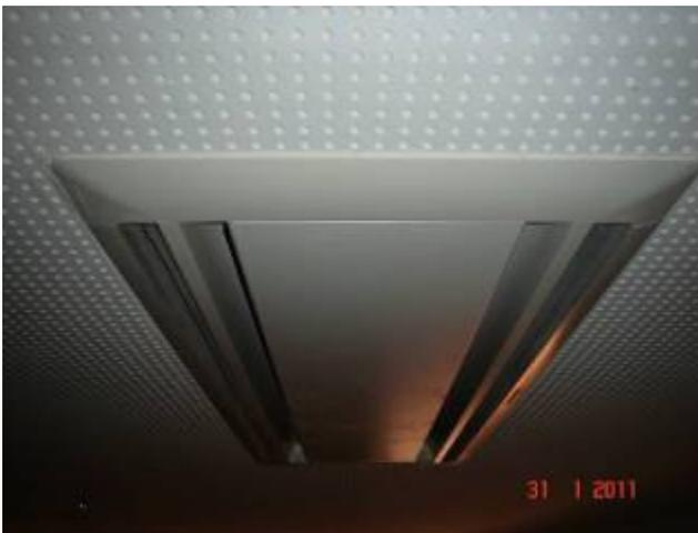
Vista da unidade evaporadora instalada no teto do plenário grande junto ao forro de gesso acartonado perfurado.
