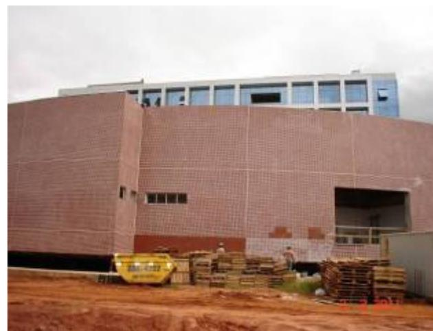
Vista da pastilha cerâmica externa e seu rejuntamento na fachada sul.
