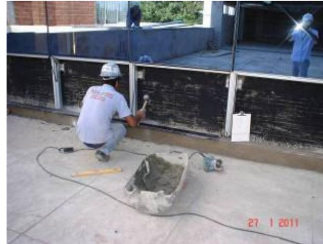
Detalhe de instalação de soleira em granito no 1º pavimento.
