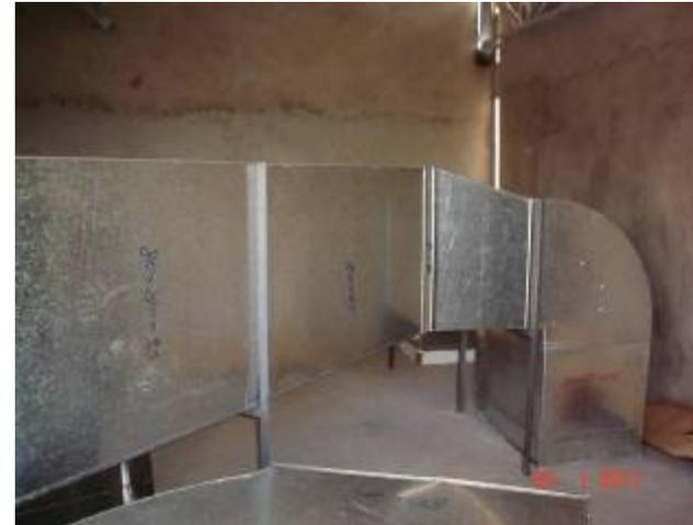
Montagem de dutos de exaustão/insuflamento na casa de máquinas de ar condicionado na cobertura.
