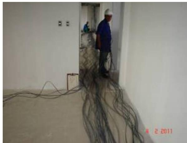
Instalação de cabeamento STP no 5º pavimento.
