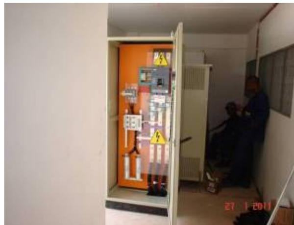
Vista dos equipamentos (quadro de distribuição) dentro da subestação de alimentação dos equipamentos de ar condicionado na cobertura.
