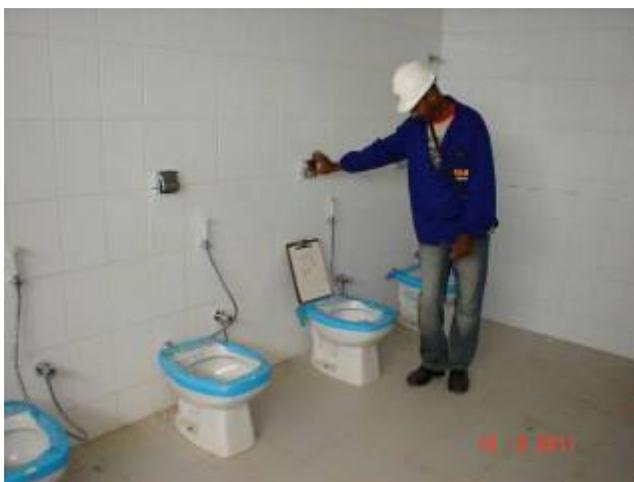
Detalhe de válvula de descarga e duchas higiênicas instaladas em banheiro coletivo do 2º pavimento.
