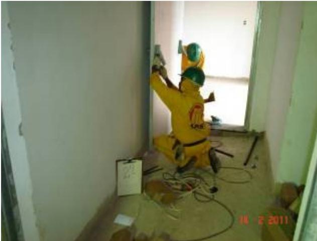
Detalhe de instalação de barra anti-pânico na porta corta-fogo do 2º pavimento.
