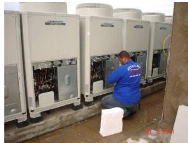
Instalação de manômetro nas unidades condensadoras de ar condicionado.
