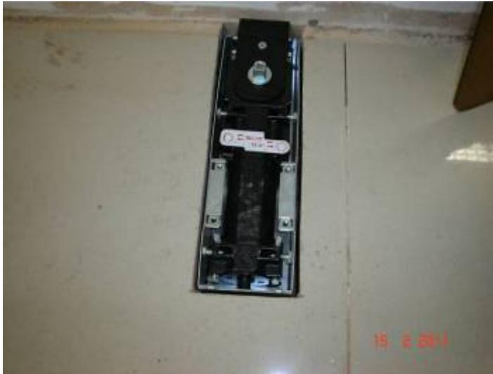
Detalhe da mola hidráulica de embutir no piso instalada no 4º pavimento.
