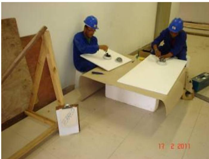
Detalhe da instalação das câmeras nas placas de forro mineral.
