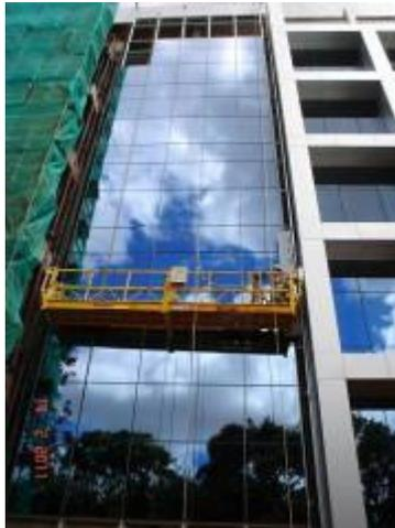
Detalhe da colocação de vidro “*structural glazing*” na fachada norte, com utilização de balancim.
