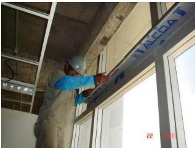
Colocação de acabamento em alumínio "cortineiro" para acabamento do forro com a esquadria de vidro no 3º pavimento.
