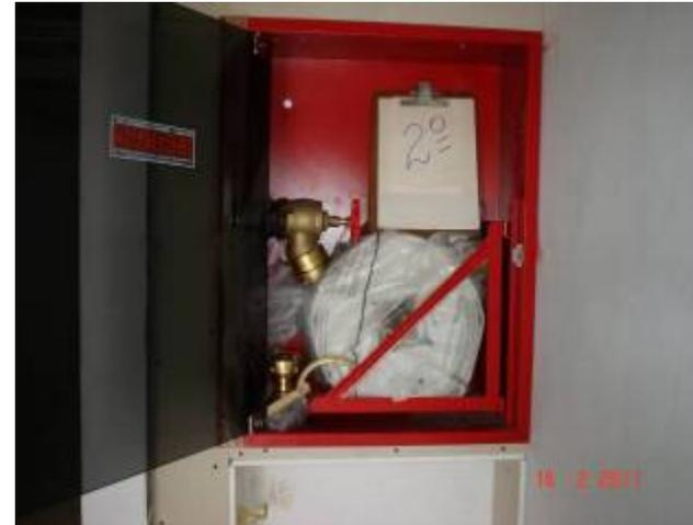
Detalhe do hidrante com mangueiras, registro, esguicho e chave *storz* no 2º pavimento.
