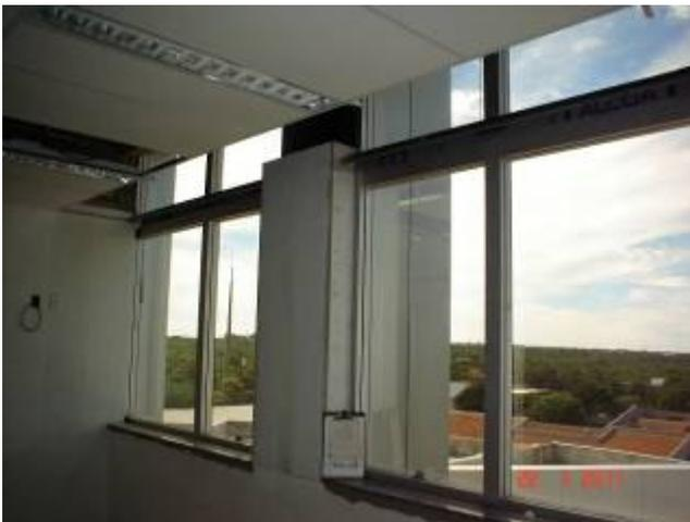
Acabamento interno em *dry wall* junto aos pilares no 3º pavimento.
