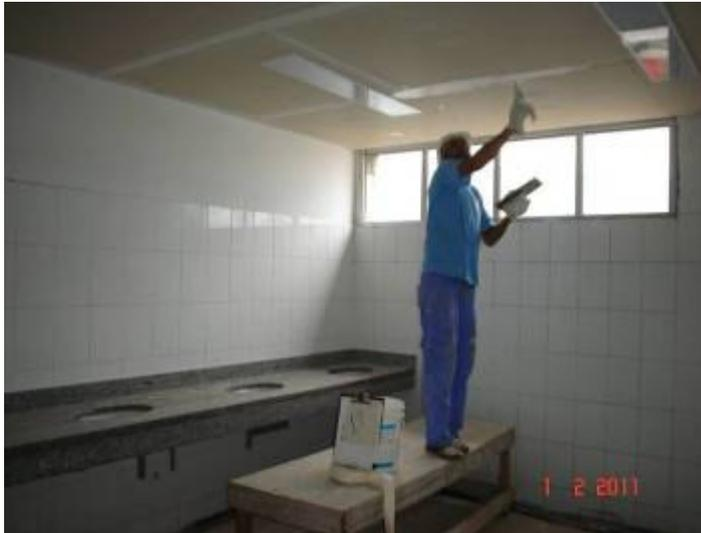
Detalhe do tratamento com fita especial nas juntas das placas de gesso acartonado utilizadas no forro dos banheiros coletivos do 1º pavimento.
