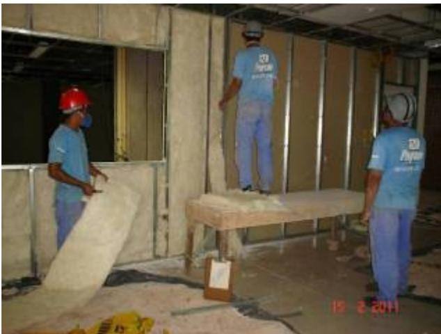
Detalhe da instalação de lã de vidro no interior das paredes de gesso acartonado tipo *dry wall* no pavimento térreo.
