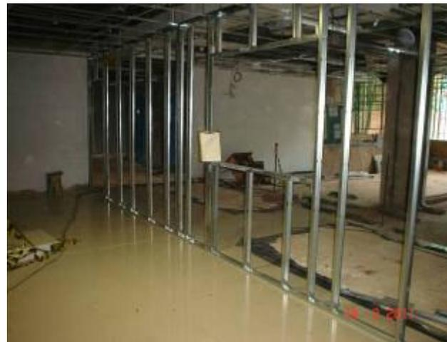
Estrutura em chapa metálica para fixação de placas de gesso acartonado, para paredes *dry wall*, no pavimento térreo.
