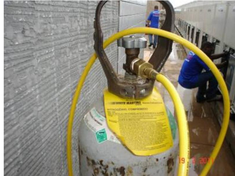
Cilindro de pressão de nitrogênio utilizado na tubulação frigorígena de ar condicionado.
