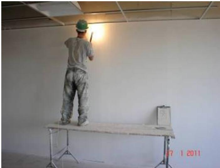
Detalhe do lixamento de massa acrílica sobre paredes para aplicação de pintura no 5º pavimento.
