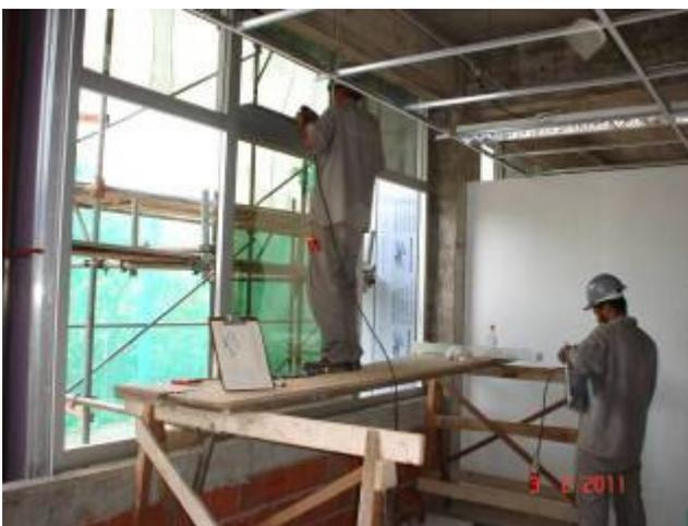
Colocação de acabamento em alumínio "cortineiro" para acabamento do forro com a esquadria de vidro no 1º pavimento.
