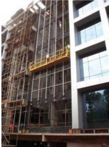
Colocação de estrutura de alumínio para fixação do vidro “*structural glazing*” na fachada norte, com utilização de balancim.
