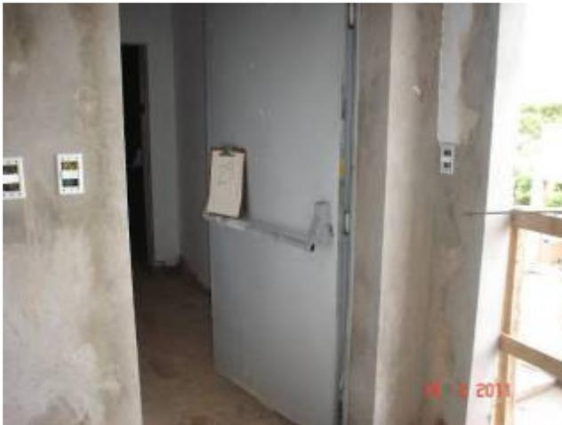
Detalhe da barra anti-pânico na porta corta-fogo no 2º pavimento.
