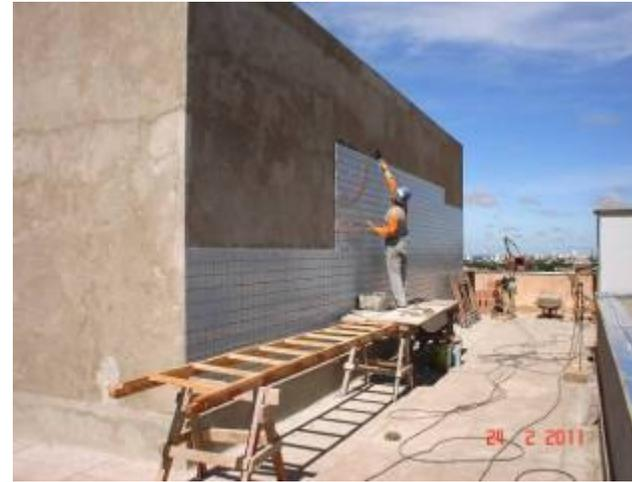
Assentamento de pastilha cerâmica externa na casa de máquinas do sistema de ar condicionado na cobertura.
