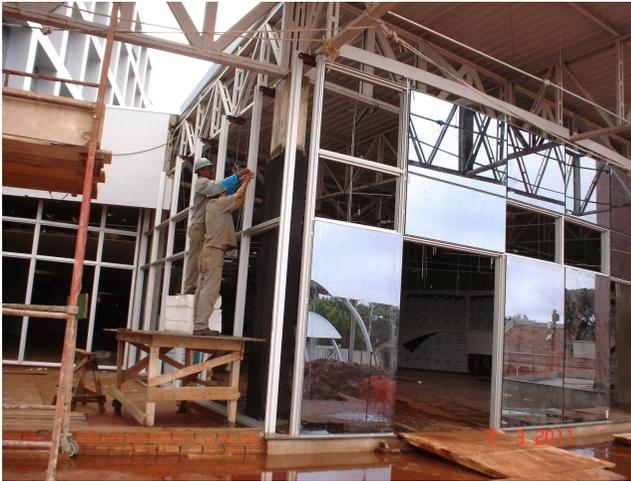
Estrutura em alumínio e colocação parcial de vidro “*structural glazing*” na entrada do saguão.
