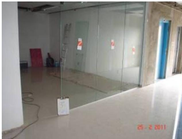
Painéis de vidro temperado assentado no 3º pavimento.
