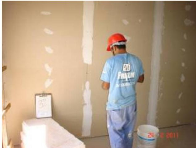
Detalhe da instalação de divisória em gesso acartonado no 3º pavimento.
