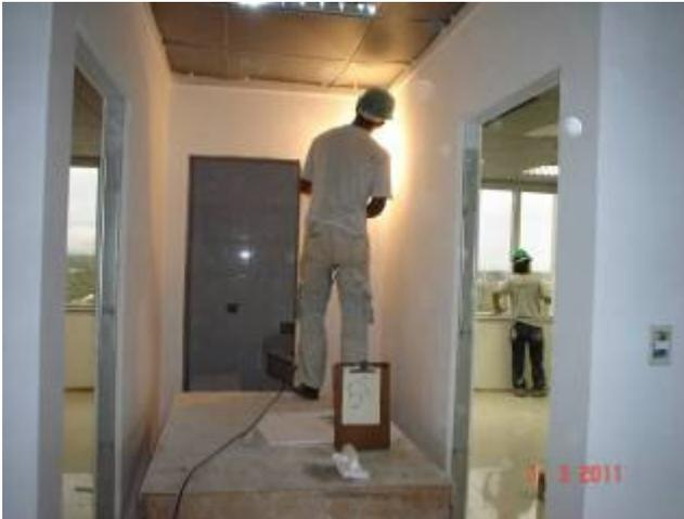
Lixamento de massa acrílica sobre paredes para aplicação de pintura no 5º pavimento.
