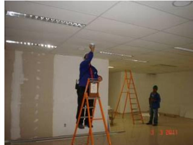
Instalação de detector ótico de fumaça em forro mineral no 3º pavimento.
