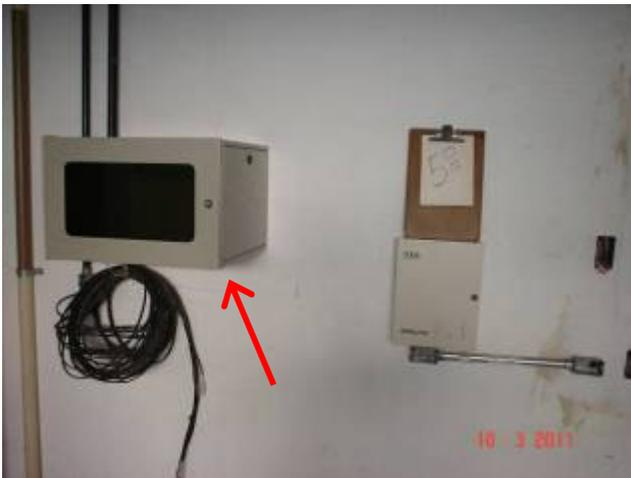
Rack do sistema de CFTV com fonte de alimentação de 12 saídas e equipamento de DVR (Digital Video Recorder) do 5º pavimento.
