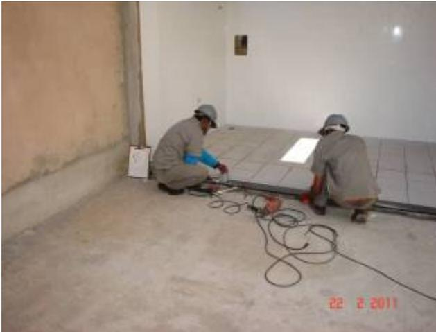
Detalhe do assentamento de soleira em granito no 1º pavimento.
