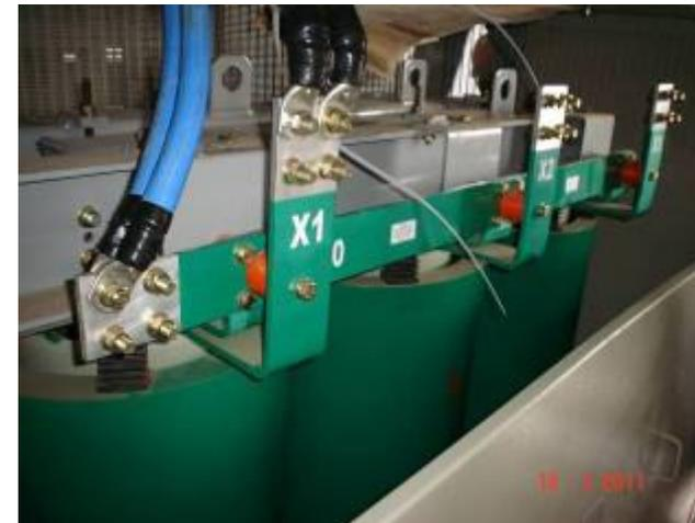
Ligação parcial de cabos do transformador encapsulado ao QDG-AC na subestação da cobertura.
