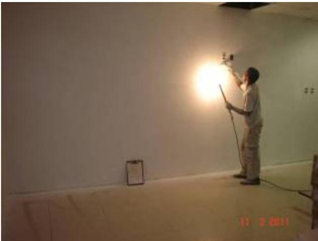
Lixamento de massa acrílica sobre paredes para aplicação de pintura no 4º pavimento.
