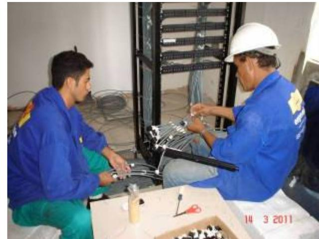
Interligação de cabeamento estruturado em *rack* da sala técnica do 1º pavimento.
