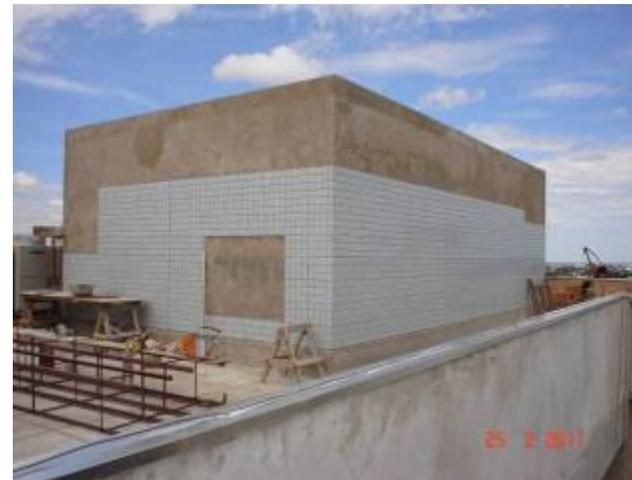
Vista da casa de máquinas do sistema de ar condicionado revestida externamente com pastilha cerâmica.
