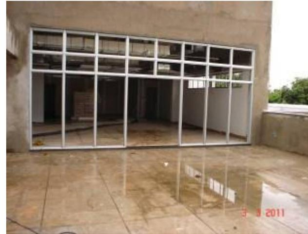
Estrutura em alumínio para fixação de vidro “*structural glazing*” no 1º pavimento.
