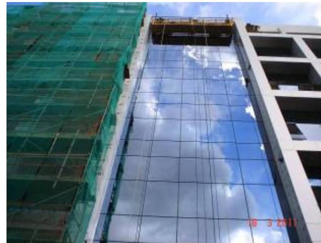
Vidro “*structural glazing*” fixado na fachada norte.
