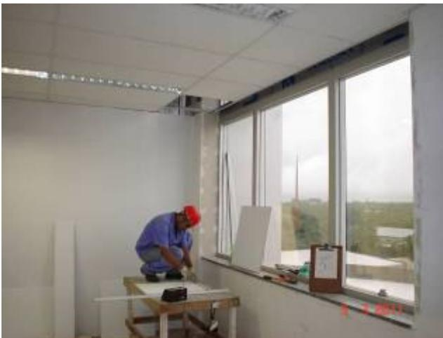
Aplicação de forro modular removível em fibra mineral no 3º pavimento.
