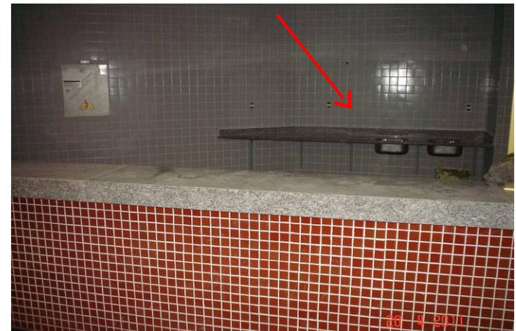
Bancada em granito e cubas de aço inox instaladas na cafeteria do pavimento térreo.
