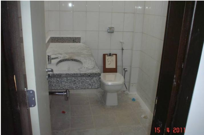
Bancada em granito, cuba de embutir, torneira, bacia sanitária e acessórios instalados em banheiro individual no 5º pavimento.
