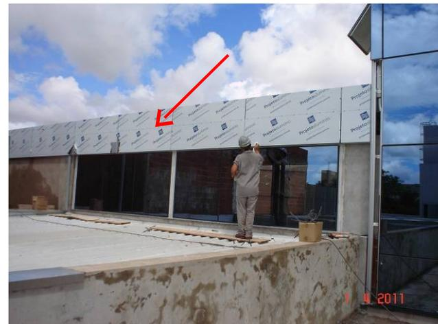
Vista do revestimento em alumínio composto instalado em platibanda da cobertura do corredor que interliga a parte A com parte B.
