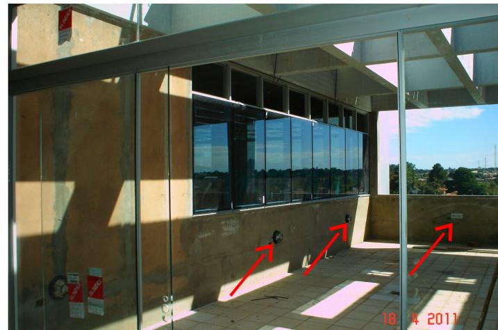
Instalação de luminárias tipo arandela no terraço do 5º pavimento.
