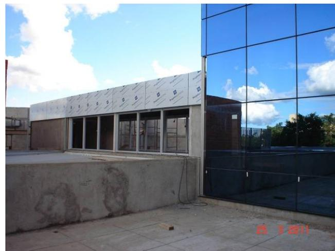
Pele de vidro “*structural glazing*” fixado na fachada leste.
