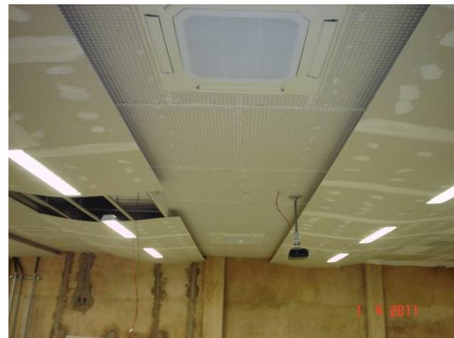
Detalhe de teto em gesso acartonado instalado em forro da sala de treinamento.
