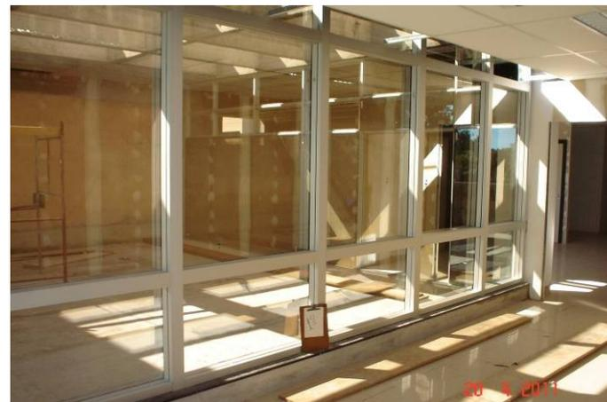
Estrutura de alumínio para pele de vidro instalado no fechamento da área do pergolado do 1º pavimento.
