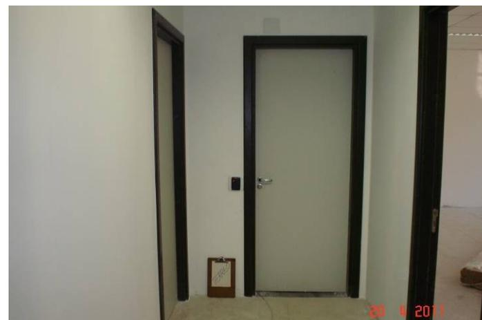
Portas de madeira assentadas no pavimento térreo, inclusive guarnições e fechaduras.
