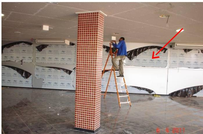
Detalhe de revestimento, em alumínio composto, de parede no saguão de entrada no térreo.
