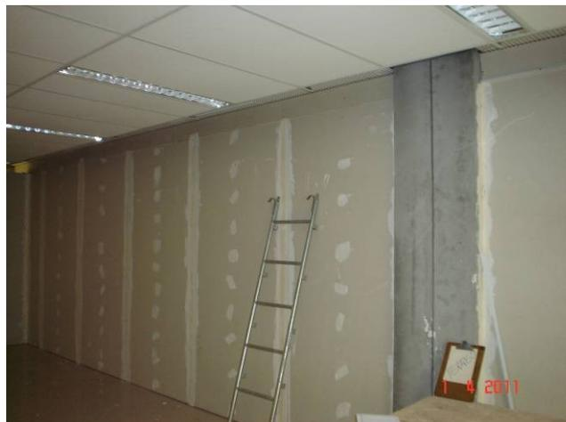
Gesso acartonado instalado em paredes do térreo.
