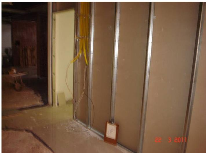
Detalhe de divisória "Dry Wall" parcialmente instalada no pavimento térreo.
