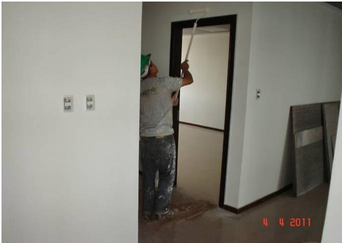
Pintura PVA sobre massa corrida em parede de gesso acartonado do 3º pavimento
