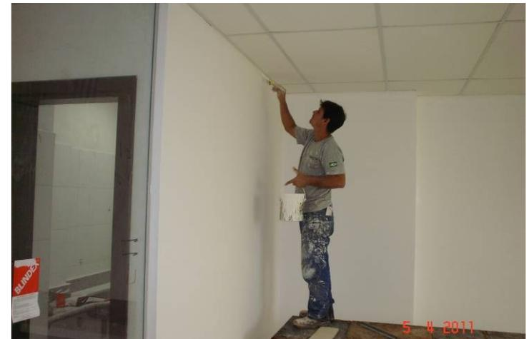
Detalhe de acabamento de pintura PVA sobre massa corrida em parede de gesso acartonado do 3º pavimento
