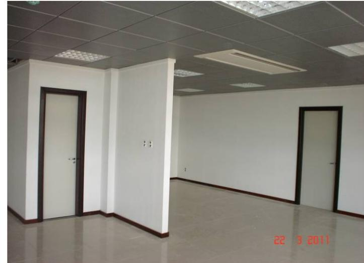
Detalhe de forro modular removível em alumínio perfurado instalado em teto do 5º pavimento
