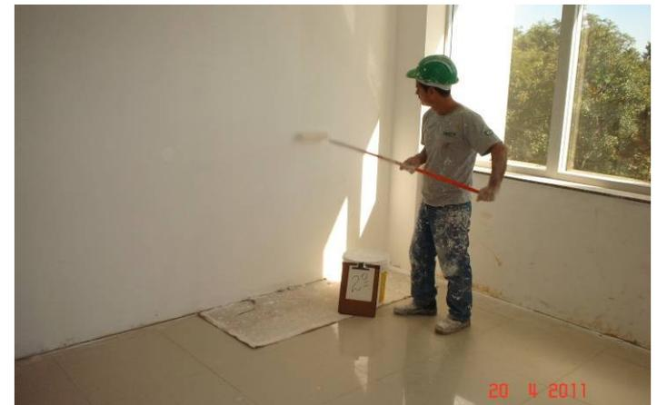
Pintura PVA sobre massa corrida em parede de gesso acartonado no 2º pavimento.
