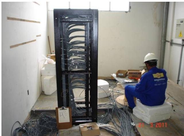
Montagem do rack da rede de lógica na sala técnica do 4º pavimento.
