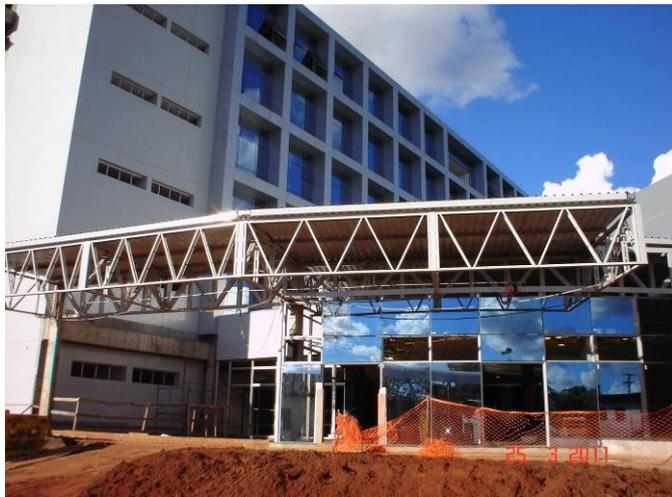
Vidro “*structural glazing*” fixado na entrada da fachada principal.
