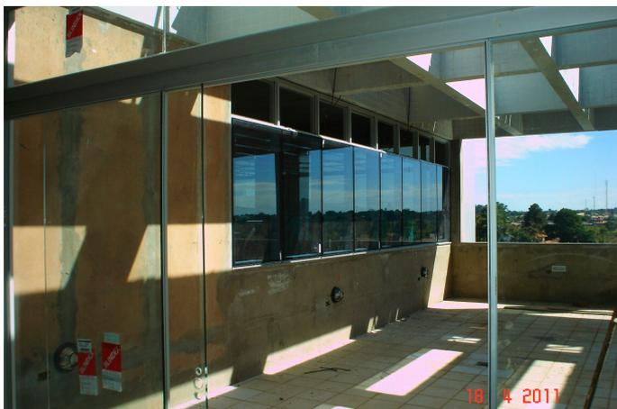
Pele de vidro instalado em janela do 5º pavimento.
