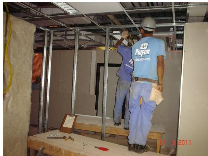
Detalhe da montagem de estrutura para fixação de divisória "Dry Wall" no pavimento térreo.
