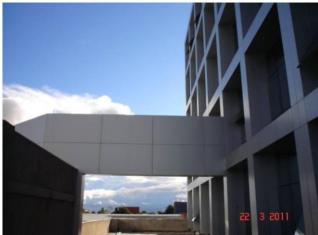
Vista externa do revestimento em alumínio composto na fachada leste do 1º pavimento.
