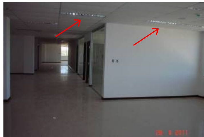
Luminárias instaladas nos pavimentos.
