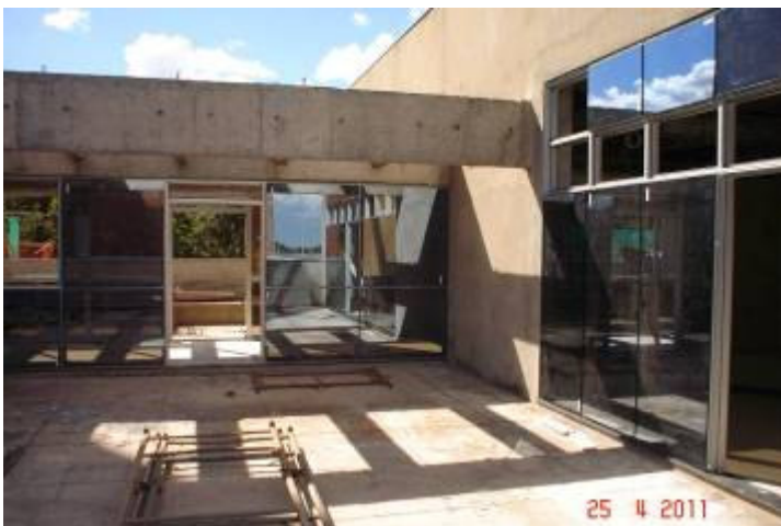
Detalhe da instalação de vidro laminado structural glazing da passarela para junta C no 1º pavimento.
