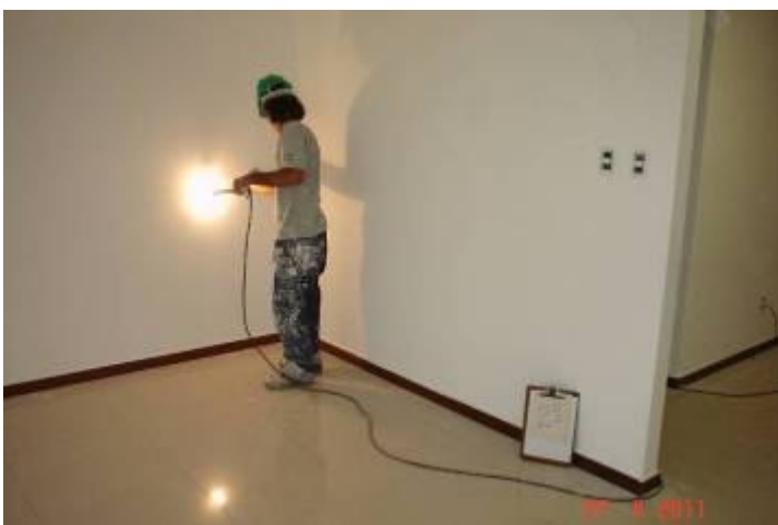
Pintura PVA sobre massa corrida em parede do 2º pavimento.
