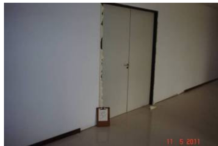
Portas de madeira assentadas no 3º pavimento, inclusive guarnições e fechaduras.
