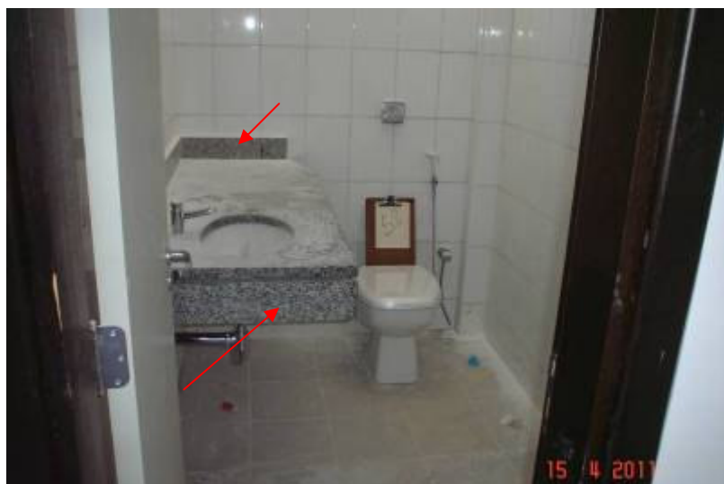
Detalhe de bancada em granito, testeira e rodopia instalada em bancada de banheiros individuais.
