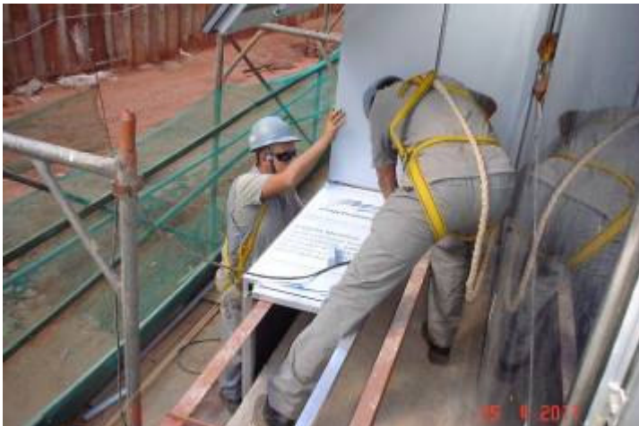
Detalhe da instalação em alumínio composto na fachada Norte no 1º pavimento.
