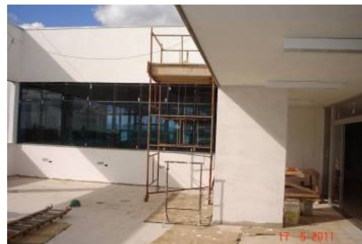
Vista da instalação de vidro laminado structural glazing no terraço do 5º pavimento fachada oeste.
