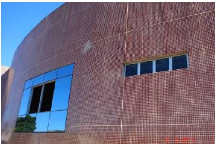
Detalhe de revestimento, em pastilha cerâmica, em parede externa da fachada sul.
