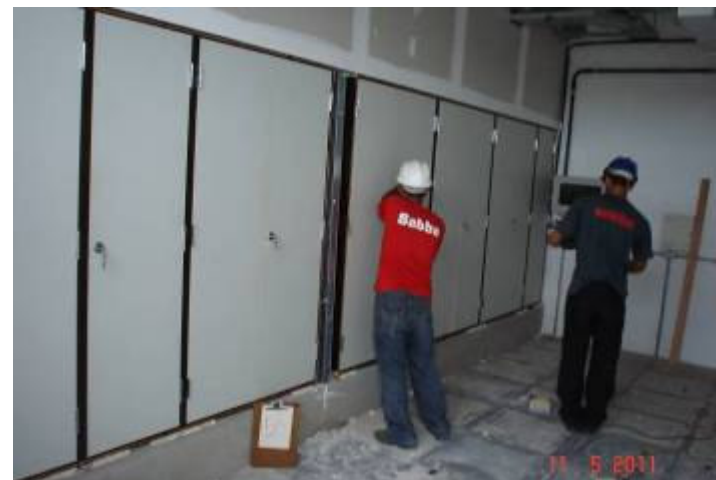
Detalhe de assentamento de portas dos shafts no 5º pavimento.
