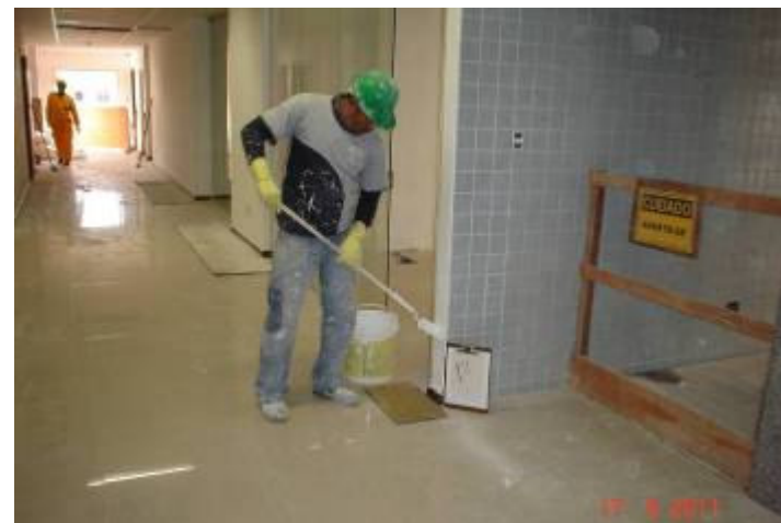
Pintura PVA sobre massa corrida em parede de gesso acartonado no 1º pavimento.
