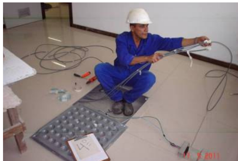
Colocação de conector RJ45 fêmea nos terminais dos cabos blindados STP categoria 6.
