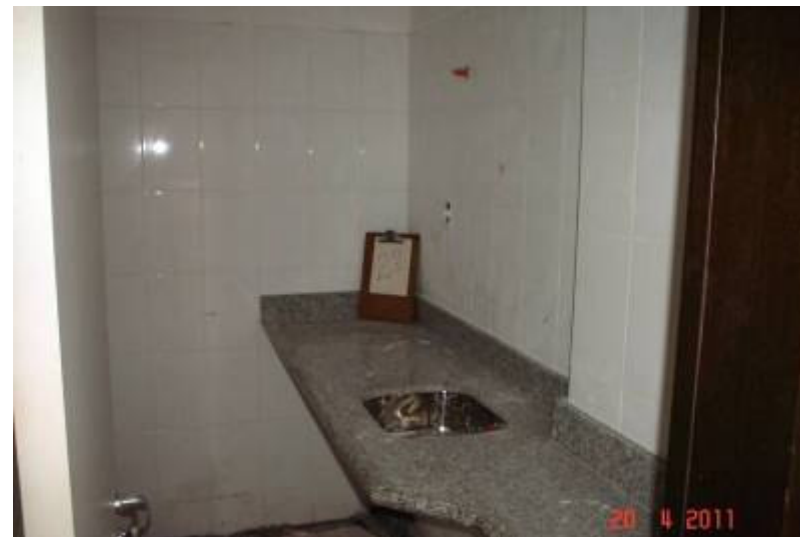
Detalhe de bancada de granito e de cuba em aço inox instalada em bancada de copa no 2º pavimento.
