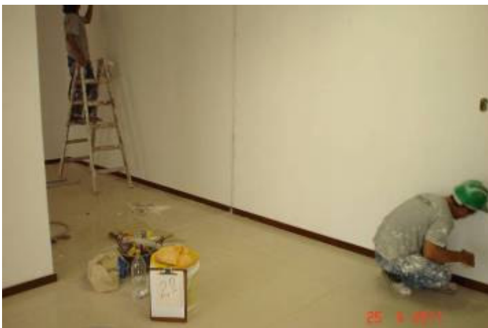
Pintura PVA sobre massa corrida em parede de gesso acartonado do 2º pavimento
