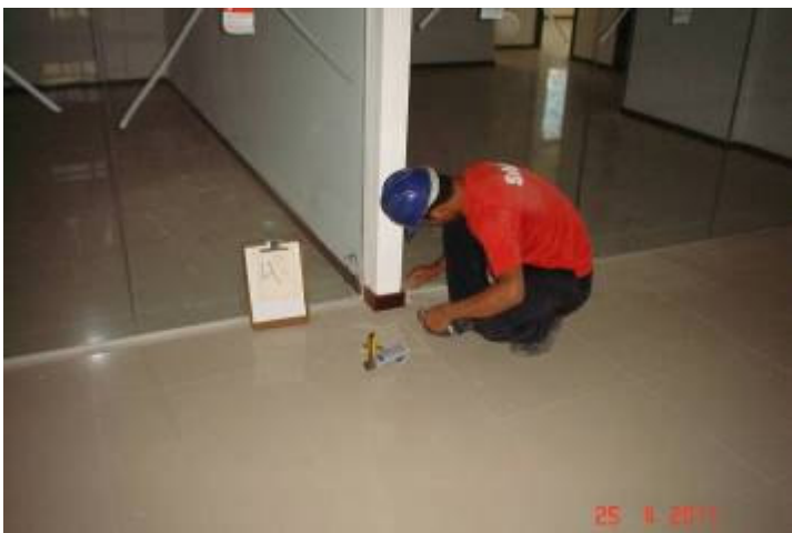
Detalhe da instalação de rodapé em madeira no 4º pavimento.
