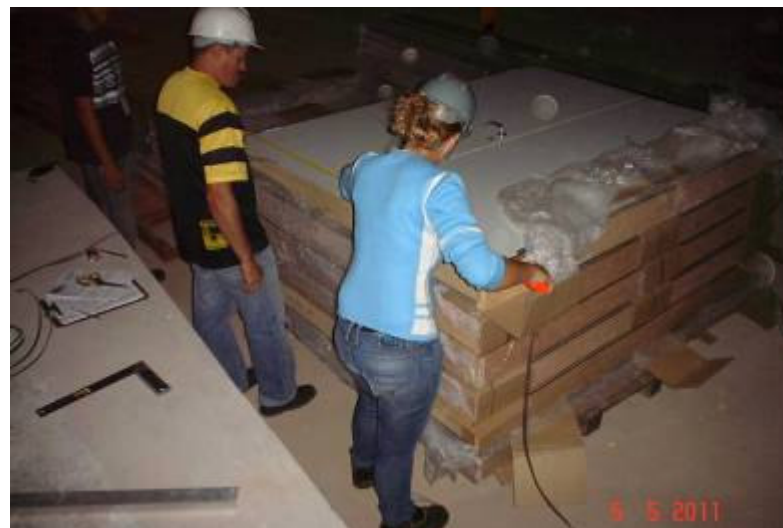
Controle de qualidade das portas a serem instaladas.
