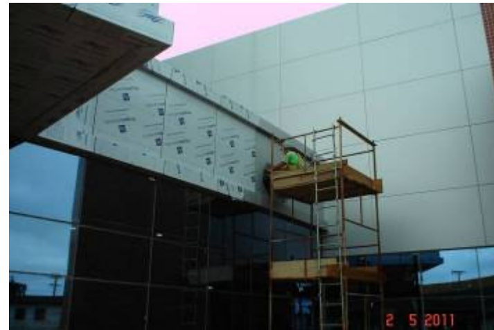
Vista do revestimento em alumínio composto instalado na fachada de entrada do prédio.
