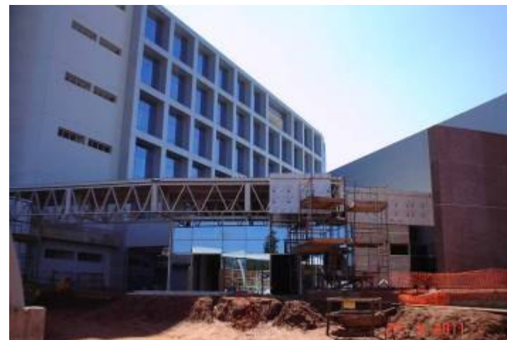
Vista da instalação de vidro laminado structural glazing da fachada oeste.
