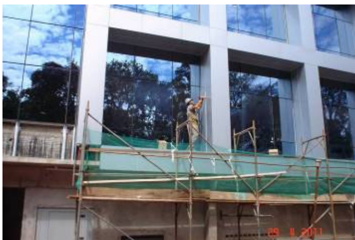
Vista da instalação de vidro laminado structural glazing na fachada norte.
