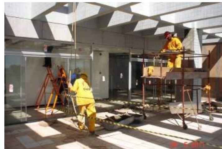
Revestimento externo em pastilha cerâmica em pilares de sustentação no pergolado do 5º pavimento.
