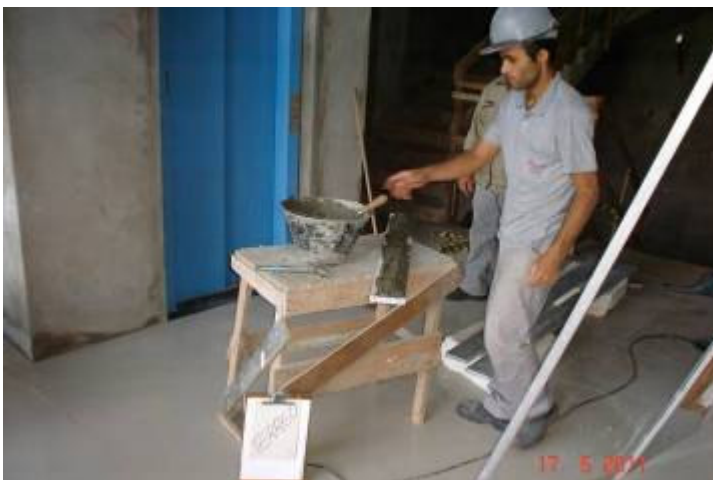
Detalhe de assentamento de soleira em granito no pavimento térreo.
