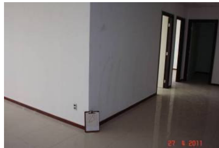
Detalhe de rodapé em madeira instalado no 2º pavimento.
