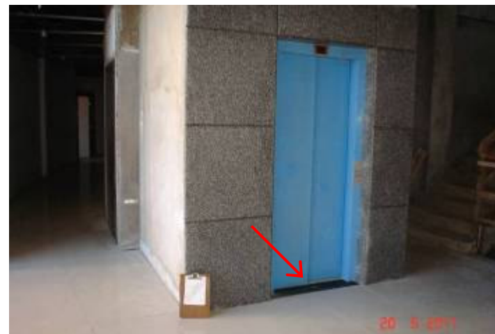
Detalhe de soleira em granito em porta de elevadores no térreo.
