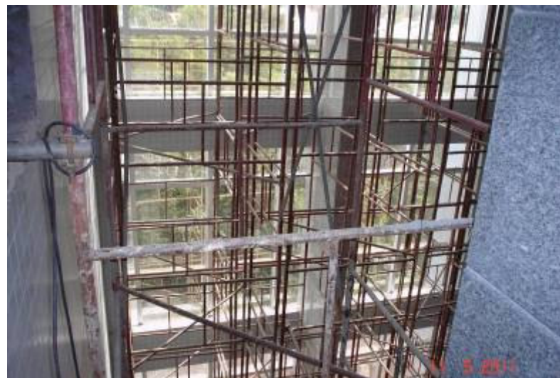
Estrutura em andaime tubular, para execução de serviços no hall dos elevadores panorâmicos.
