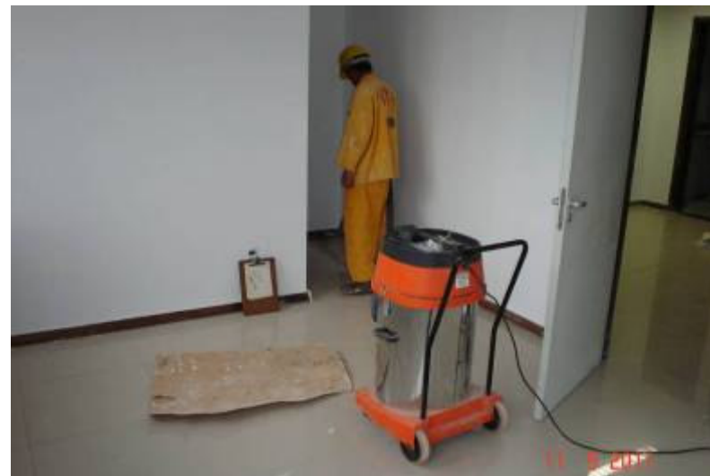
Equipamento (aspirador de pó) utilizado na limpeza diária da obra.
