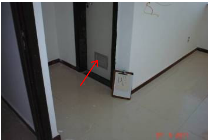
Portas de madeira com grelha instalada em porta de banheiro do 4º pavimento.
