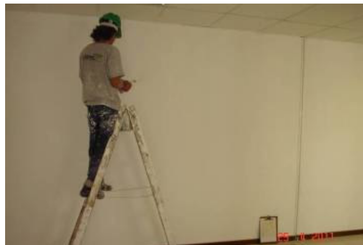
Detalhe de acabamento de pintura PVA sobre massa corrida em parede de gesso acartonado do 2º pavimento
