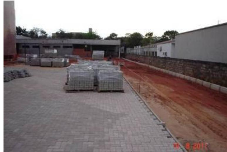
Vista de parte do piso intertravado e de meio-fio tipo DNER na lateral Sul.
