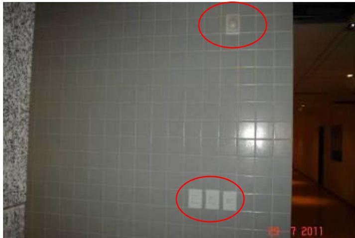
Detalhe de interruptores e sensores de presença instalados.
