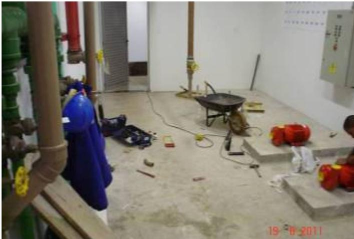
Detalhe da instalação de conjunto moto-bomba, para instalação de combate a incêndio (5º pavimento).
