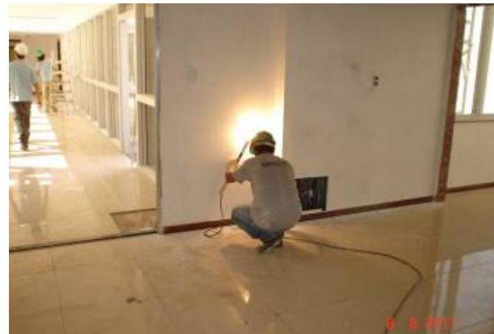
Lixamento sobre massa acrílica em parede, para pintura no 1º pavimento.
