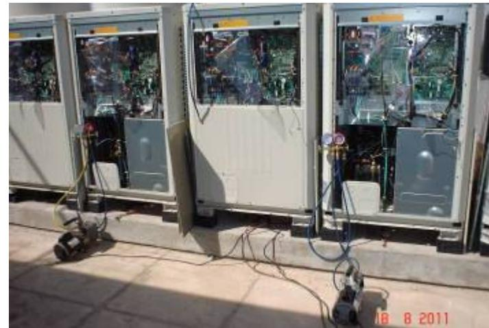
Carga de gás nas máquinas condensadoras do sistema de ar condicionado.
