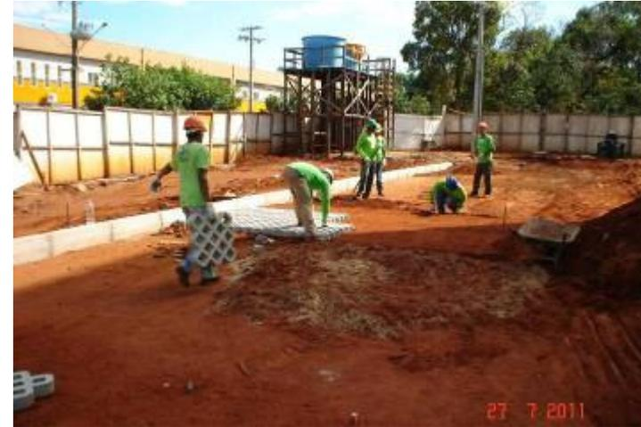
Colocação de piso intertravado – tipo vazado.
