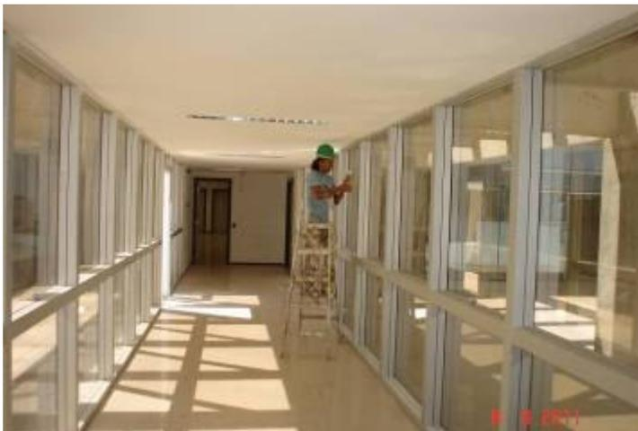
Emassamento de teto em gesso acartonado, para pintura no 1º pavimento.
