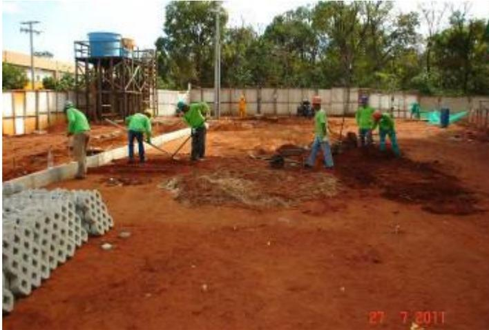
Preparo do terreno para colocação de piso intertravado - tipo vazado.
