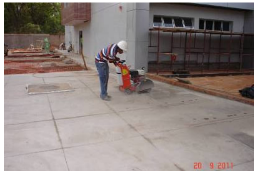
Detalhe da execução de friso no piso em concreto de alta resistência.
