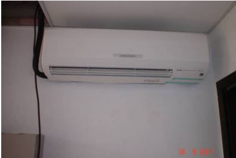
Detalhe da instalação do Split.
