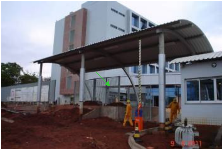
Detalhe da instalação do portão metálico de acesso.
