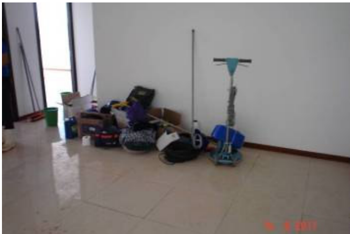
Equipamento e material para limpeza da obra.
