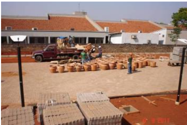
Detalhe do descarregamento dos vasos cerâmicos para paisagismo.
