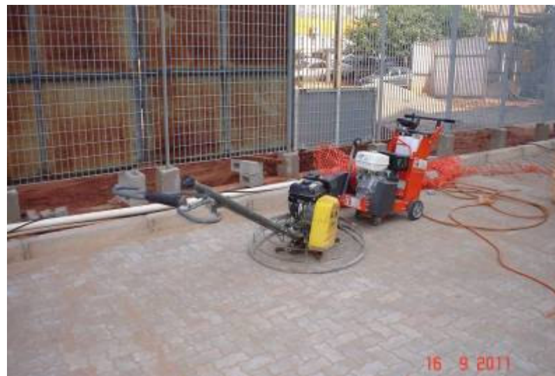
Detalhe dos equipamentos para execução de piso em concreto de alta resistência (desempenadeira e máquina de corte para piso.)
