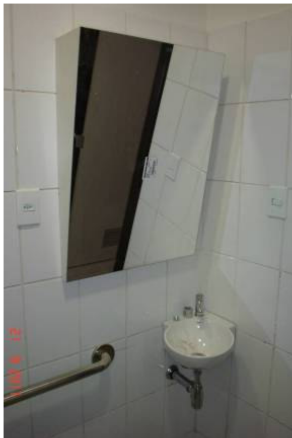
Detalhe do espelho instalado no banheiro adaptado (pessoa com deficiência), bem como barra de apoio.
