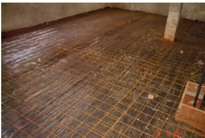
Detalhe da armação de aço sobre lona preta para piso de alta resistência (sala de manutenção).
