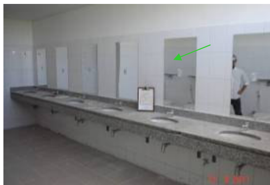
Detalhe da instalação de espelho de cristal em banheiro coletivo do 3º pavimento.
