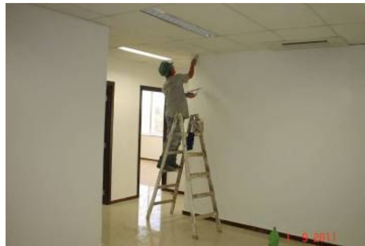
Detalhe do emassamento de parede junto ao teto para pintura das paredes 3º pavimento.
