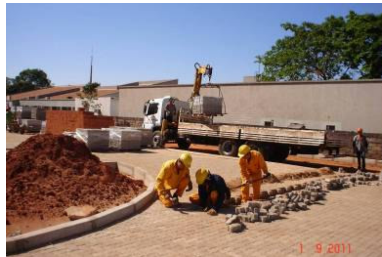
Detalhe da descarga de piso intertravado, e escavação para a instalação de grelha para captação de águas pluviais.
