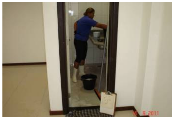
Detalhe da limpeza da bancada de granito e revestimento cerâmico no 5º pavimento
