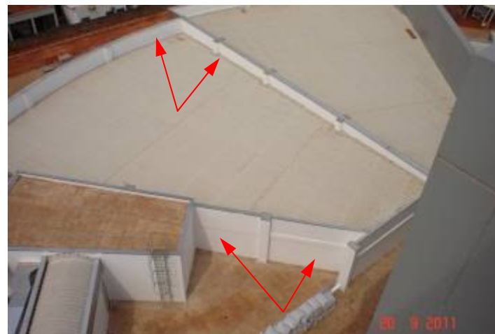
Detalhe da pintura sobre parede sem massa acrílica.
