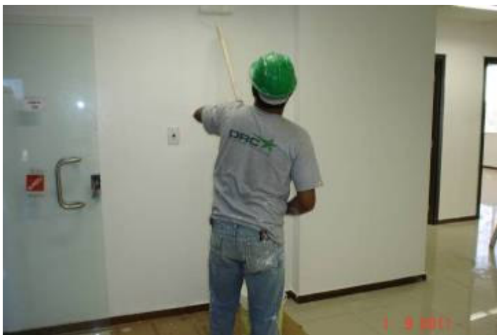
Detalhe da pintura de parede sobre massa acrílica no 3º pavimento.
