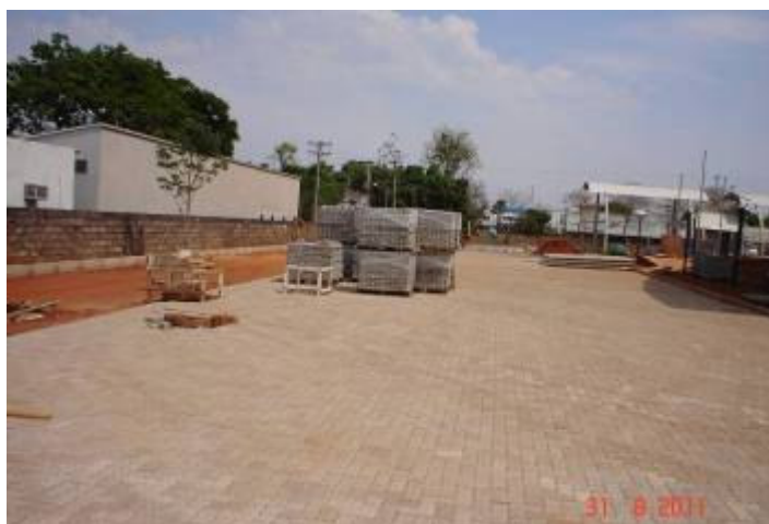
Detalhe do piso intertravado na lateral da Fachada Sul.
