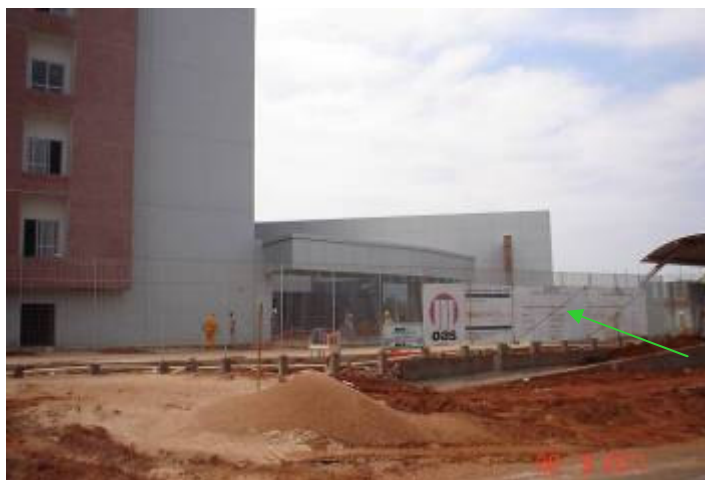
Detalhe do gradil de fechamento em aço carbono.
