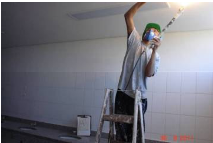
Lixa sobre massa corrida em teto para pintura 4º pavimento.
