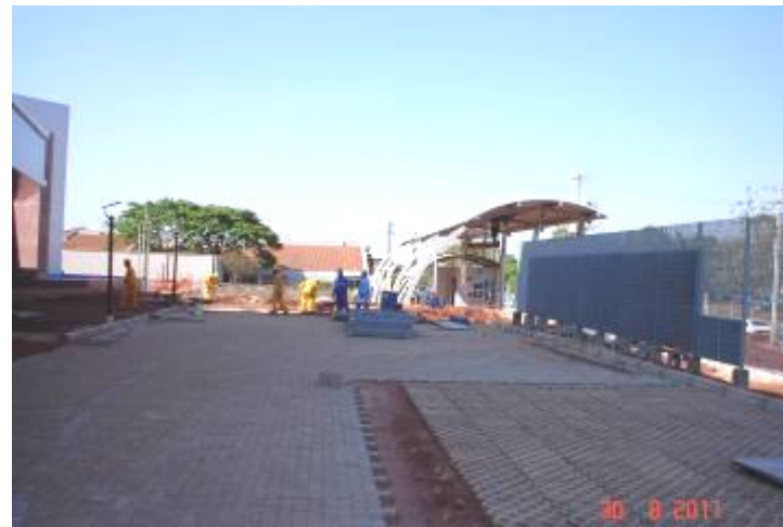
Detalhe da execução do piso intertravado, intertravado tipo vazado e meio fio.
