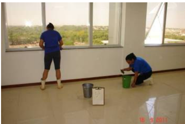
Detalhe da limpeza de peitoris e piso no 5º pavimento
