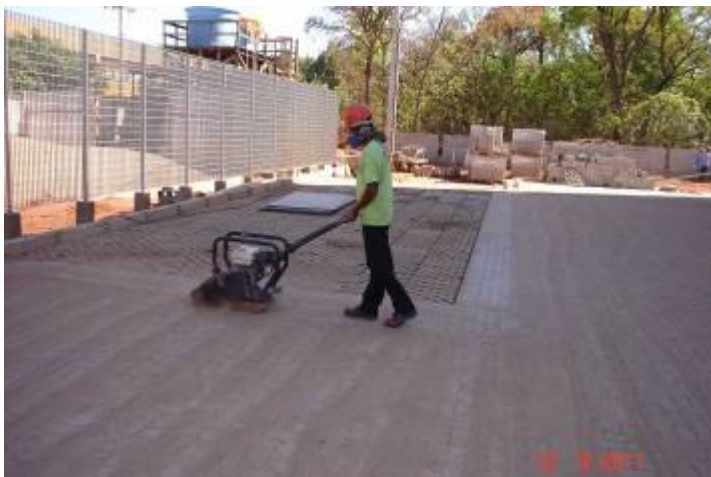
Detalhe da compactação do piso intertravado.
