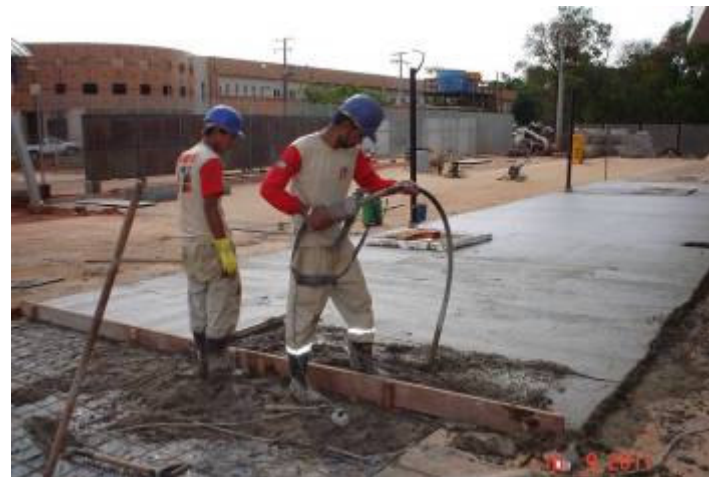
Detalhe da execução do piso em concreto de alta resistência.
