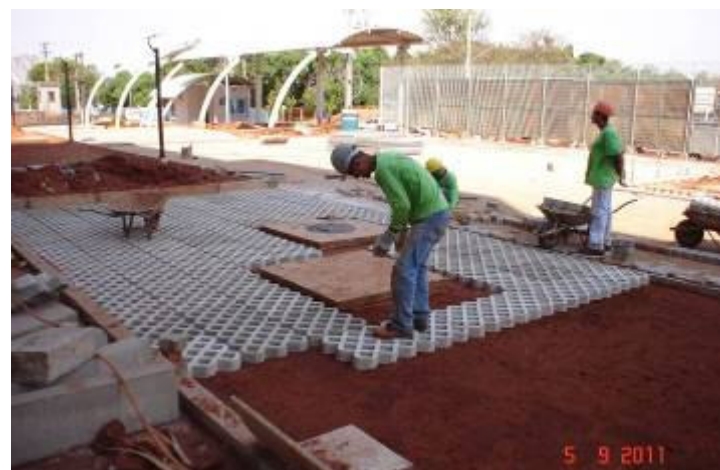
Detalhe da execução do piso intertravado vazado.
